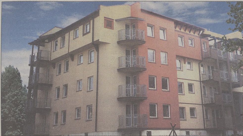
Budynki w końcowej fazie realizacji, stan z września br.
