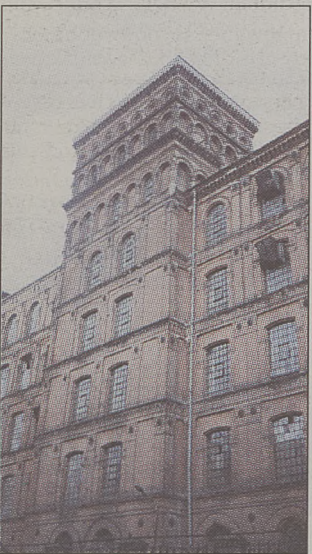
Fragment przędzalni Poznańskiego przy ul. Ogrodowej
