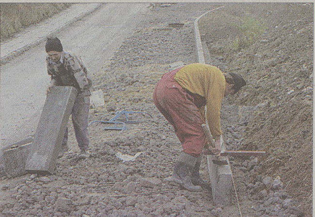
Pracownicy RDM z Nowej Huty osadzają bloki krawężnikowe
