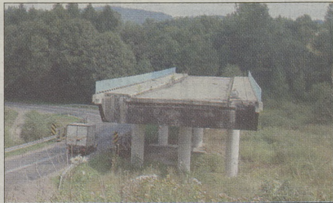
Most donikąd, wybudowany przed laty obok starej trasy Wadowice - Sucha Beskidzka
