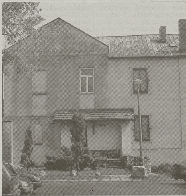
Kilka lat potrwa gruntowny i skomplikowany remont kompleksu trzech budynków przy ul. Szpitalnej. Fot. Jacek Sypień
