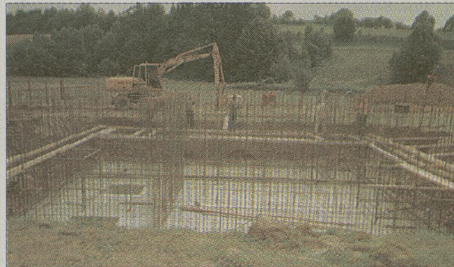
Koparka przy oczyszczalni
