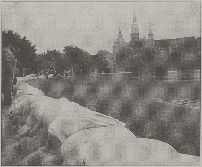
Tak zabezpieczano wały wiślane pod Wawelem w czasie powodzi w lipcu 1997 r. Fot. Anna Kaczmarz
