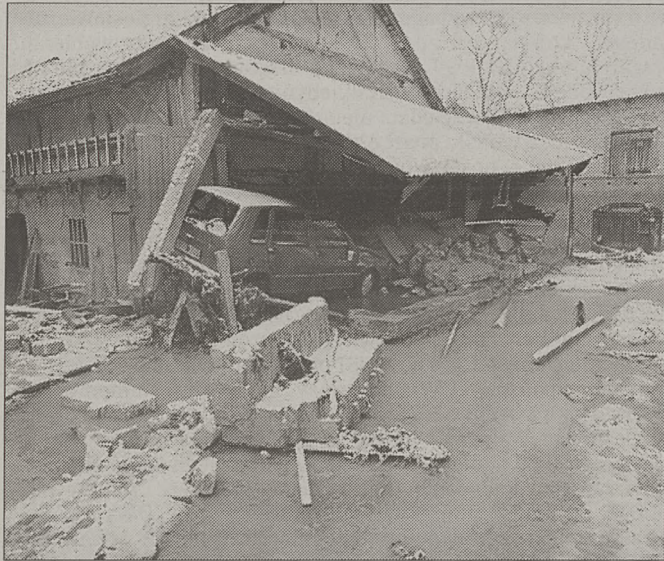
Tędy przeszła potężna fala
