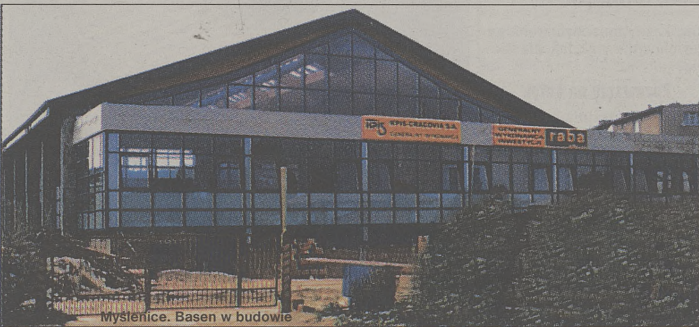
Mysienice. Basen w budowie
