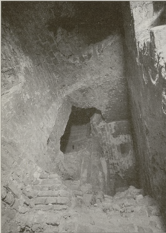
Podziemie kamienicy przy ul. Kanoniczej
