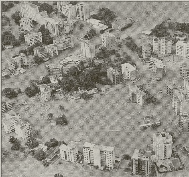
Widziane z góry budynki miasta La Guaira, 20 km na północ od Caracas otoczone mułem naniesionym przez rzeki w czasie powodzi Fot. PAP/EPA (Francisco PAGES)
