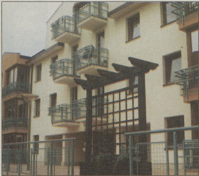
Fragment nagrodzonego osiedla przy ul. Piastowskiej
