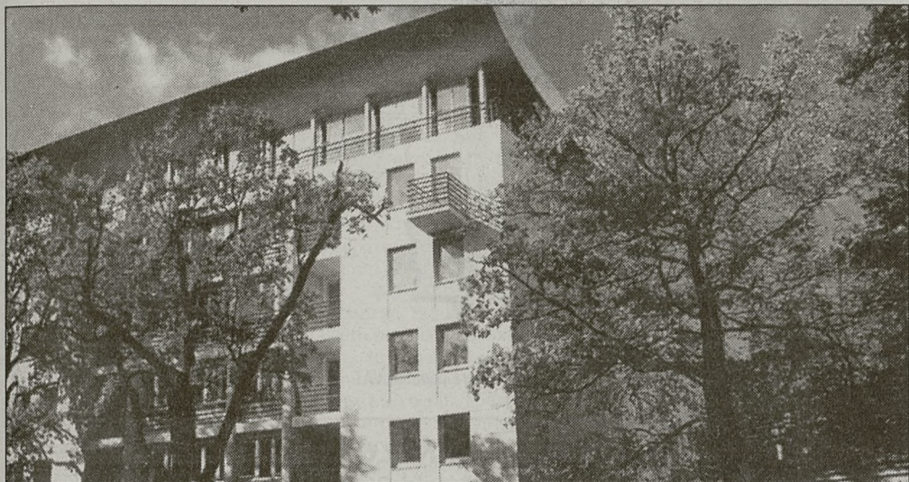
Budynek mieszkalny przy ulicy Szucha w Warszawie. Ma 36 mieszkań, biura, basen kąpielowy (na zdjęciu poniżej) i sauny.
