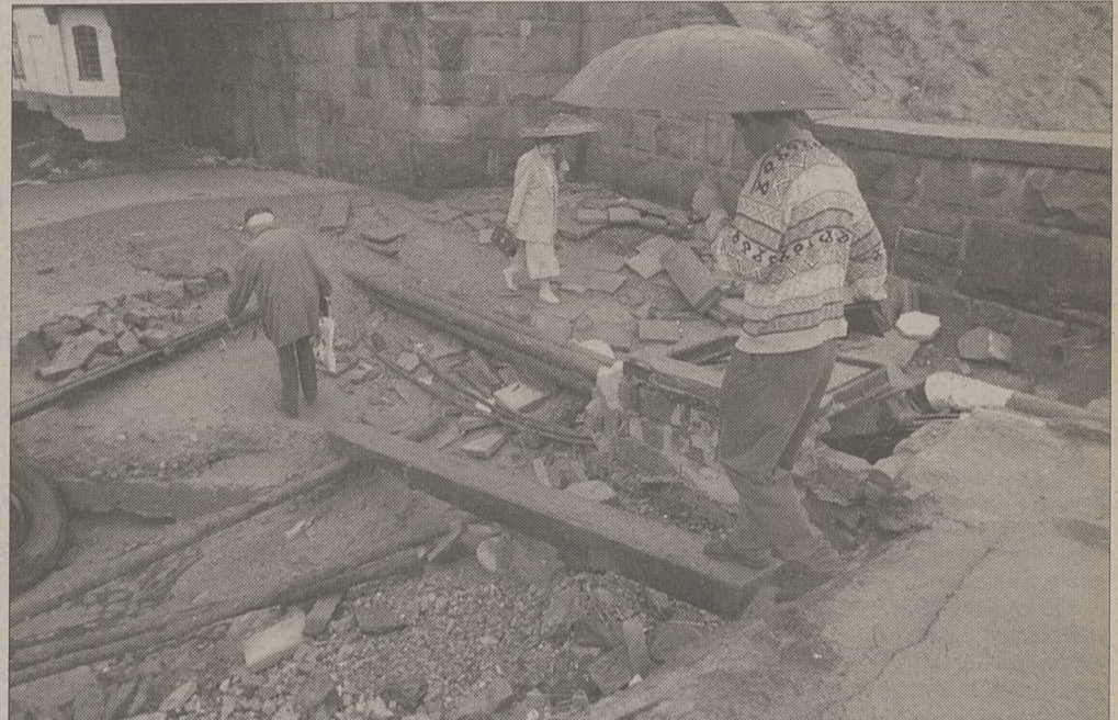
Most na Nysie Kłodzkiej przy ul. Śląskiej w Kłodzku po pierwszej fali powodziowej.
