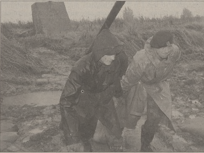
Przed zapowiadaną drugą falą powodziową żołnierze Nadwiślańskich Jednostek Wojskowych z Warszawy w pośpiechu zapełniali wyrwy w walcach przeciwpowodziowych na Odrze w Raciborzu. Fot. PAP/CAF
