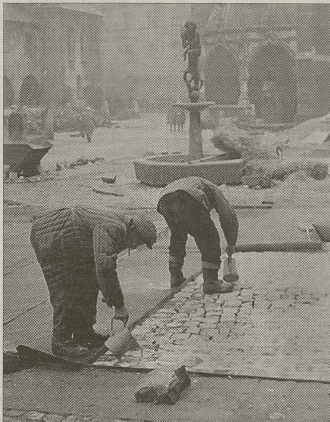
Zdjęcie z 1961 roku. Robotnicy układają nową nawierzchnię na płycie Rynku Głównego. Fot. Wacław Kłag
