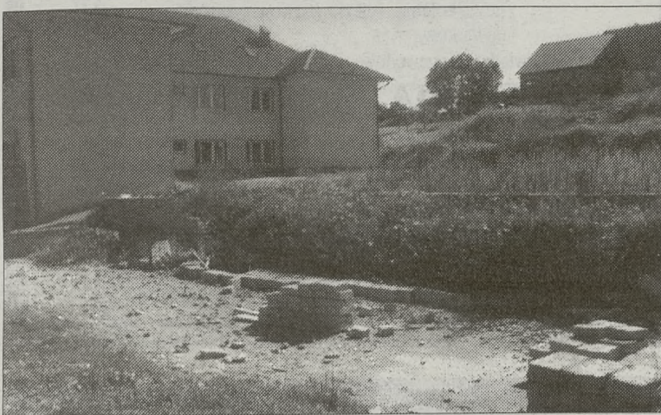
Szkoła w Długolecie. Tyle zostało z murów przyszłej sali gimnastycznej.
