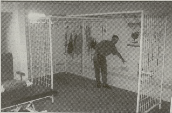
Po wodzie pozostał na ścianach grzyb.
