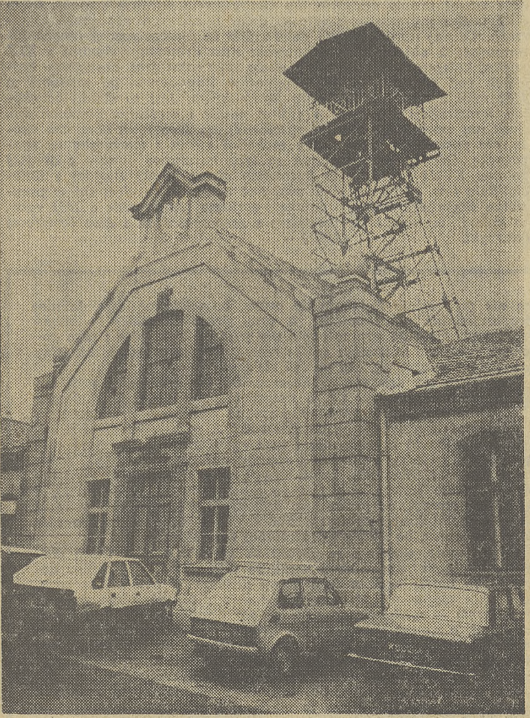
Tym szybem kuracjusze będą zjeżdżali do komory Ważyn. Obecnie szyb jest remontowany. Stuletnią, drewnianą obudowę (od 70 do ponad 200 metrów pod powierzchnią ziemi) zastępuje się trwałszą, betonową. Młodzież, która w tym roku zainauguruje działalność bocheńskiego sanatorium będzie korzystała z nowszego szybu Campi. Fot. Bogumił Opiola.
