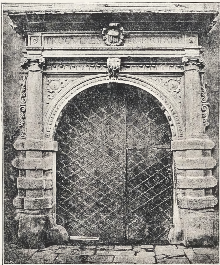
Portal domu przy ulicy Kanonicznej l. 21.
