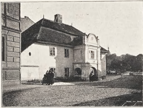
Fig. 19. Dworek przy ulicy Basztowej.
