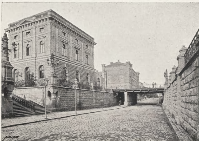
Podkop kolejowy przy ul. Lubicz.
