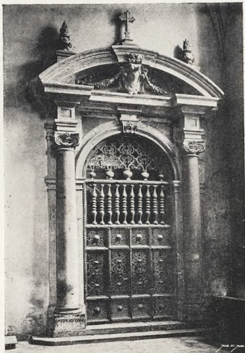
Fig. 140. Portal kaplicy ks. Lubomirskich u Dominikanów.
