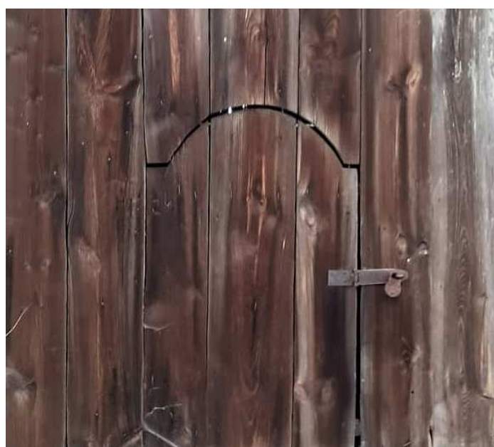
Fot. nr 376. Boczne drzwi. (02.07.2023)
