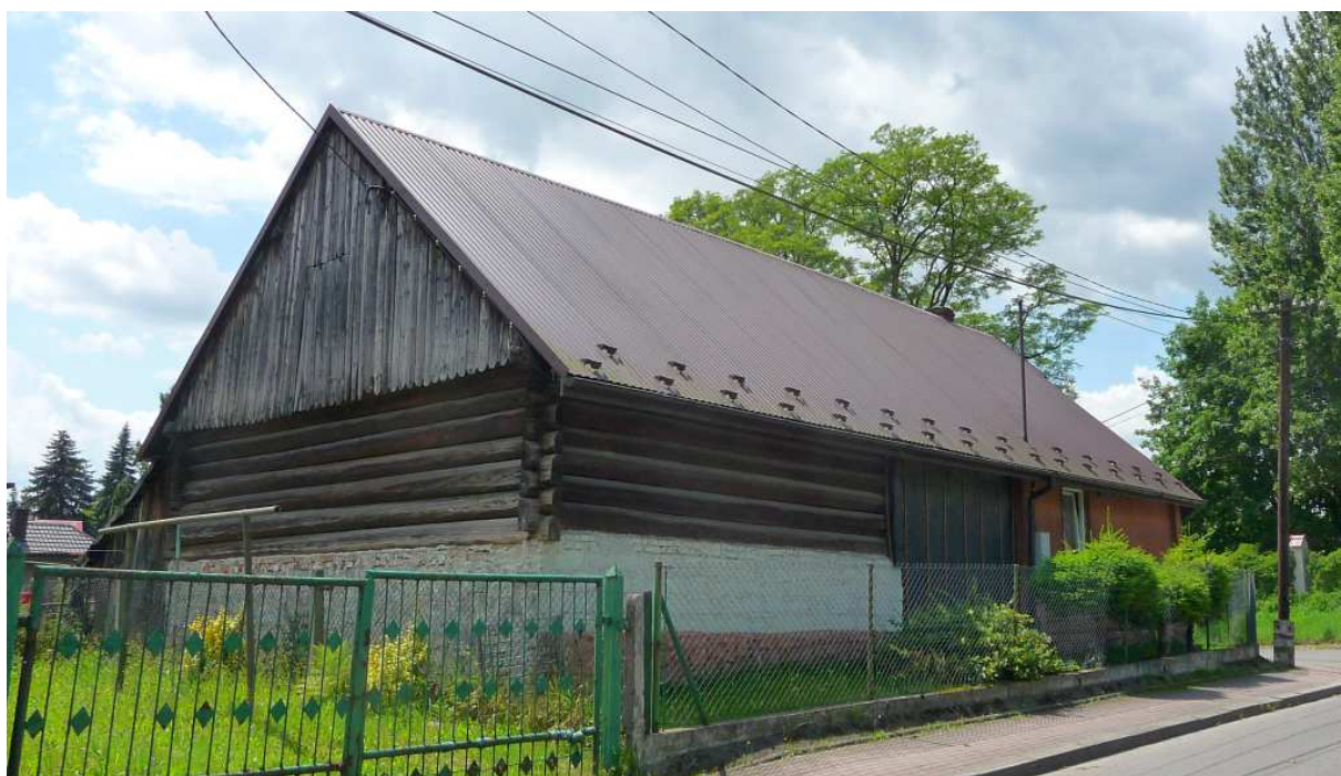
Fot. nr 415 (415-416). Tylna część od strony ulicy z oryginalnym narożnikiem o konstrukcji zrębowej. (24.06.2025)
