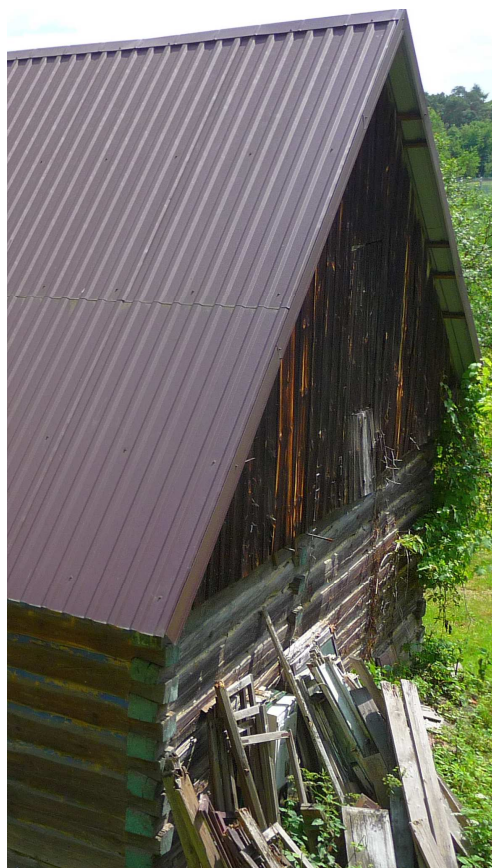
Fot. nr 398. Próba uchwycenia ściany szczytowej części mieszkalnej.
