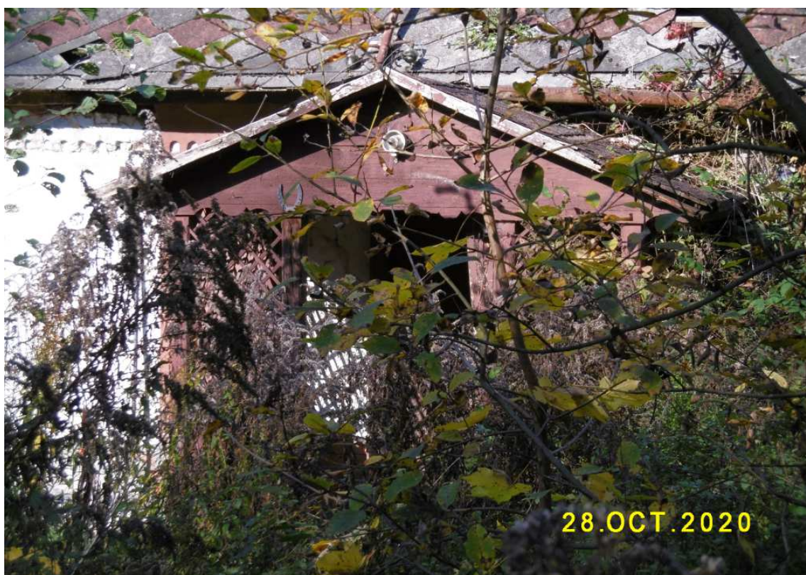
Fot. nr 120. Profilowany w drewnie ganek.
