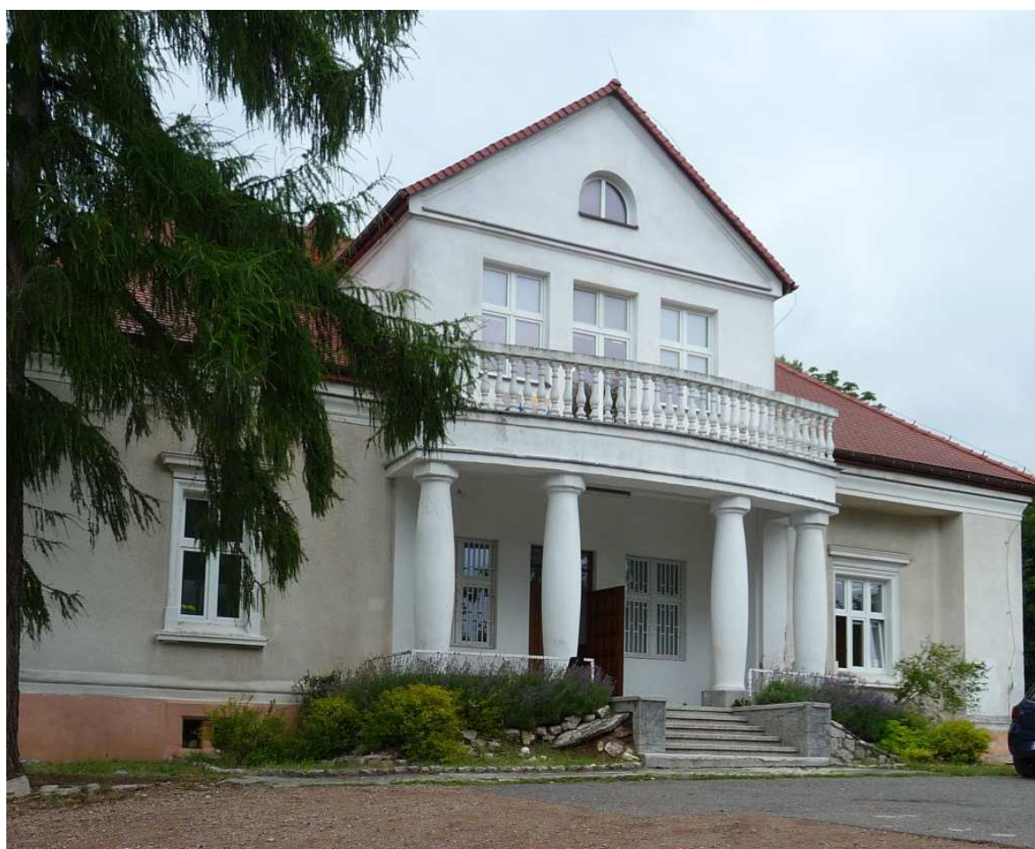
Fot. nr 477 (477-478). Fasada obiektu. (10.07.2025)
