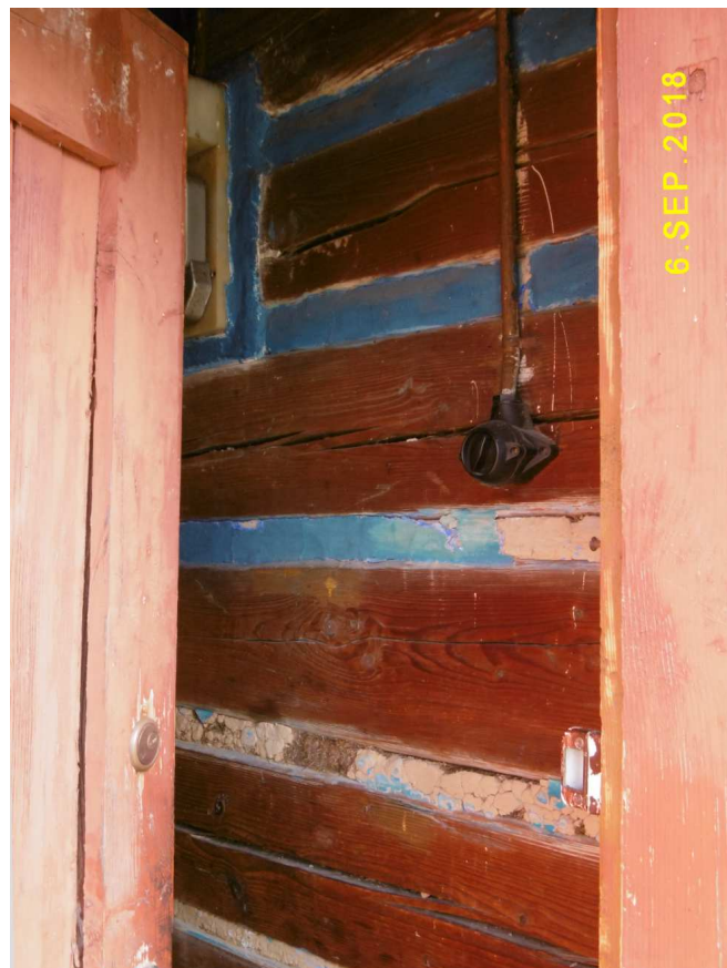
Fot. nr 212. Oryginalne malowanie sieni.
