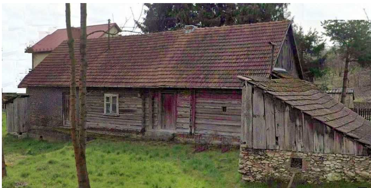
Fot. nr 424 (424-426). Zapewne jeszcze XIX-wieczna zagroda pod nr 137 na terenie tzw. Małej Morawicy.
