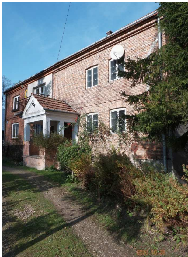
Fot. nr 131 (131-133). Murowana zagroda pod nr 118.
