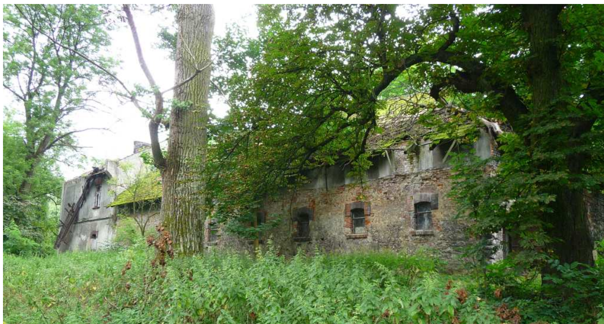
Fot. nr 510 (510-514). Zabudowania gospodarcze przylegające do oficyny. (27.07.2025)
