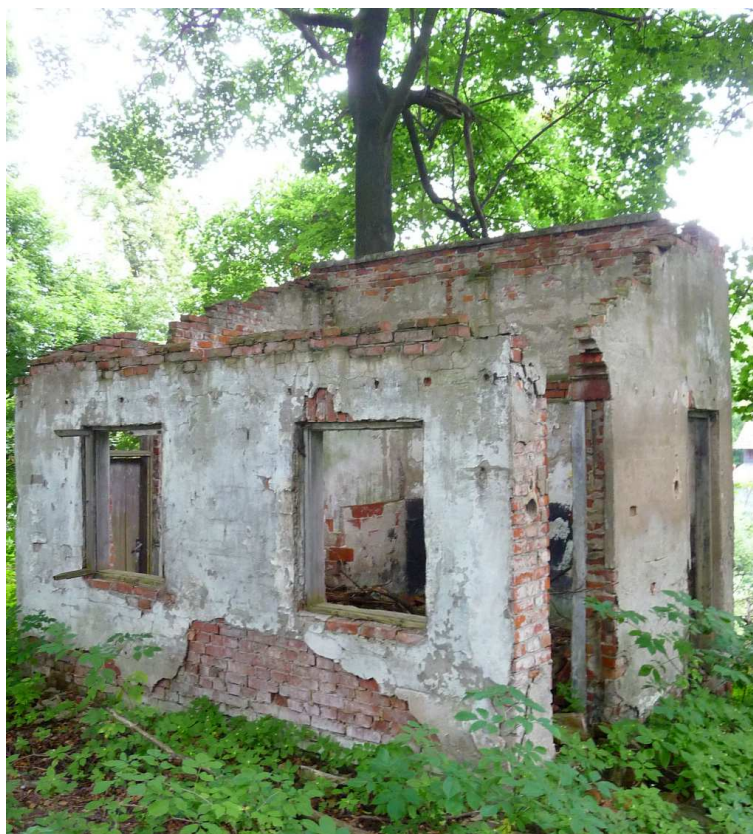
Fot. nr 521. Obiekt na tyłach pałacu (dawna wartownia?), raczej powojenny. (27.07.2025)
