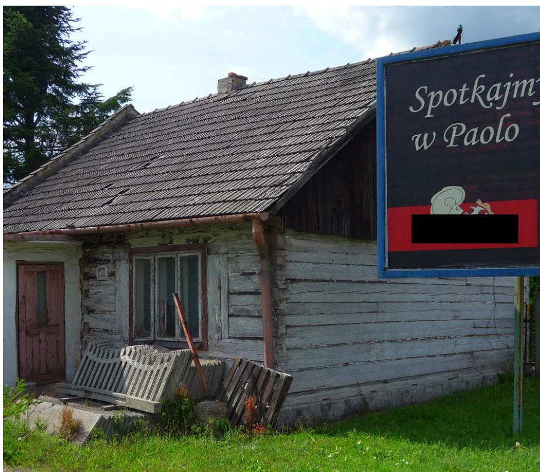
Fot. nr 547 (546-547). Widoki od strony podwórka. (29.07.2025)
