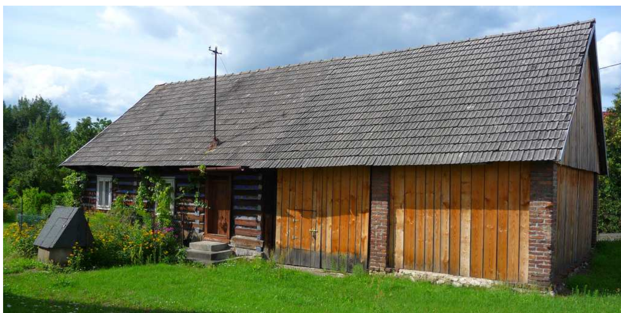
Fot. nr 543 (543-545). Zapewne ponad stuletnia chałupa spod nr 25, do której we wspólnym korpusie przylega stodoła. Obiekt przykładnie zadbane. (29.07.2025)
