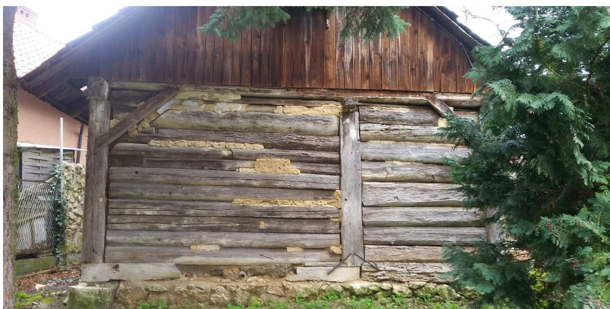
Fot. nr 386. Lewa boczna ściana.
