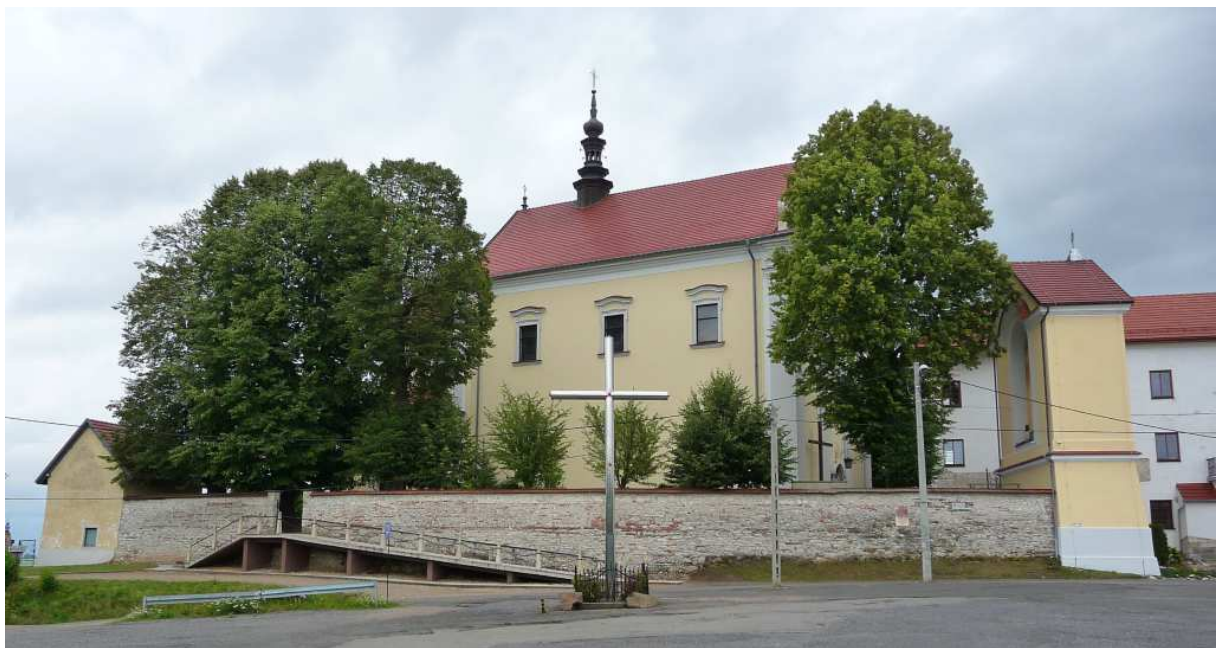
Fot. nr 465. Widok na elewację północną kościoła. (10.07.2025)
