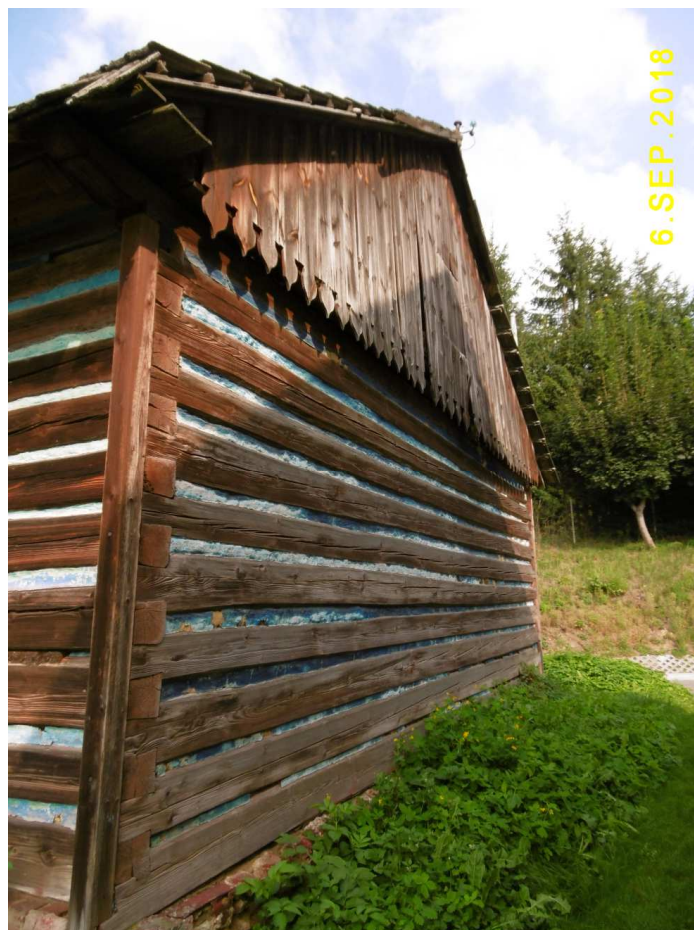
Fot. nr 207. Oryginalna, lewa ściana szczytowa.
