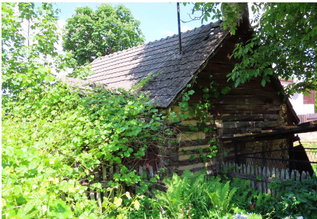
Fot. nr 244. Prawa ściana szczytowa (11.06.2021)
