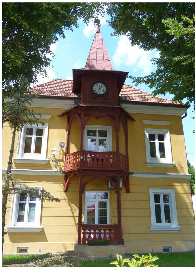
Fot. nr 422. Fasada pałacyku. (24.06.2025)
