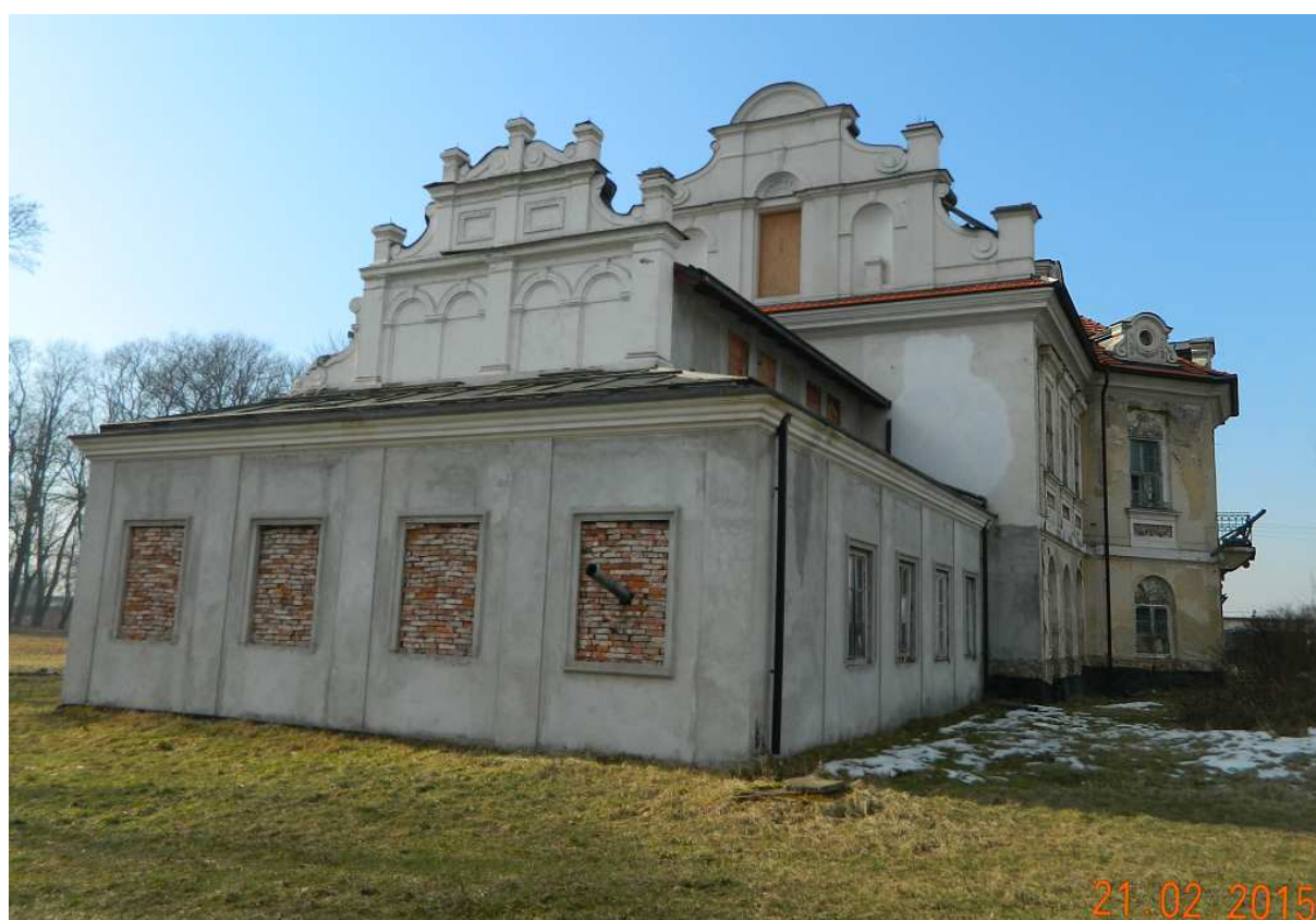
Fot. nr 20. Lewa, boczna ściana.
