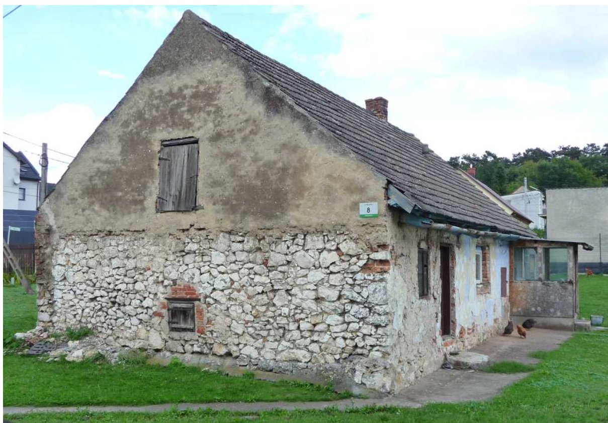
Fot. nr 539 (539-549). Wzdłuż ulicy Balickiej. Fot. nr: 539-541. Wiejski dom pod nr 8, w lewej części wybudowany z popularnego w tej okolicy, bo łatwo dostępnego, kruszywa wapiennego. (29.07.2025)
