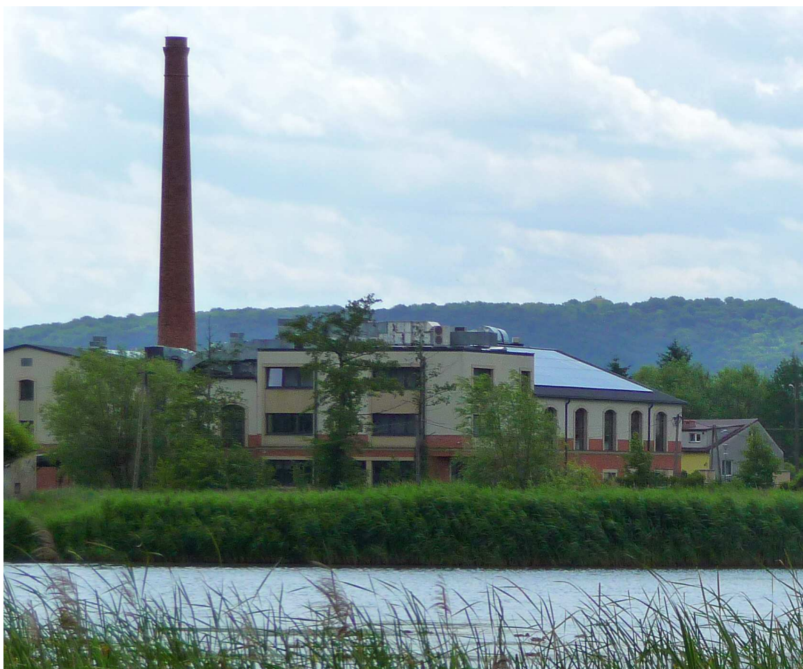
Fot. nr 392. Przykład udanej rewitalizacji zabudowań przemysłowych.
