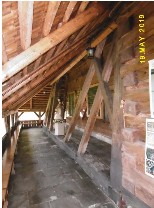
Fot. nr 342. „Soboty”, czyli przykryte pulpitowym dachem obejście opasujące kościół.
