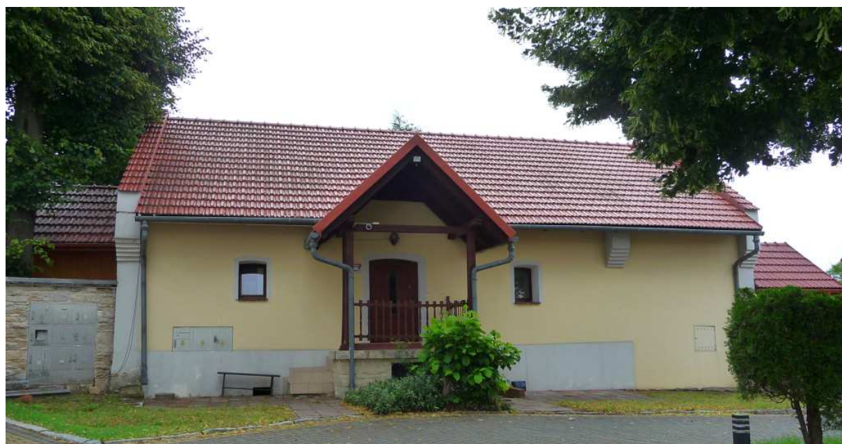
Fot. nr 463 (463-464). Zabudowania nowej plebanii na południowym dziedzińcu przy kościele. (10.07.2025)
