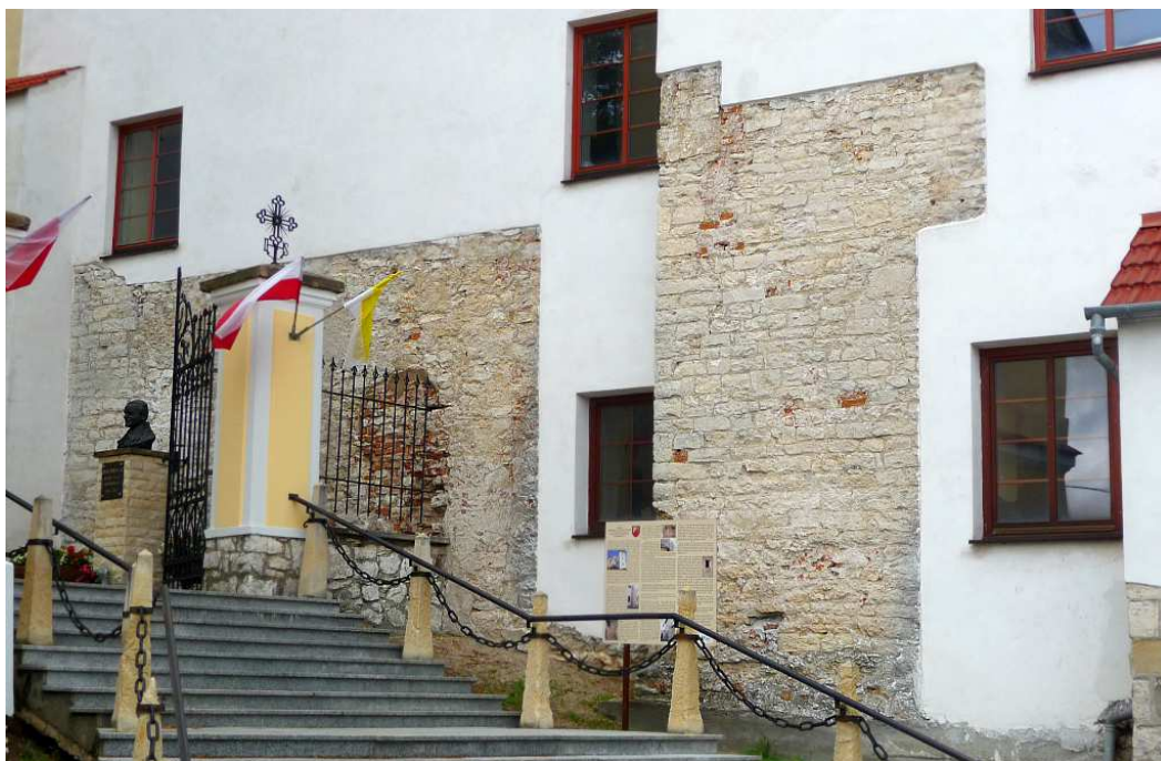
Fot. nr 456. Romańska faktura dolnej części ściany północnej. (10.07.2025)
