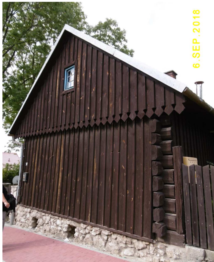
Fot. nr 168. Boczna ściana szczytowa
