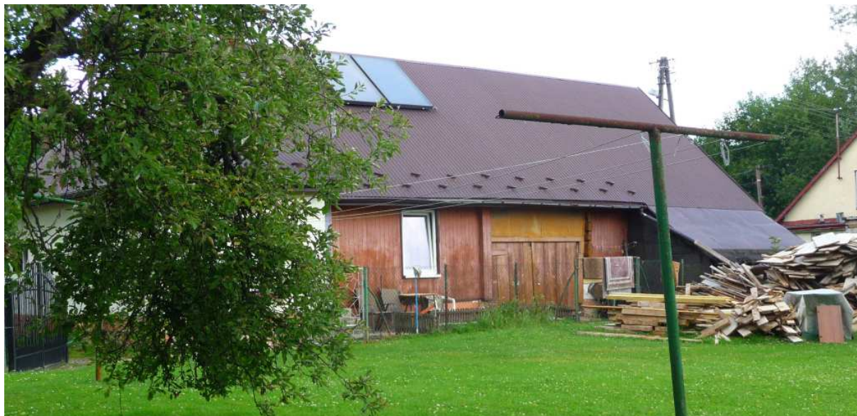
Fot. nr 414 (414-418). Nieco już zniekształcona dawna chałupa z ulicy Szkolnej 26. Fasada od strony podwórka. (24.06.2025)
