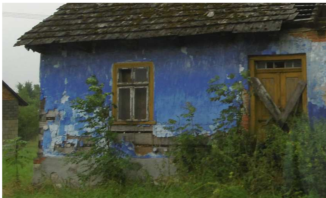
Fot. nr 140. Drewniana część mieszkalna. (31.07.2019)
