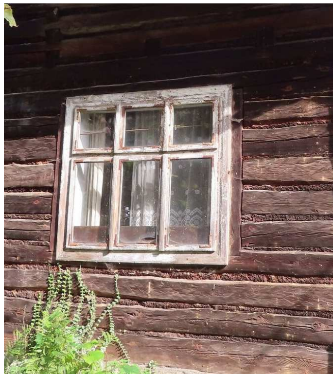
Fot. nr 380. Okno typu weneckiego w fasadzie.
