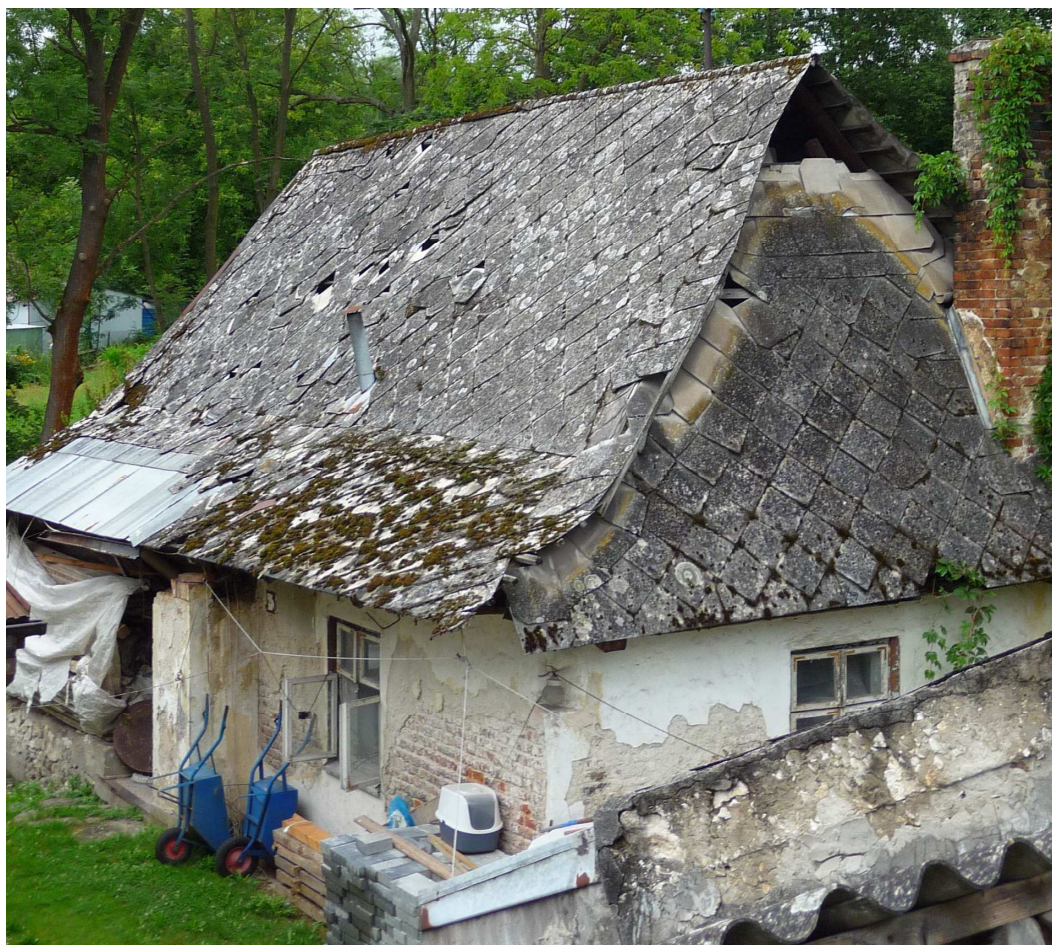
Fot. nr 488. Podwójne pokrycie dachowe dawnej chałupy, to wyższe, ochronne, wykonane z eternitu. (10.07.2025)
