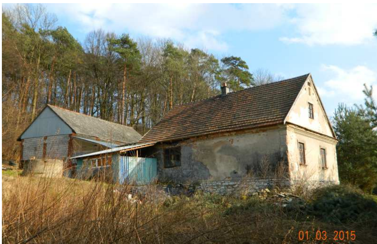
Fot. nr 157. Tylna część domu.
