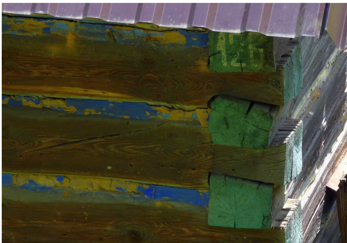
Fot. nr 396. Detale ściany w narożniku. Belki i uszczelnienie między nimi, tu glina, były malowane w innych kolorach. (24.06.2025)
