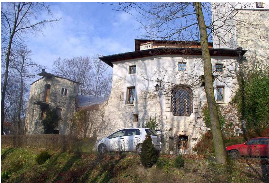
Fot. nr 257 (257-258). Rekonstrukcja części mieszkalnej dawnej warowni. (11.11.2010)
