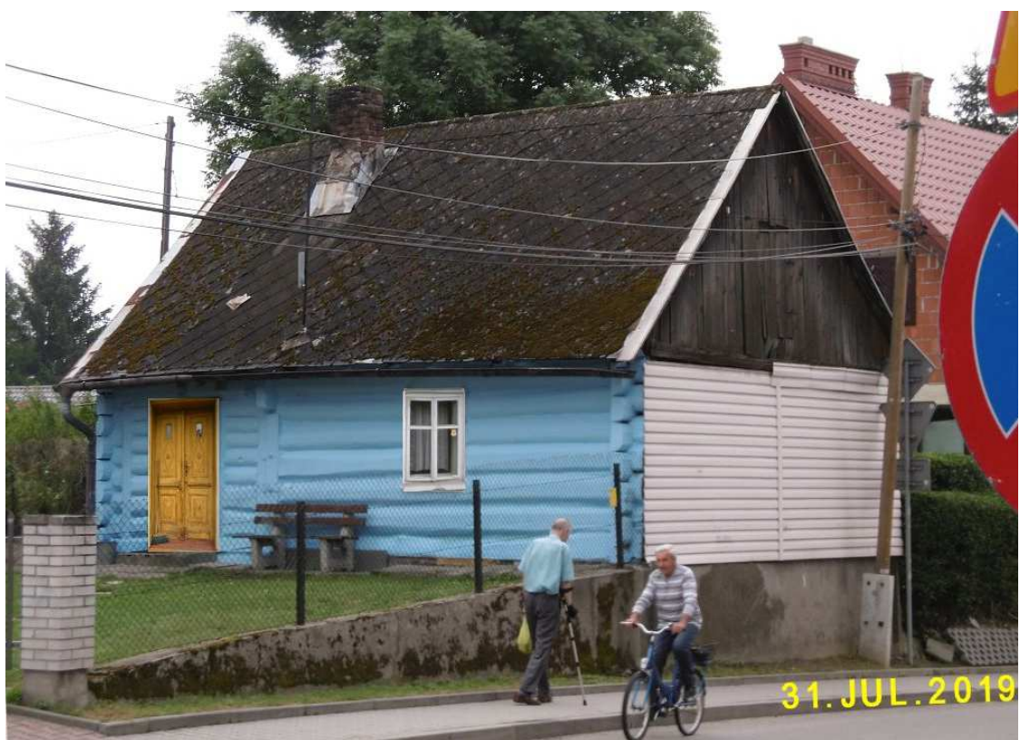
Fot. nr 48. Próba rekonstrukcji fasady.
