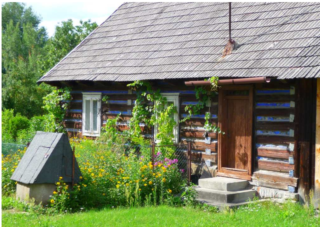
Fot. nr 544. Część mieszkalna. (29.07.2025)
