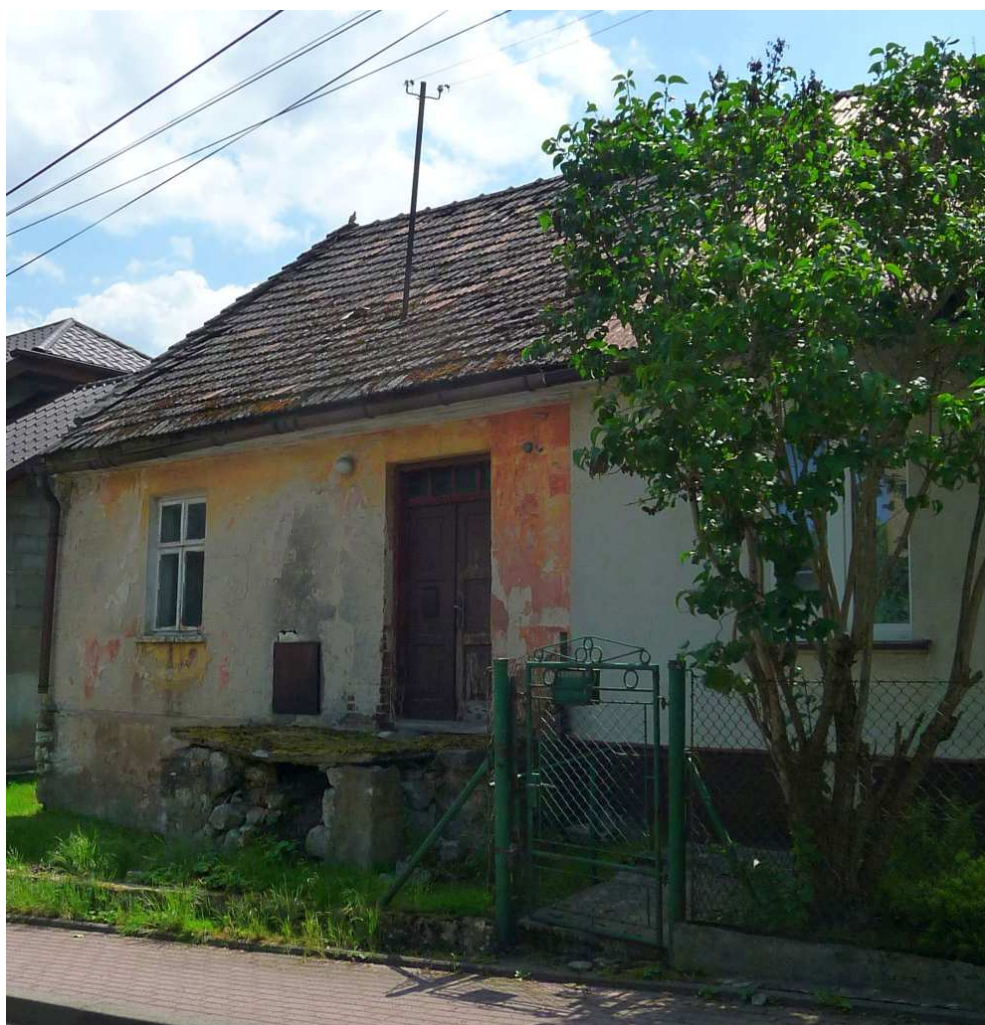
Fot. nr 419. Oryginalny, lewy fragment fasady zapewne przedwojennego domu z ulicy Szkolnej 28. (24.06.2025)
