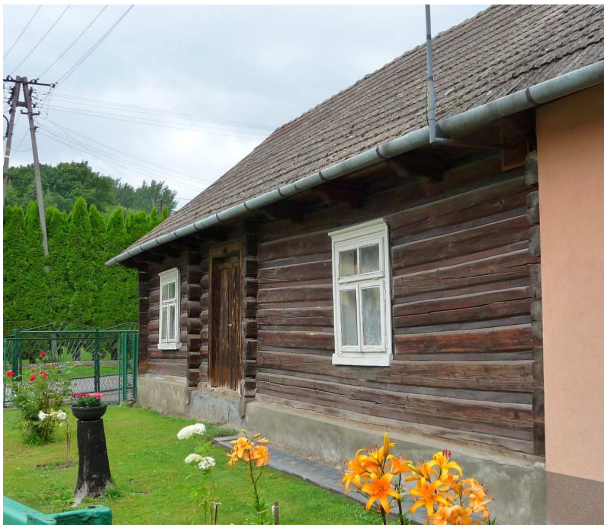
Fot. nr 447. Oryginalny fragment fasady o konstrukcji zrębowej. Okna późniejsze, zapewne z lat 30. XX wieku. (10.07.2025)
