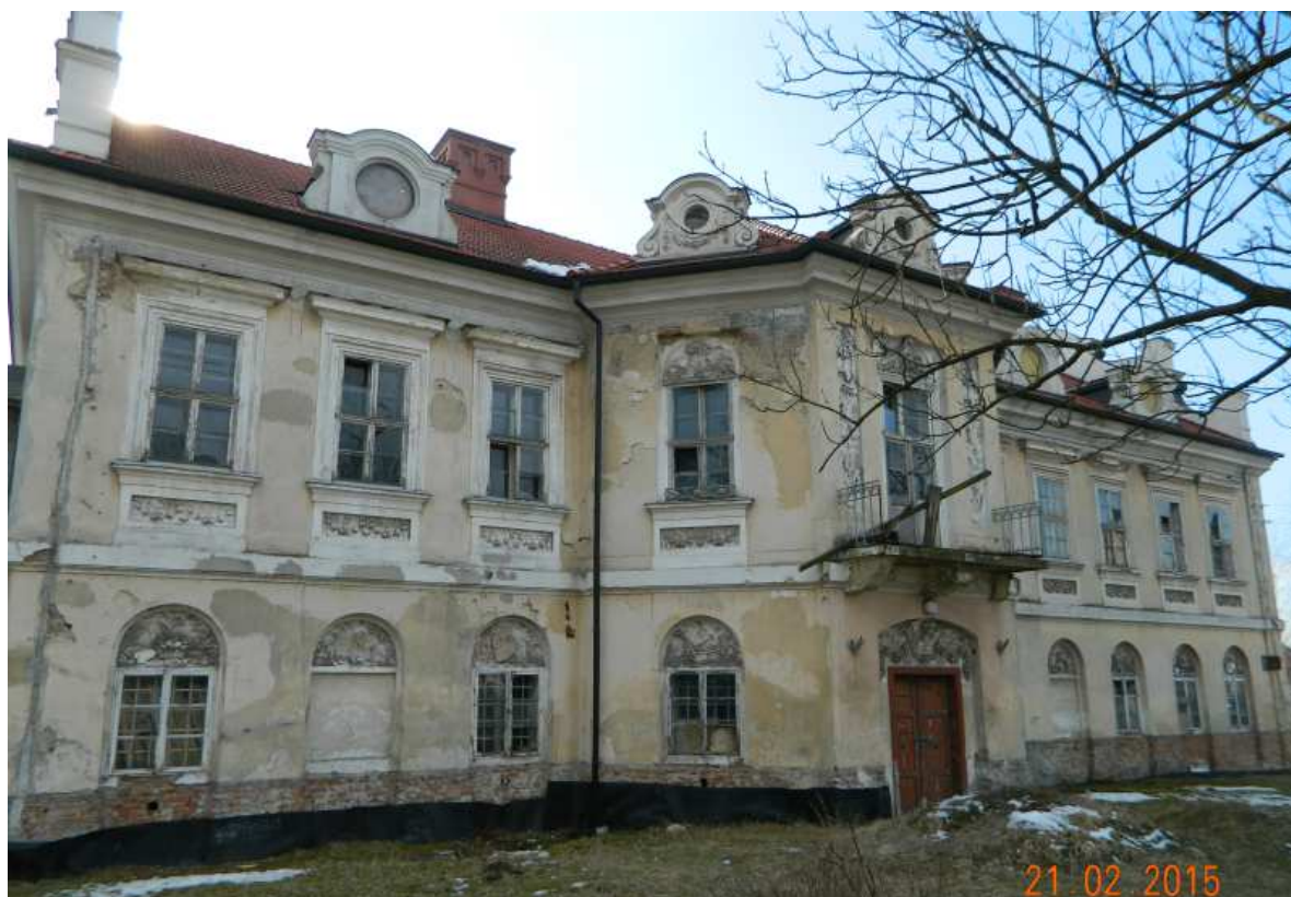
Fot. nr 17 (16-19). Fasada.
