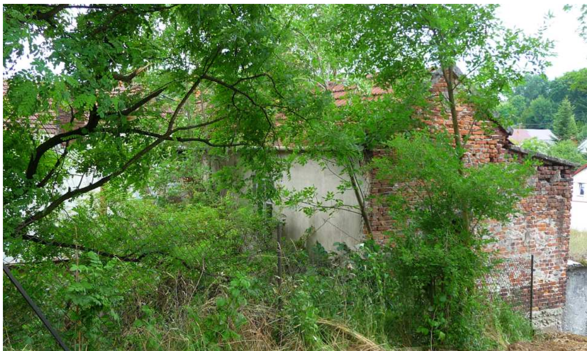
Fot. nr 432 (432-433). Widoki na tylne fragmenty kompleksu. (10.07.2025)
