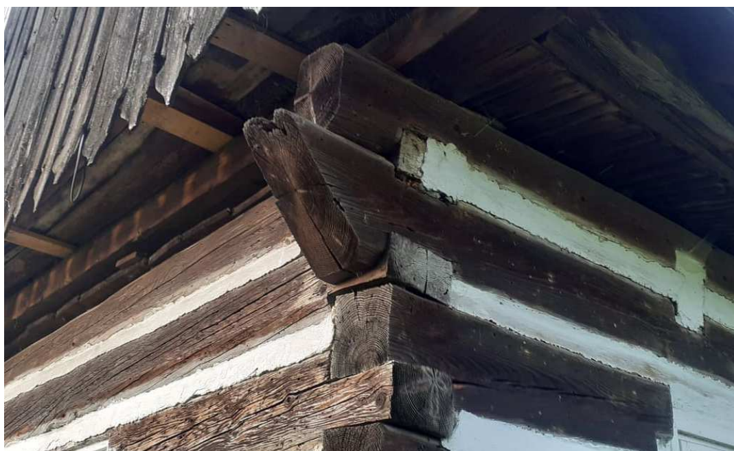
Fot. nr 370. Detale więźby dachowej. (02.07.2023)
