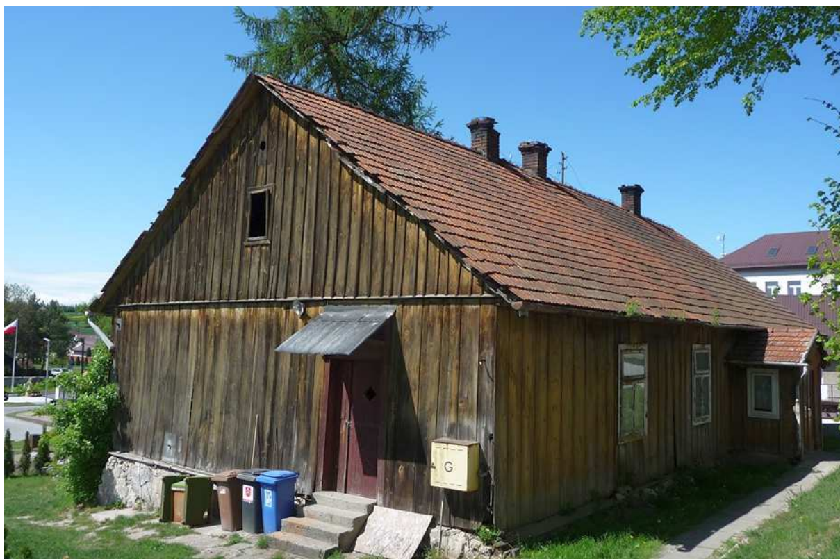
Fot. nr 267 (267-268). Tylony fragment obiektu; tu ze ścianą szczytową.
