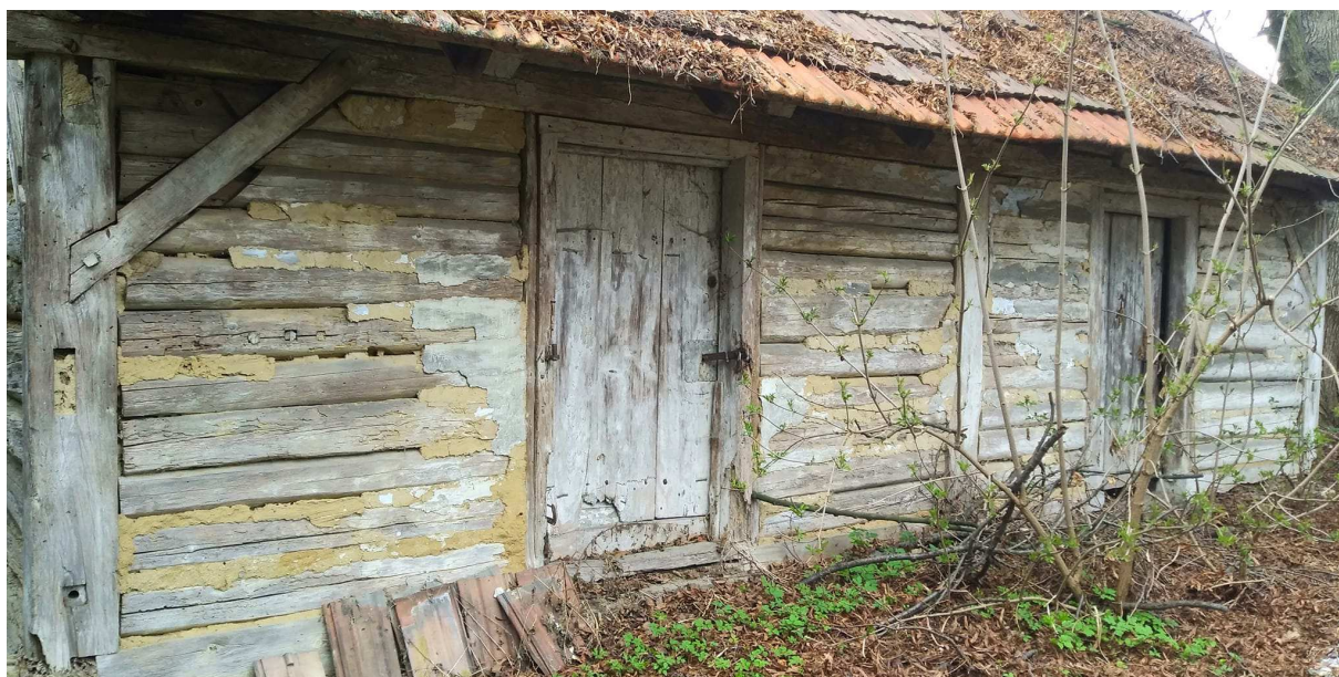
Fot. nr 384 (383-384). Widoki od strony podwórka.
