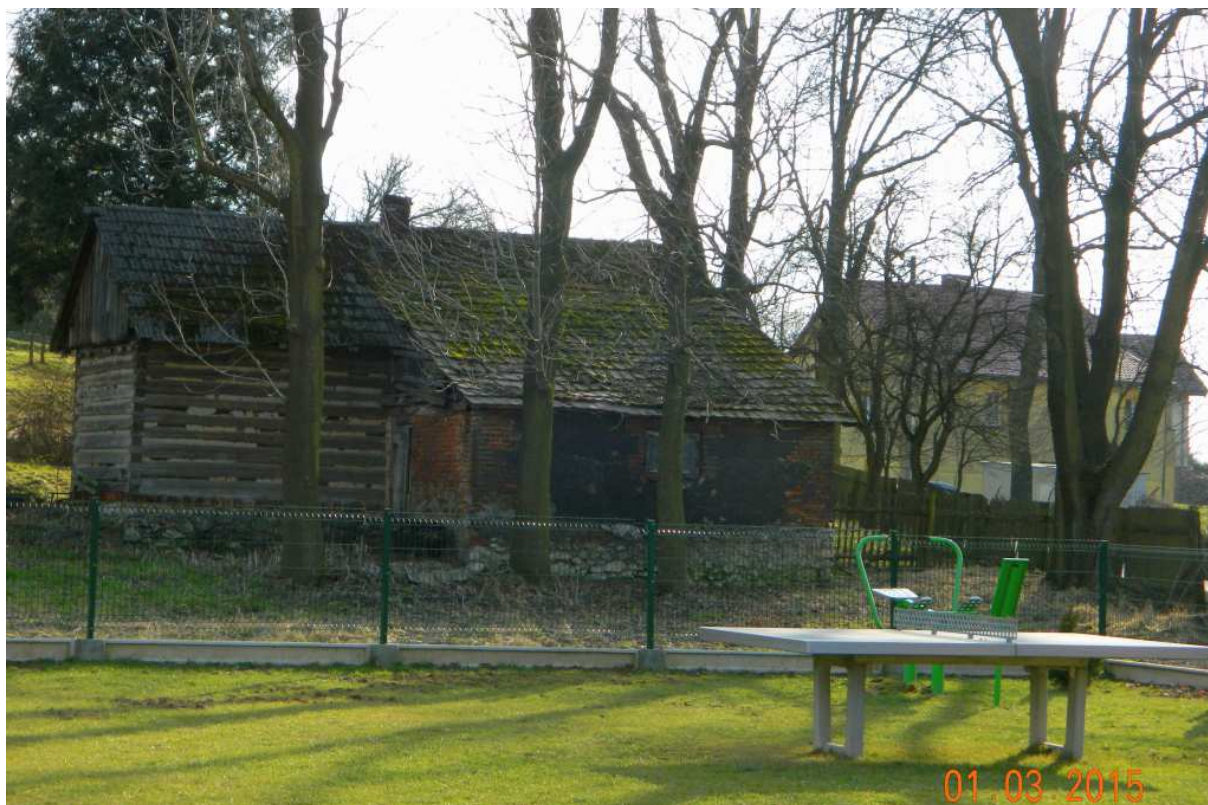
Fot. nr 188 (188-189). Tylna część od strony podwórka.
