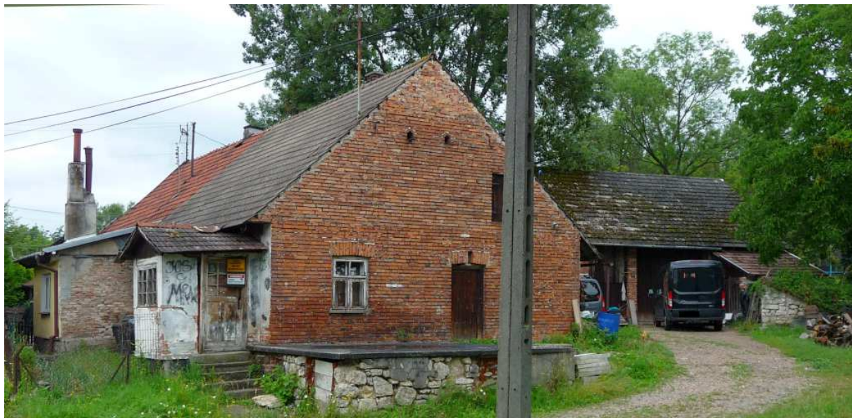
Fot. nr 482 (482-485). Przygotowana do wyburzenia zapewne przedwojenna zagroda pod nr 127. (10.07.2025)
