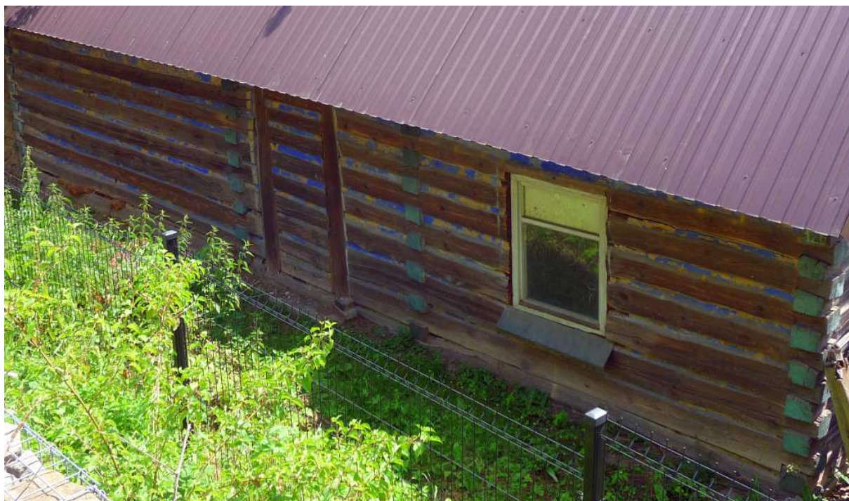
Fot. nr 395 (395-396). Fragment zapewne dawnej części mieszkalnej o konstrukcji zrębowej, zapewne części mieszkalnej. (24.06.2025)
