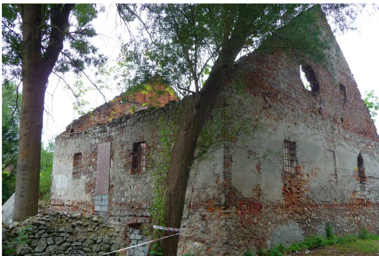
Fot. nr 531 (531-534). Budynek przylegający do drogi. (27.07.2025)
