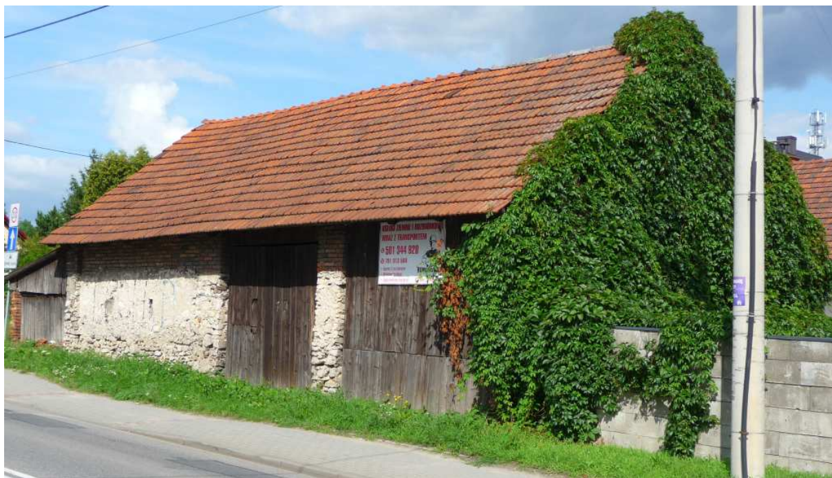
Fot. nr 542. Stodoła obok posesji pod nr 116, w narożu z ulicą Wspólną 2, również wybudowana z użyciem wapiennego kruszywa. (29.07.2025)
