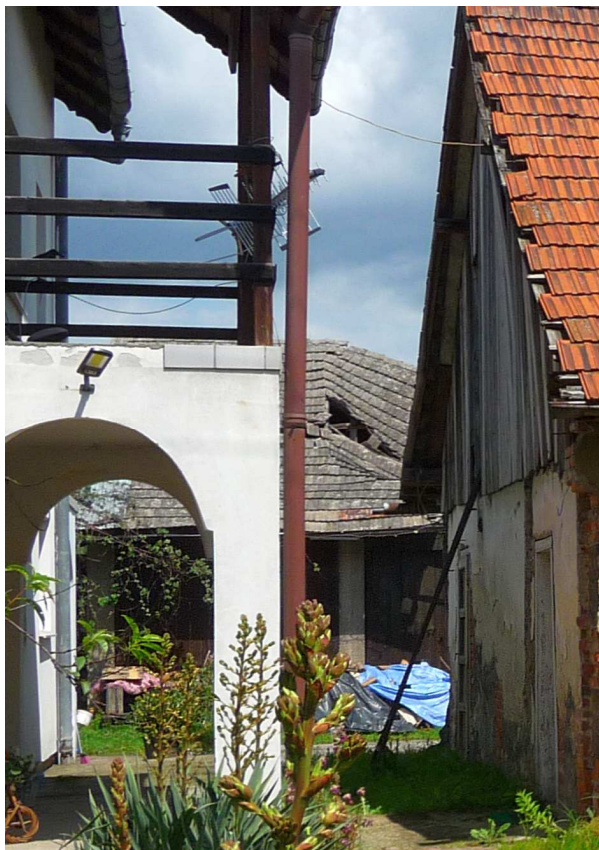
Fot. nr 403. Fragment czołowej ściany stodoły
