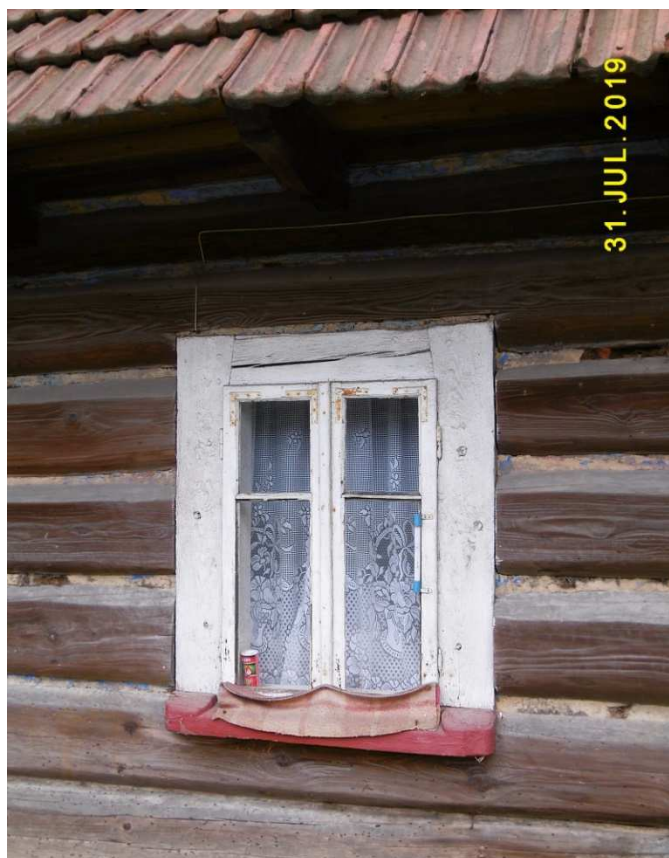
Fot. nr 32. Oryginalne okienko typu ościeżnicowego.
