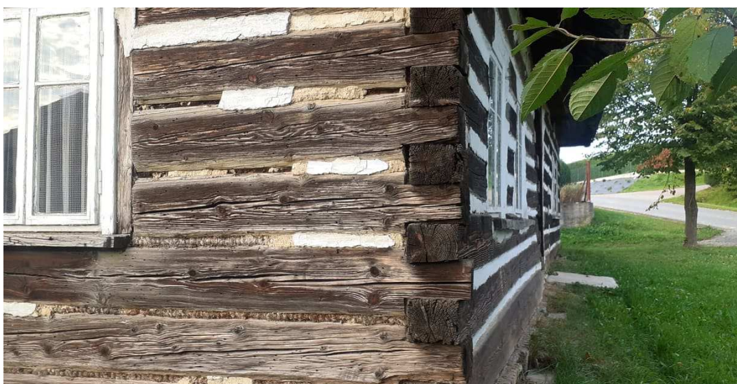
Fot. nr 368. Lewy narożnik chałupy o konstrukcji zrębowej. (02.07.2023)
