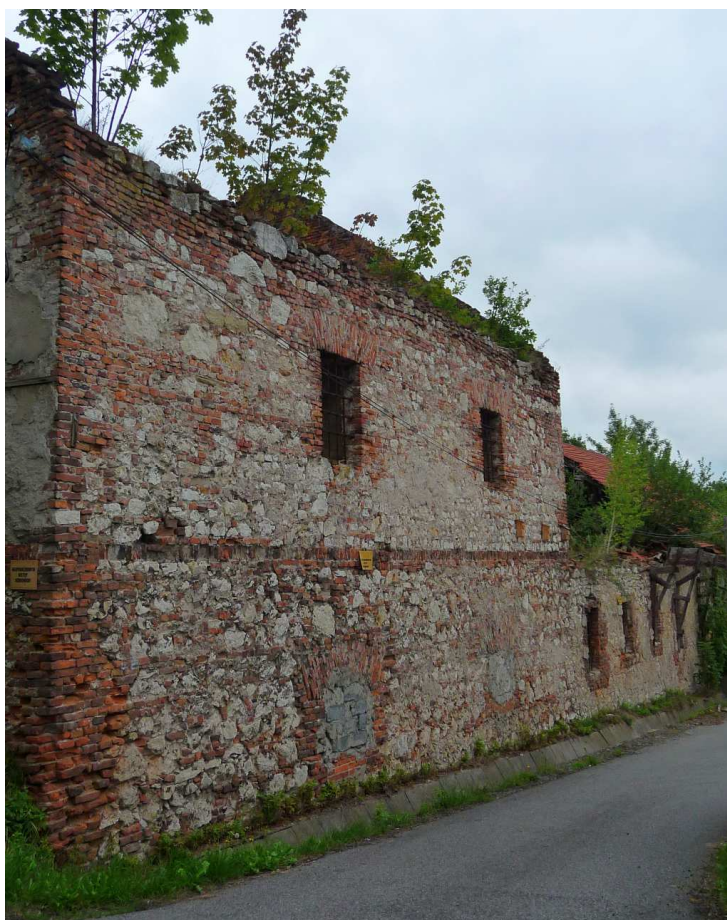
Fot. nr 533 (533-534). Zabudowania fabryczne w głębi posesji. (27.07.2025)
