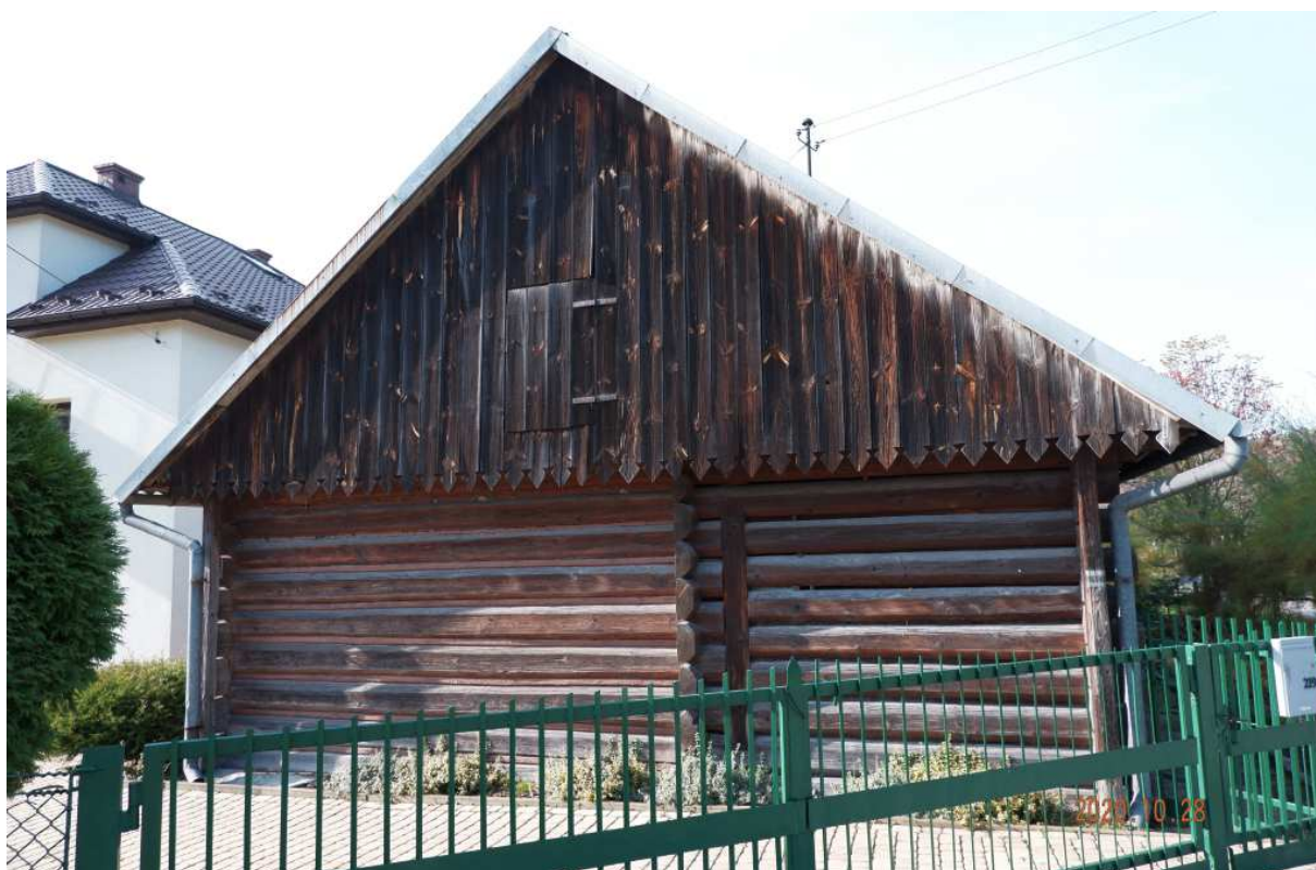
Fot. nr 98. Ściana szczytowa.
