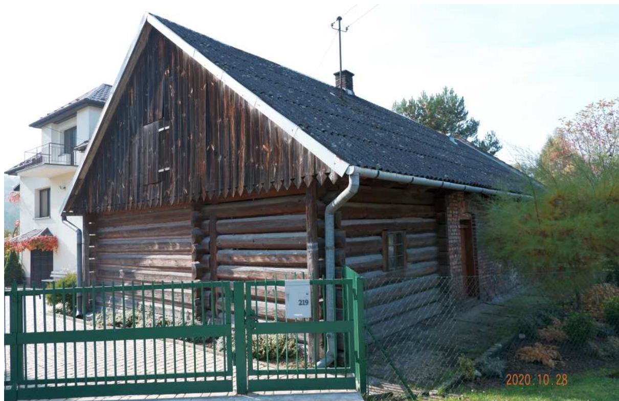
Fot. nr 99 (99-100). Widoki od strony drogi.
