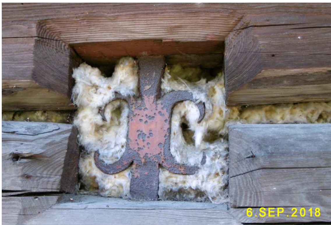
Fot. nr 202. Lufcik od stajni.
