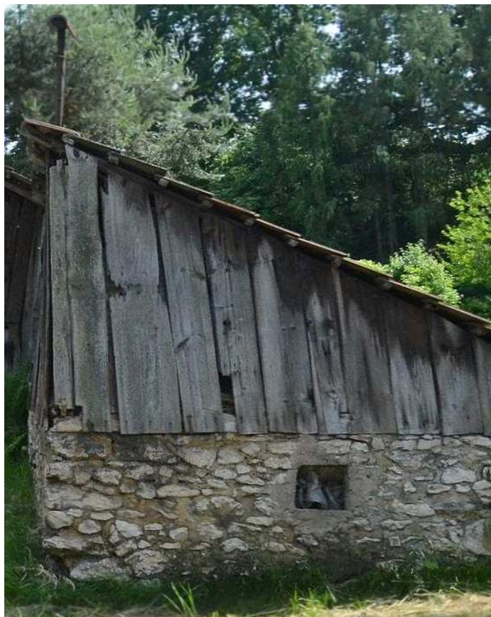
Fot. nr 426. Wykonany z wapiennych okruchów i nakryty drewnianym dachem wolnostojący budynek gospodarczy (10.07.2025)
