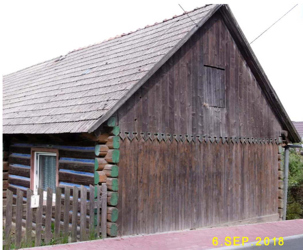
Fot. nr 180. Ściana szczytowa.
