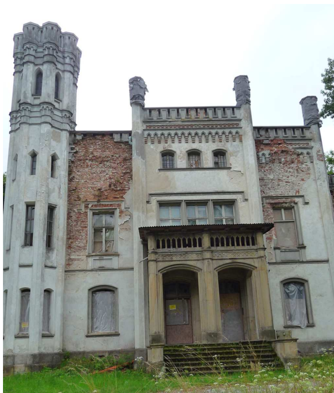
Fot. nr 517. Fasada. (27.07.2025)
