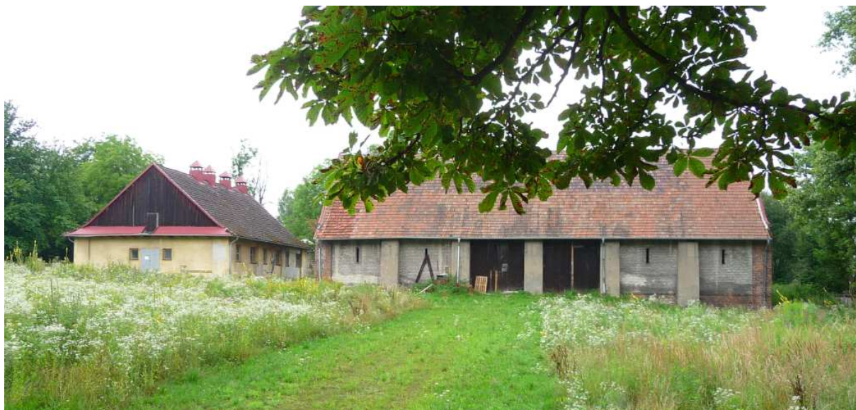
Fot. nr 525. Kompleks folwarku dworskiego w sąsiedztwie z pałacem. (27.07.2025)
