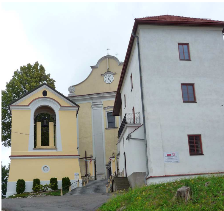
Fot. nr 454 (454-470). Wokół zespołu zamkowego, utworzonego w Średniowieczu przez ród Toporczyków, potem przynależnego do Tęczyńskich. Kościół p.w. św. Bartłomieja, pospołu z dzwonnica, został wybudowany w połowie XVIII wieku. Stoi w miejscu starej świątyni, która wchodziła w skład kompleksu dawnej warowni. (10.07.2025)
