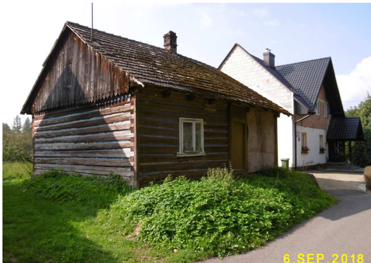
Fot. nr 205 (204-206). Fragment od strony drogi.
