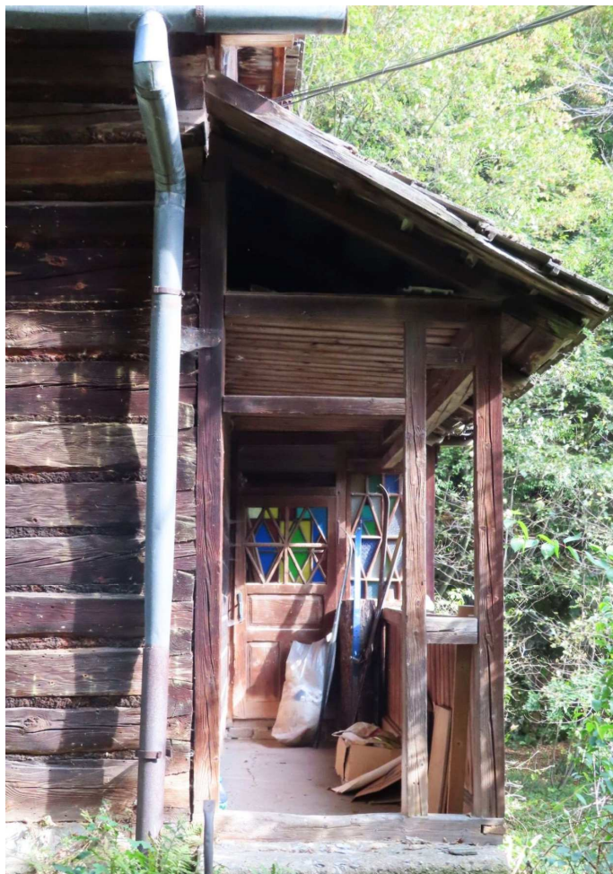
Fot. nr 381 (381-382). Częściowo odkryty przedsionek.
