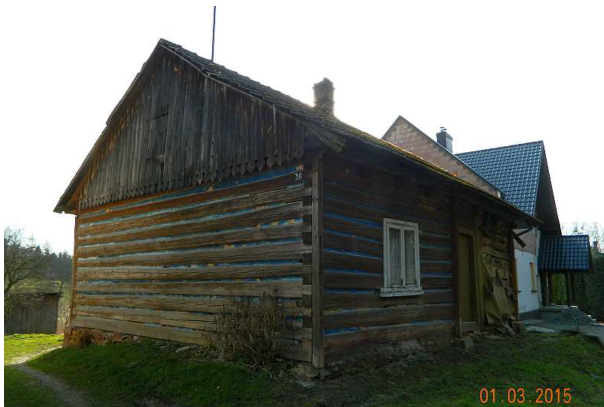
Fot. nr 204 (204-213). Skromna chałupa dwutraktowa pod nr 38, z oryginalnym belkowaniem.
