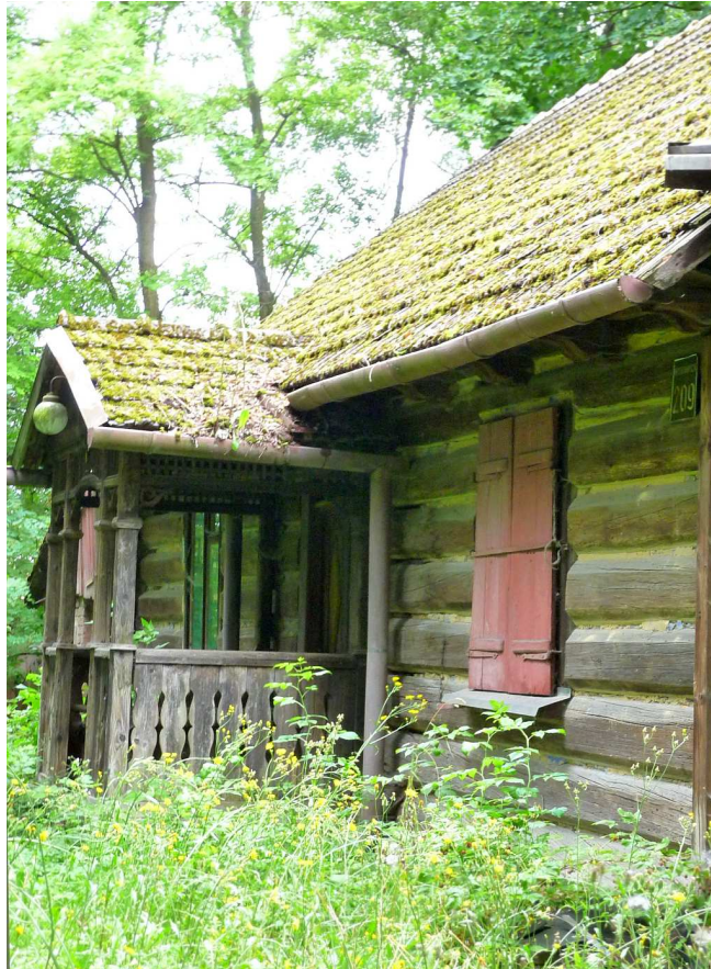
Fot. nr 496. Fasada z odkrytym gankiem. (10.07.2025)
