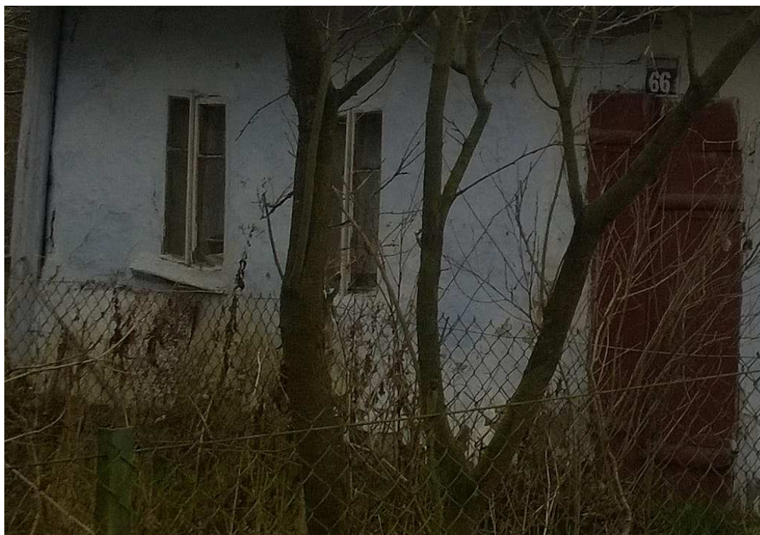
Fot. nr 349. Oryginalne detale fasady. (15.12.2014)
