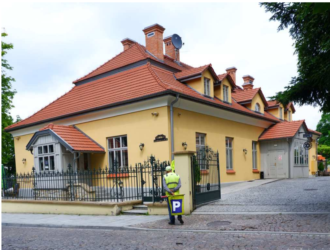
Fot. nr 112 (111-112). Elewacja południowa. (01.07.2023)
