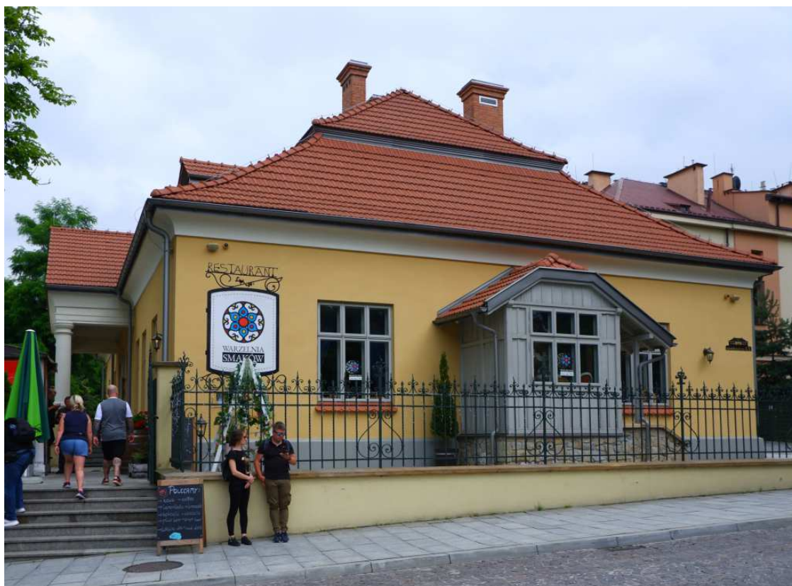
Fot. nr 113. Ściana szczytowa od strony ulicy. (01.07.2023)
