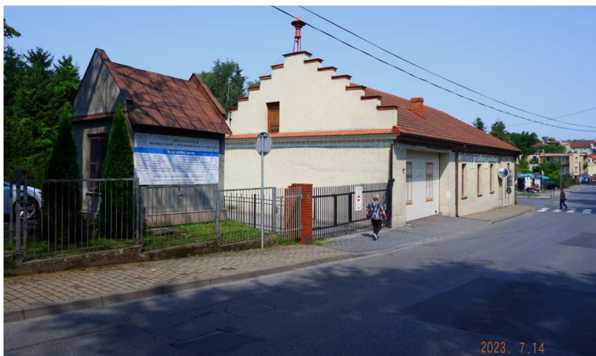
Fot. nr 73 (73-75). Ujęcia od strony ulicy Limanowskiego.
