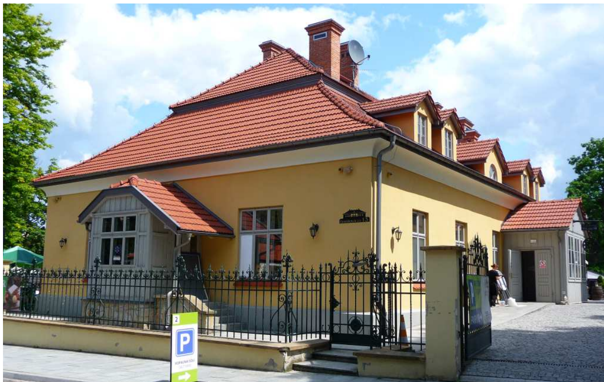
Fot. nr 266 (265-267). Ściana szczytowa od strony ulicy. (16.07.2025)
