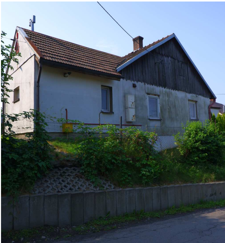
Fot. nr 188. Widok z ulicy Długiej. (14.07.2023)
