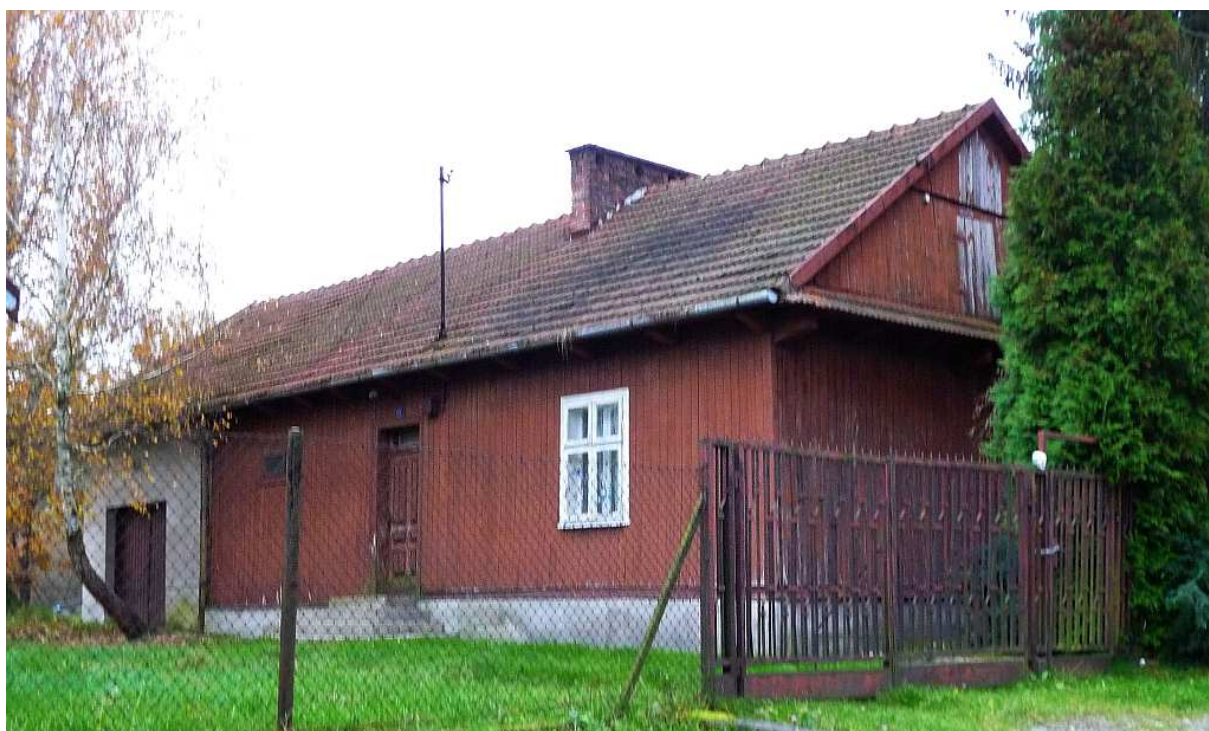
Fot. nr 396. Tylony fragment domu, którego ściany są pokryte drewnianym szalunkiem, a okno jest typu skrzynkowego. (31.10.2024)
