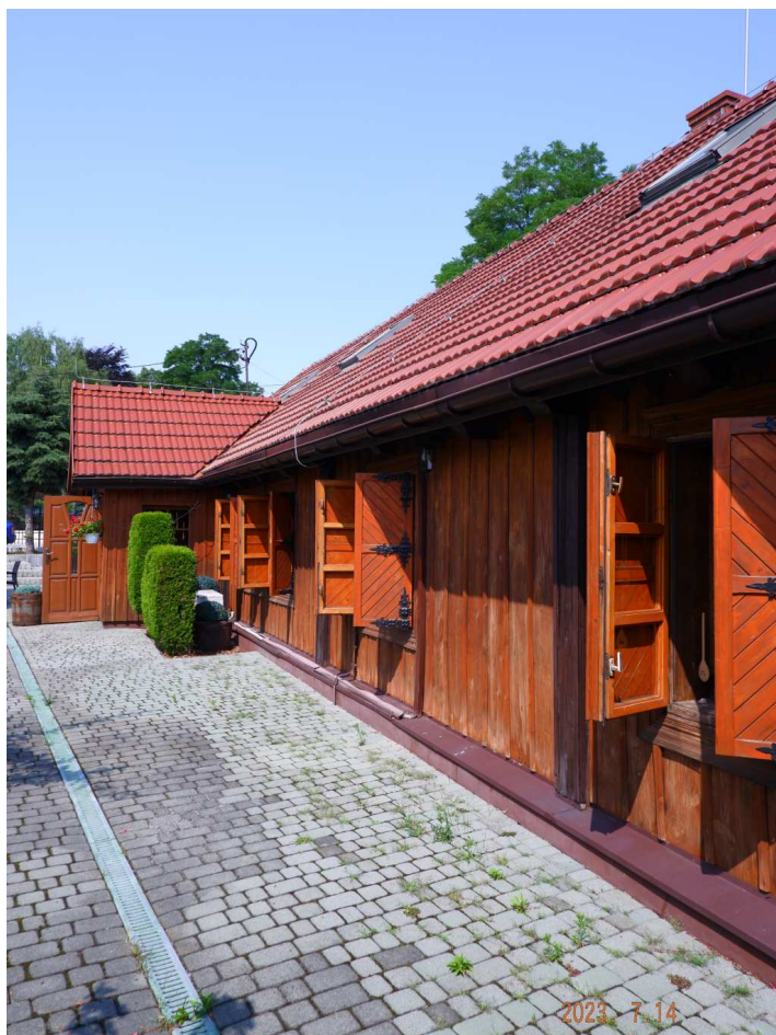
Fot. nr 102 (102-104). Elewacja południowa i jej detale.
