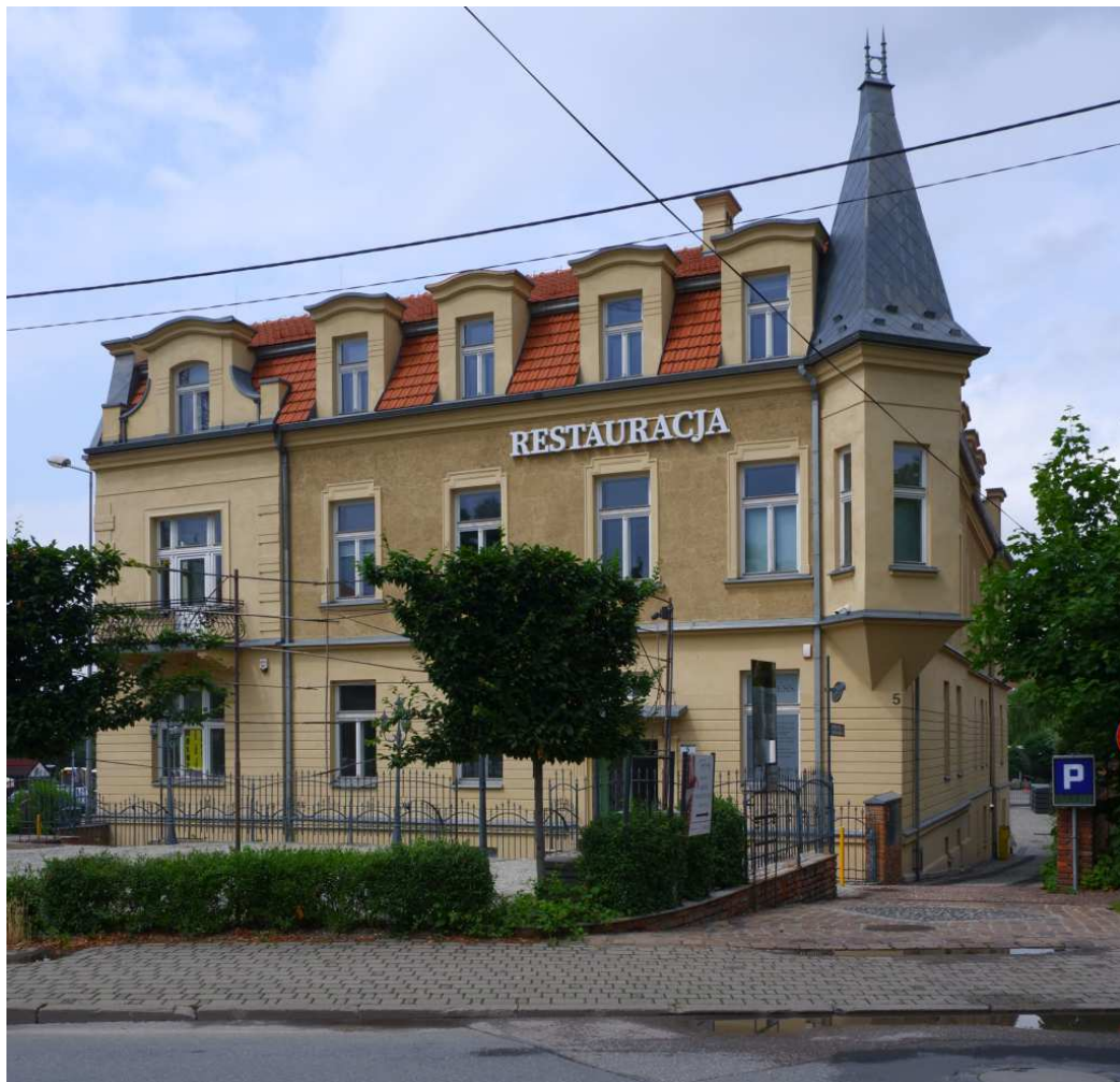
Fot. nr 135 (137-137). Fasada od strony ulicy Dembowskiego. (01.07.2023)
