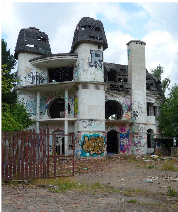
Fot. nr 345. Ruina niedokończonej willi giganta pod nr 49. Jej rozmiar i rozmach przypomina nieukończony zamek w Łapalicy na Kaszubach. (16.07.2025)
