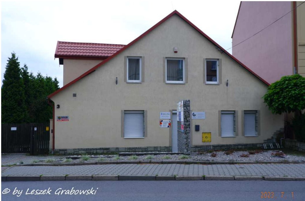
Fot. nr 44. Znacznie przebudowany już dom spod nr 3, wg GEZ datowany na okolice roku 1874.
