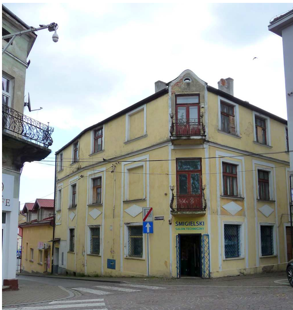
Fot. nr 313. Kamienica z roku 1928 przy ulicy Bednarka 2. (14.04.2025)
