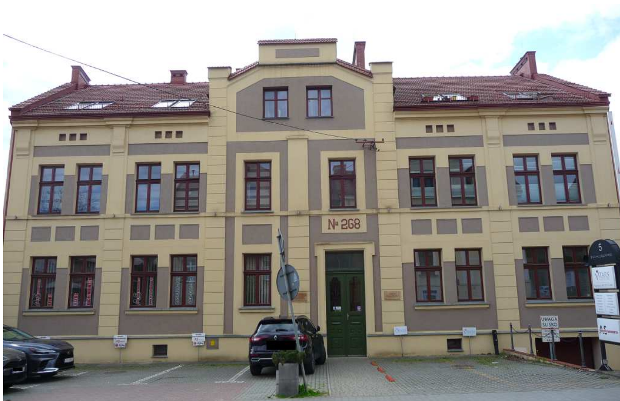
Fot. nr 325 (325-330). Wzdłuż ulicy Kosiby. Odnowiona kamienica pod nr 5, wybudowana w roku 1912. (14.04.2025)
