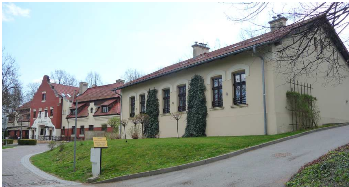
Fot. nr 256. Zespół Hotelu Grand Sal w Parku Kingi 7. Z prawej dawny budynek TG Sokół, wybudowany w roku 1892, z którego pozostała oryginalna ściana frontowa. (14.04.2025)
