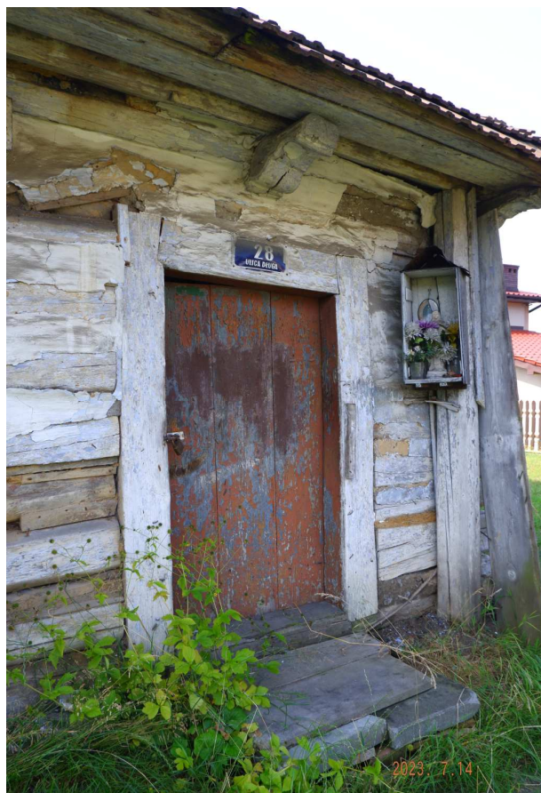
Fot. nr 178 (178-179). Detale fasady. Oryginalne drzwi.
