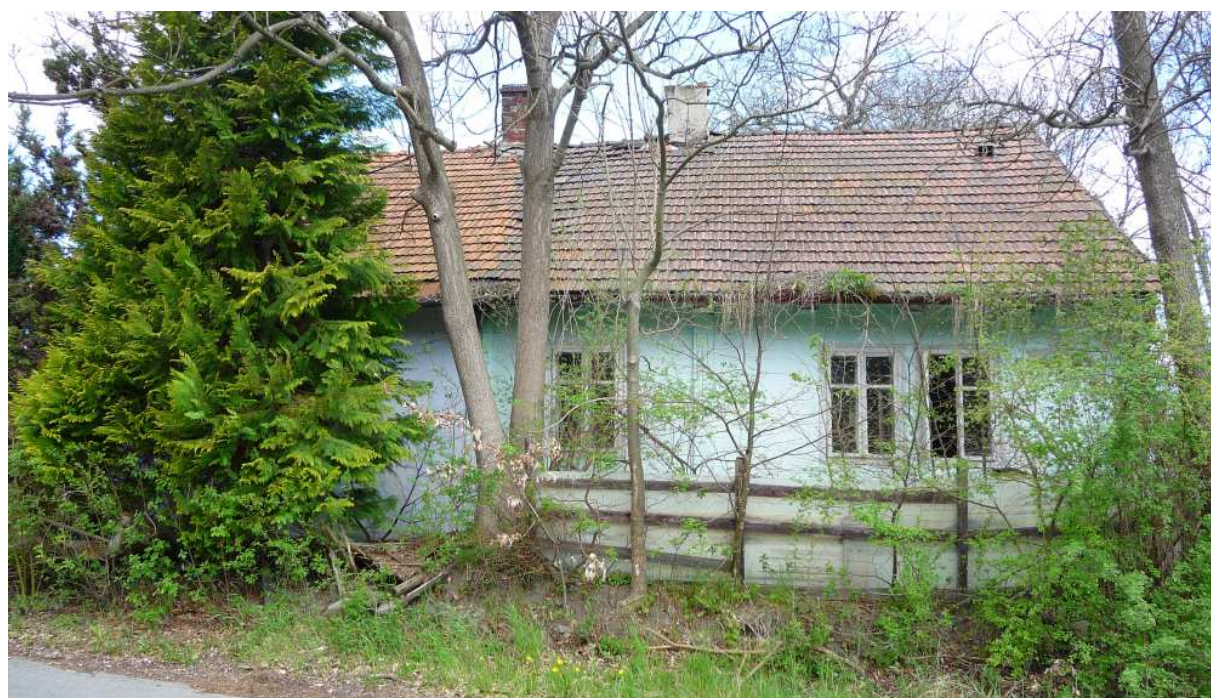
Fot. nr 249. Fasada od strony ulicy Nowy Świat. (14.04.2025)
