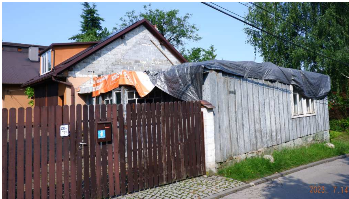
Fot. nr 192 (192-193). Może ostatnie spojrzenia na fasadę z gankiem.
