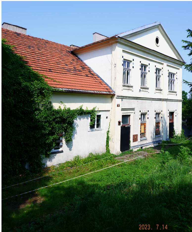
Fot. nr 96 (96-97). Dom pod nr 19, wybudowany na początku XX wieku.
