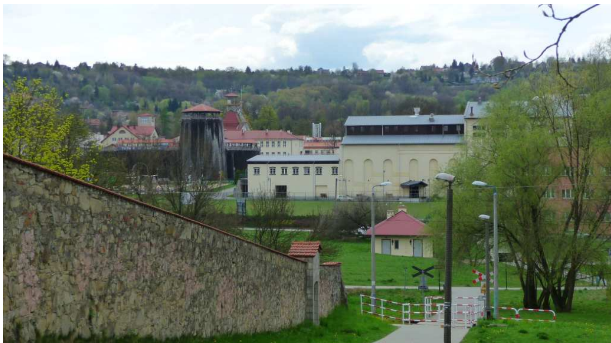
Fot. nr 334. Widok spod kościoła na zabudowania KSW. (14.04.2025)
