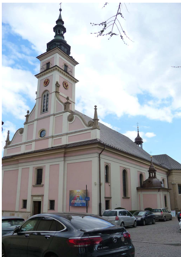
Fot. nr 293. Fasada – widok z ulicy Zamkowej. (14.04.2025)
