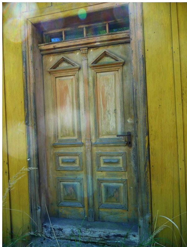
Fot. nr 463. Bogato profilowane drzwi. (10.05.2026)
