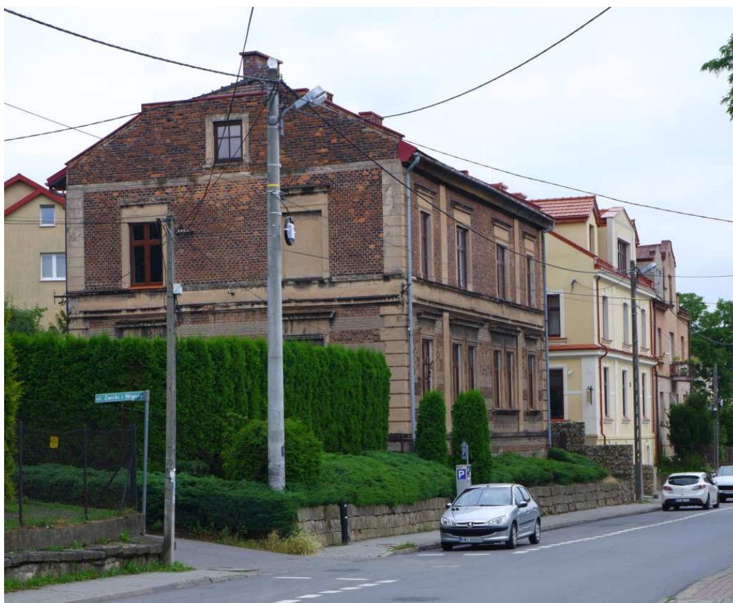
Fot. nr 39 (39-41). Domy spod nr: 6 i 8. (01.07.2023)
