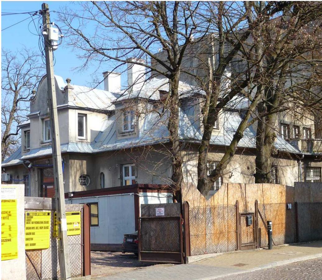
Fot. nr 437 (437-440). Wzdłuż ulicy Kilińskiego. Stuletnia willa pod nr 5, opuszczona przez posterunek Policji, na etapie generalnego remontu. (12.03.2026)
