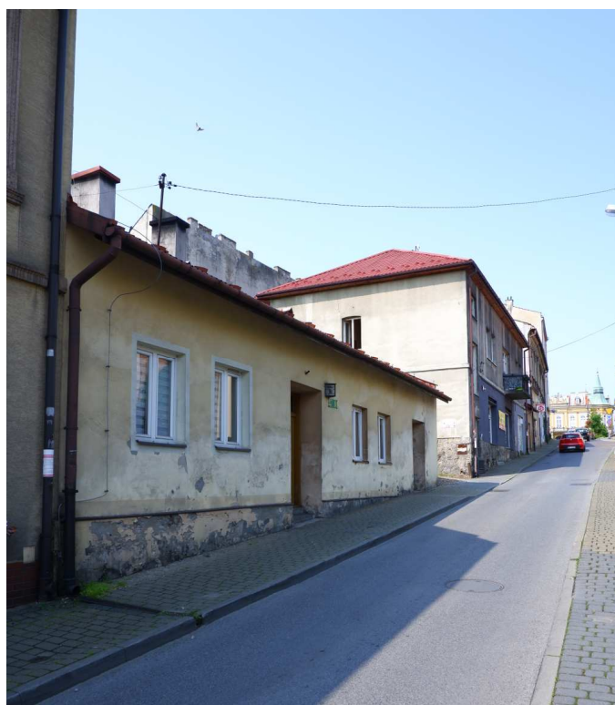
Fot. nr 85. Pierzeja o nieparzystych numerach poniżej domu pod nr 9. (14.07.2023)
