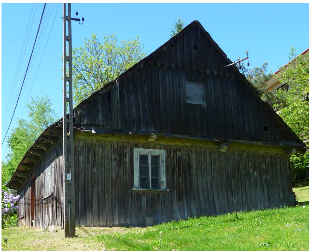
Fot. nr 489. Ściana szczytowa. (10.05.2026)
