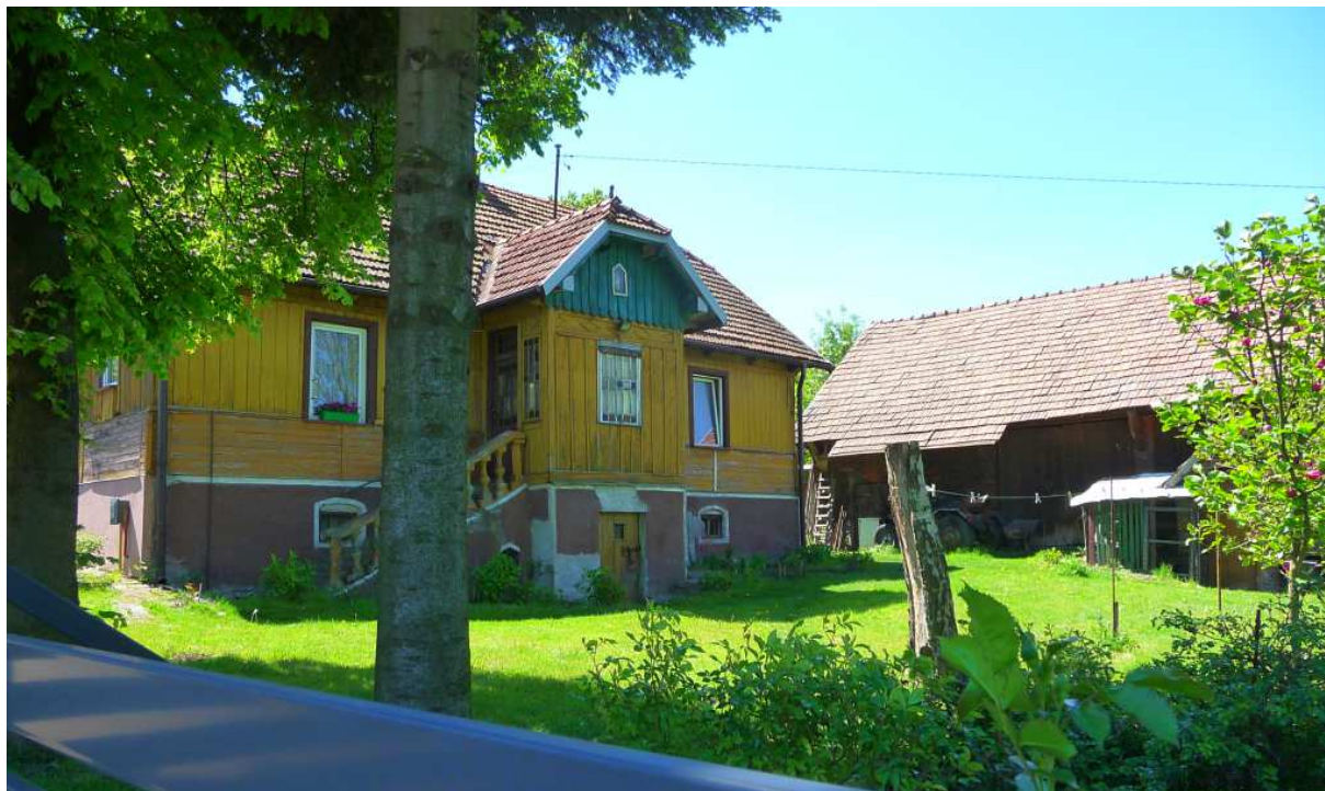
Fot. nr 470 (470-473). Zapewne blisko 100-letni, bliski oryginałowi dom w zagrodzie pod nr 69. (10.05.2026)
