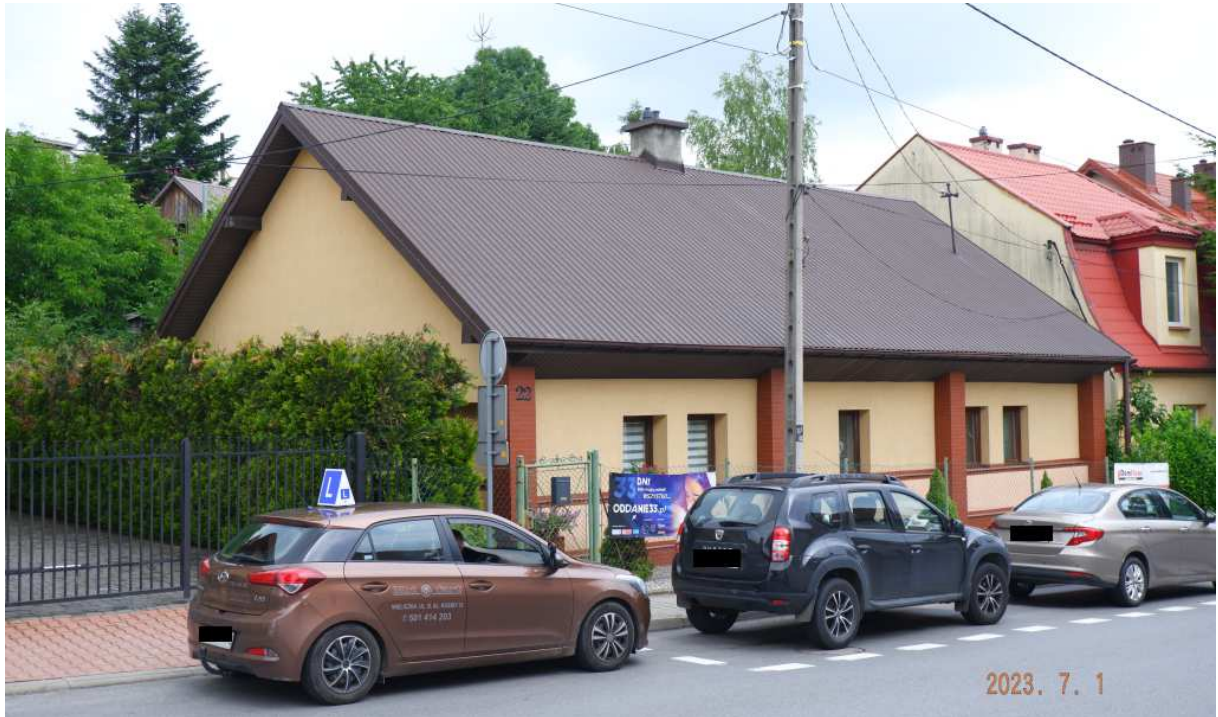
Fot. nr 37. Przebudowana chałupa z I poł. XIX wieku spod nr 22.
