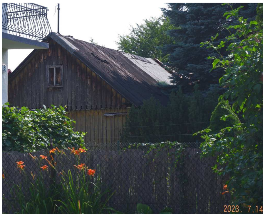
Fot. nr 209. Ściana szczytowa.
