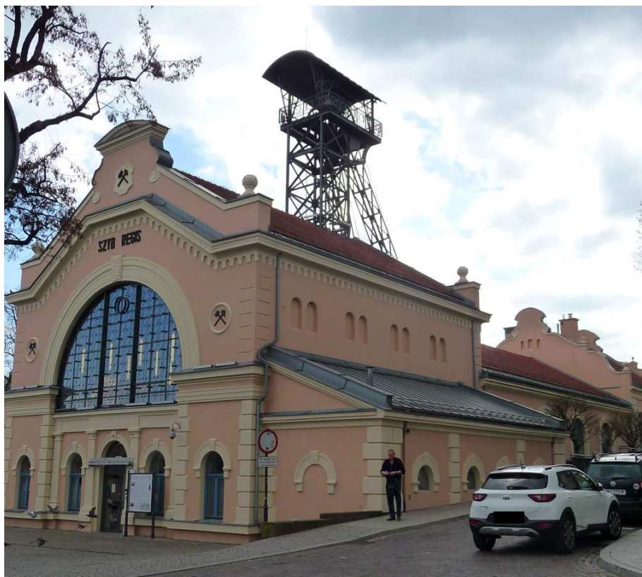
Fot. nr 316 (316-317). Szyb Regis KSW przy placu Kościuszki 9. Nadszybie z lat 1860-61. Do 1938 roku działał w nim młyn solny. (14.04.2025)
