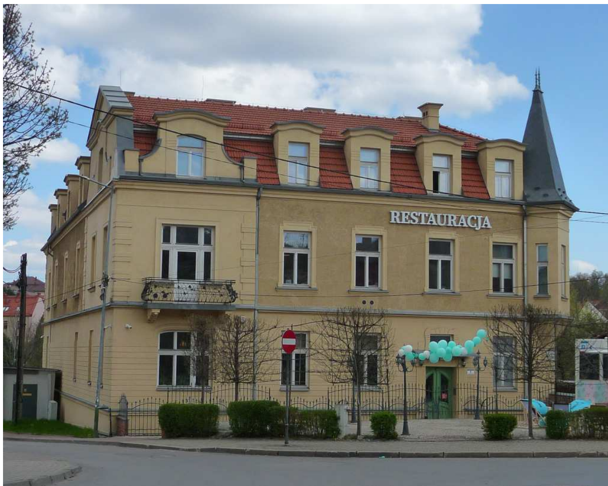
Fot. nr 280. Eklektyczna kamienica, zapewne z początku XX wieku, przy ulicy Dembowskiego 5. (14.04.2025)
