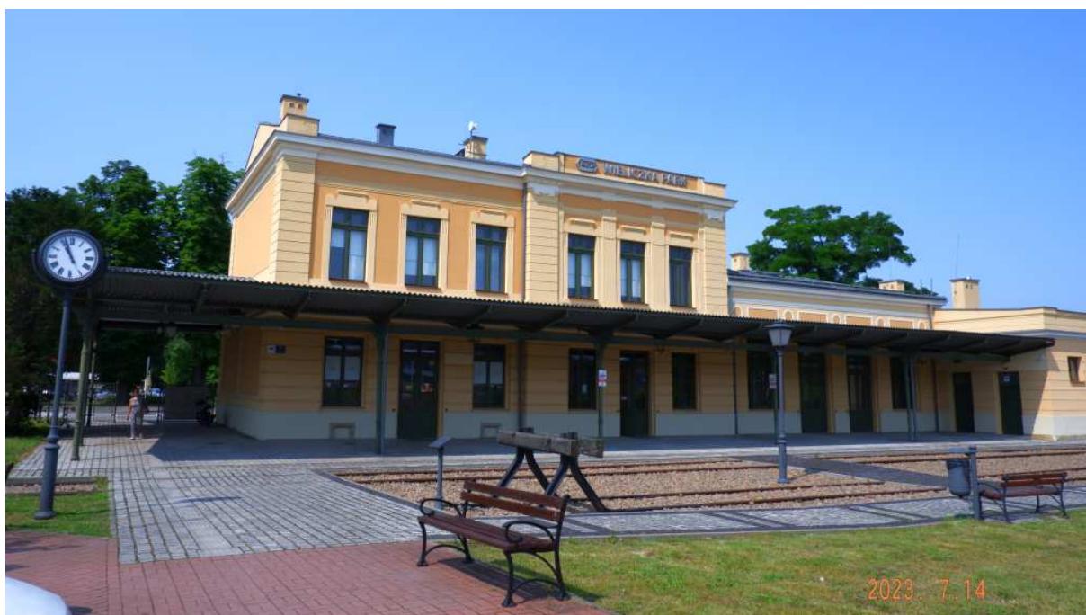
Fot. nr 151. Widok od strony peronów.
