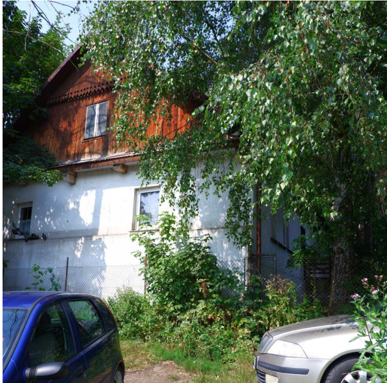
Fot. nr 80. Próba uchwycenia domu pod nr 11 z początku XX wieku. (14.07.2023)
