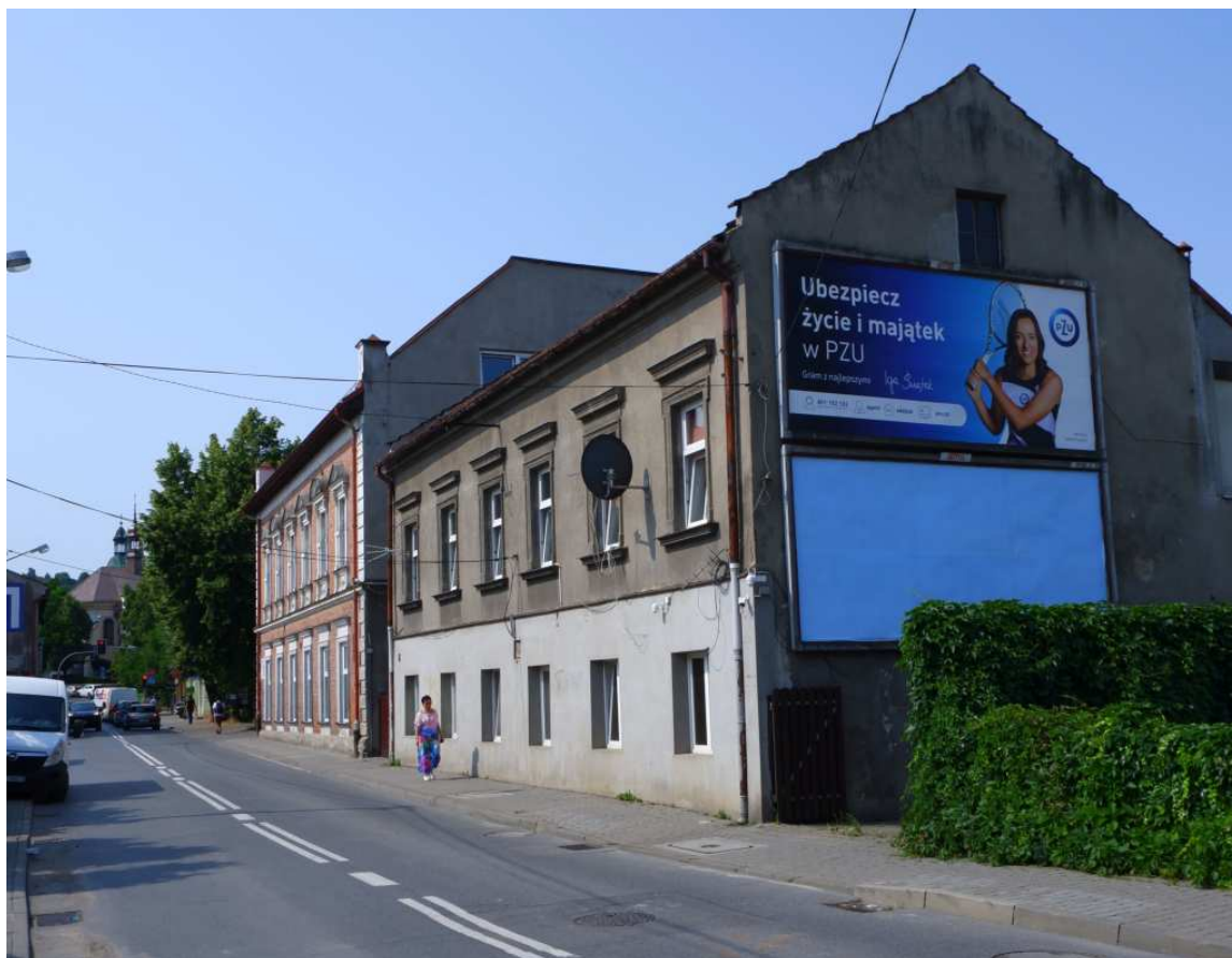
Fot. nr 62. Zabudowa z przełomu XIX i XX wieku pod nr: 6 i 8. (14.07.2023)
