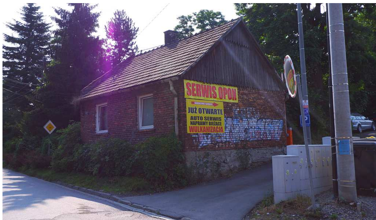
Fot. nr 171. Murowany dom, zapewne przedwojenny, spod nr 16. Okna już współczesne. (14.07.2023)
