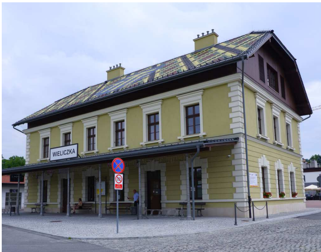
Fot. nr 142 (142-143). Tylny fragment od strony torów kolejowych. (01.07.2023)
