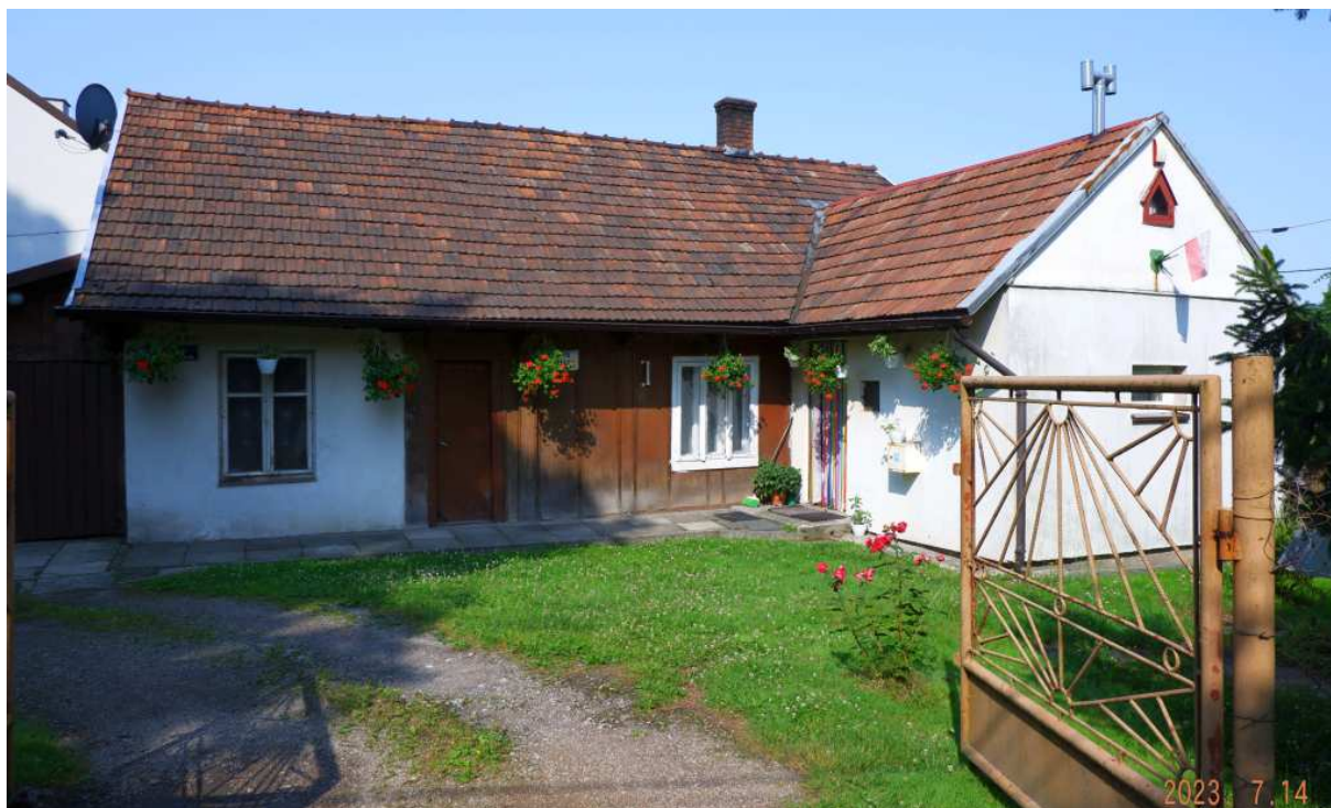
Fot. nr 186 (186-188). Chyba najlepiej zachowana w okolicy zagroda przy ulicy Źródlanej 9: chałupa i poprzecznie do niej dostawiona stajnia, w narożu z ulicą Długą. Kompleks, zapewne z początku XX wieku, nie figuruje nawet w GEZ.
