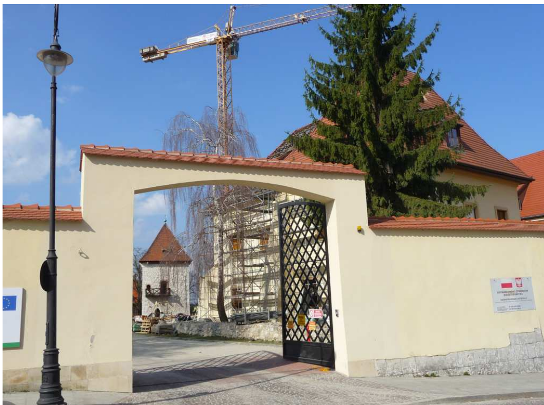
Fot. nr 427 (427-429). Wzdłuż ulicy Zamkowej. Wjazd na teren zamku żupnego pod nr 6. (12.03.2026)
