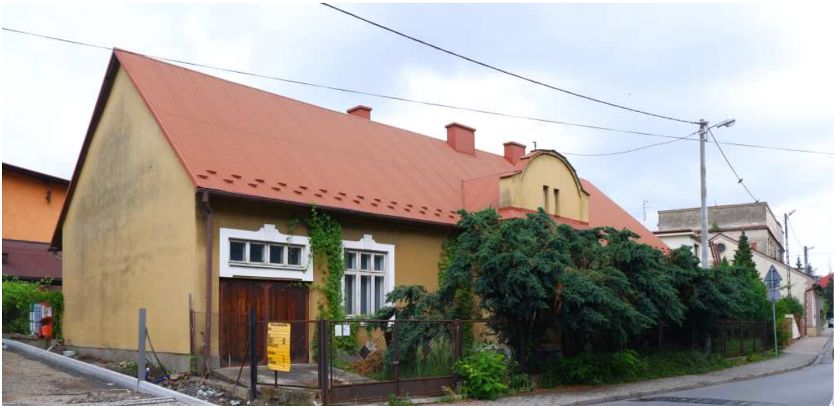
Fot. nr 47 (47-51). Wzdłuż ulicy Legionów. Fot. nr: 47-48. Pod nr 8 dawny dom Franciszka Aywasa, burmistrza Wieliczki z lat 1903-1934, wybudowany zapewne w I ćwierci XX wieku. (01.07.2023)
