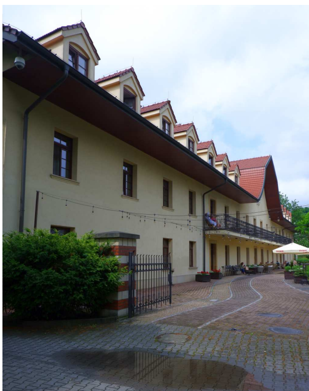
Fot. nr 11 (11-13). Fasada nowej Turówki i jej detale.
