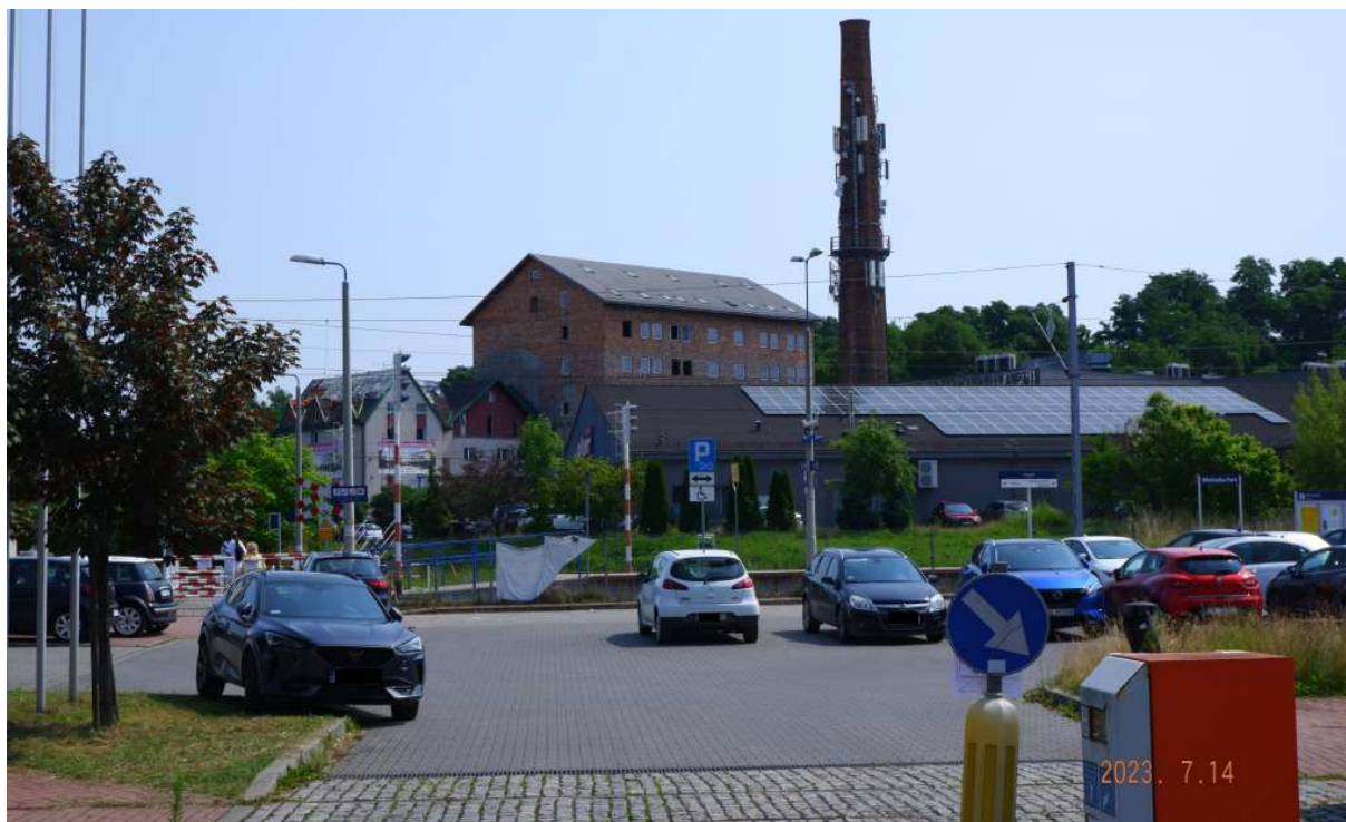
Fot. nr 154 (154-157). Z pozostałościami po dawnej cegielni w tle. Widok z ulicy Dembowskiego
