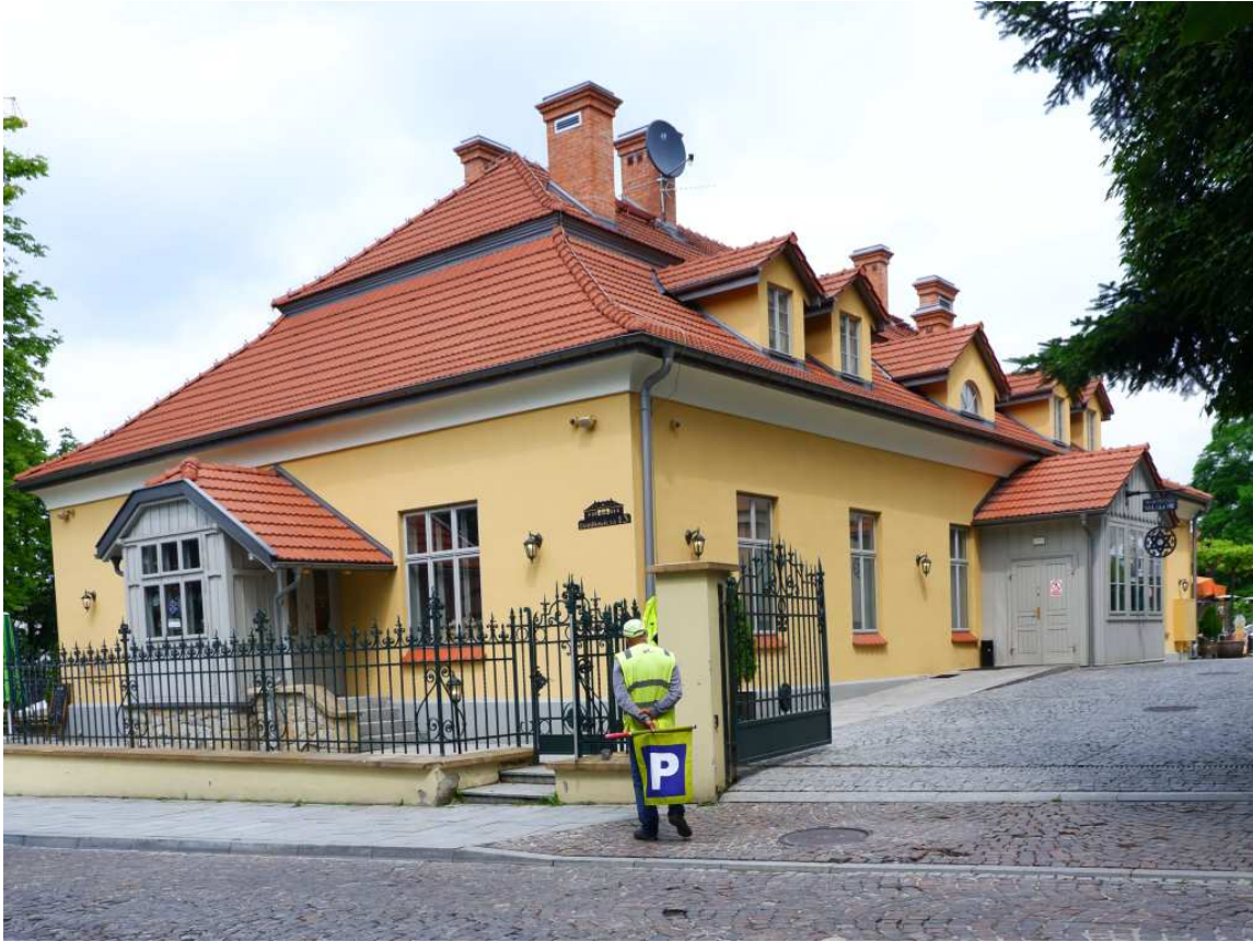
Fot. nr 112 (111-112). Elewacja południowa. (01.07.2023)
