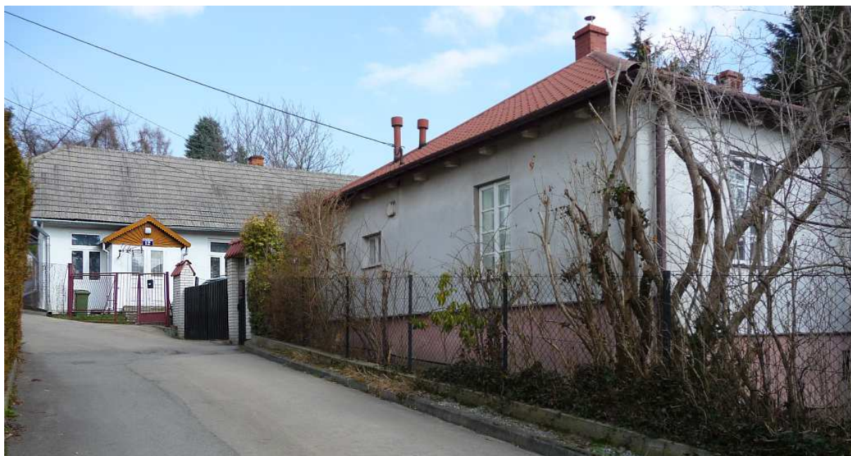
Fot. nr 404 (404-410). Wzdłuż ulicy Sienkiewicza. Fragment klimatycznej zabudowy o numerach: 12 i 14. (12.03.2026)
