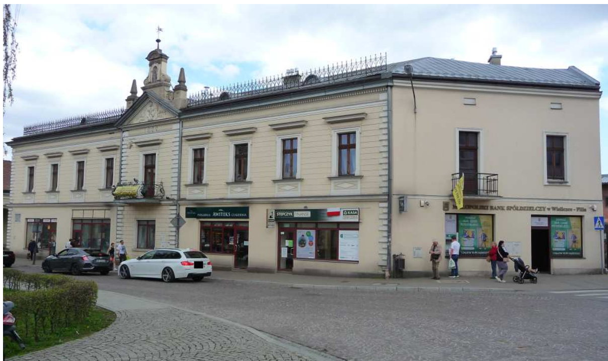
Fot. nr 314. Dawny Hotel Pod Złotym Aniołem przy placu Kościuszki 1, wybudowany w roku 1835. (14.04.2025)
