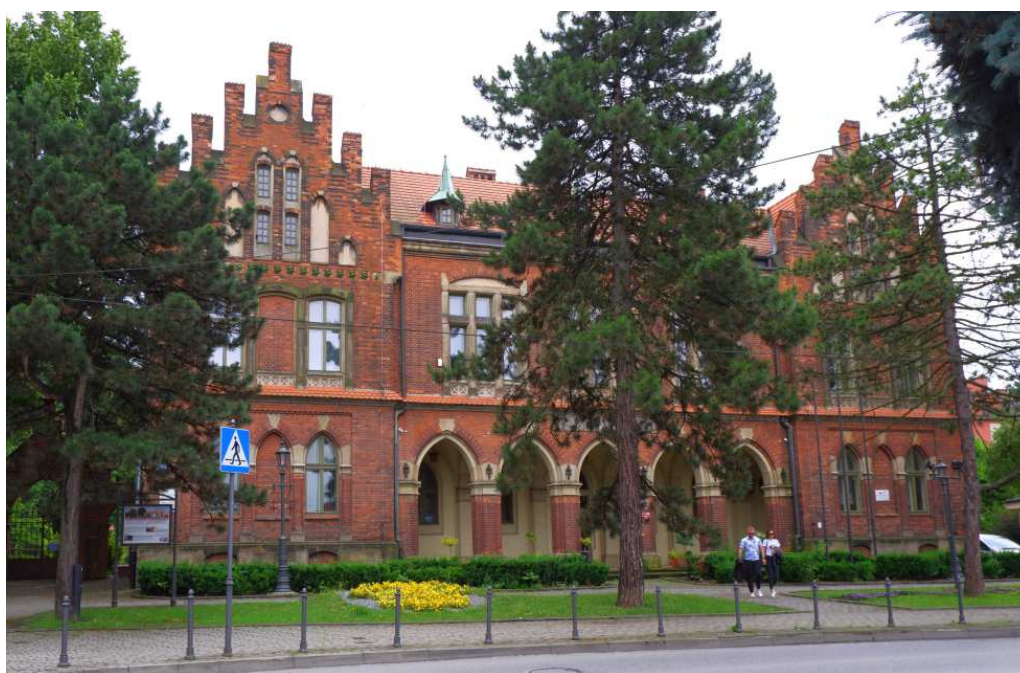
Fot. nr 129. Fasada obiektu w ujęciu z ulicy. (01.07.2023)
