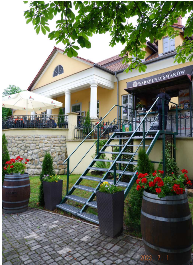
Fot. nr 114. Elewacja północna z kolumnowym portykiem na wejściu do Warzelnii Smaków.
