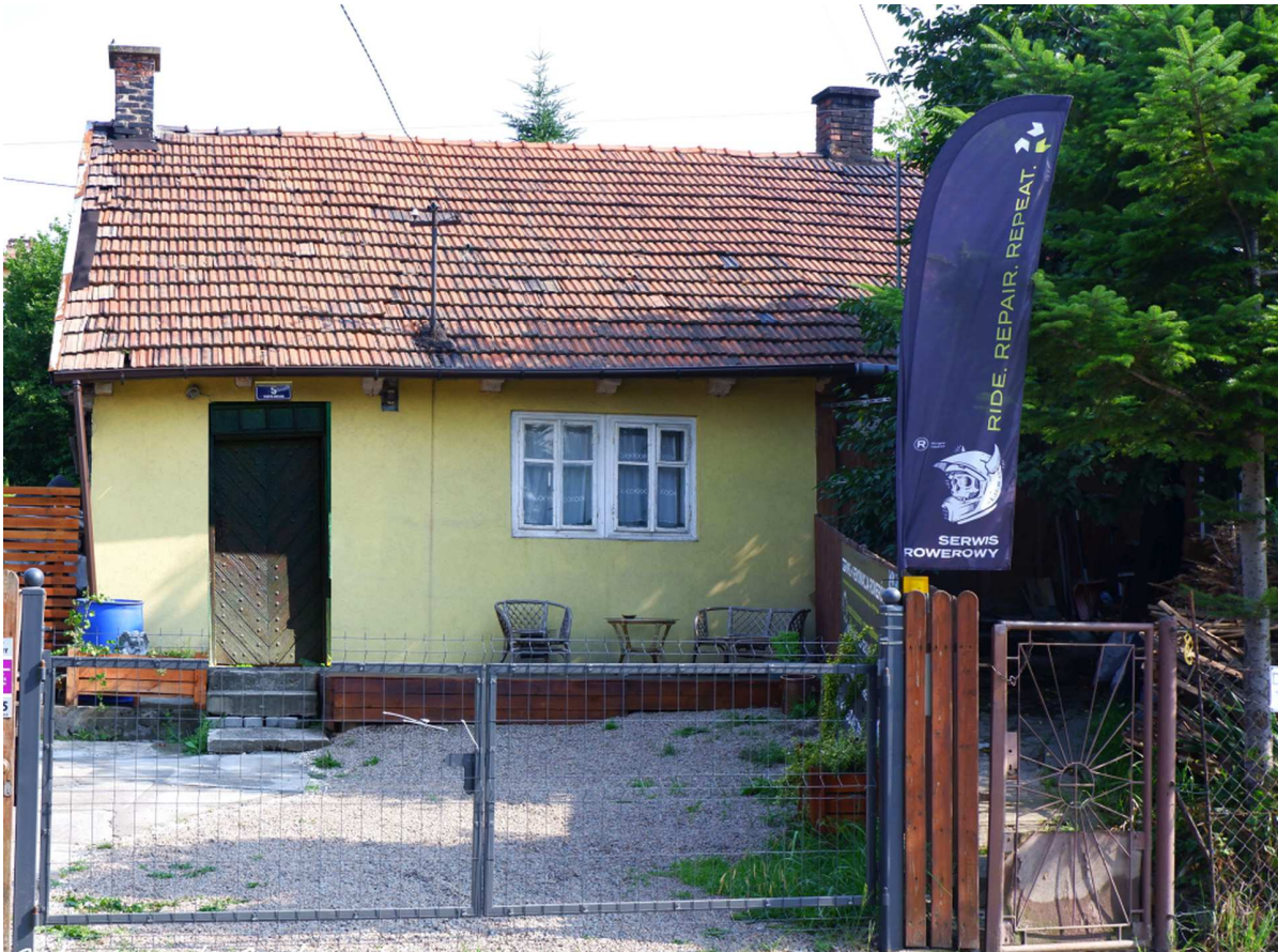
Fot. nr 167a. Próba rekonstrukcji fasady z oryginalnymi drzwiami.
