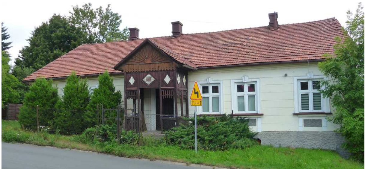
Fot. nr 378 (378-379). Zapewne niespełna 100-letni, wielorodzinny dom murowany pod nr 129, z profilowanym, odkrytym gankiem pośrodku fasady. (16.07.2025)
