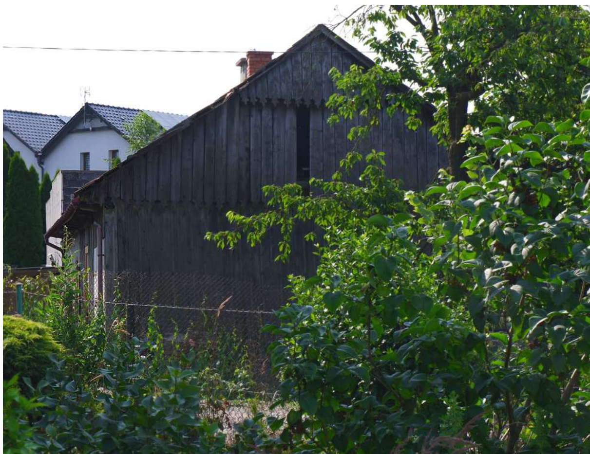
Fot. nr 197. Drewniana chałupa, zapewne z początku XX wieku, pod nr 17. Próba uchwycenia fasady z ulicy. (14.07.2023)
