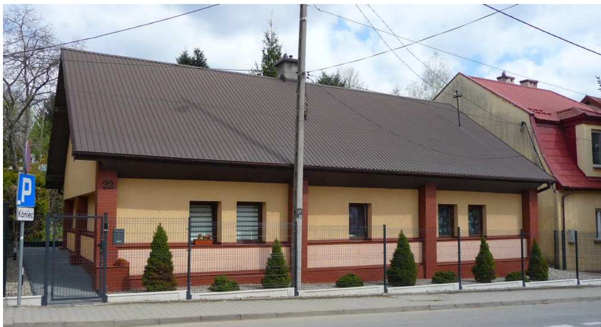
Fot. nr 328. Przebudowana chałupa pod numerem 22, której powstanie przypada na I. połowę IX wieku. (14.04.2025)
