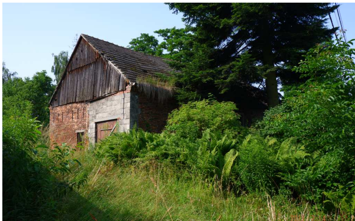
Fot. nr 175. Murowany, opuszczony dom pod nr 20. (14.07.2023)
