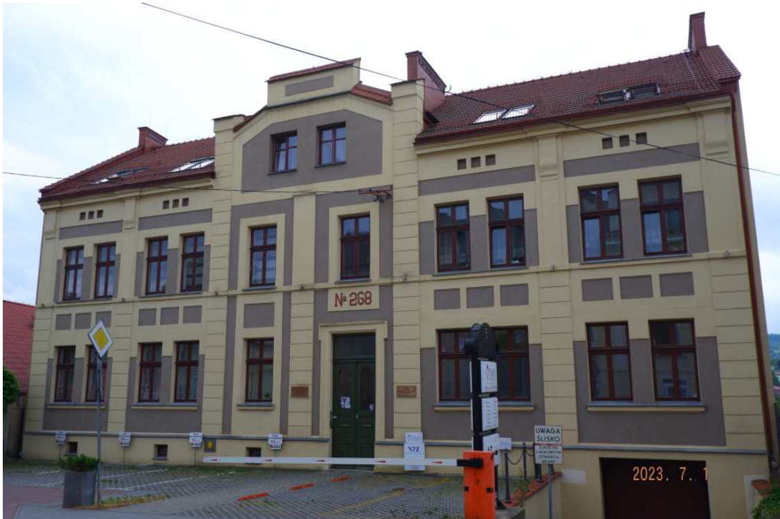
Fot. nr 42 (42-43). Solidnie odnowiona, murowana kamieniczka spod nr 5 z roku 1912.
