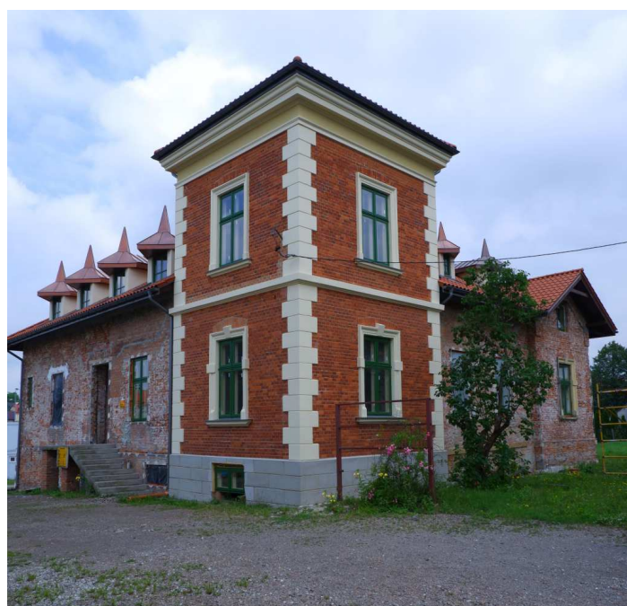
Fot. nr 147. Romantyczna wieża. (01.07.2023)
