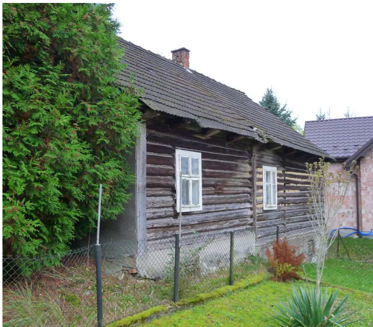
Fot. nr 391. Tylny fragment, który już przypomina nawet XIX-wieczną chałupę. (31.10.2024)
