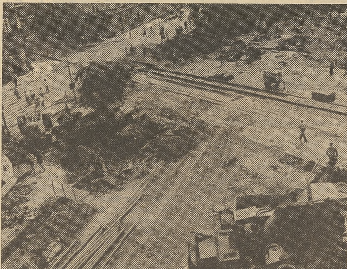
Tu krzyżują się remontowane tory z przebudowywaną największą arterią komunikacyjną. Fot. JADWIGA RUBIŚ
