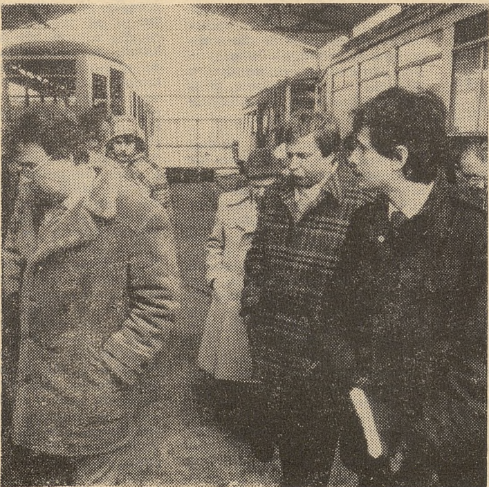
Wizyta w przyszłej wózkowni ZET Nowa Huta.
