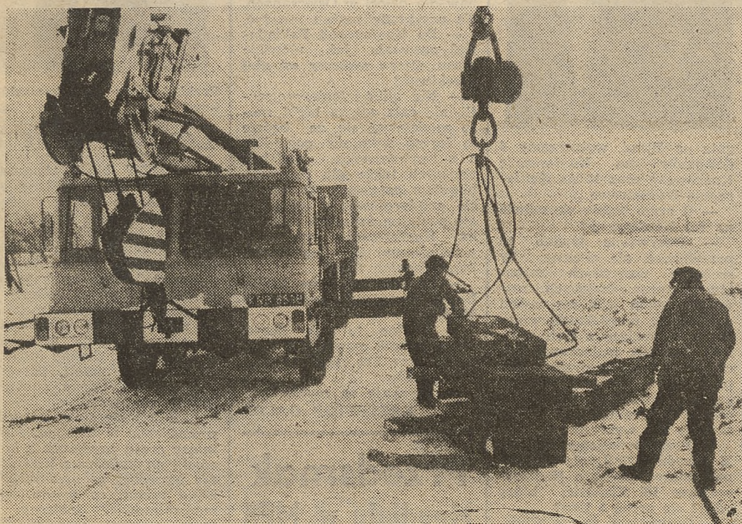
Próby obciążenia postawionego właśnie dźwigu. Na horyzoncie bloki Prądznika Białego — Zachód. Fot. STANISŁAW MAKAREWICZ
