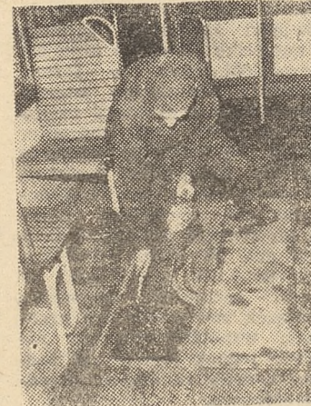
Jan Kłis dba o to, by wszystkie przekładnie zostały uzupełnione smarem.
