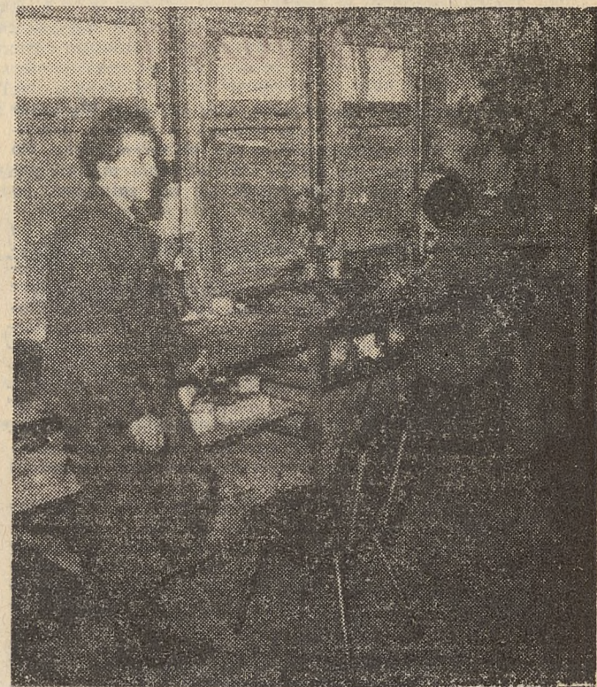
Tak wygląda przerobiony z baraku warsztat elektryczny.
