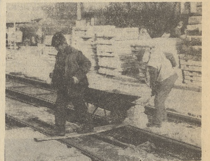
Od lewej: Mieczysław Jaśkowiec i Ryszard Kuczera rozsypują cementowo-piaskową podsypkę pod płyty w torze.
