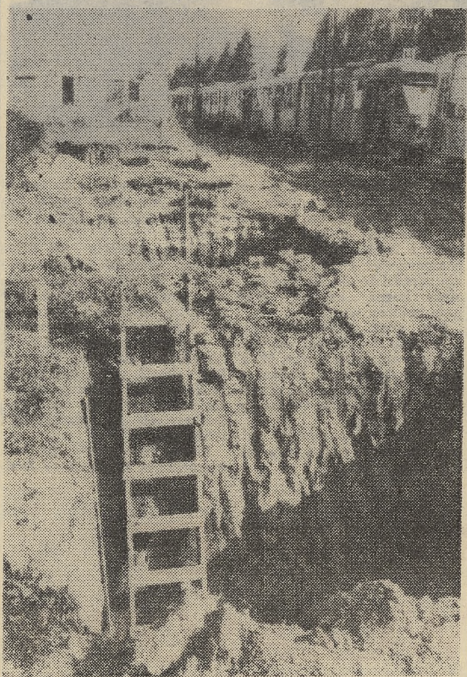
Wykopy pod automatyczną myjnię.
