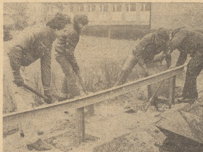
Naprawiają odcinek chodnika.
