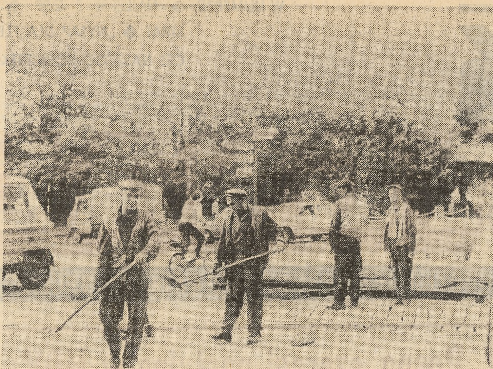
Remont kapitalny rozjazdów torowiska przy Foczie Głównej
