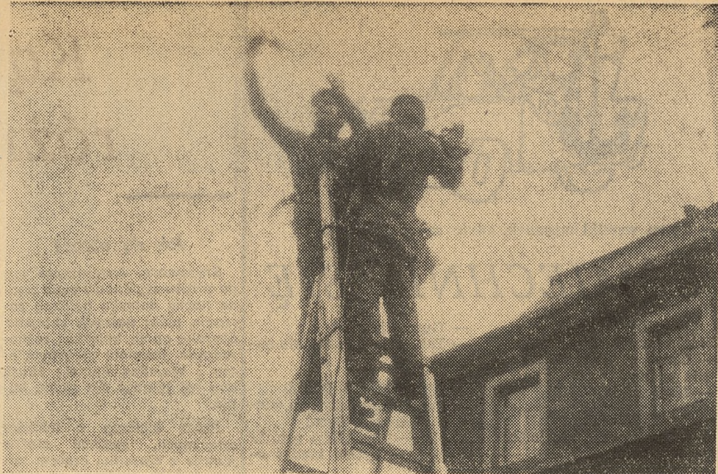
Podwieszanie przewodu jezdni na nowobudowanej pętli tramwajowej w Dreźnie przez polskich brygadystów sieciowych — Adama Kądziołkę i Kazimierza Kordulę.
