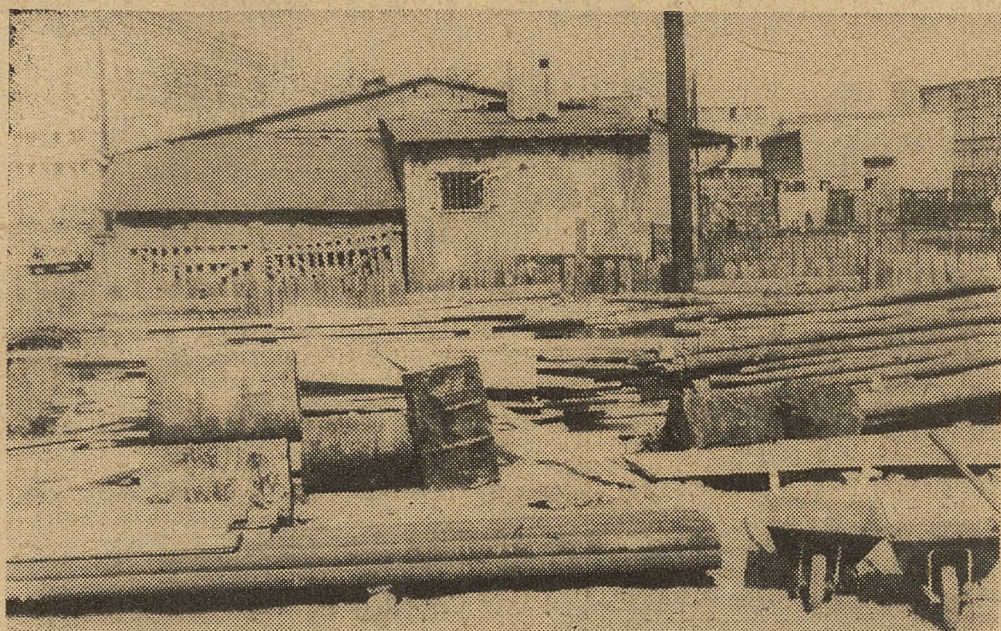
Budowa Podstacji na Grzegórkach. Czytaj str. 3 „Spokojnie... szefie... spokojnie”.
