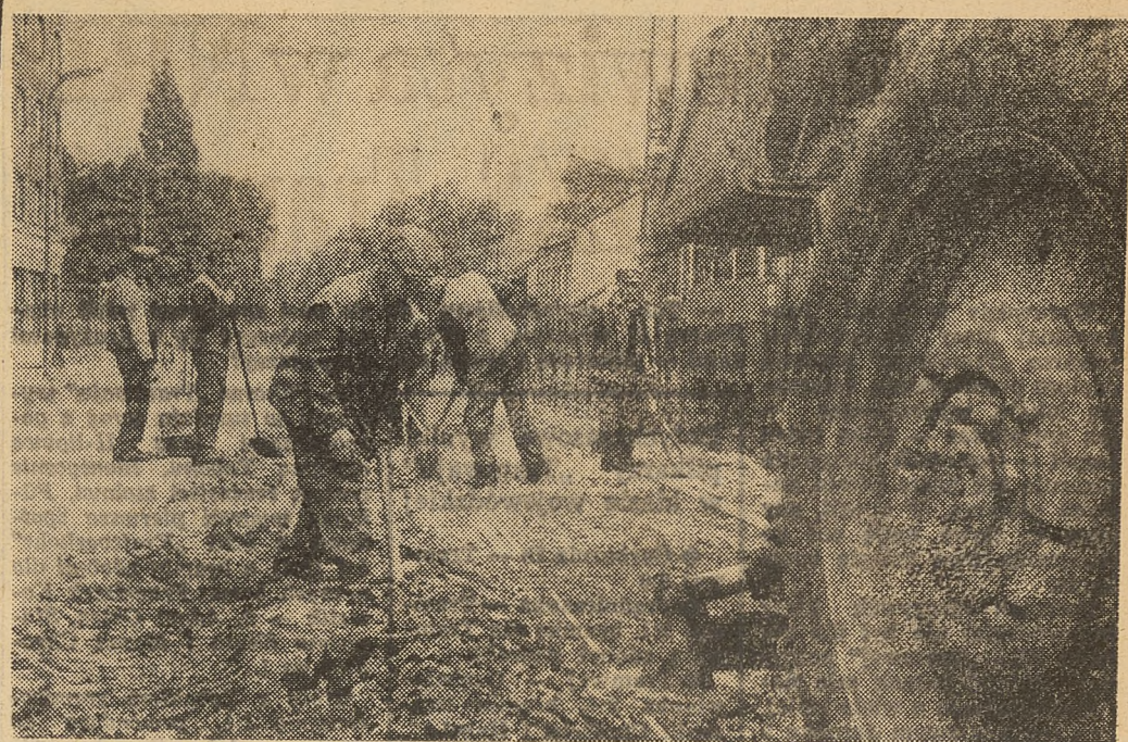
Remont kapitalny torowiska.
