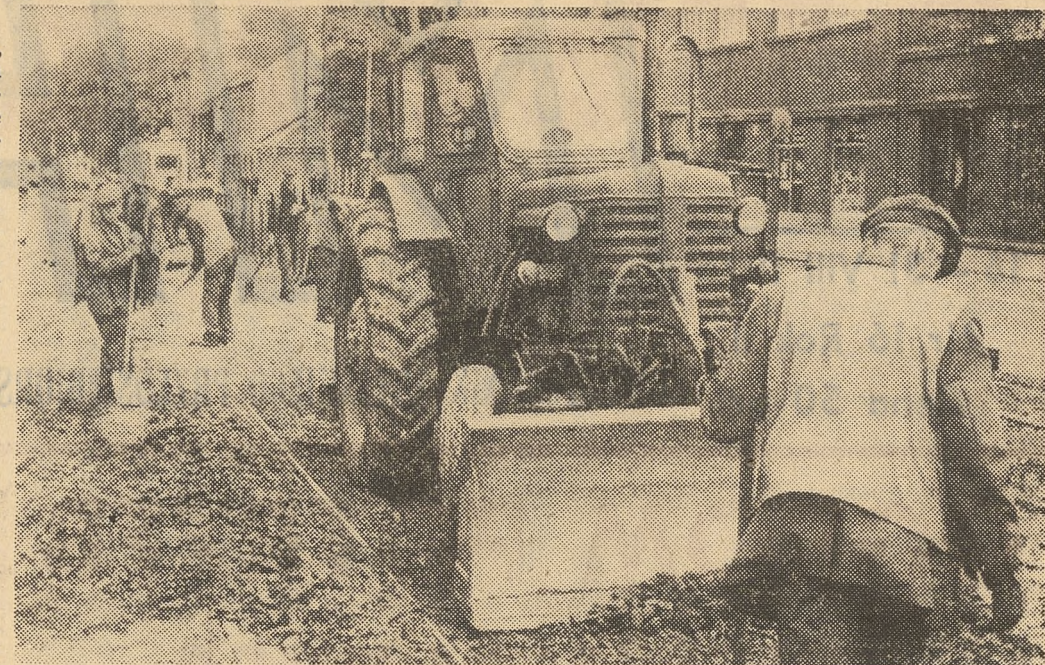
Koparko-spychacz rozplantowuje tłuczeń na torowisku przy ul. Mogińskiej.
