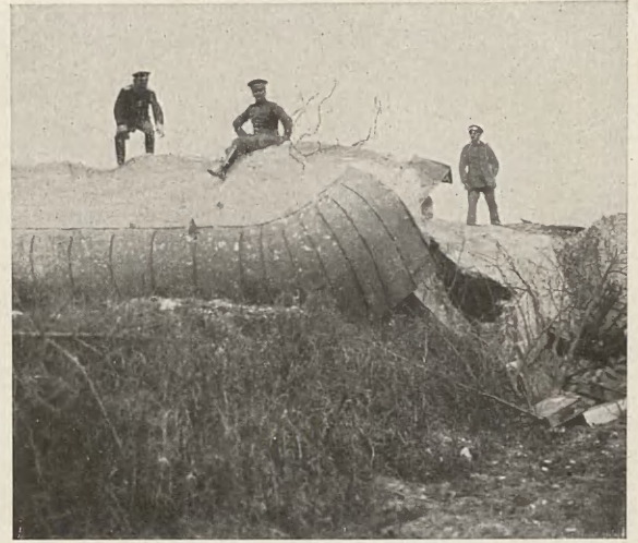
Nr. 185. Die Wirkung der Mörser von Krupp und Skoda an einem Panzerturm auf Fort 11: Die Kuppel eines Geschützturmes, die 30 m weggeschleudert wurde R. Semede
