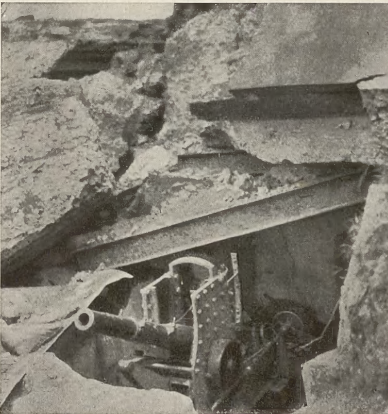
Nr. 184. Ein russisches Festungsgeschütz im Fort 11, dessen meterstarke Eisenbetonierung durch einen 42-cm-Treffer abgesprängt wurde
