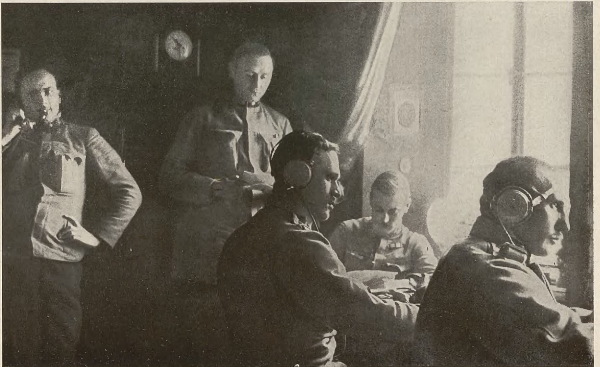
Nr. 77. Telephonzentrale im Stabsquartier
