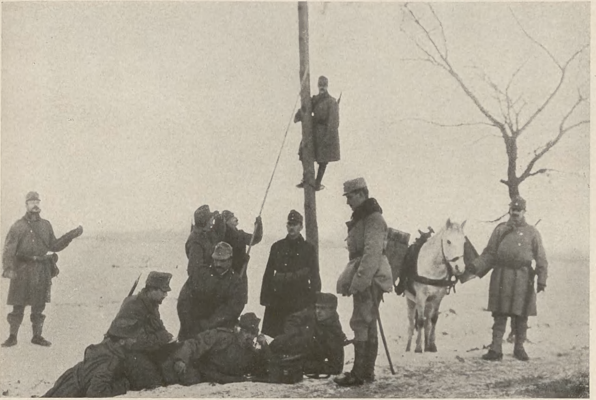
Nr. 76. Telephonstation vor dem Feinde
