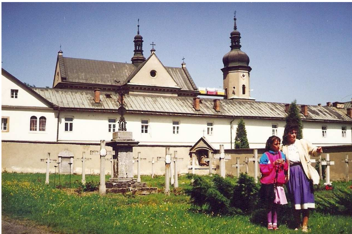
Fot. nr 75. Zabudowania klasztorne. (1992)
