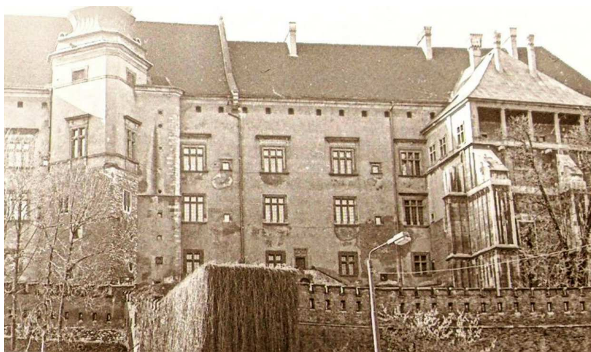
Fot. nr 37. Wschodnie skrzydło w ujęciu od strony ulicy Grodzkiej.
