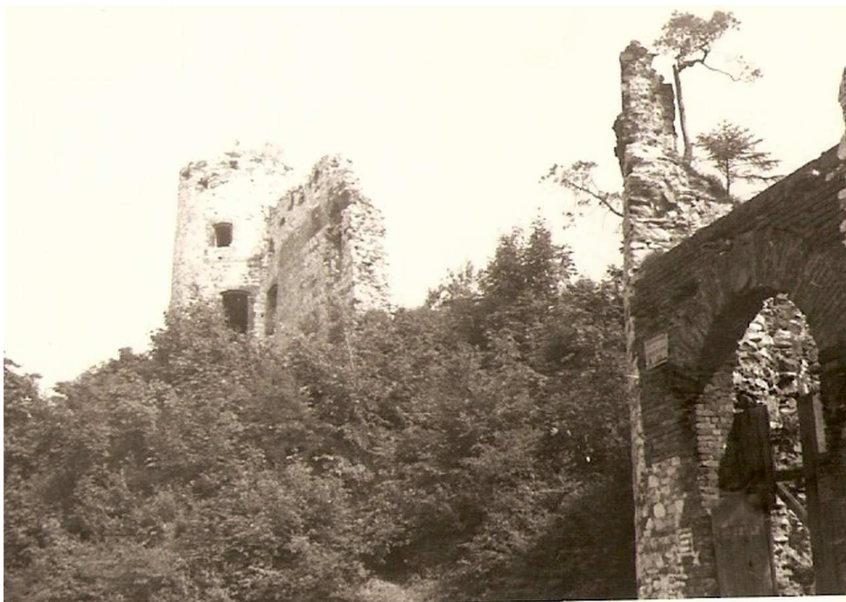
Fot. nr 78 (78-79). Ruiny zamku „Tęczyn” w Rudnie. (1983)
