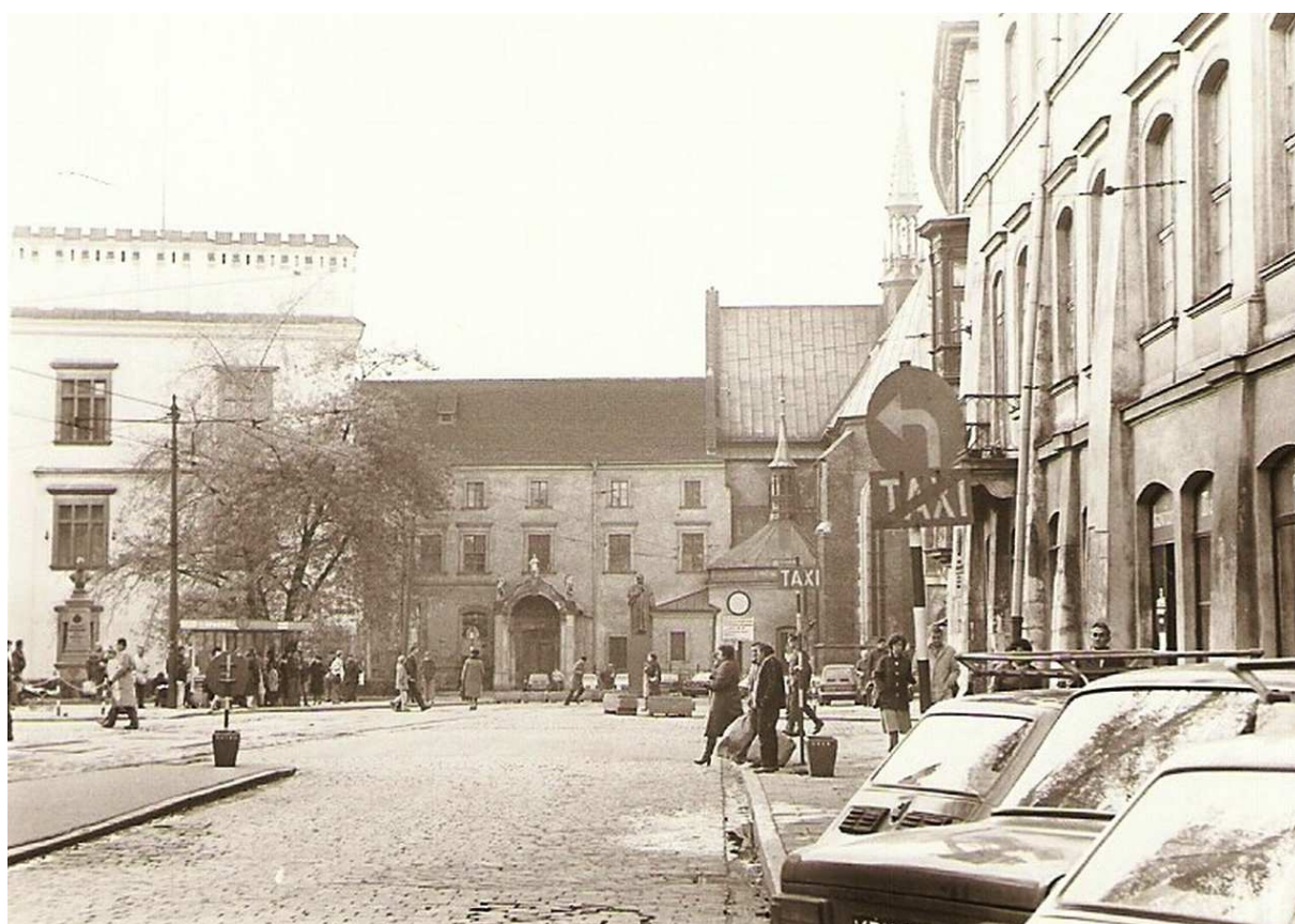
Fot. nr 23. Pałac Wielopolskich – widok spod kościoła Dominikanów.
