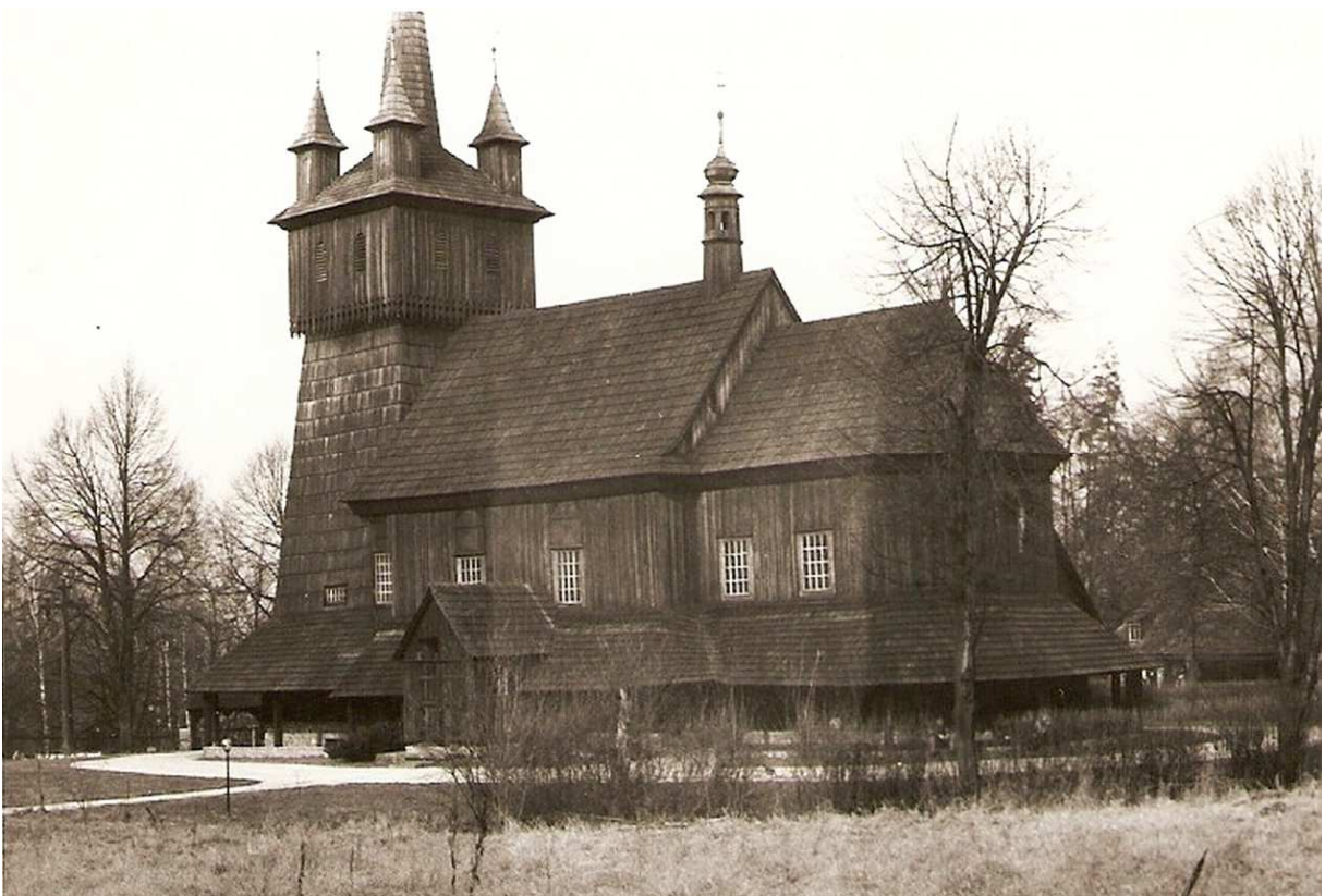
Fot. nr 63. Odbudowany po pożarze z roku 1978 zabytek, który ponownie spłonie w roku 2002.
