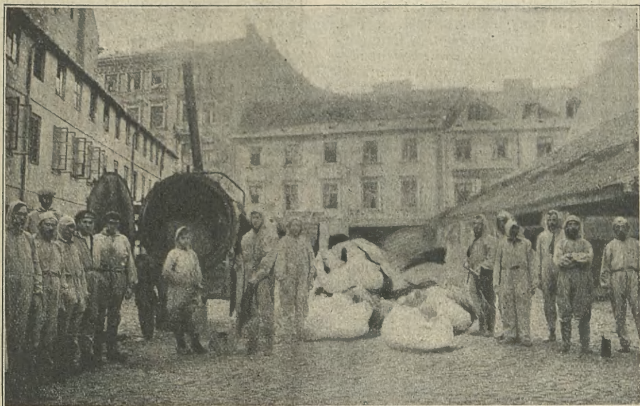
Dezynfekcja domu „Trefne Jutki“ przy ul. Franciszkańskiej № 29.
