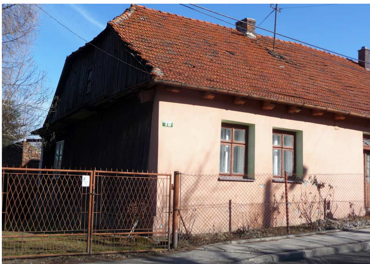
Fot. nr 550. Narożnik otynkowanego domu pod nr 19 z oryginalnymi oknami typu skrzynkowego. (15.03.2012)
