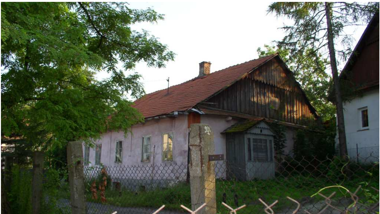
Fot. nr 63 (63-67). Kilka ujęć oryginalnego domu drewniano-murowanego z I. połowy XIX wieku spod nr 13, typowego dla klasycystycznego obrazu Wieliczki. Fasada ciągle posiada oryginalne, sześciopolewe okna drewniane, otwierane na zewnątrz. Do ściany bocznej przylega obudowany ganek. Jego stan systematycznie podupada. (01.07.2009)
