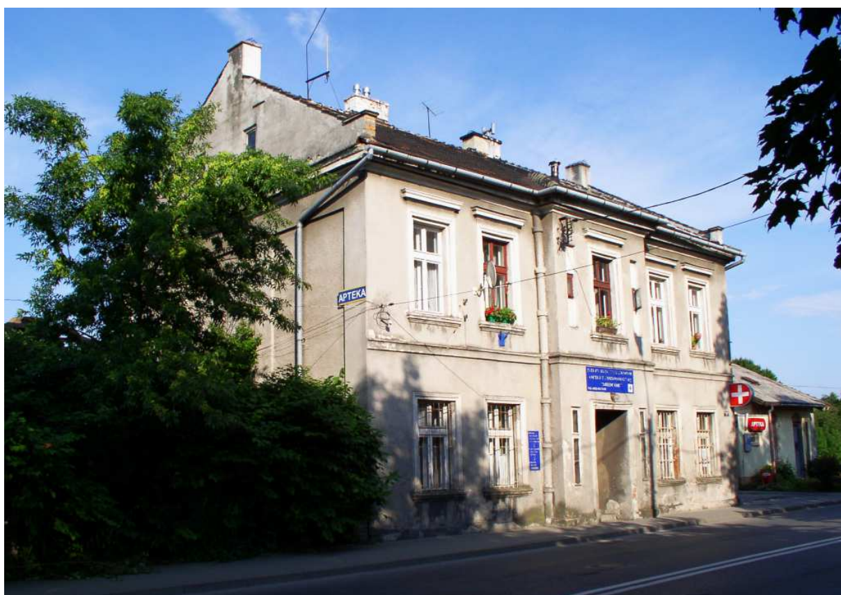
Fot. nr 231. Budynek przy stacji Wieliczka pod nr 57, wybudowany zapewne na przełomie XIX i XX wieku, który figuruje w GEZ. (22.06.2011)
