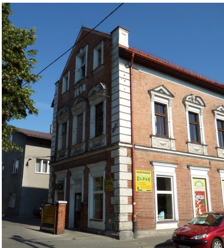
Fot. nr 380. Ściana szczytowa z datą powstania. (24.07.2012)
