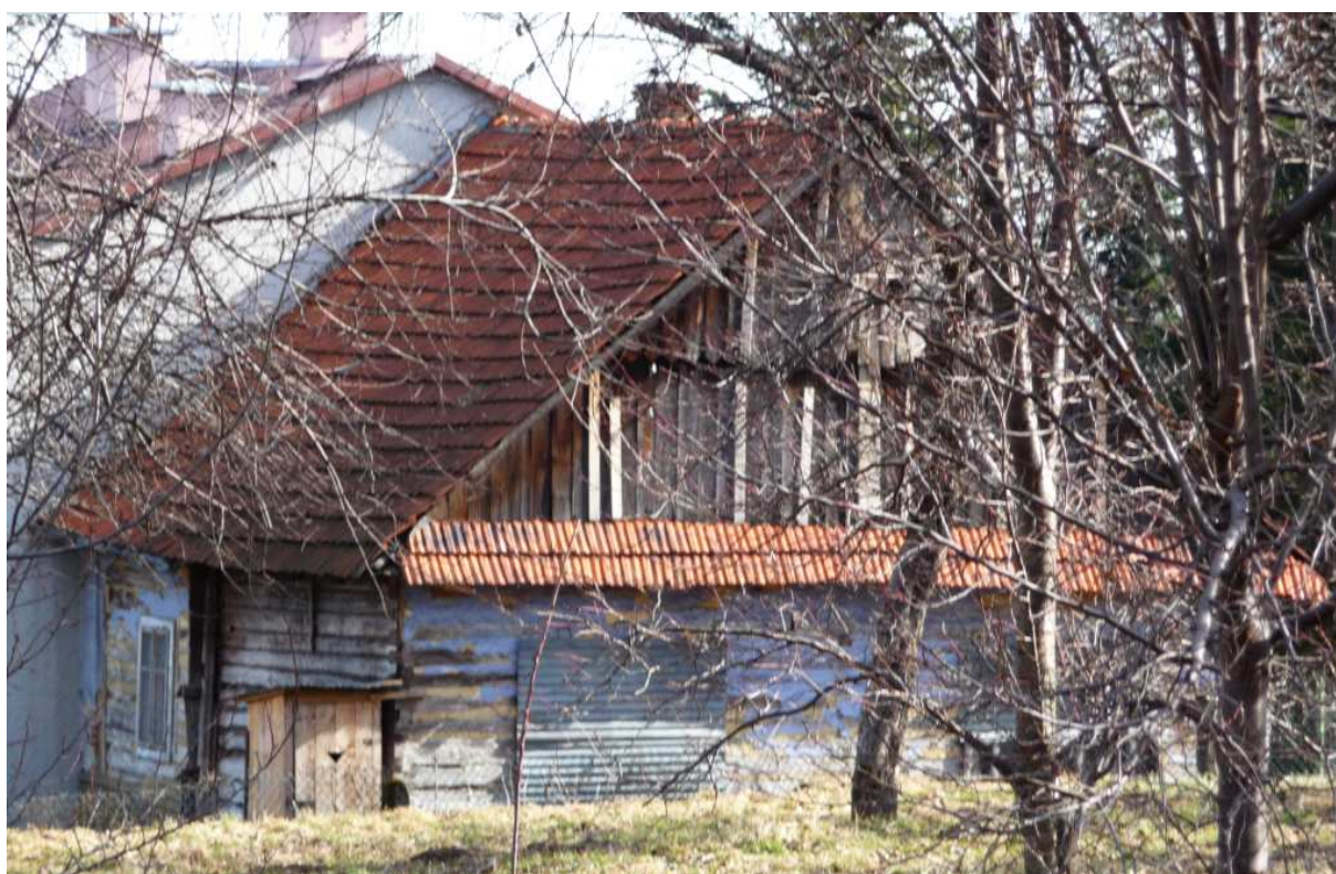
Fot. nr 456 (456-458). Stara chałupa spod nr 14 i jej detale, które przybliżają jej datowanie na koniec XIX wieku. Obiekt nie został wpisany do GEZ. (15.03.2012)
