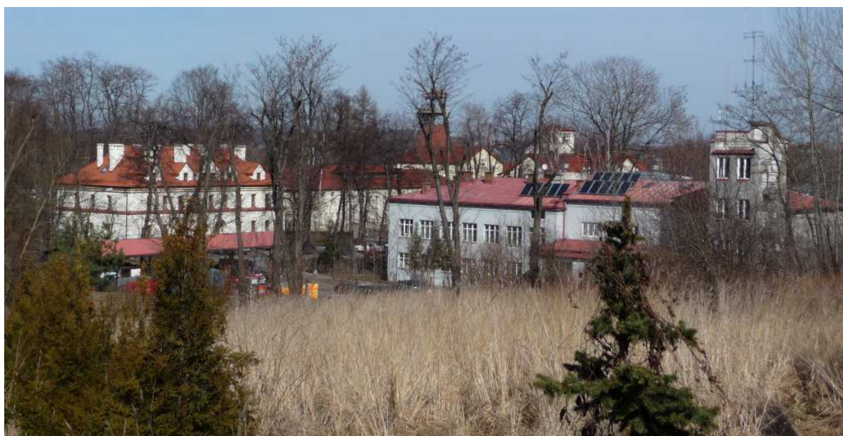
Fot. nr 542. Na pierwszym planie budynek Straży Pożarnej w Parku Kingi. (15.03.2012)
