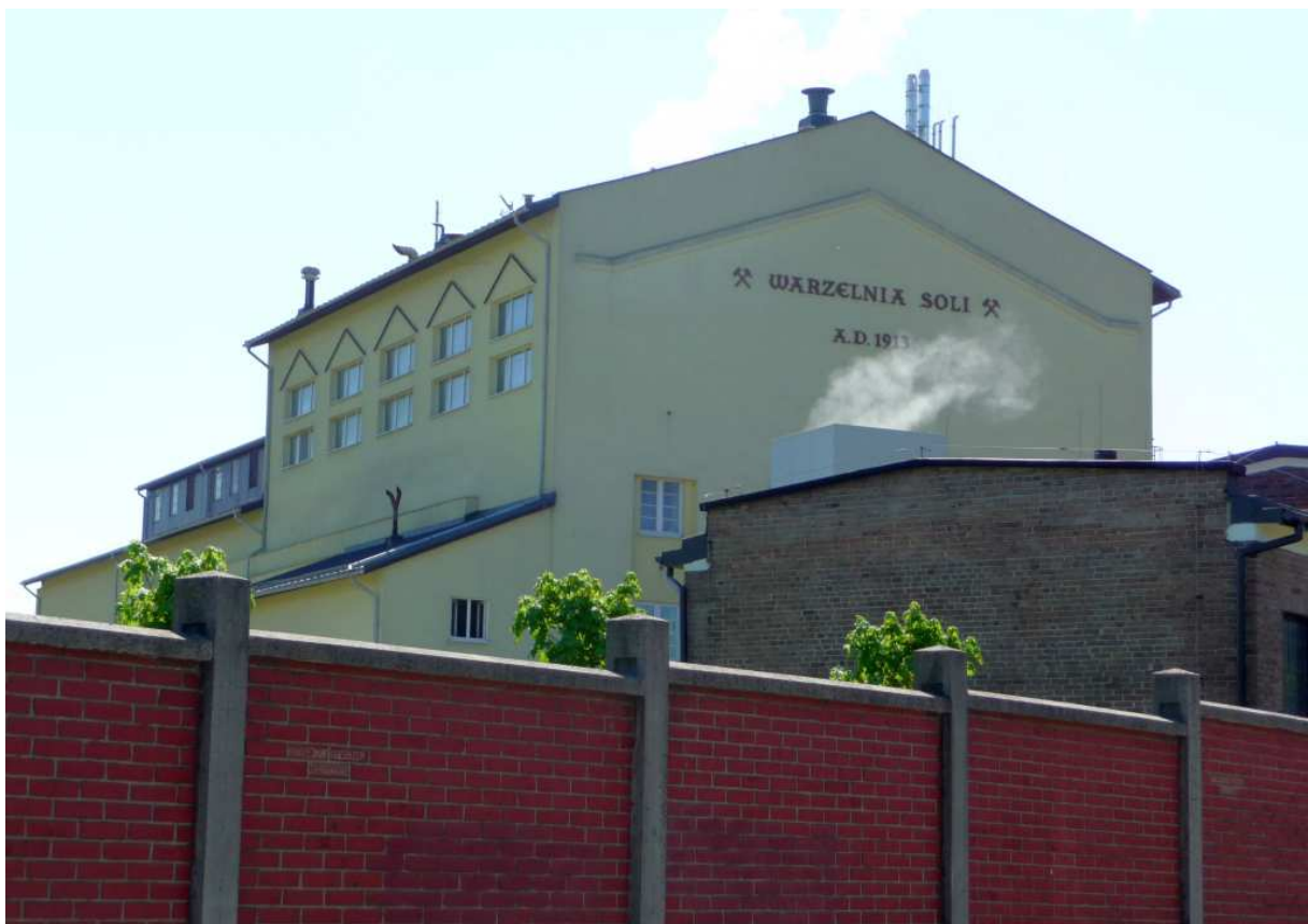
Fot. nr 147. Budynek nowej warzelni, która powstała w latach 1910-1913, w ujęciu z ulicy Matejki. Niestety nie przylega już do niej wyburzony w latach 80. XX wieku komin chłodni. (09.05.2012)
