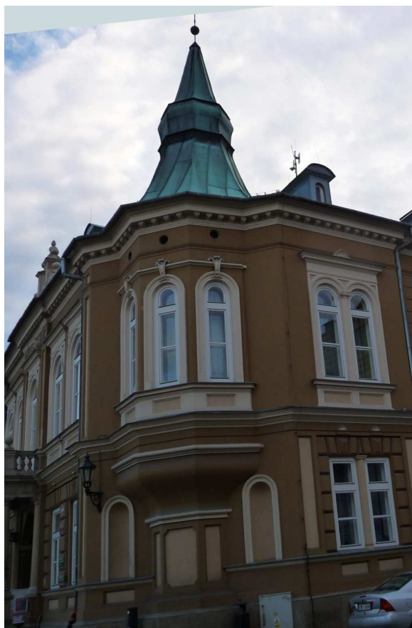
Fot. nr 27. Narożnik w formie półokrągłej wieżyczki pałacyku z końca XIX wieku. w narożu z Rynkiem Górnym 6. (26.10.2011)
