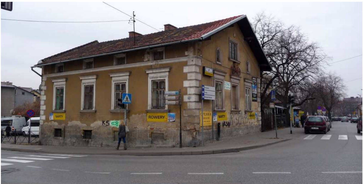
Fot. nr 382 (382-386). Widoki na fasadę. (21.12.2011)
