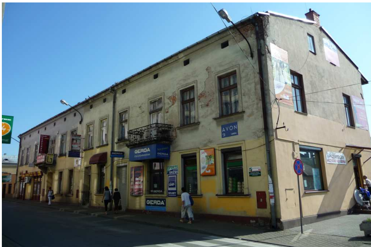
Fot. nr 483. Zespół dwóch domów spod nr: 4-6, wybudowanych na początku XX wieku, wpisanych do GEZ (24.07.2012)
