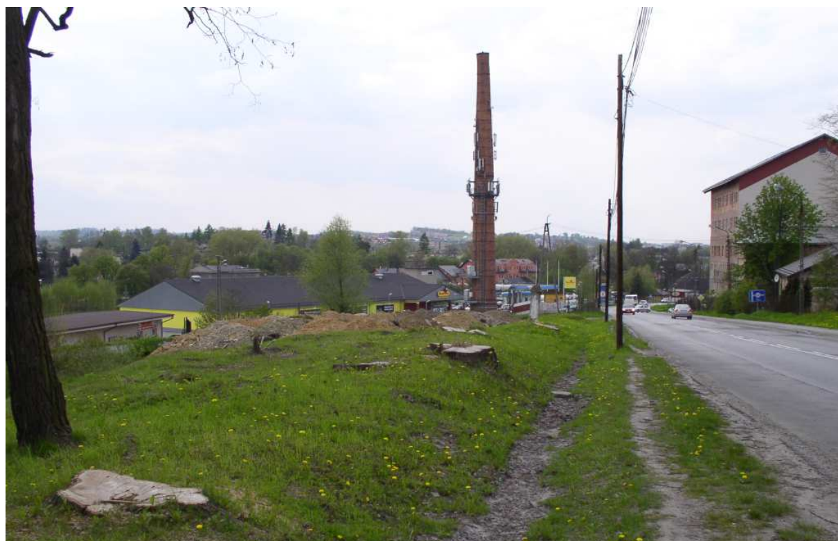
Fot. nr 324 (324-327). Pozostałości po dawnej cegielni pod nr 1, po której pozostał charakterystyczny komin, wpisany do GEZ. W miejscu budynku produkcyjnego stoi dziś Biedronka (28.04.2010)
