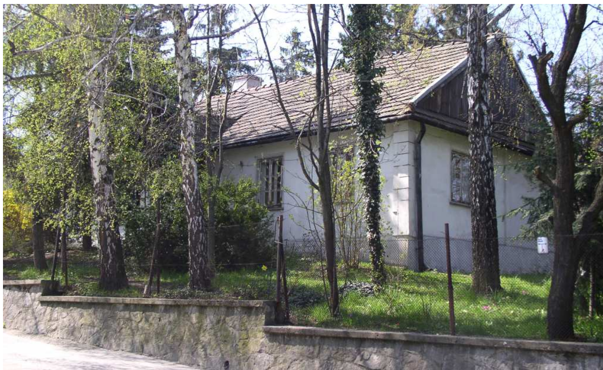
Fot. nr 404 (404-407). Wybudowany po roku 1878 klasycystyczny dom z gankiem, na kształt tradycyjnego dworku, z ulicy Górniczej 5. Obiekt wpisany do GEZ. (15.04.2009)
