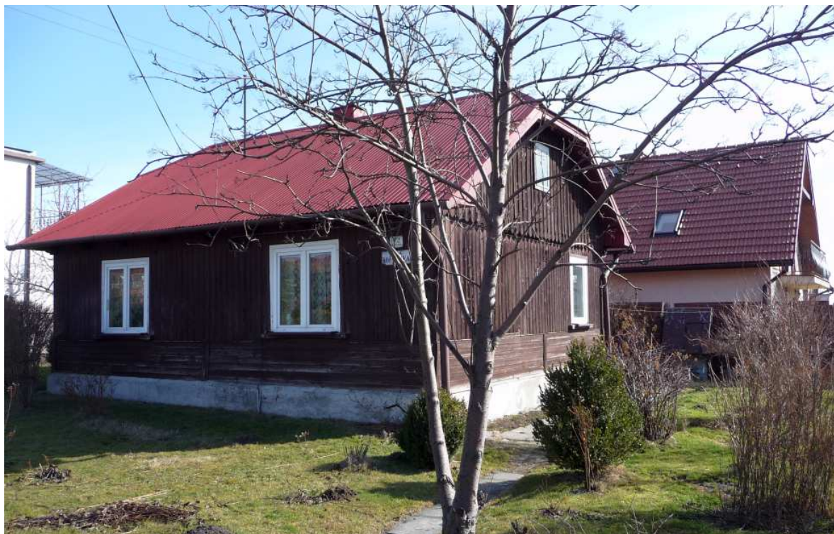
Fot. nr 522. Zniekształcona przez współczesne okna fasada domu pod nr 92. (15.03.2012)
