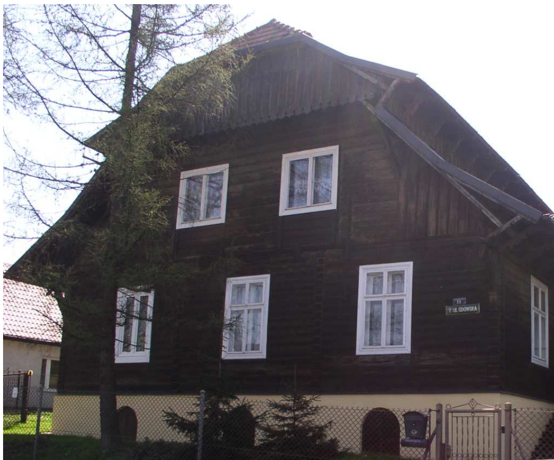
Fot. nr 420. Ściana szczytowa od strony ulicy z oryginalnymi jeszcze w większości oknami typu skrzynkowego, które dziś, po wymianie, zatraciły dawne podziały. (16.04.2009)
