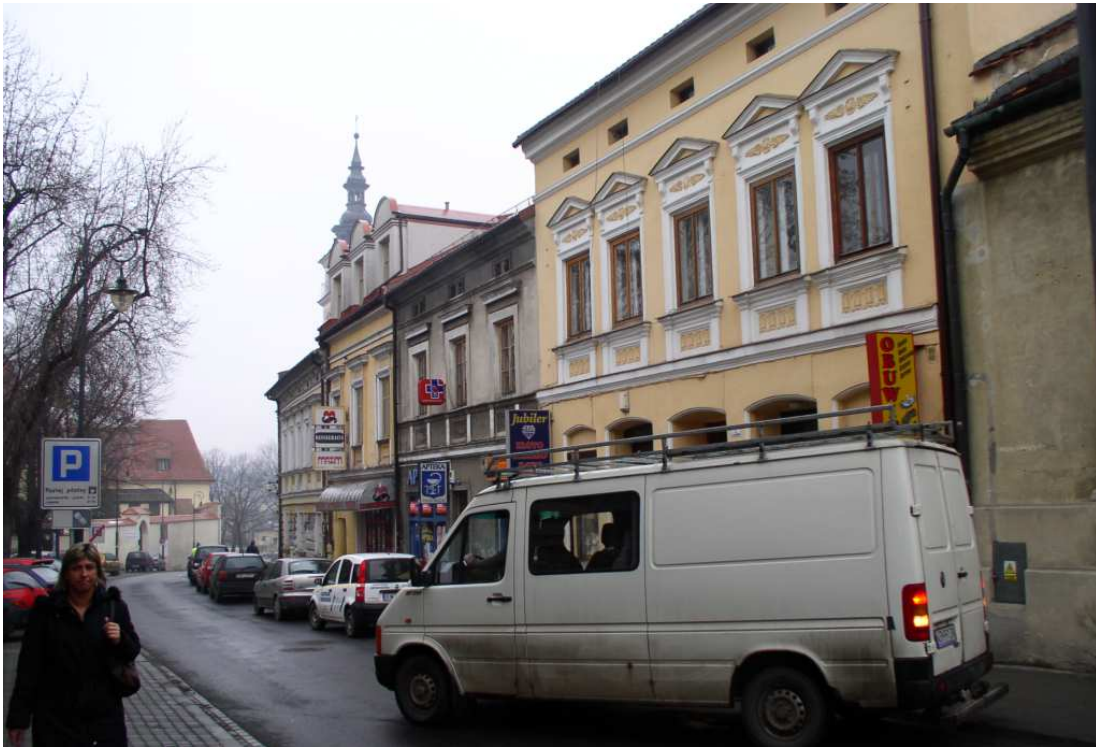
Fot. nr 104 (104-109). Kłika ujęć fragmentu niskiej zabudowy o numerach 1-7, która w większości powstała pod koniec XIX wieku. Domy pod nr: 1 i 3 (z prawej), powstałe w ostatniej ćwierci XIX wieku, znajdują się w Rejestrze Zabytków (03.03.2009)
