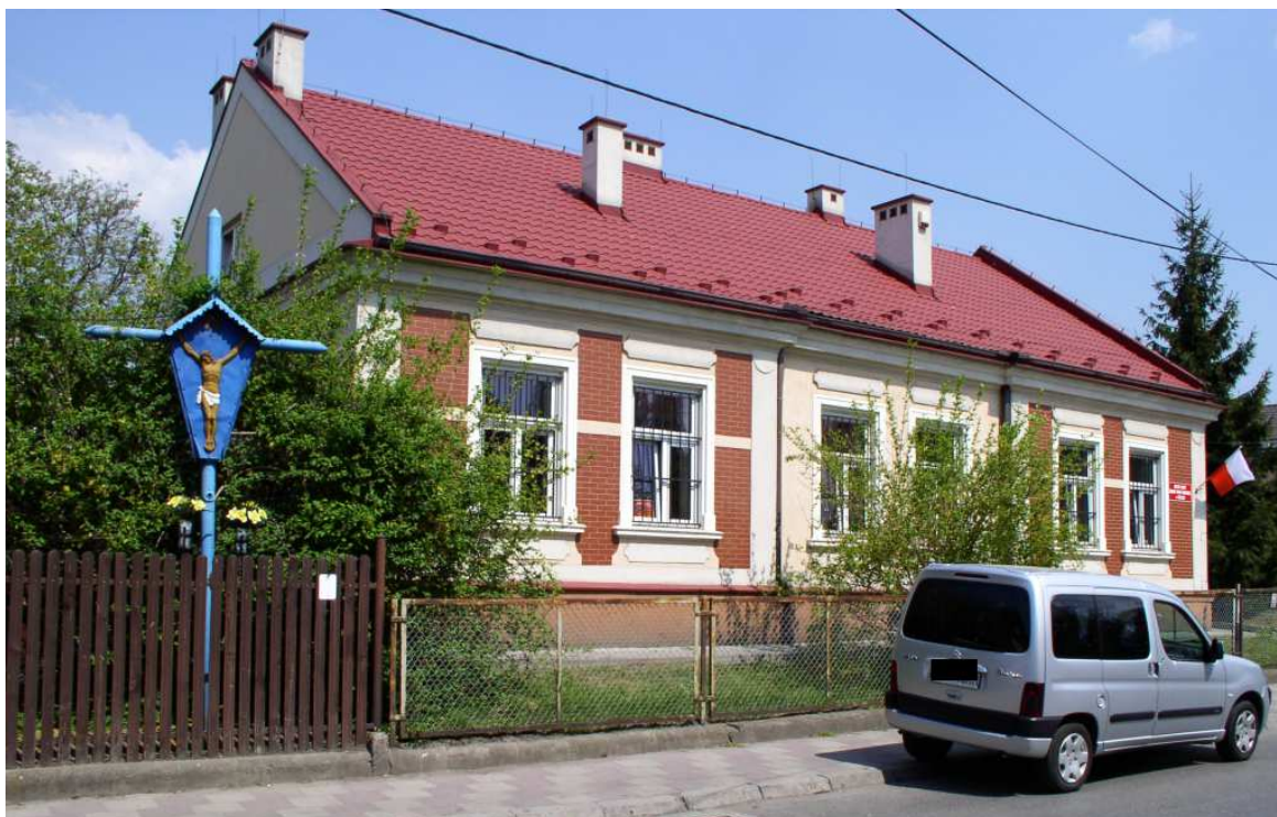
Fot. nr 391 (391-392). Murowany dom z początku XX wieku spod nr 26, wpisany do GEZ i przylegający do niego kapliczka. (04.05.2009)
