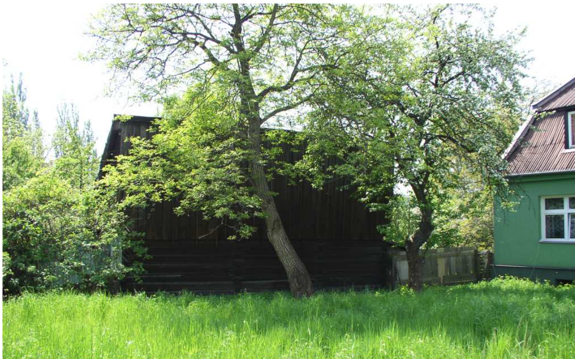
Fot. nr 394 (394-396). Tylny fragment domu bądź budynku gospodarczego na tyłach posesji pod nr 17. (04.05.2009)
