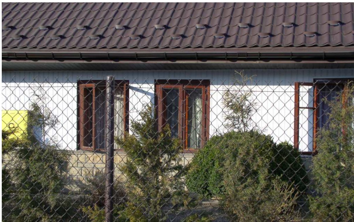
Fot. nr 428. Prawe okno w fasadzie obiektu pod nr 54 typowe dla chałup z końca XIX wieku. (04.04.2009)
