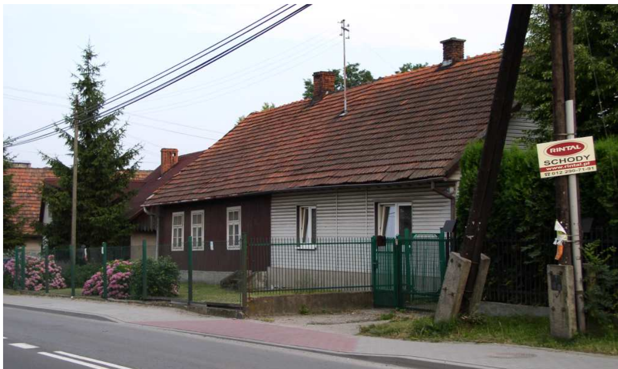
Fot. nr 424 (424-425). Dom pod nr 43, może nawet dawna chałupa. Lewy fragment, oszalowany, z oknami trójskrzydłowymi, typowymi dla lat 20/30 XX wieku. (15.07.2009)
