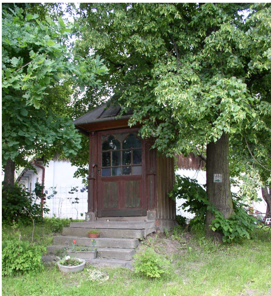
Fot. nr 217 (217-220). Przylegająca do chałupy pod nr 1 kapliczka typu domkowego, powstała pod koniec XIX wieku, usytuowana przed wejściem na teren KSW. Tu górnicy modlili się przed szychtą. Wraz z chałupą tworzy klimatyczny zakątek. (06.06.2011)
