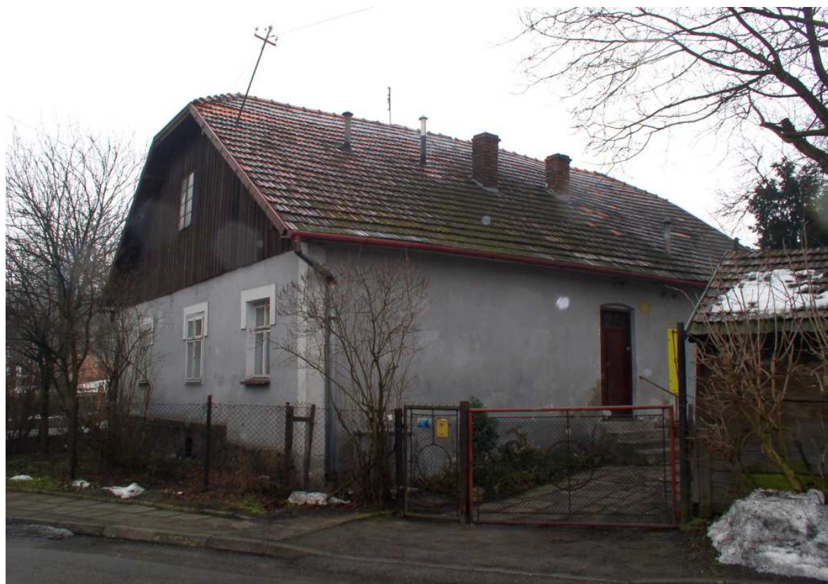
Fot. nr 530. Boczna ściana szczytowa od strony ulicy Janińskiej, jeszcze z oryginalnymi oknami typu skrzynkowego, których w fasadzie już nie ma. (03.03.2009)
