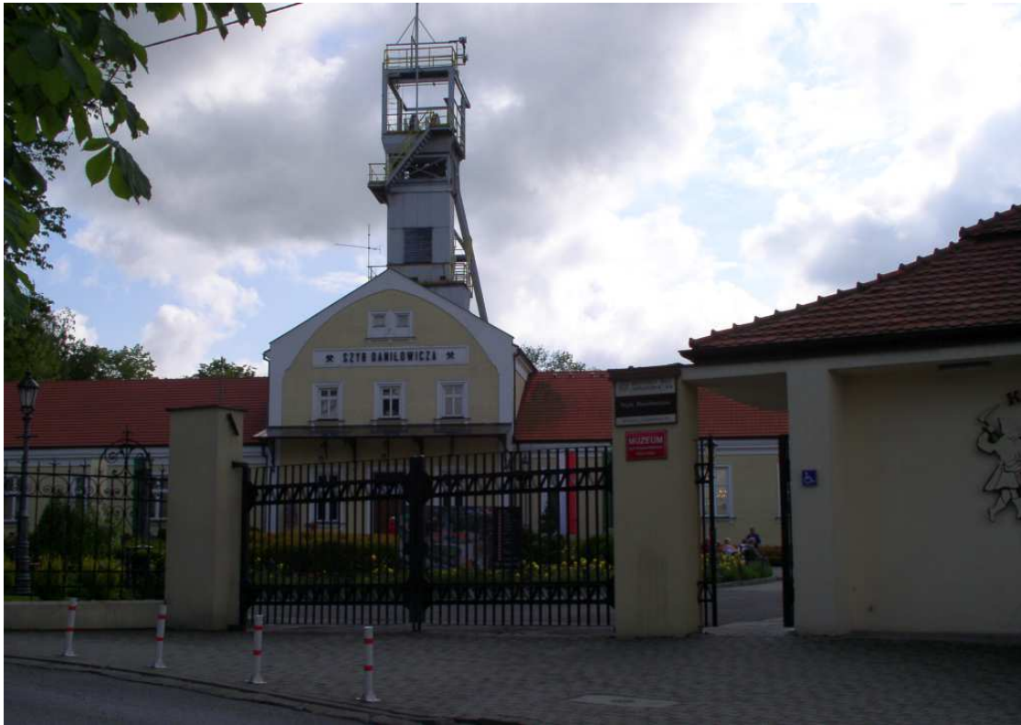
Fot. nr 140 (140-145). Szyb Daniłowicza przy ulicy Daniłowicza 10, gdzie w KSW zaczyna się trasa turystyczna. Nadszybie powstało w roku 1898. Sam szyb został wybity w latach 1635-1640. (01.06.2009)
