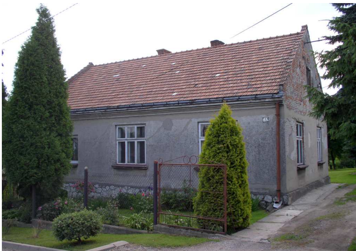
Fot. nr 559. Może już powojenny dom pod nr 1 z oryginalnymi oknami typu skrzynkowego. (06.06.2011)
