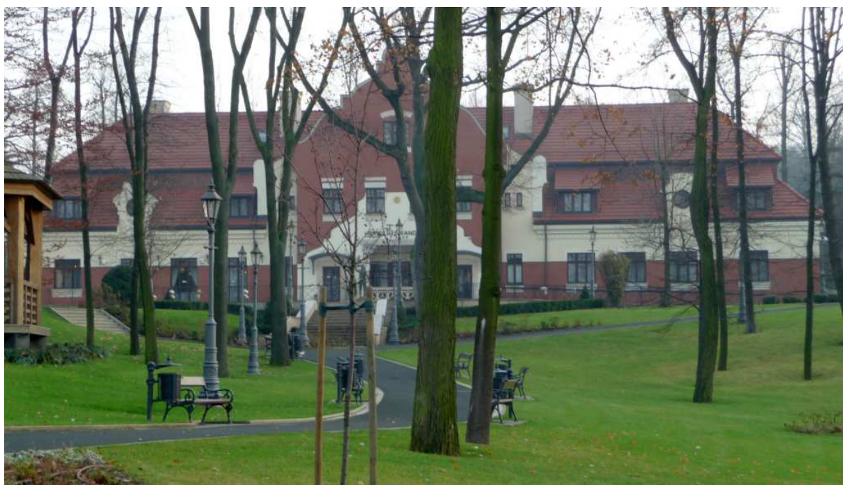
Fot. nr 173. Współczesna wersja Hotelu Grand Sal w Parku Kingi 7, który powstał w zrekonstruowanym budynku łaźniek salinarnych, wybudowanych na przełomie XIX i XX wieku. Do użytku został oddany w roku 2009. (25.11.2012)
