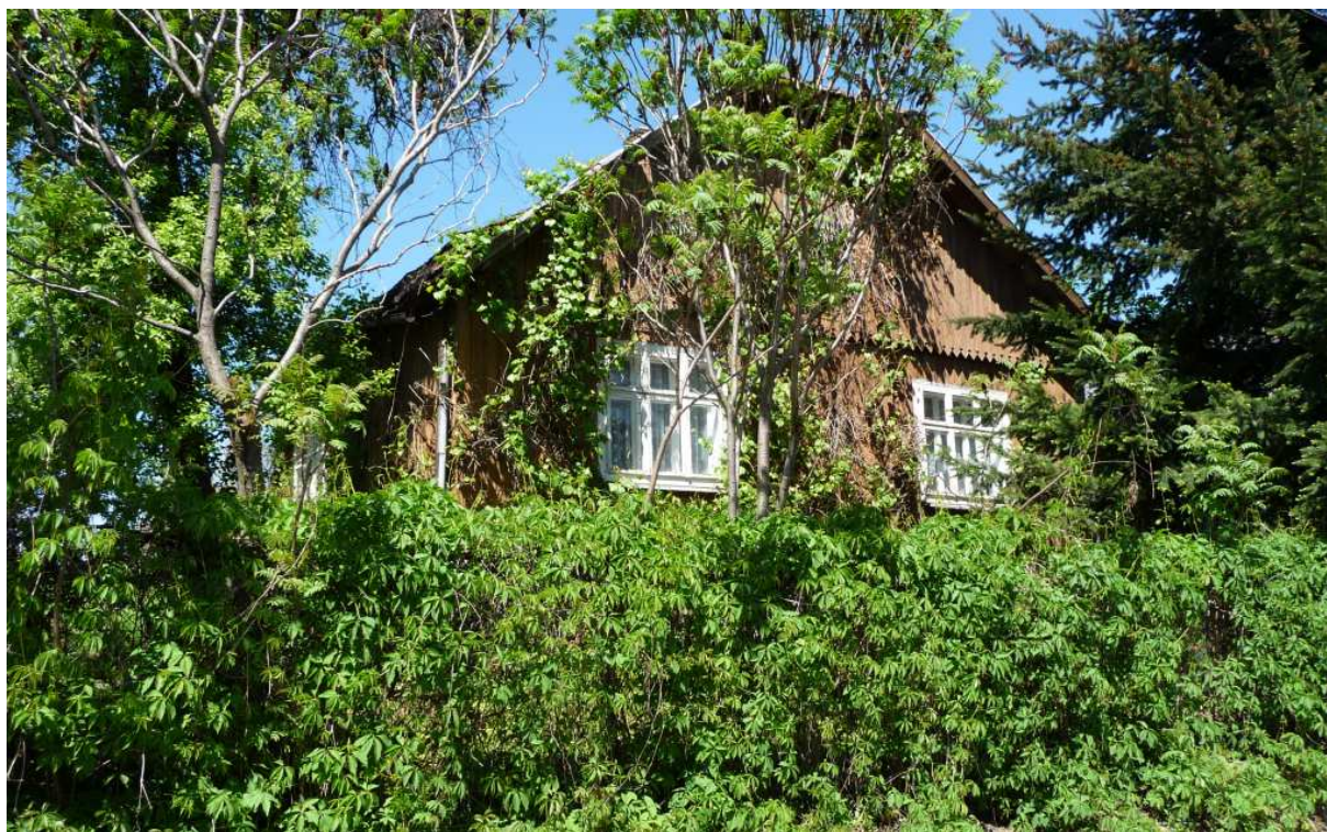
Fot. nr 223 (222-224). Próby uchwycenia ściany szczytowej i fasady. (09.05.2012)
