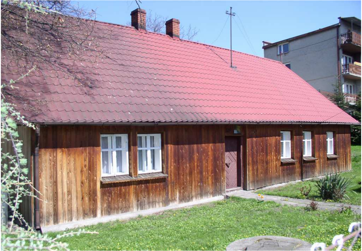
Fot. nr 100 (100-103). Chałupa pod nr 22 i jej oszalowana fasada od strony ulicy, niestety już wyburzona, choć była wpisana do GEZ. Mogła powstać pod koniec XIX wieku. (16.04.2009)
