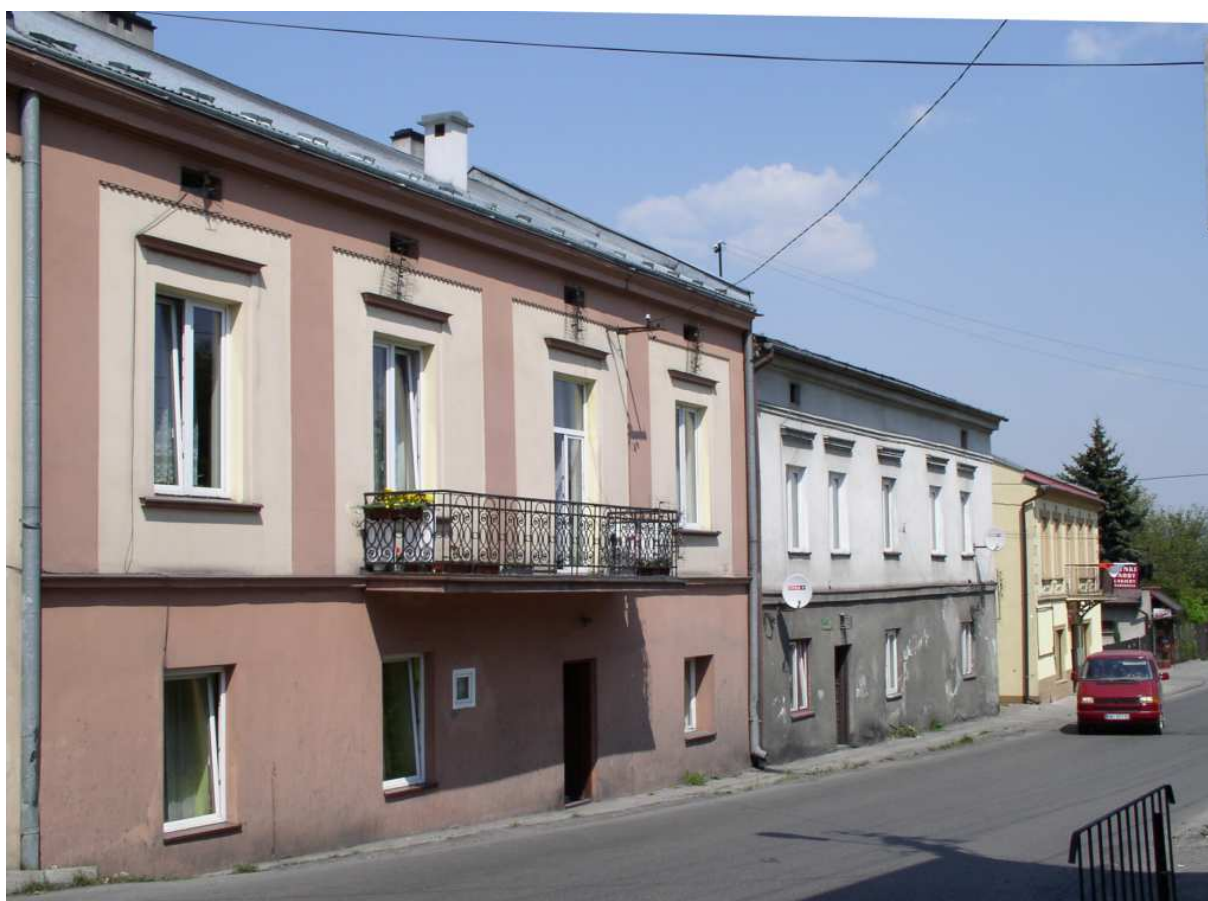
Fot. nr 534. Fragment zabudowy ulicy o nr: 25-29. Widoczne na zdjęciu domy z enklawy żydowskiej wg GEZ powstały przed rokiem 1786. (04.05.2009)
