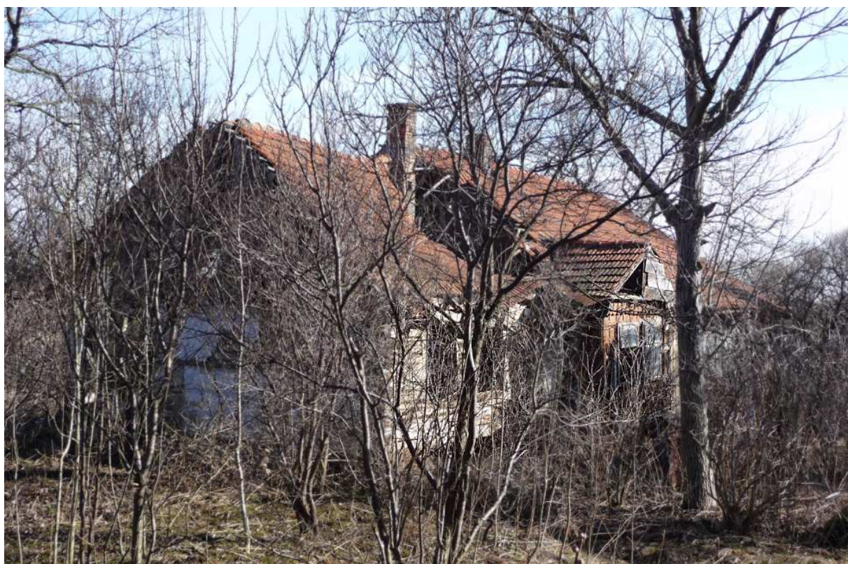
Fot. nr 496 (496-499). Próba uchwycenia przysłoniętej zaroślami ruiny rozległego domu drewnianego z początku XX wieku, może dawnej chałupy, spod nr 28 (?). (15.03.2012)
