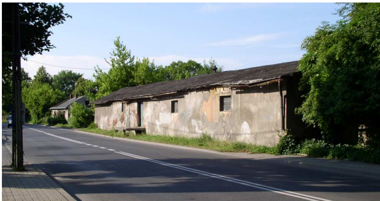
Fot. nr 227. Wyburzone magazyny kolejowe w sąsiedztwie domu pod 65. (22.06.2011)
