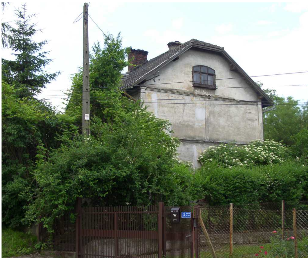
Fot. nr 198 (198-199). Boczna ściana szczytowa z oryginalnym oknem. (06.06.2011)
