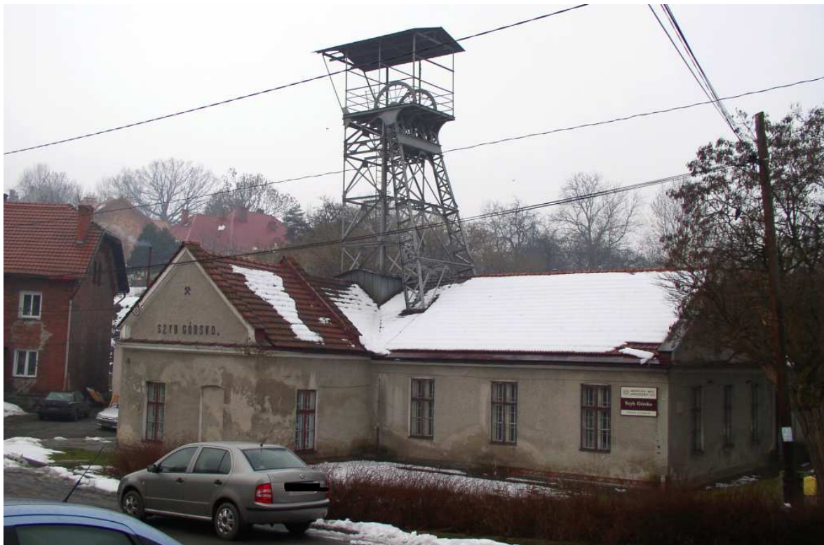
Fot. nr 39. Szyb Górsko, jeden z kilku w zespole KSW, którego nadszybie powstało na początku XIX wieku. Obiekt wpisany do Rejestru Zabytków. (03.03.2009)
