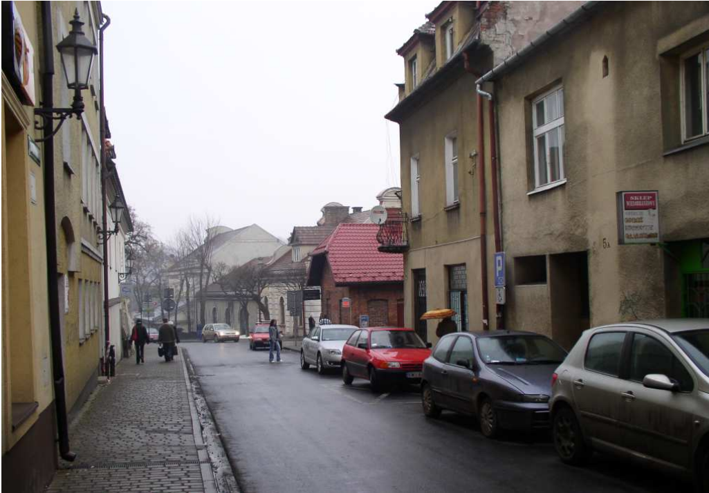
Fot. nr 84. Dolny odcinek ulicy o nr: 5-9. Domy pod nr: 5 i 7 znajdują się w GEZ. W tle zabudowa placu Kościuszki. (03.03.2009)
