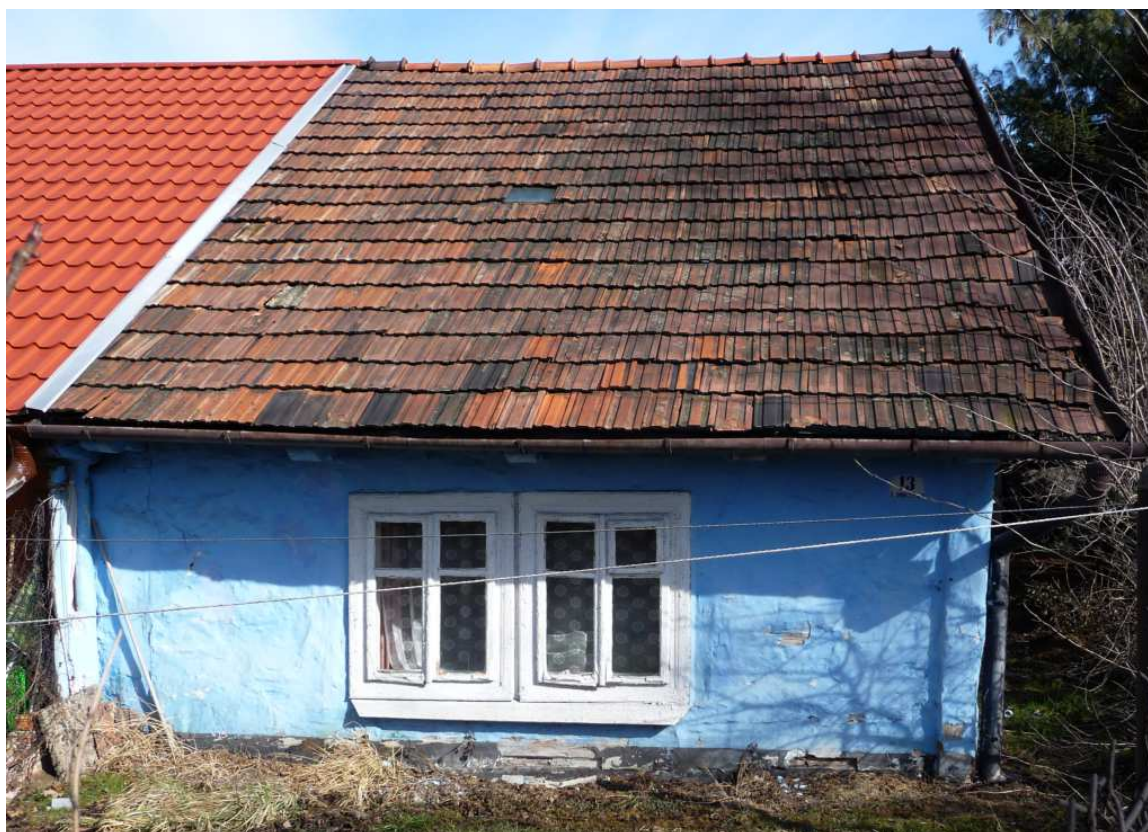
Fot. nr 447 (446-448). Archaiczny fragment fasady. (15.03.2012)
