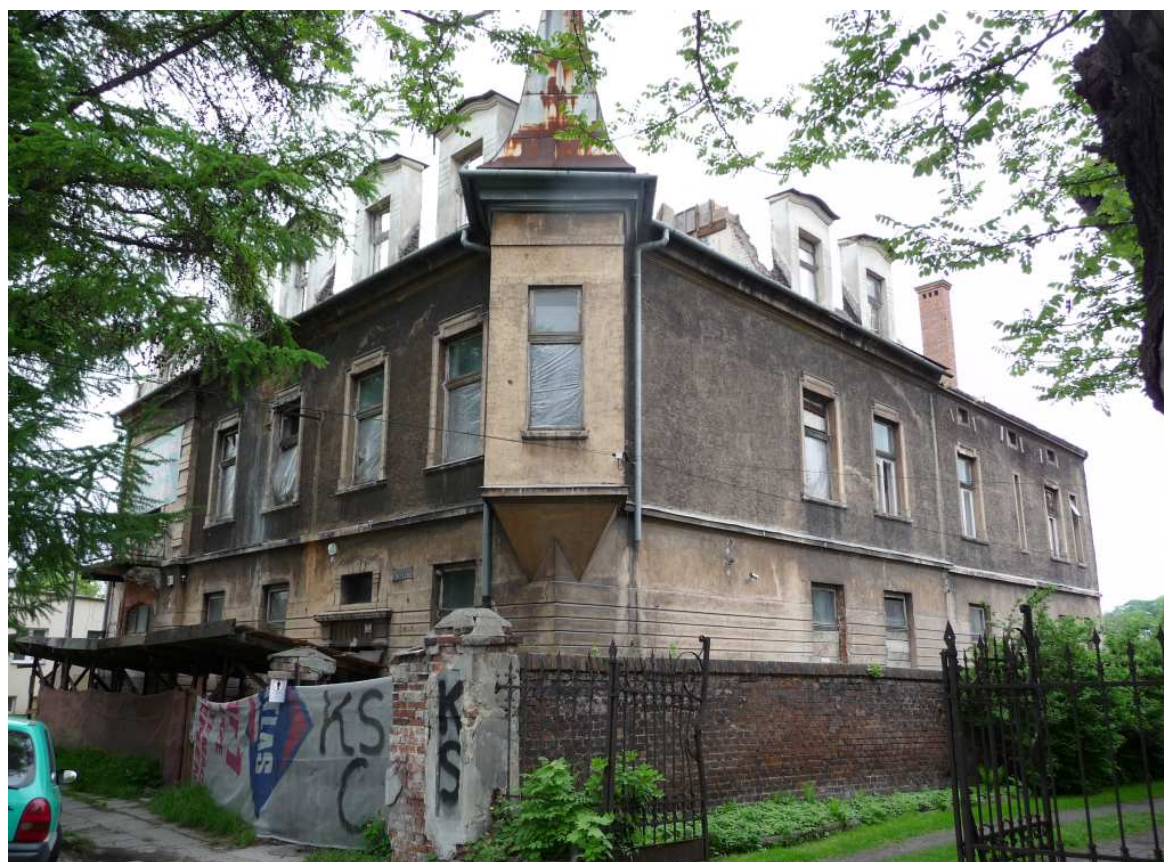
Fot. nr 269 (269-270). Wykusz na kształt wieży w narożu fasady. (08.05.2012)
