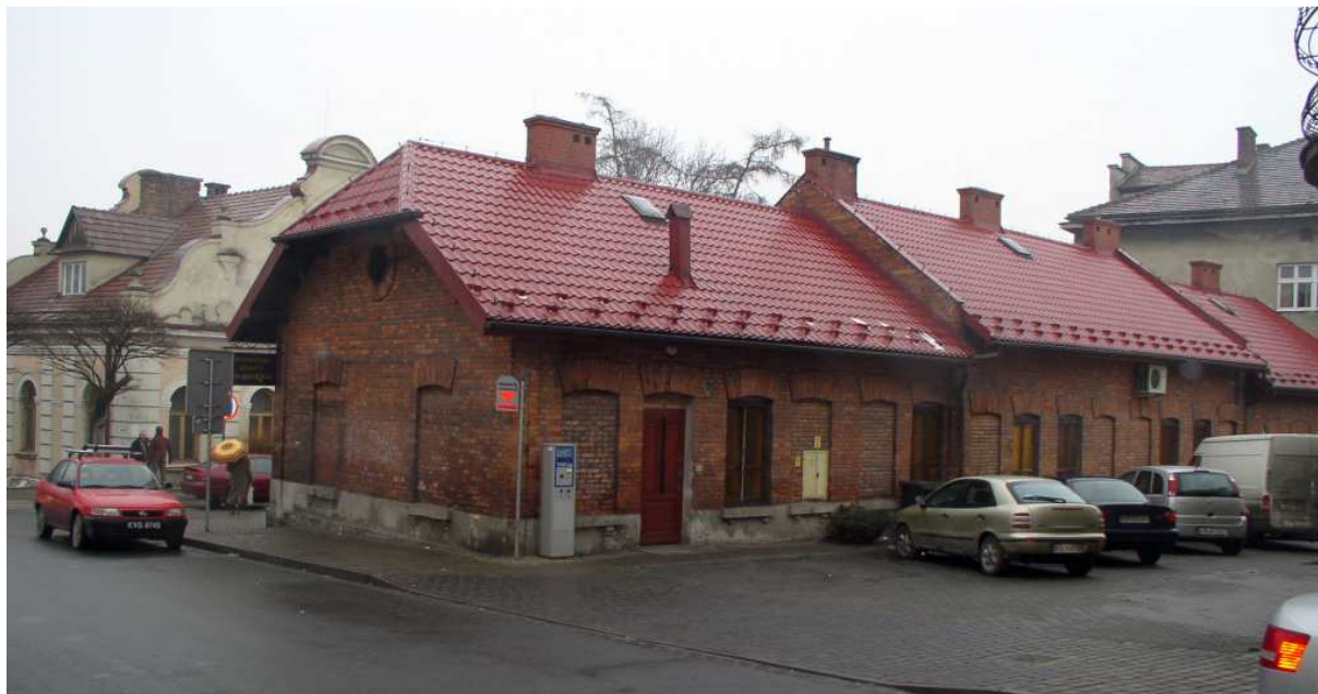
Fot. nr 87 (87-90). Dawne kramy masarskie do sprzedaży mięsa i wędlin przy ulicy Sikorskiego 9, powstałe w roku 1896 wg projektu Jana Hojarczyka, budowniczego miejskiego. Fot. nr: 87-88. Widoki od strony ulicy Sikorskiego. (03.03.2009)
