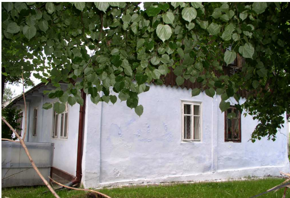
Fot. nr 214 (214-215). Boczna ściana szczytowa z oryginalnymi oknami. (06.06.2011)
