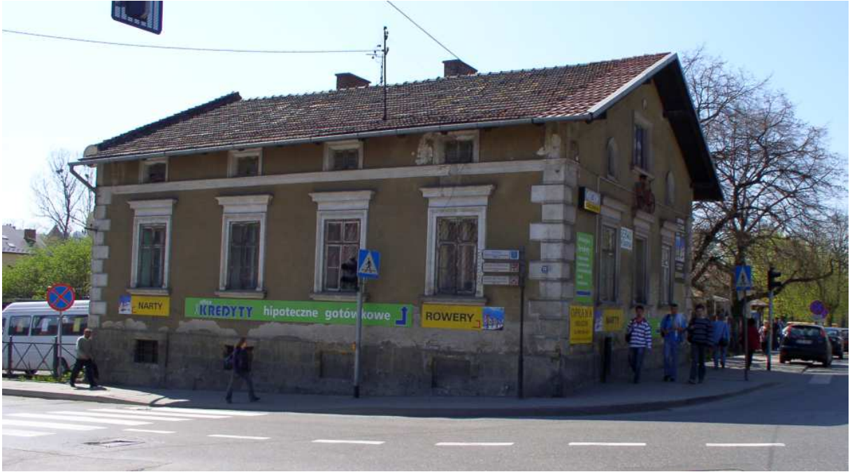
Fot. nr 381 (381-390). Wyjątkowej dla mnie urody oryginalny dom pod nr 12 (róg z ulicą Legionów), który powstał zapewne w ostatniej ćwierci XIX wieku. W nim mieszkał i tworzył Henryk Kozubski (1911-2021), zwany wielickim Chagalem. Budynek jest wpisany do Rejestru Zabytków, ale coraz bardziej zaniedbany. (16.04.2009)
