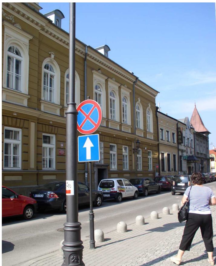
Fot. nr 29 (29-32). Fragment zabudowy ulicy o numerach: 2-6, powstałej pod koniec XIX wieku. Budynki o numerach: 4, 6, 10, 11-13 i 19 znajdują się w GEZ. (23.07.2010)
