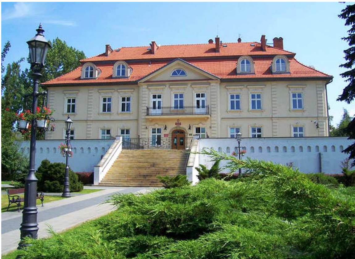
Fot. nr 399 (399-400). Fasada świeżo odrestaurowanego i przekształconego w siedzibę IPN pałacu Konopków, który powstał na pocz. ostatniej ćwierci XVIII wieku (obecny adres to plac Skulimowskiego 1). Obiekt wpisany do Rejestru Zabytków. (06.09.2009)
