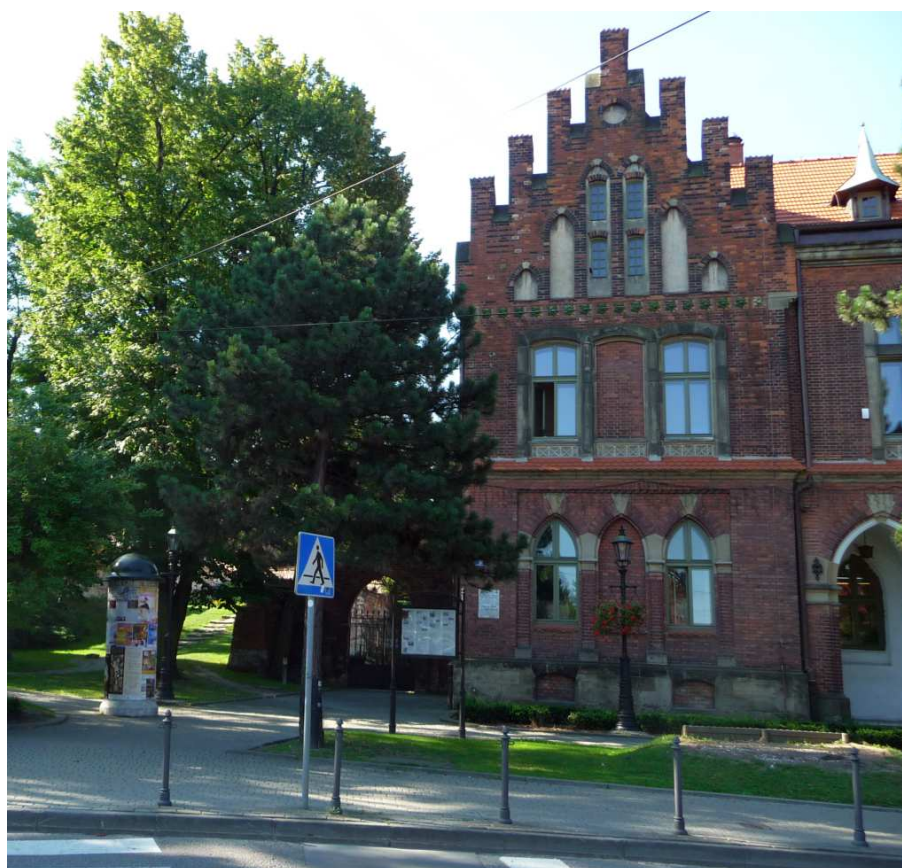
Fot. nr 281. Lewy ryzalit w fasadzie. (24.07.2012)
