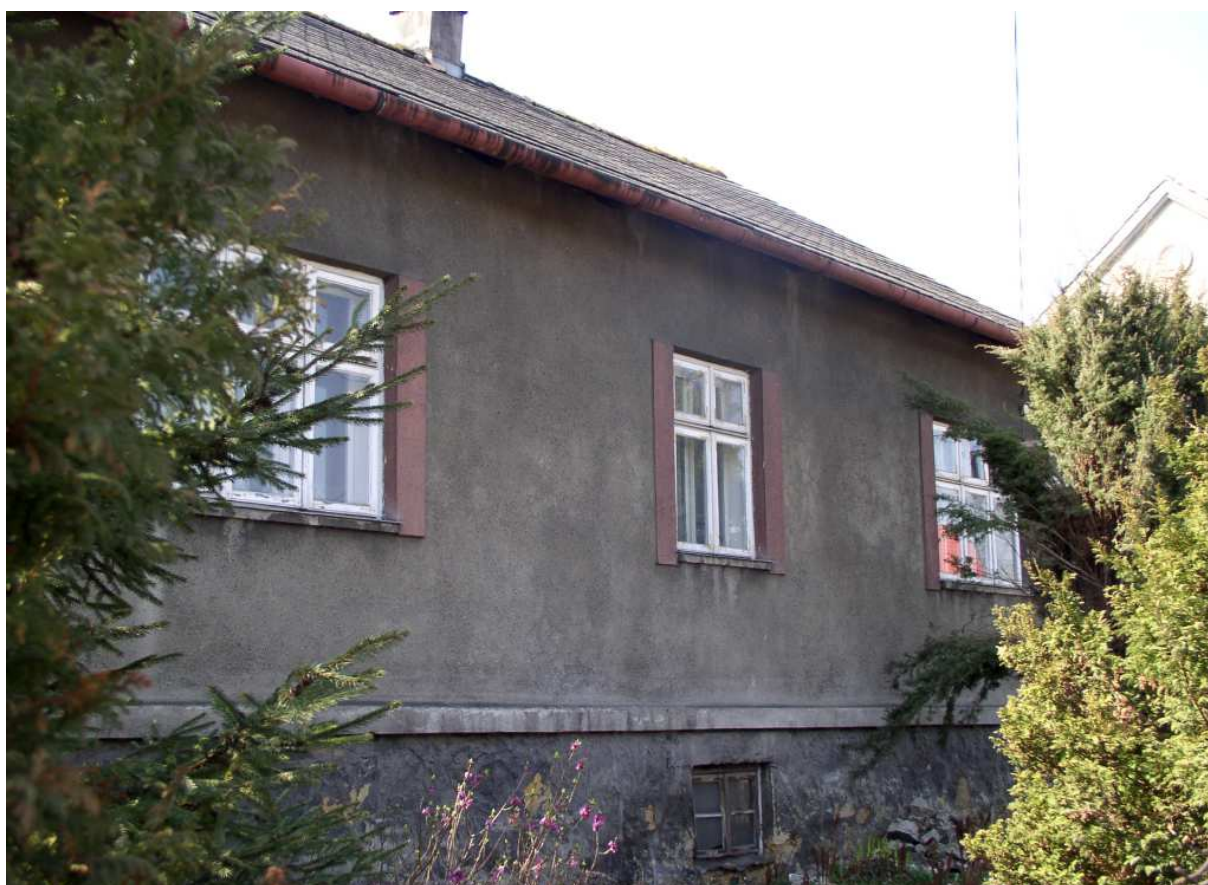
Fot. nr 429. Murowany dom spod nr 57, z oryginalnymi oknami typu skrzynkowego, który mógł powstać niedługo po zakończeniu II wojnie światowej. (04.04.2009)
