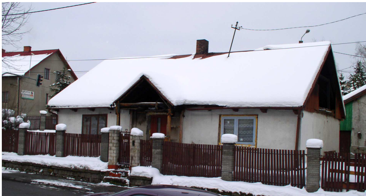
Fot. nr 341 (341-344). Dom drewniany pod nr 28, w oryginale wybudowany pod koniec XIX wieku XIX, ze znacznie zniekształconą z czasem fasadą. Obiekt figuruje w GEZ. (20.02.2009)
