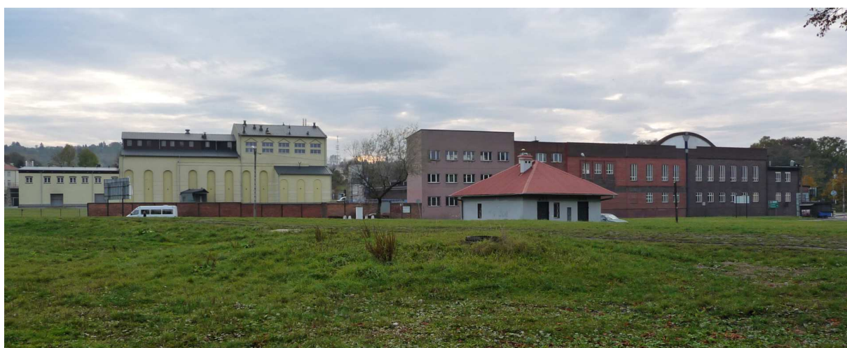
Fot. nr 237. Budynki KSW wzdłuż środkowego fragmentu ulicy. (26.10.2011)
