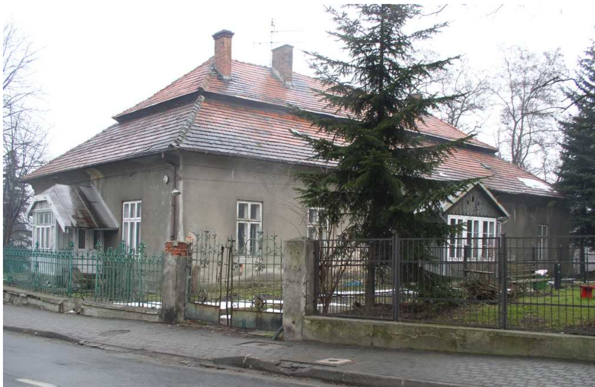
Fot. nr 306 (306-314). Widoki na elewację południową. (03.03.2009)
