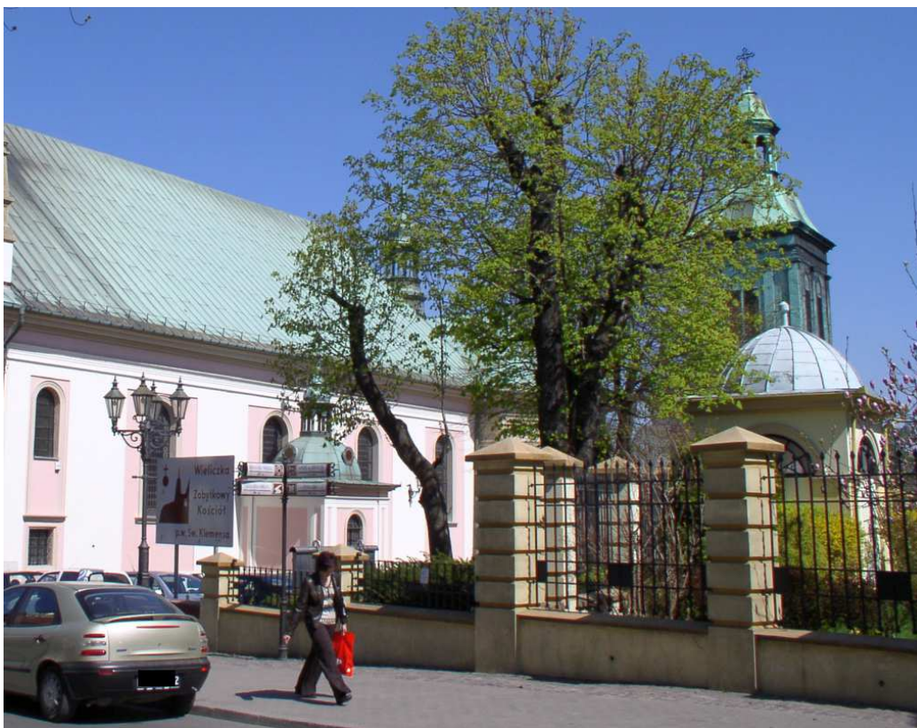
Fot. nr 112. Elewacja południowa. (16.04.2009)
