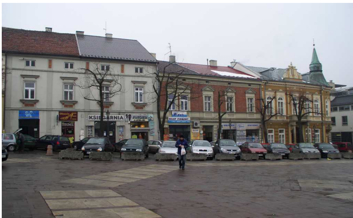
Fot. nr 6 (6-9). Zachodnia pierzeja Rynku o nr: 3-6. Domy o nr: 4 i 5 (tu pierwszy i drugi z lewej) znajdują się w GEZ, zaś obiekt w kształcie neorenesansowego pałacyku pod nr 6 w Rejestrze Zabytków. (03.03.2009)
