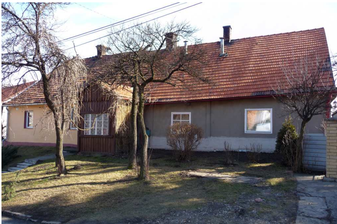
Fot. nr 488 (488-489). Drewniany dom z gankiem, pokryty tynkiem, na posesji pod nr 18, wpisany do GEZ. Miał powstać w I. połowie XIX wieku. (15.03.2012)
