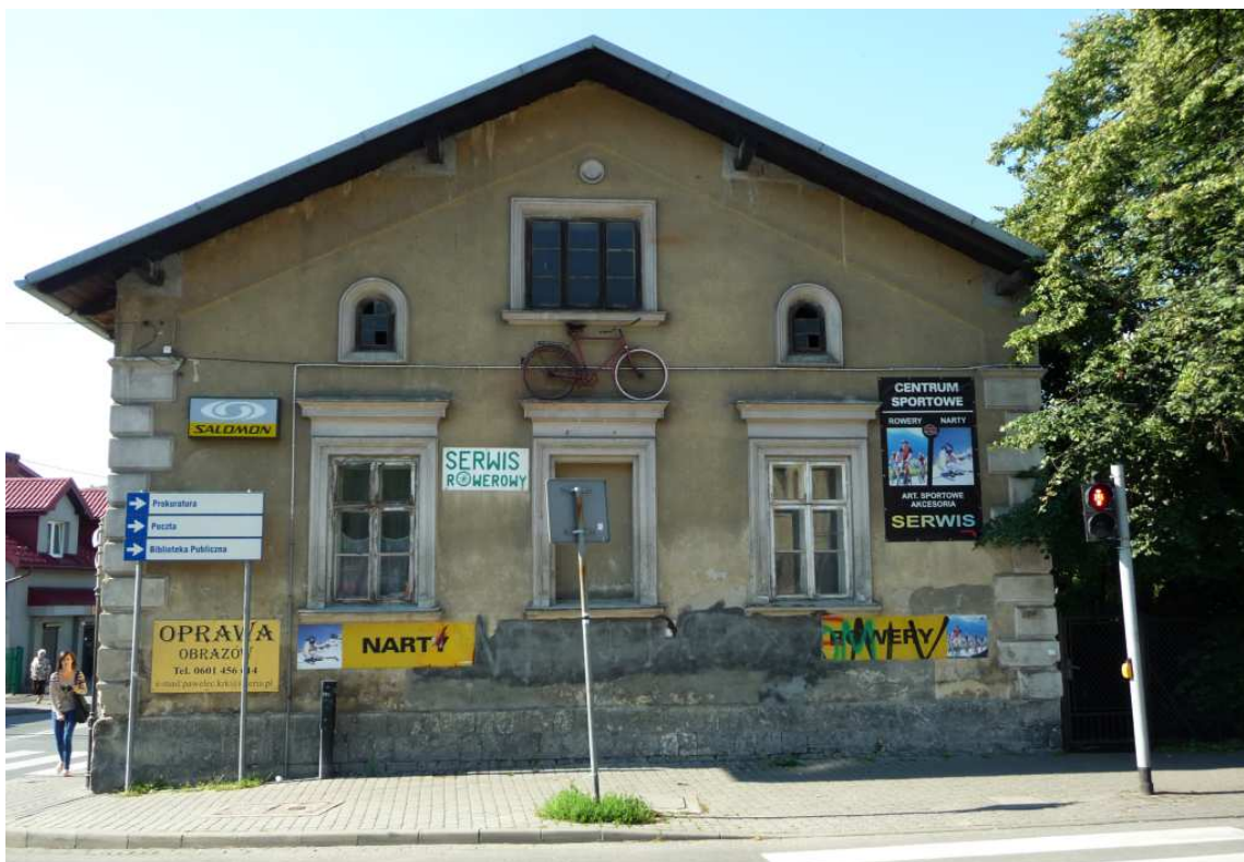
Fot. nr 387. Ściana szczytowa od strony ulicy Legionów. (24.07.2012)
