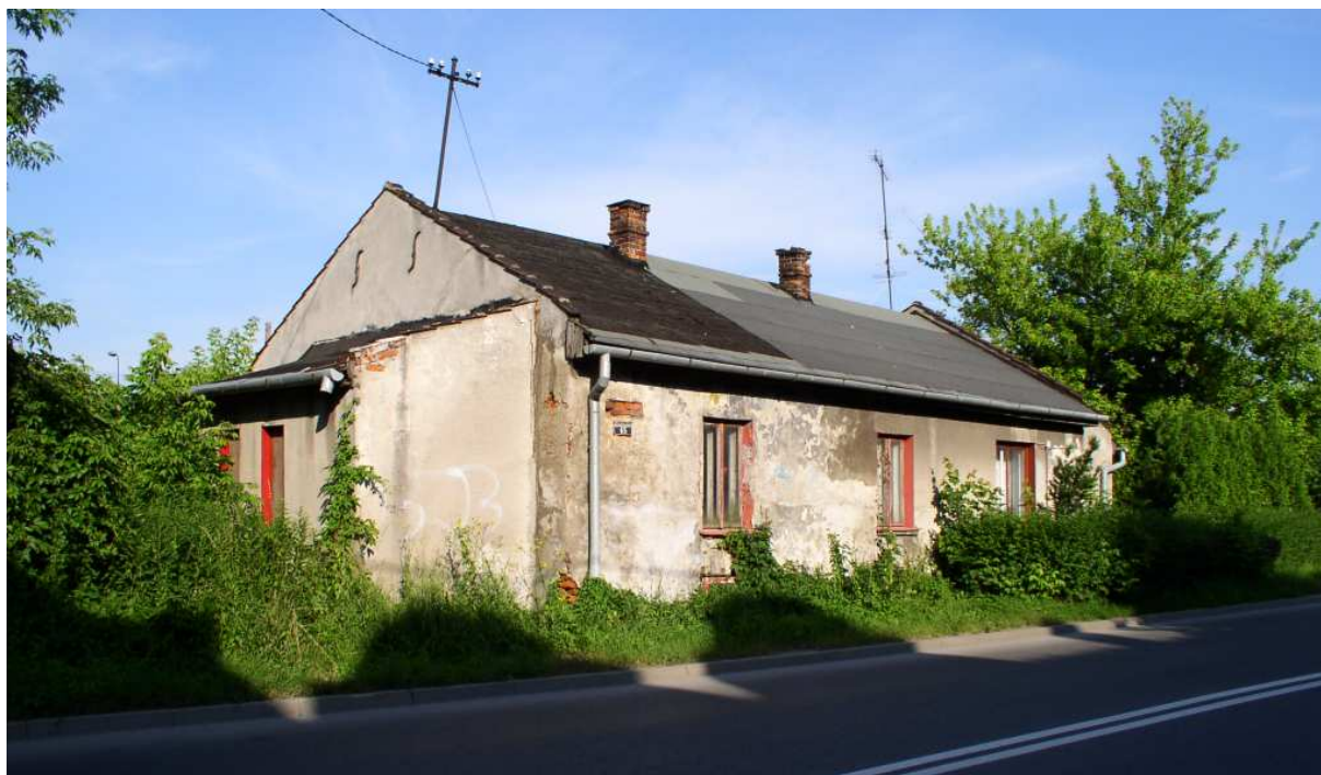
Fot. nr 226. Nieistniejący już dom, przylegający do stacji kolejowej Wieliczka, pod nr 65. (22.06.2011)
