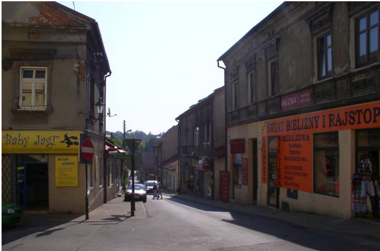
Fot. nr 76 (76-77). Ujęcia od strony Rynku Górnego. Pierwszy z prawej dom pod nr 1 z końca XIX wieku, wpisany do GEZ, a z lewej niska zabudowa o numerach: 2-6. (23.07.2010)
