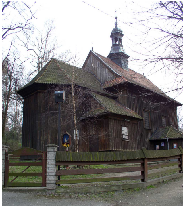
Fot. nr 461 (461-465). Kościół św. Sebastiana wg stanu przed ostatniej renowacji. Ta zabytkowa, drewniana świątynia o konstrukcji zrębowej, na zewnątrz oszalowana, była konsekrowana w roku 1598, ale jej bryła została przebudowana w XVII i głównie w XVIII wieku. W barokowo wyposażonym wnętrzu znajdują się polichromie Włodzimierza Tetmajera z początku XX wieku. (05.04.2009)
