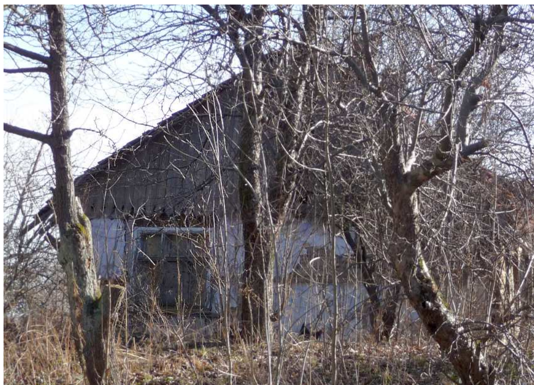
Fot. nr 499. Boczna ściana szczytowa. (15.03.2012)
