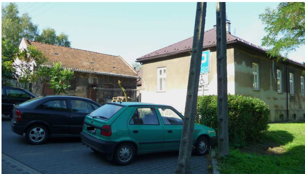
Fot. nr 481 (481-482). Fragmenty od strony podwórka. Lewe skrzydło. (24.07.2012)
