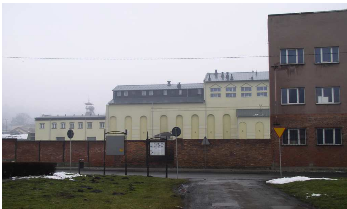
Fot. nr 149. Z budynkiem warzelni w tle. (03.03.2009)
