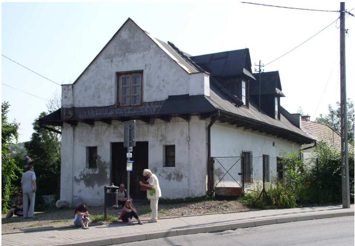
Fot. nr 263. Dom pod nr 11, z dobudowanymi facjatami. (23.07.2010)
