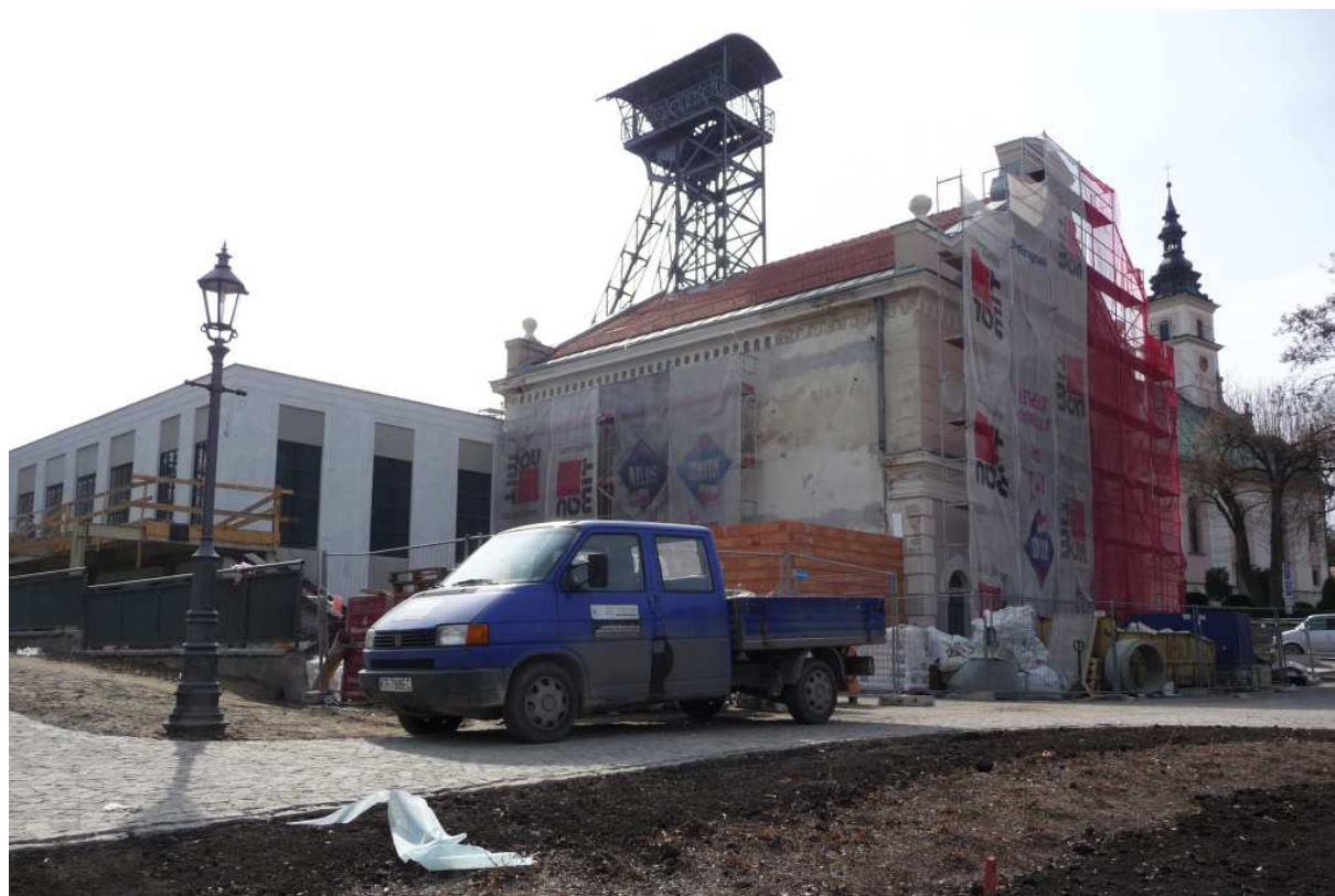
Fot. nr 95. Remont i rozbudowa zaplecza szybu z przeznaczeniem na obiekt sportowy. (27.03.2012)
