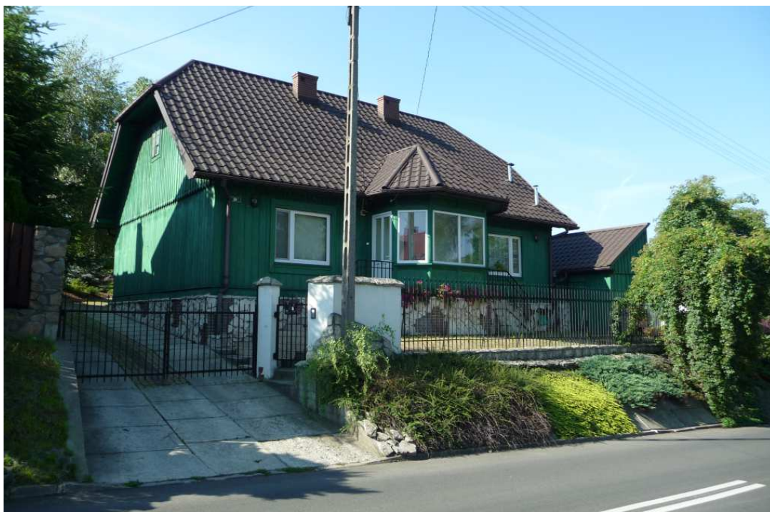
Fot. nr 545. Dom z gankiem spod nr 10, typowy dla zabudowy z lat 20. XX wieku. (24.07.2012)
