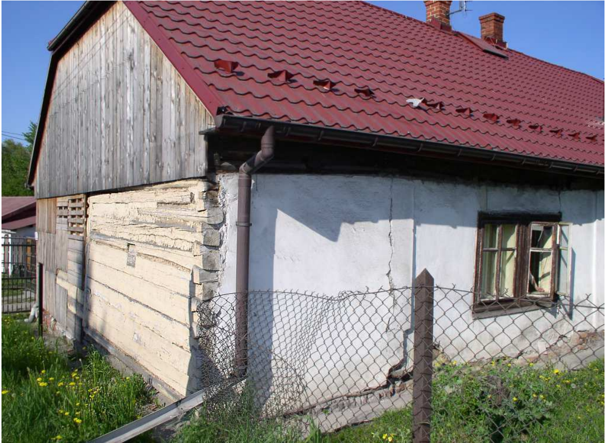
Fot. nr 410. Oryginalna, belkowana, drewniana faktura typu zrębowego widoczna w szczytowej ścianie od strony ulicy. (29.04.2009)
