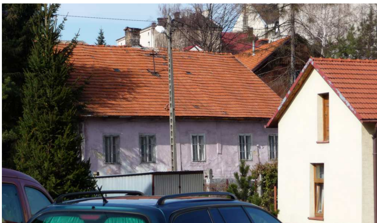
Fot. nr 67. Widok na fasadę z ulicy Limanowskiego. (15.03.2012)
