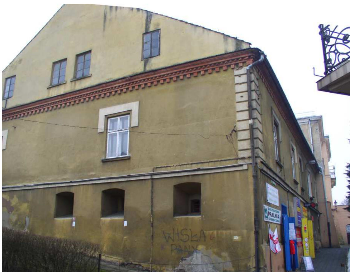
Fot. nr 58. Wpisany do Rejestru Zabytków dom z naroża Rynku 1 i ulicy Reymonta, wybudowany w roku ok. 1773 - widok na narożnik z ulicy Batorego. (03.03.2009)
