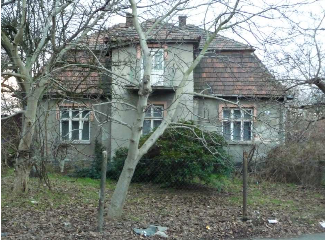
Fot. nr 194. Pełny widok na fasadę. (27.12.2012)
