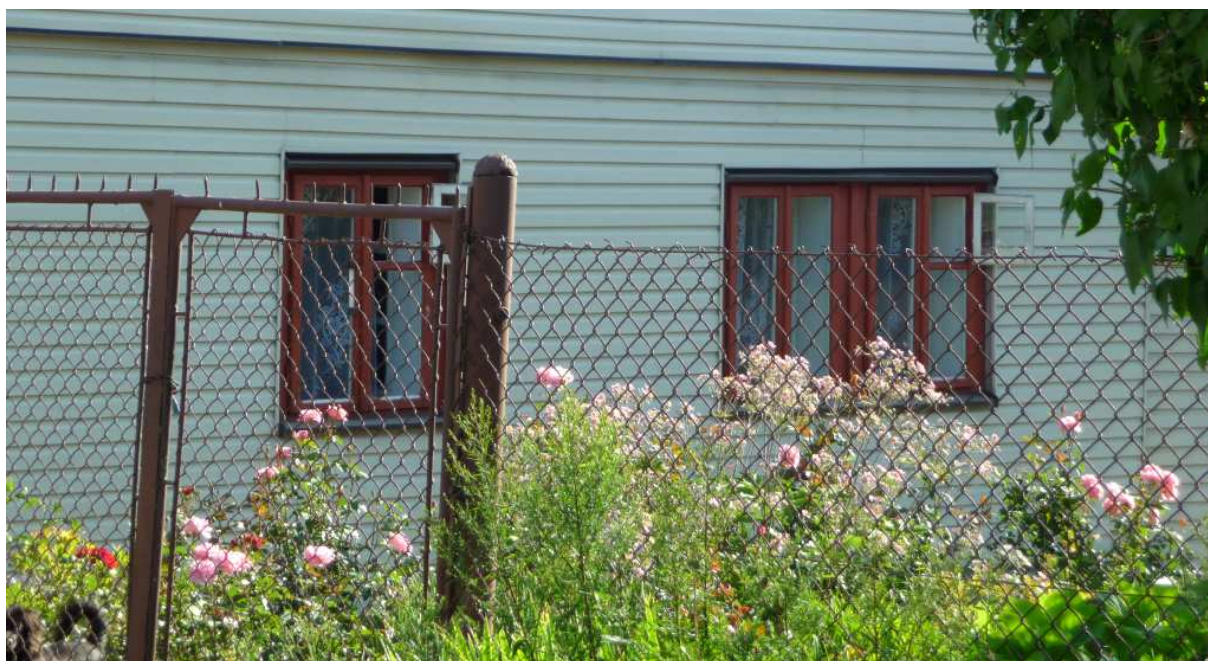
Fot. nr 53. Okna w ścianie szczytowej. (24.07.2012)
