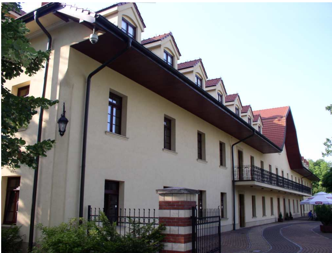
Fot. nr 232 (232-232. Wybudowana od nowa Turówka z zespołu dawnej warzelni KSW, przy ulicy Żeromskiego 1, a mimo to obiekt znajduje się w Rejestrze Zabytków. Fot. nr:232-233 - widoki na tylny fragment od strony stacji kolejowej. (22.06.2011)
