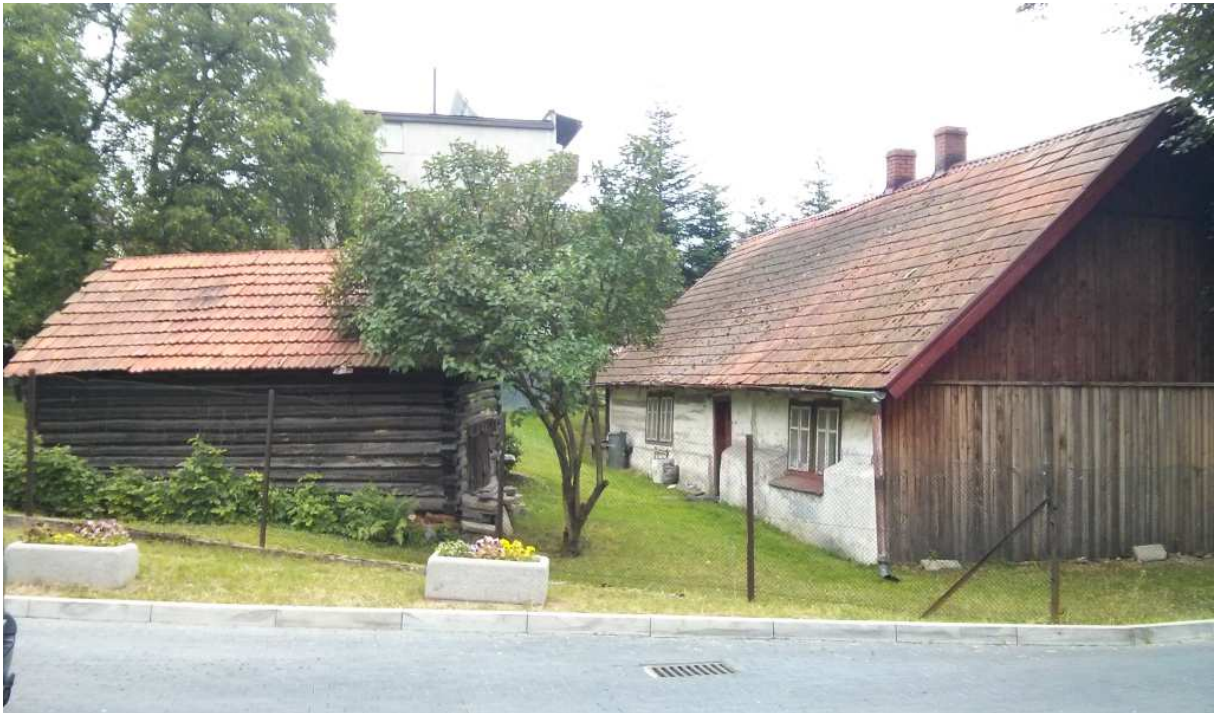
Fot. nr 101 (101-103). Ujęcia nieistniejącej już zagrody od strony podwórka. W tym przypadku odstępuje od przyjętych ram czasowych. Zdjęcia z roku 2015. (29.06.2015)
