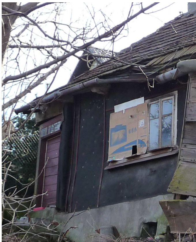
Fot. nr 477. Detale fasady. (15.03.2012)
