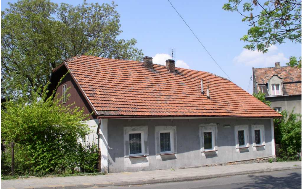
Fot. nr 531. Fasada tuż po wymianie okien skrzynkowych na bezpodziałowe plastiki. (04.05.2009)
