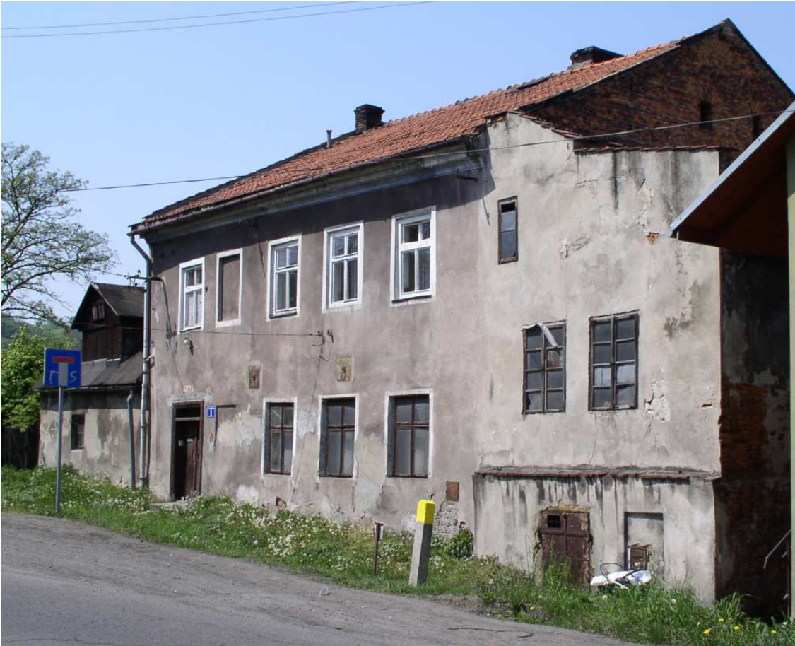
Fot. nr 537. Dom z ulicy Wiejskiej 1, narożu z ulicą Kłaśnieńską, zapewne jeszcze XIX-wieczny i przylegający do niego niski, nieistniejący już budynek dawnego młyna. W prawym fragmencie domu mieszkała rodzina Schönkerów. Obiekt wpisany do GEZ. Z prawej fragment dachu domu Armerów spod nr 31. (04.05.2009)
