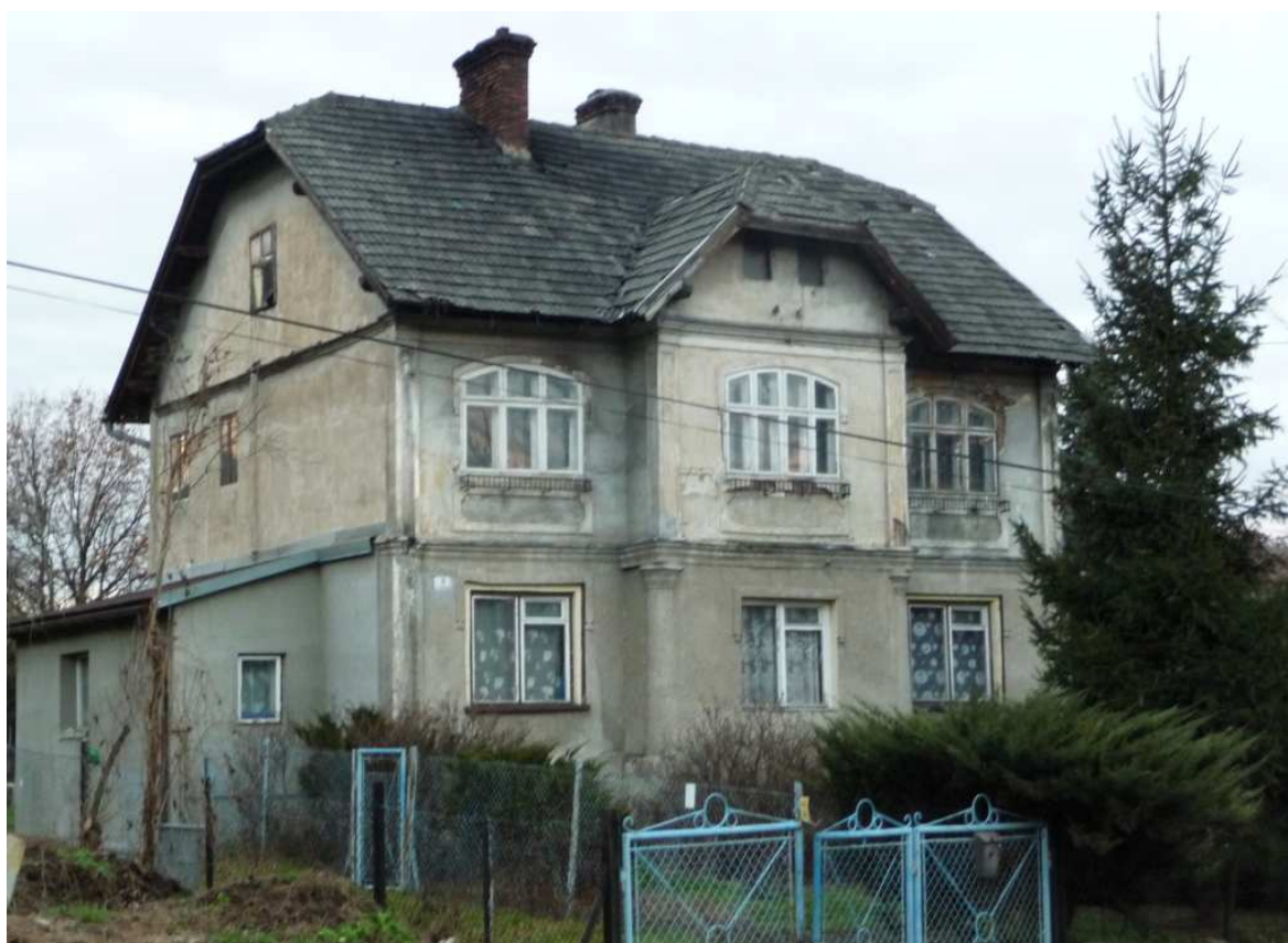
Fot. nr 197. Bliska oryginałowi fasada, typowo klasycystyczna, gdzie na pierwszym piętrze obiektu przetrwały okna typowe dla tego okresu. (27.12.2012)
