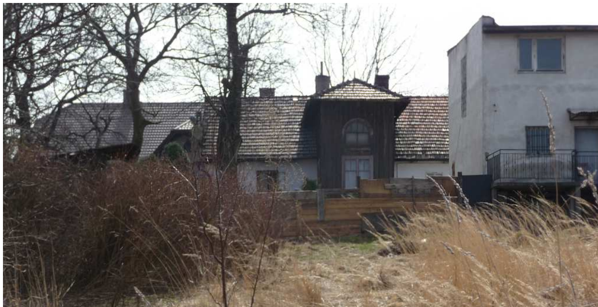
Fot. nr 216. Tył chałupy od strony dawnego ogrodu, z gankiem z loggią widokową pośrodku. (27.03.2012)
