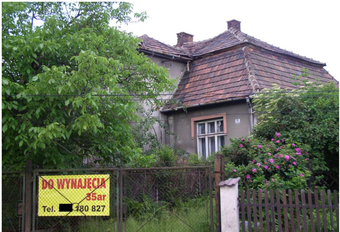
Fot. nr 191 (191-194). Zapewne międzywojenny już dom na kształt willi spod nr 16. Obiekt nie figuruje w GEZ. (06.06.2011)
