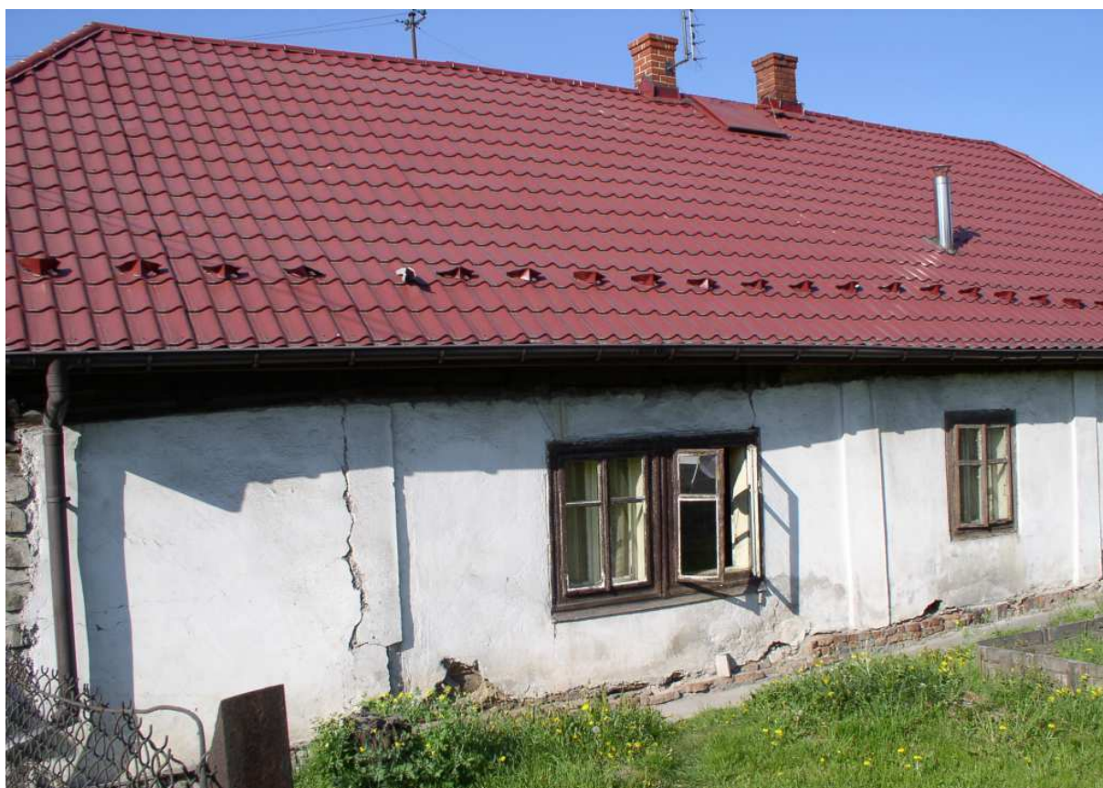
Fot. nr 409. Oryginalne okna typu ościeżnicowego. (29.04.2009)
