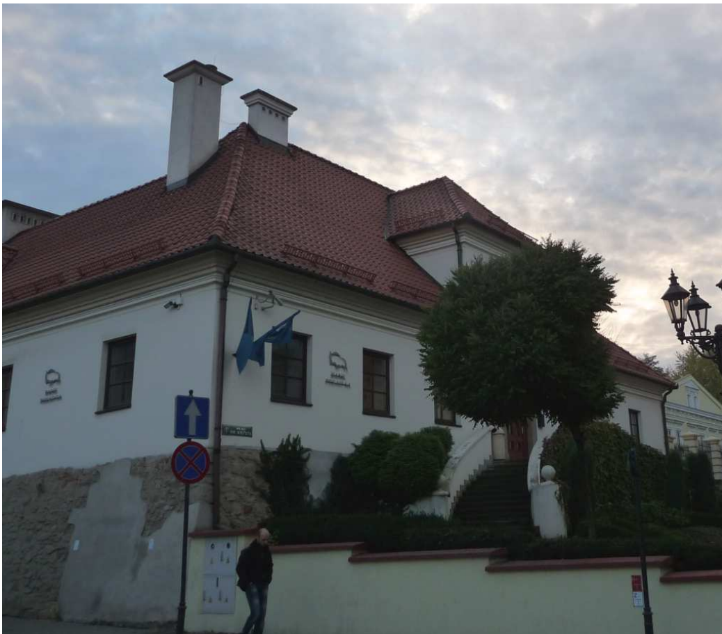
Fot. nr 86. Klasycystyczny budynek tzw. Wikarówki pod nr 8, świeżo po odnowie. Powstał w roku 1819, w miejscu starej plebanii, lecz do końca XIX wieku był kilka razy przebudowywany. (26.10.2011)
