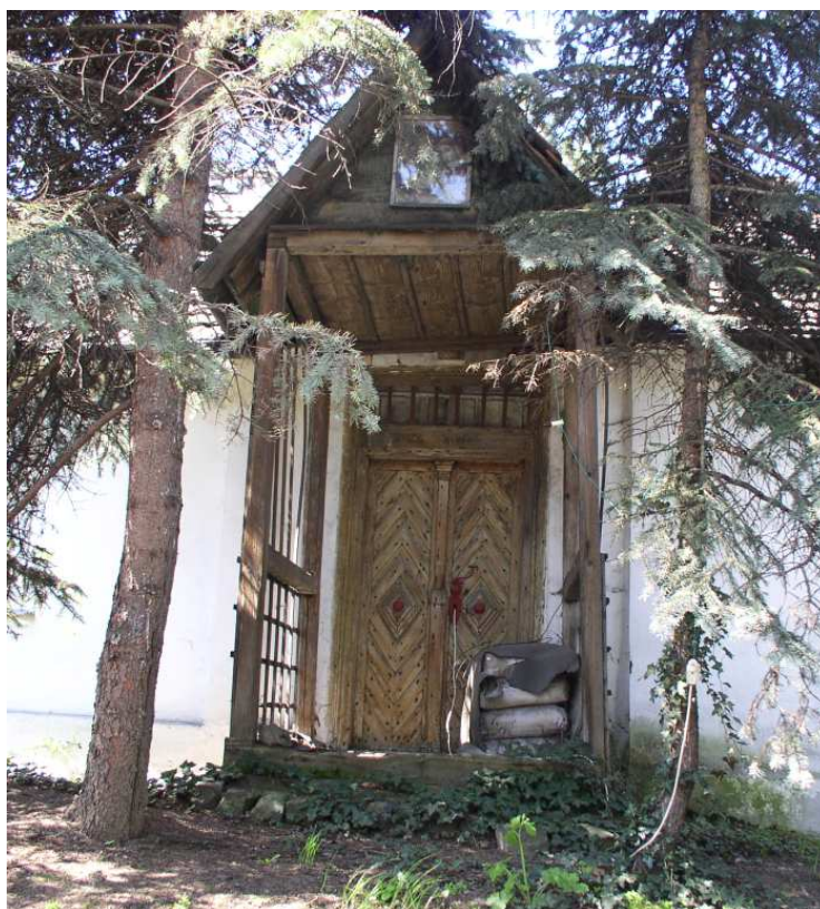
Fot. nr 407. Ganek na kształt portyku. (16.04.2012)
