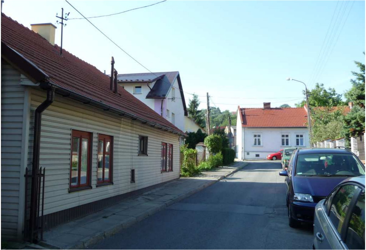
Fot. nr 50 (50-53). Pokryta sidingiem drewniana chałupa z I. połowy XIX wieku spod nr 12 i jej detale. Obiekt jest wpisany do GEZ (24.07.2012)
