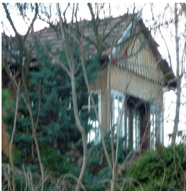
Fot. nr 225. Obudowany ganek od strony ogrodu. (27.12.2012)
