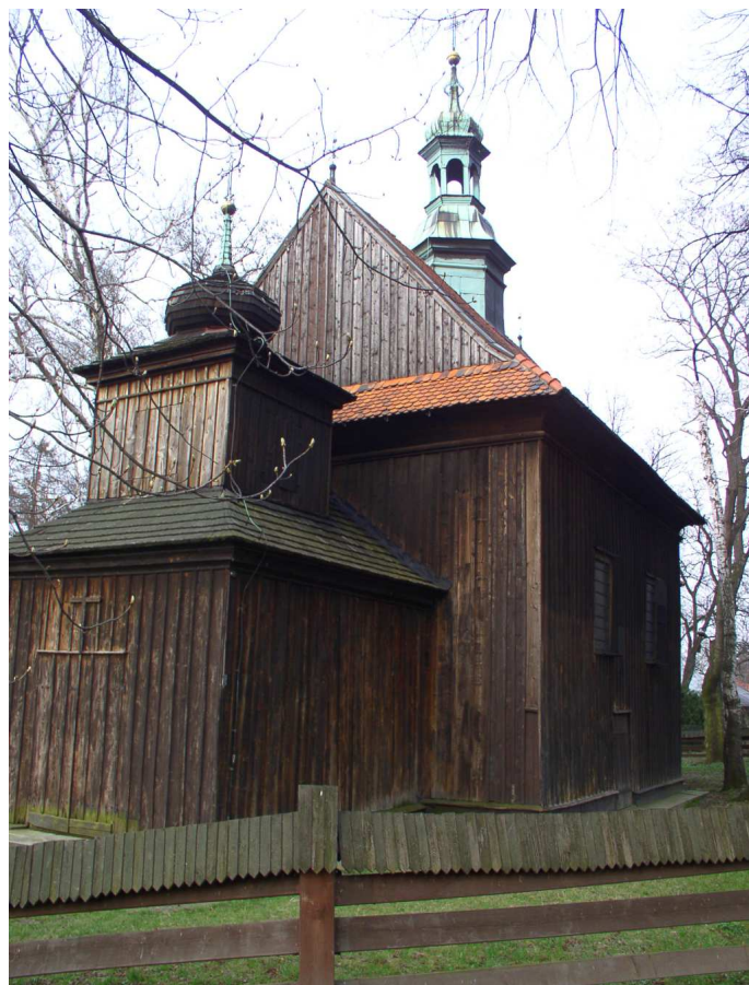
Fot. nr 464. Zachodnie wejście z kruchtą. (05.04.2009)
