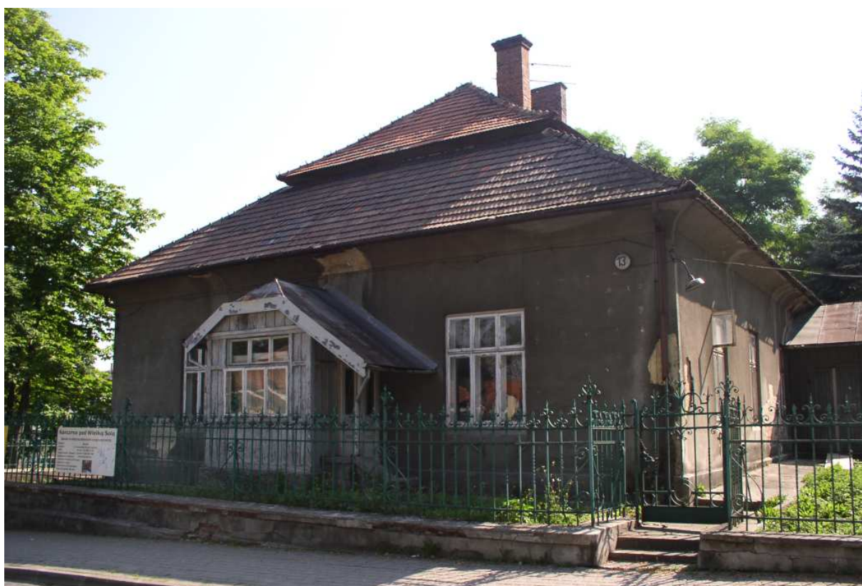
Fot. nr 303 (303-305) Boczna ściana szczytowa z obudowanym gankiem przy wejściu. (23.07.2010)
