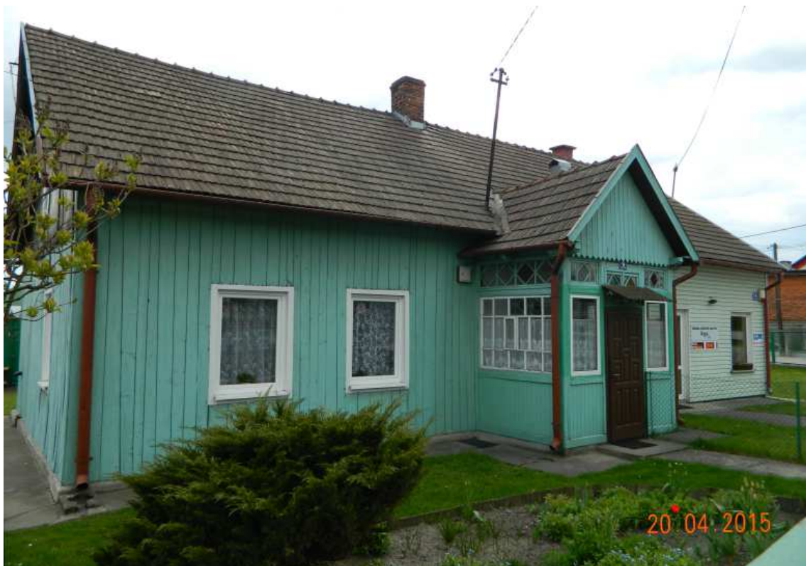
Fot. nr 175 (175-177). Zniekształcona przez nowe okna fasada domu z ul. Kościuszki 19.
