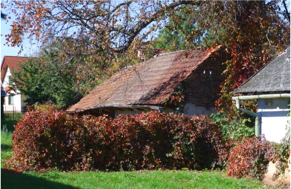
Fot. nr 293 (293-294). Próba uchwycenia budynków przylegających do chałupy od strony ogrodu.
