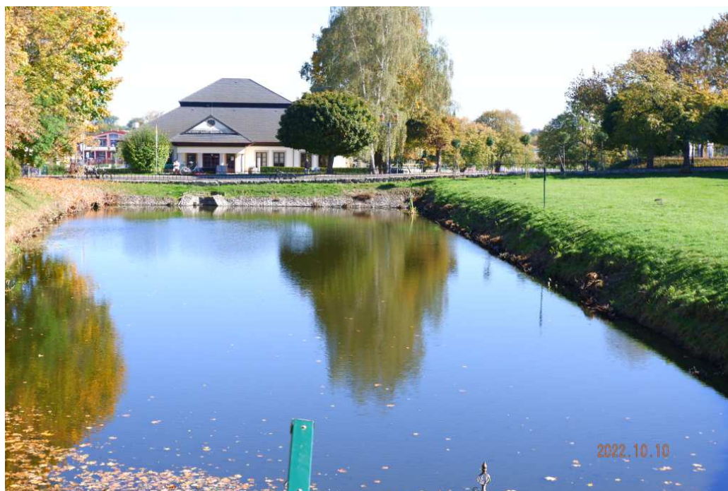
Fot. nr 300 (300-301). Stylizowany dworek przy ulicy Spółdzielczej 4. A obok, pod nr 7, nieuchwycony przeze mnie Dom „Na Kazimierzu”, wpisany do rejestru zabytków.
