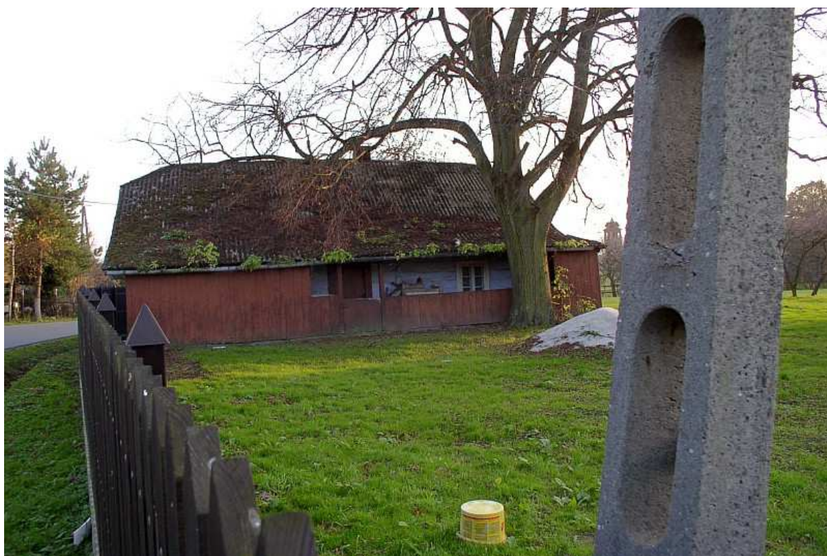
Fot. nr 324. Widok na tylny fragment osłonięty okapowym dachem. (23.10.2010)
