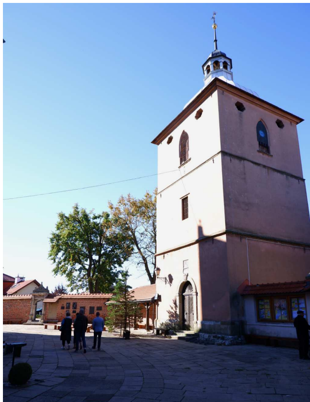
Fot. nr 203. Przykościelna dzwonnica.
