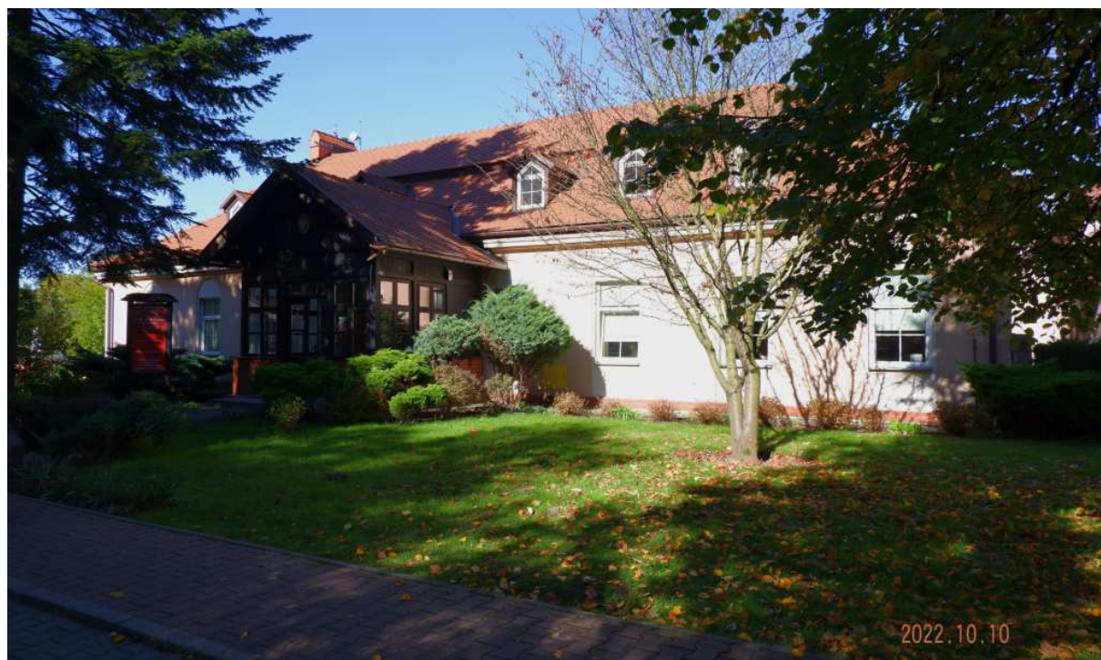
Fot. nr 280 (280-281). Dawny budynek folwarczny przy ulicy Zamkowej 5, gdzie obecnie mieści się UMiG Niepołomice i jego Wydział Planowania Przestrzennego i Nieruchomości.
