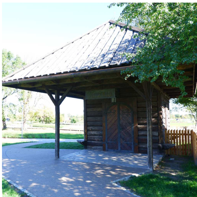
Fot. nr 234 (234-236). Luźna kompozycja kuźni, która powstała z wykorzystaniem niewielkich fragmentów zabytkowych chałup z Mogiły z ulic: Kopaniec 15 i Powiatowej 11.
