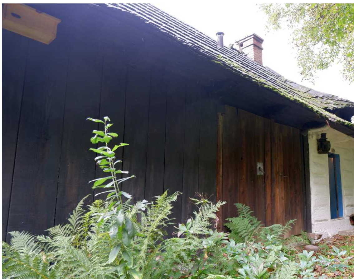
Fot. nr 36. Przylegająca do chałupy stodoła.
