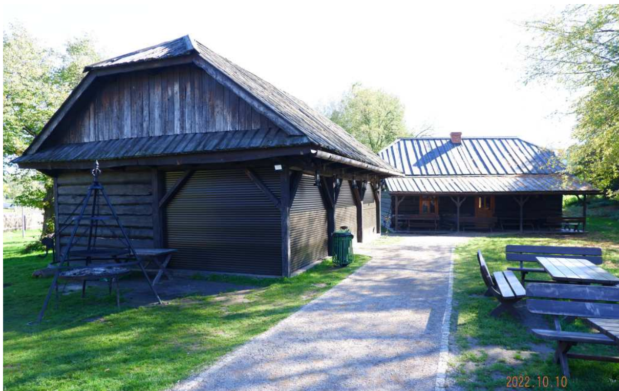
Fot. nr 244 (244-246). Dom z elementami konstrukcji przysłopowej i dachem okapowym, siodełkowym, którego fasada znika pod żaluzją. To typowy obiekt usługowy.
