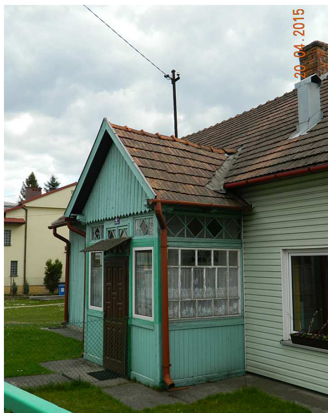
Fot. nr 176. Ciągłe bliski oryginałowi oszklony ganek.
