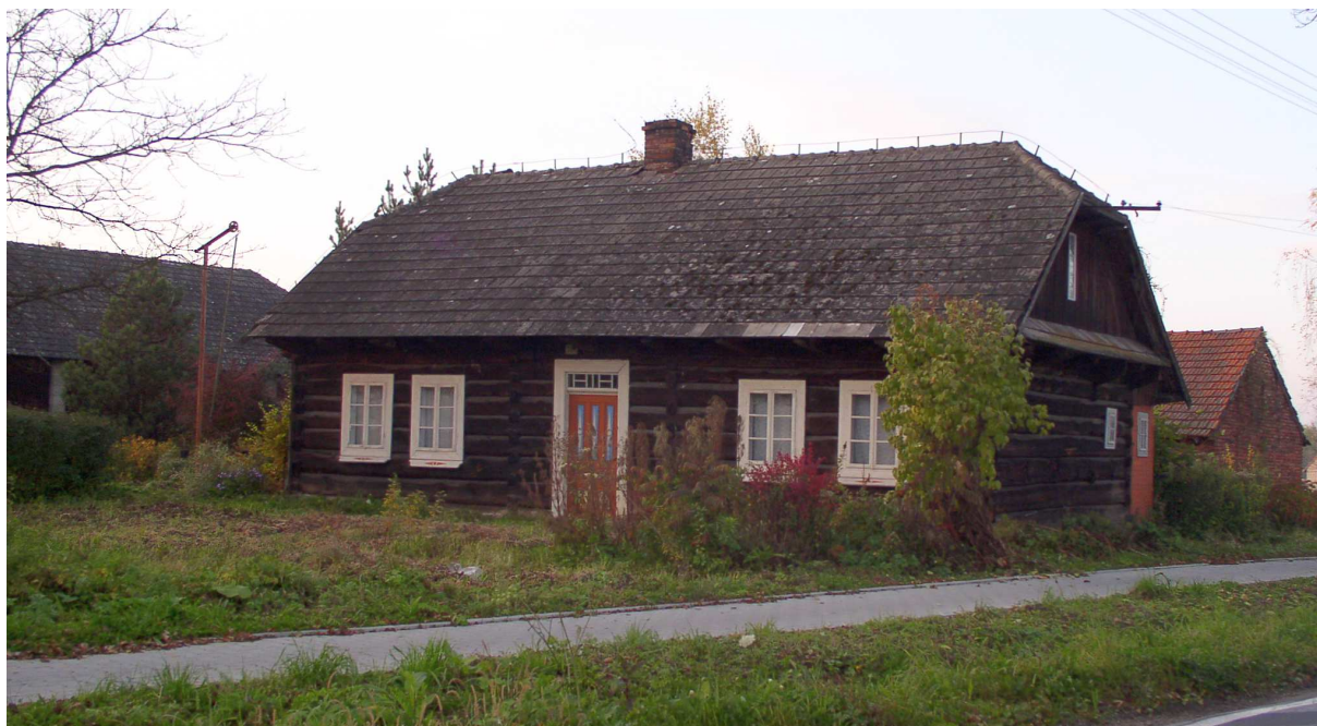
Fot. nr 309. Zapewne około 100-letni dom z naczółkowym dachem i okapem pod nr 227. (23.10.2010)
