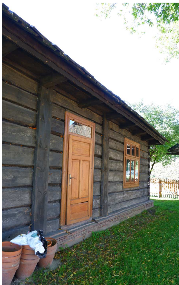
Fot. nr 240. Drzwi i okno typu weneckiego typowe dla lat 30. XX wieku
