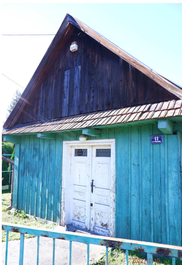
Fot. nr 224. Boczna, szczytowa ściana i wejście pod nr 11.
