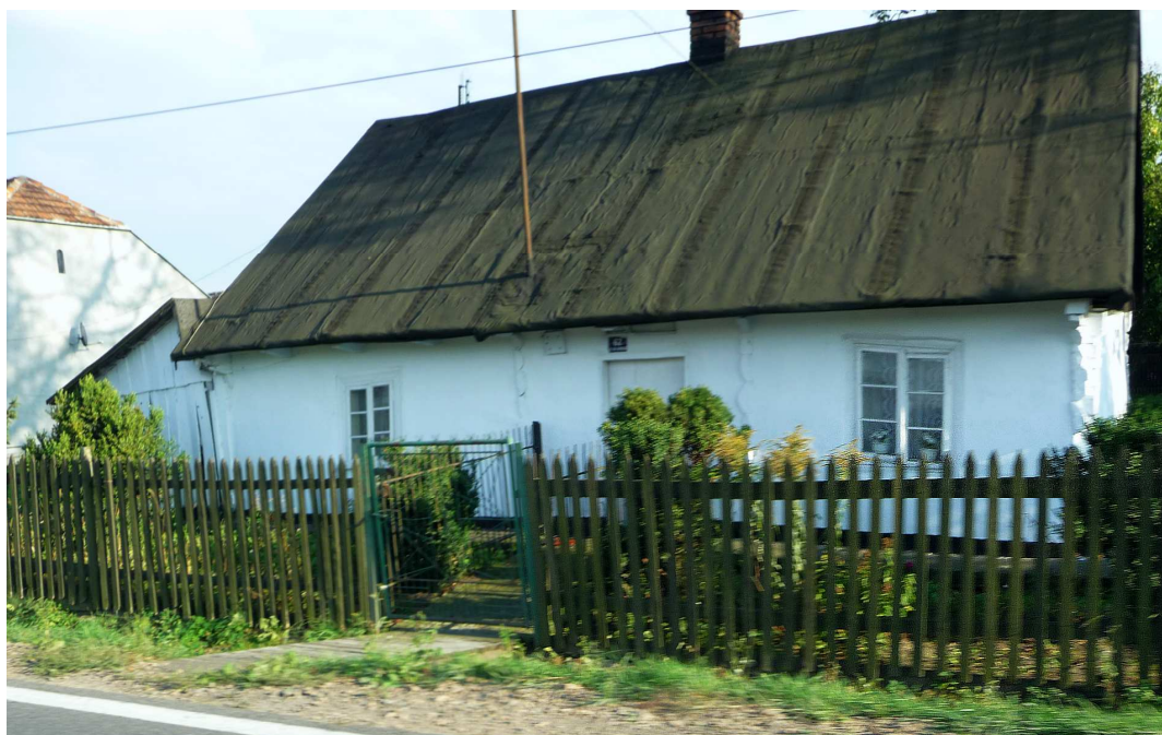
Fot. nr 308. Wiekowa chałupa z ulicy Batoiego 62, wkrótce po renowacji i usunięciu pęknięcia w dachu i w fasadzie. (16.09.2012)
