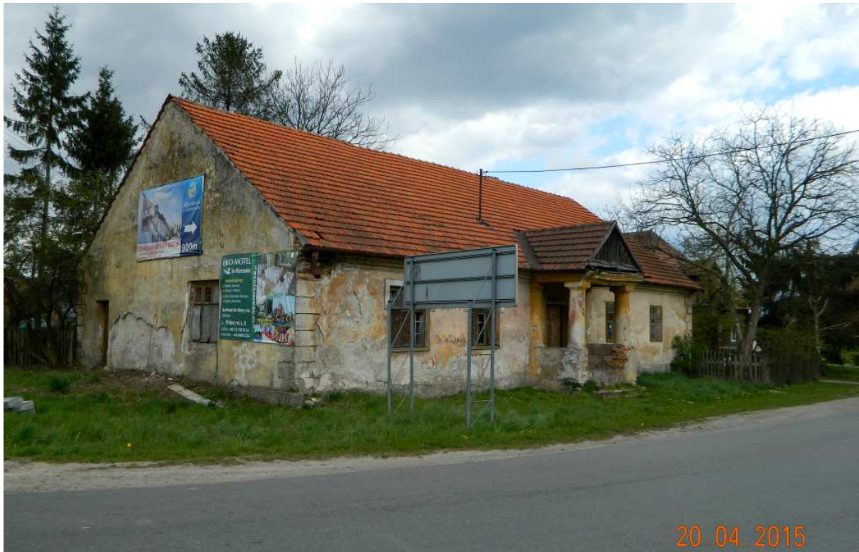
Fot. nr 127 (127-129). Fasada obiektu, usytuowanego przy bocznej drodze do Zakrzowca. Powstał on, w stylu dworkowym, pod koniec XIX wieku.
