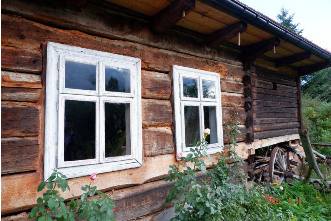
Fot. nr 83. Późniejsze okna, zapewne z lat 20. XX wieku.
