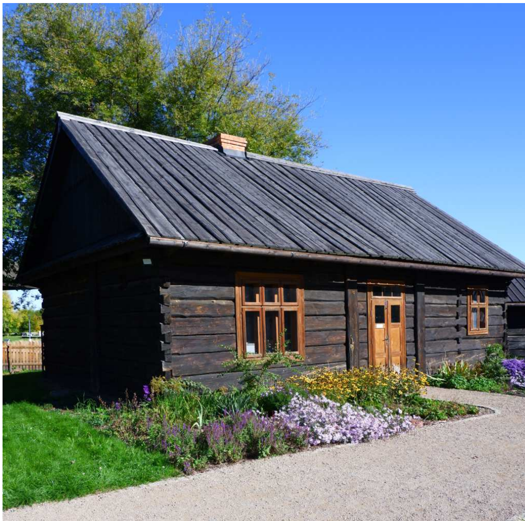
Fot. nr 237 (237-240). Dom przy kuźni. Osnowa drewniana może pochodzić nawet z XIX wieku, natomiast okna we wszystkich obiektach w osadzie to detale typowe dla przełomu lat 20/30 XX wieku, co musi budzić niesane odczucia.
