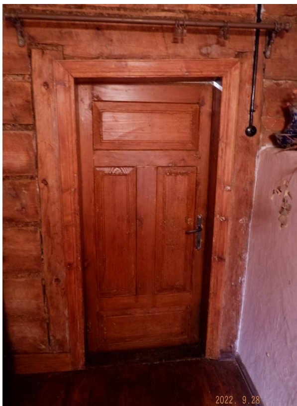
Fot. nr 12. Drzwi wejściowe, te już oryginalne.
