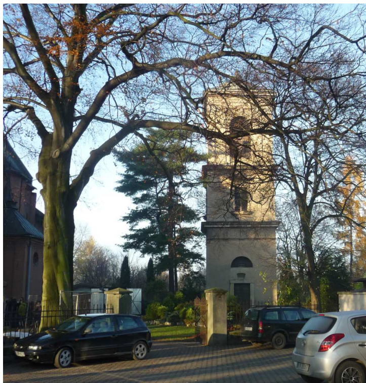
Fot. nr 146. Przykościelna dzwonnica.
