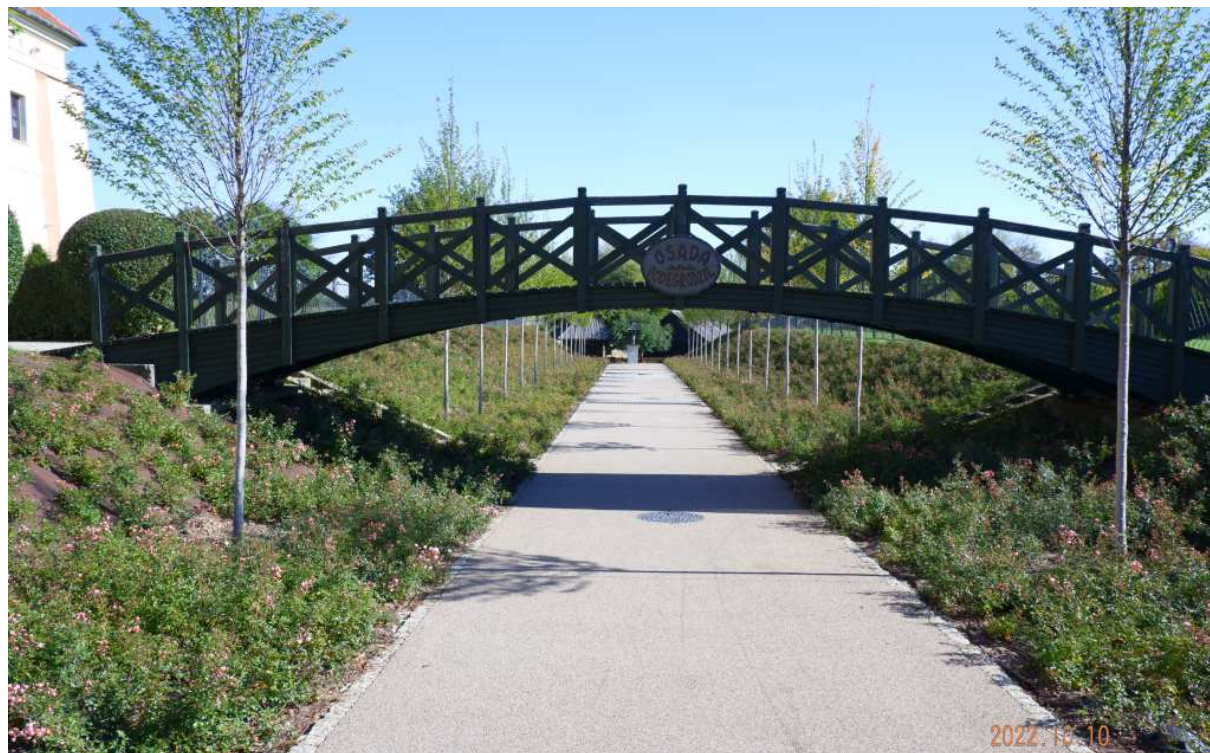
Fot. nr 230 (230-231). Droga do Osady Podegrodzie.
