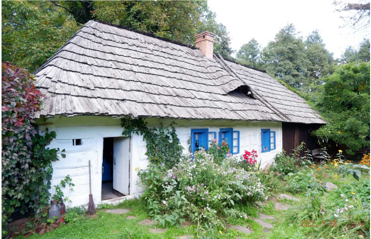
Fot. nr 51 (51-54). Fasada od strony ogrodu.
