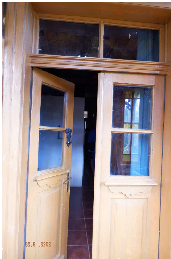
Fot. nr 110. Drzwi wewnętrzne domu.
