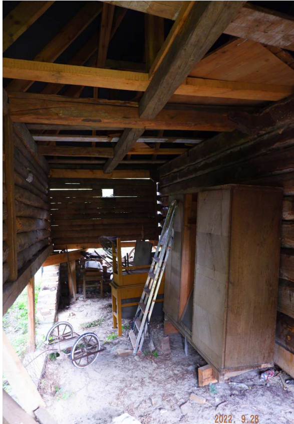
Fot. nr 87. Część gospodarcza na etapie rekonstrukcji.
