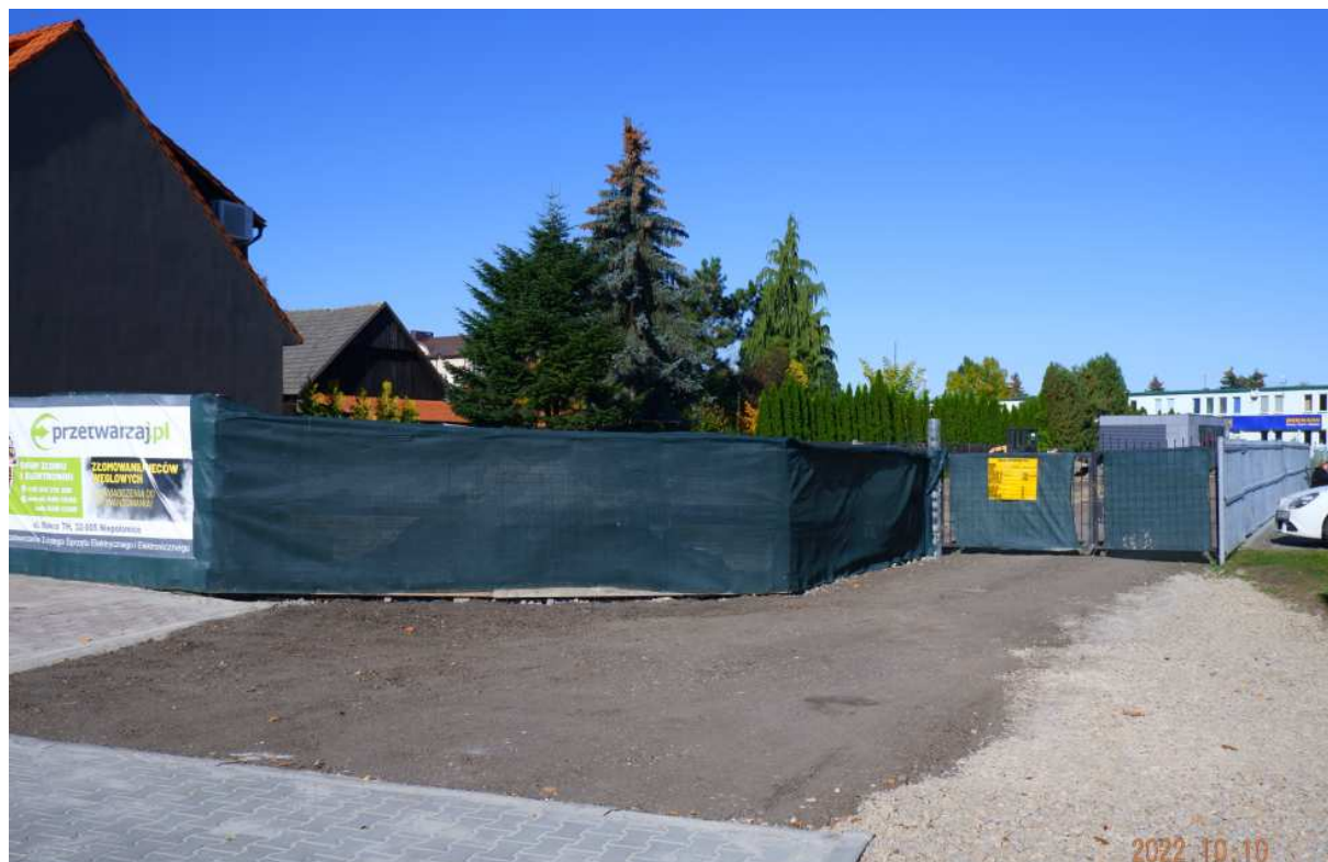
Fot. nr 181. Pusty plac po wyburzonym budynku.
