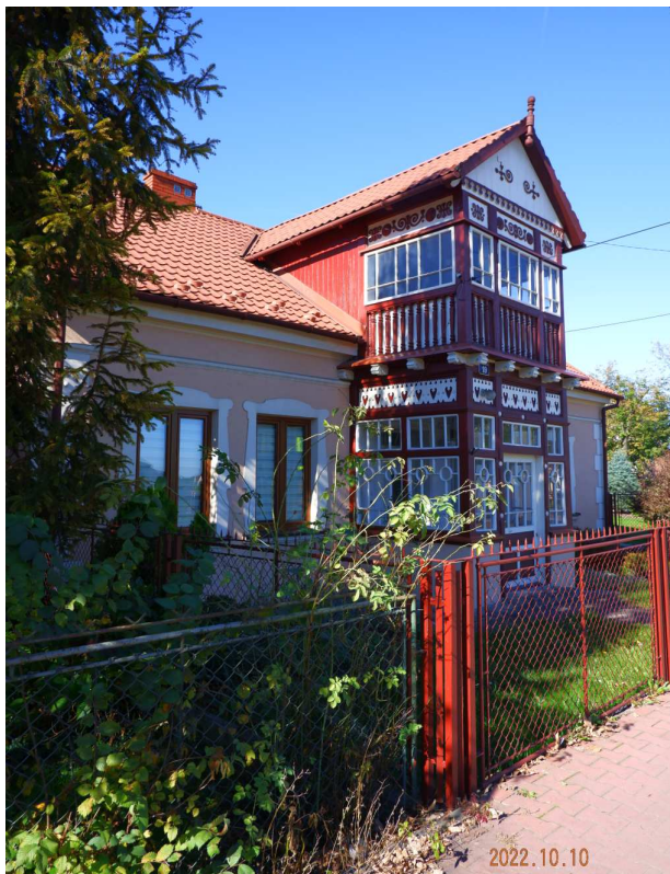
Fot. nr 297 (297-299). Współcześnie odnowiona willa spod nr 19, w której zachował się wyjątkowej urody ganek z zaskloną loggią widokową.
