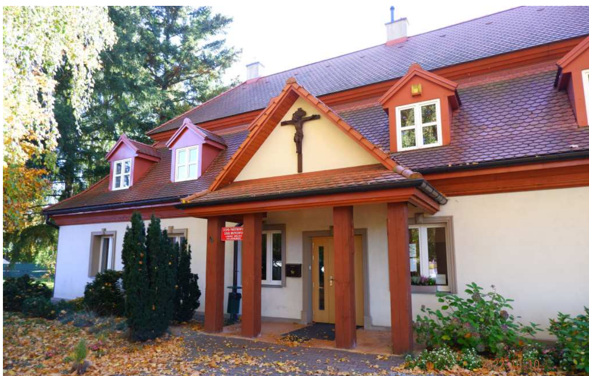
Fot. nr 218. Fasada budynku.
