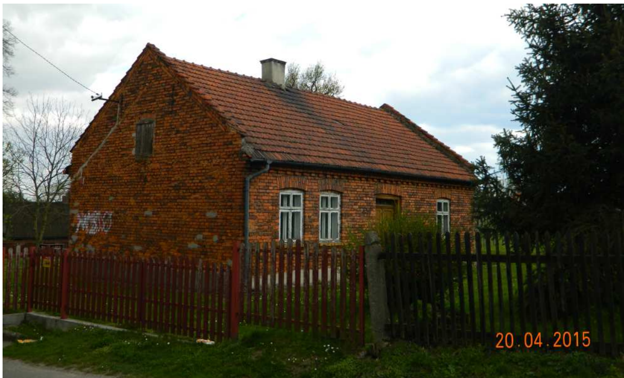
Fot. nr 138. Fasada domu z oryginalnymi oknami typu skrzynkowego, który mógł powstać już po II wojnie światowej.
