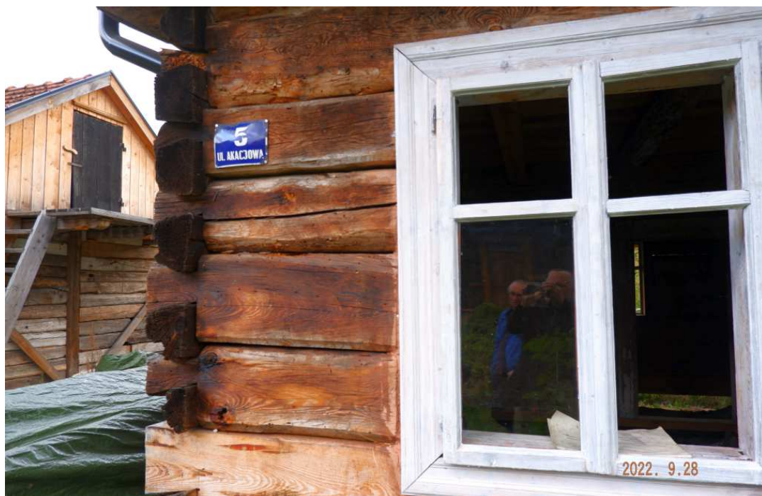
Fot. nr 80 (80-84). Oryginalne detale fasady. Stary adres: Akacjowa 5.
