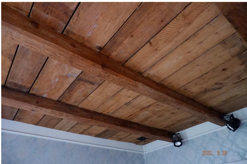
Fot. nr 115. Powąta z dźwigarami.
