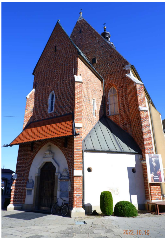
Fot. nr 207. Wejście i kruchta od strony zachodniej.
