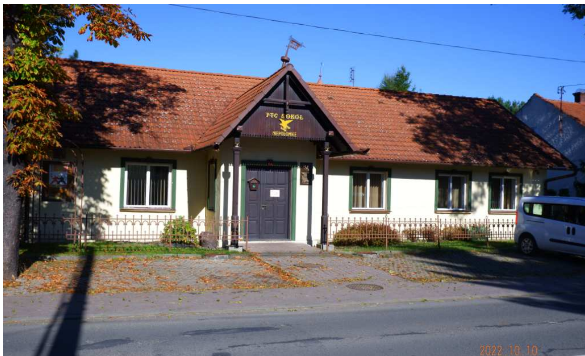
Fot. nr 167 (167-168). Stan z roku 2022.
