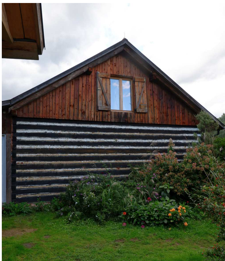
Fot. nr 106. Boczna ściana złożona z „ogaconych” belek.
