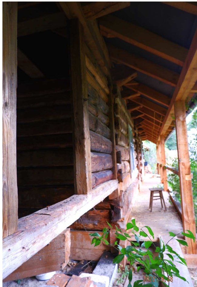
Fot. nr 86 (86-90). Tylny fragment z odsłoniętą podcieniową werandą, przysłoniętą dachem okapowym wspartym na słupach.
