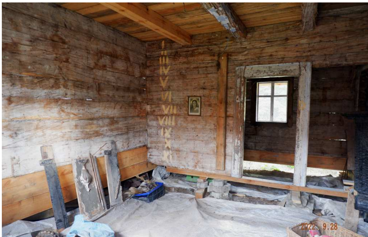
Fot. nr 121. W niewykończonej jednej z izb.
