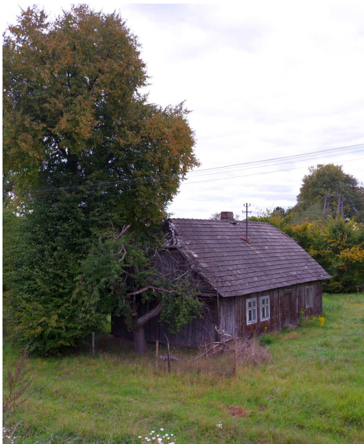
Fot. nr 134 (134-136). Dom po prawej stronie drogi dojazdowej do skansenu, z wiekowym drzewem przy jego boku.
