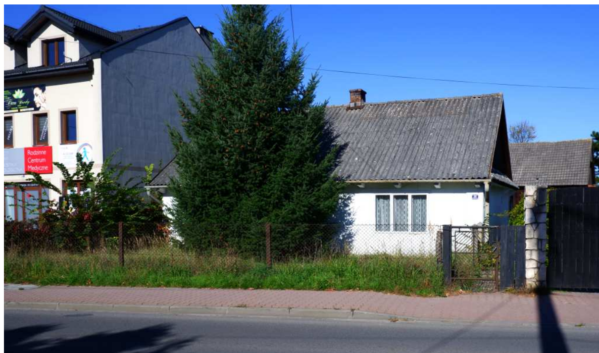
Fot. nr 182 (182-183). Dawna chałupa z nieoryginalnymi oknami pod nr 26. (10.10.2022)
