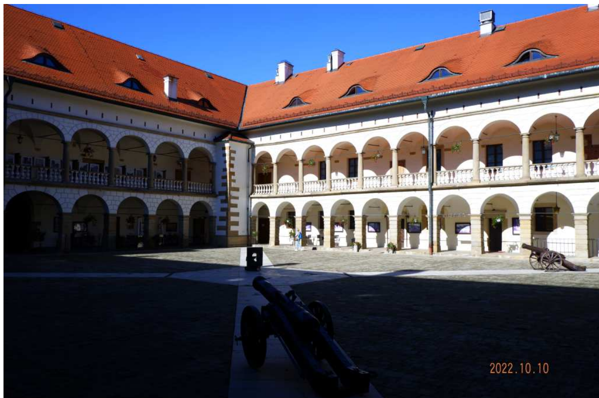
Fot. nr 261. Narożnik północno-zachodni.
