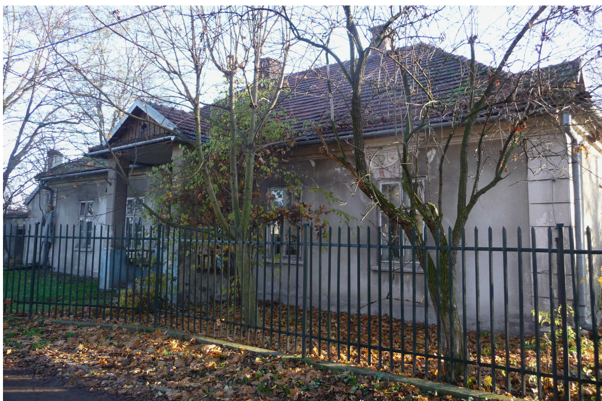
Fot. nr 144. Fasada dworku. (10.11.2012)
