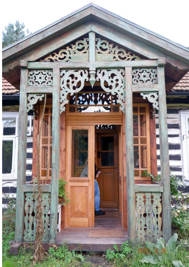
Fot. nr 103. Mistrzowsko zdobiony laubzegowymi wycinkami ganek. Podobnej urody detal został zniszczony 10 lat temu w domu przy ulicy Kościuszki 4. (fot. nr 155).
