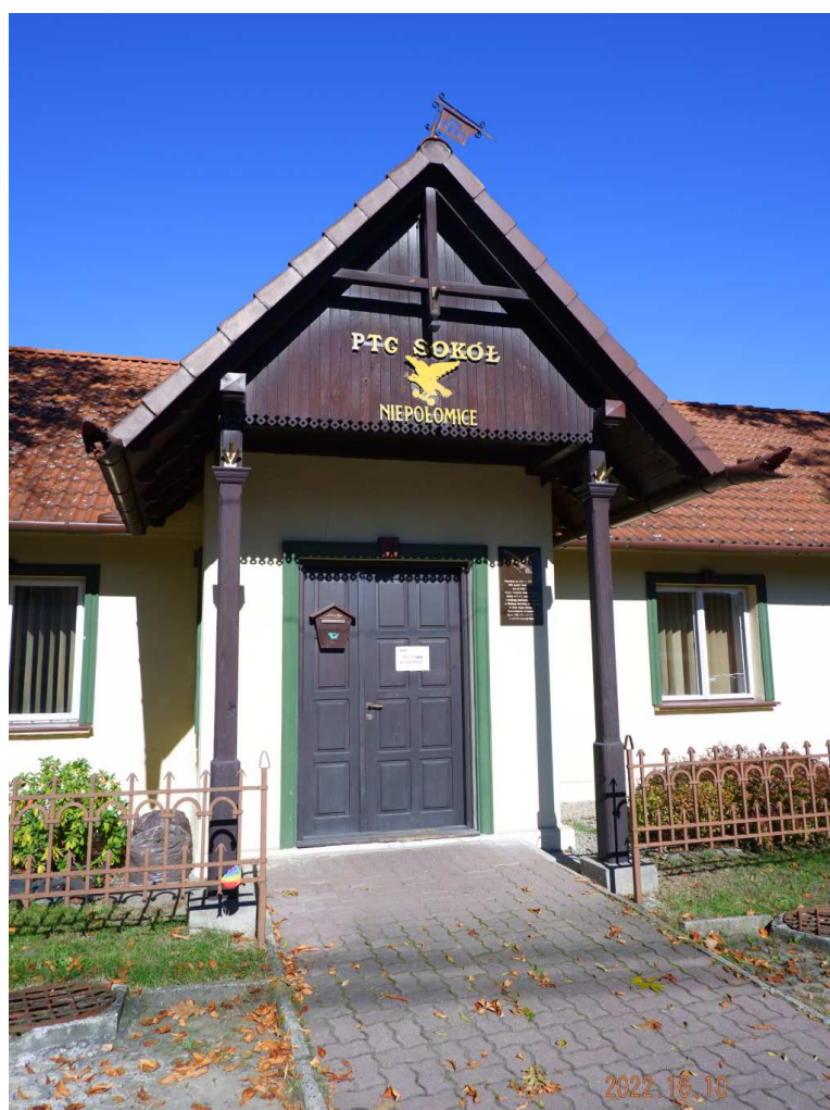
Fot. nr 168. Portyk przed wejściem.
