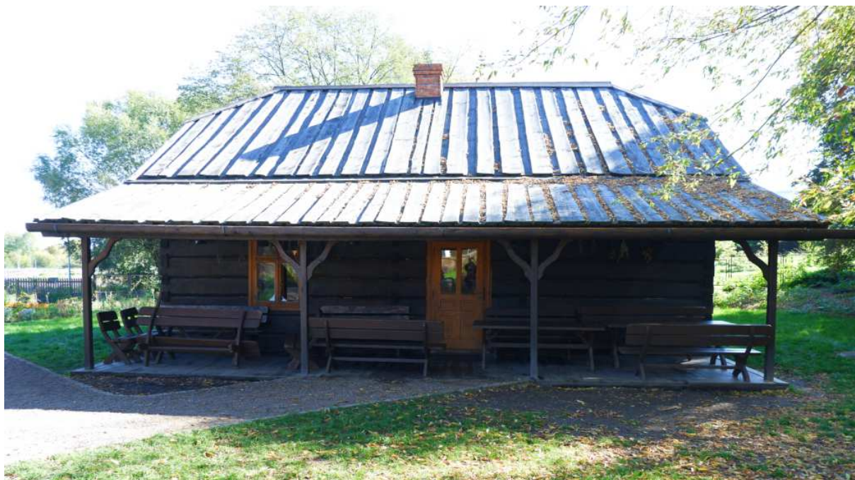
Fot. nr 247 (247-250). Ostatni z domów w osadzie, z podcieniem i dachem okapowym wspartym na słupach.
