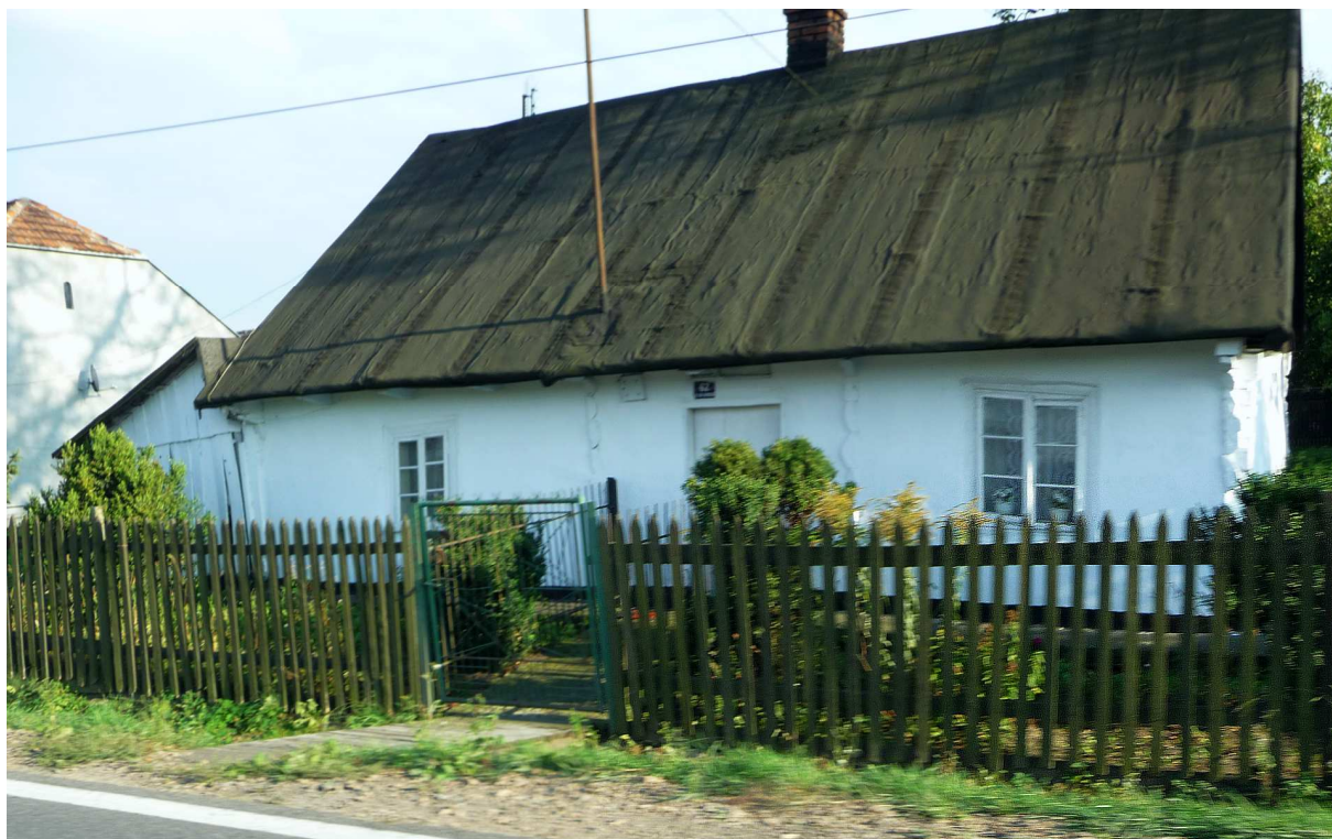
Fot. nr 306 (306-306a). Wiekowa chałupa z ulicy Batorego 62, wkrótce po renowacji i usunięciu pęknięcia w dachu i w fasadzie. (16.09.2012)
