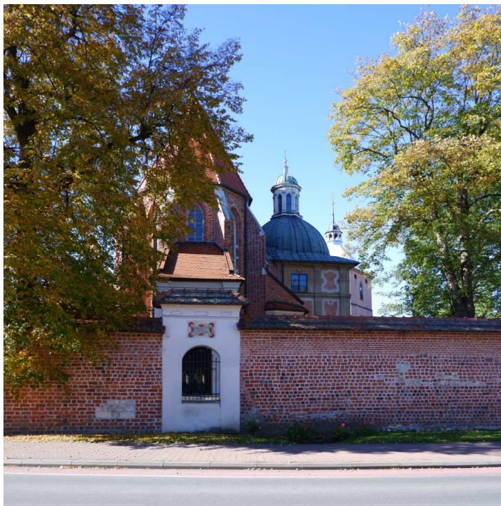
Fot. nr 205. Ujęcie od strony ulicy Pięknej.
