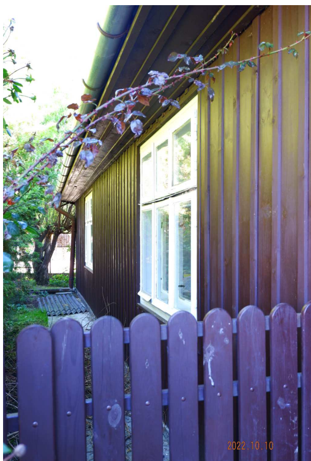
Fot. nr 305a. Okna typu weneckiego w fasadzie.
