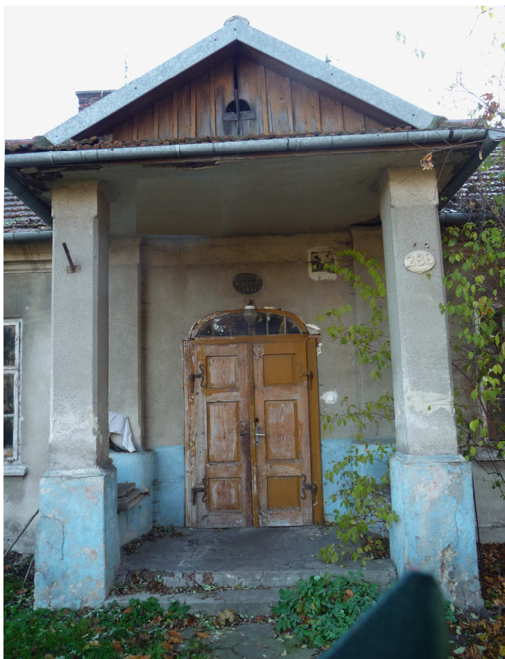
Fot. nr 145. Portyk przed wejściem. (10.11.2012)
