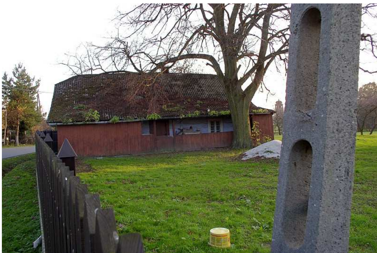
Fot. nr 334. Widok na tylny fragment osłonięty okapowym dachem. (23.10.2010)
