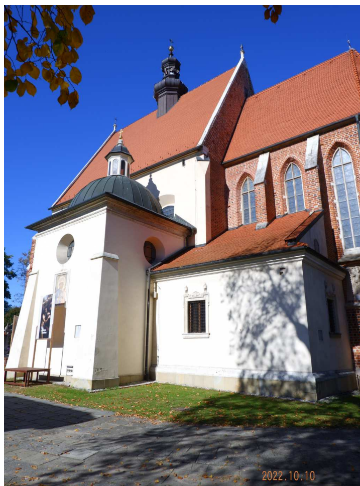
Fot. nr 206. Widok od strony południowej.
