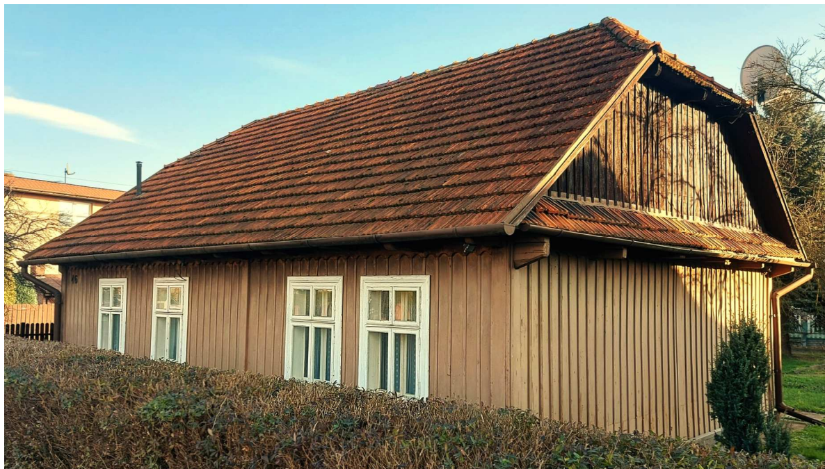
Fot. nr 307 (307-307a). Zapewne około 100-letni oszalowany dom z ulicy Batorego 46, w którym nadal trwają oryginalne okna typu skrzynkowego. (10.10.2022)
