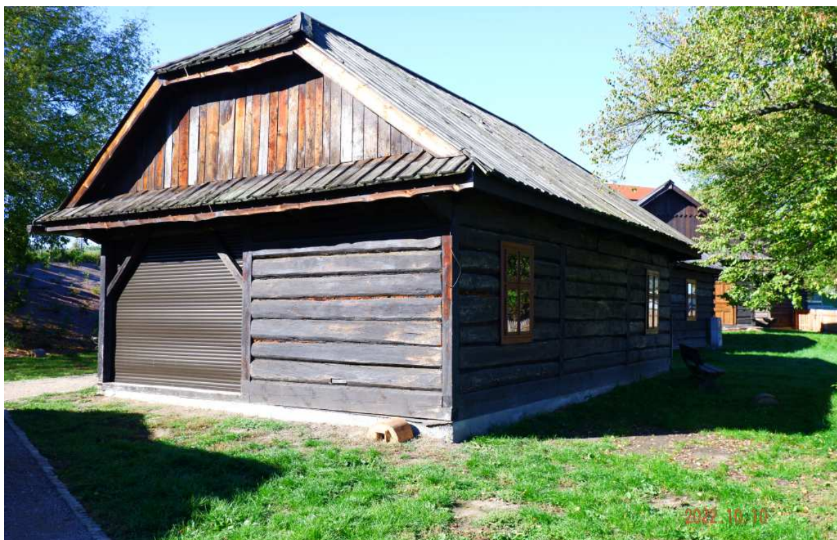
Fot. nr 246. Tylna część domu z oknami typu skrzynkowego, które, podobnie jak typu weneckiego, powstarczają się we wszystkich obiektach.
