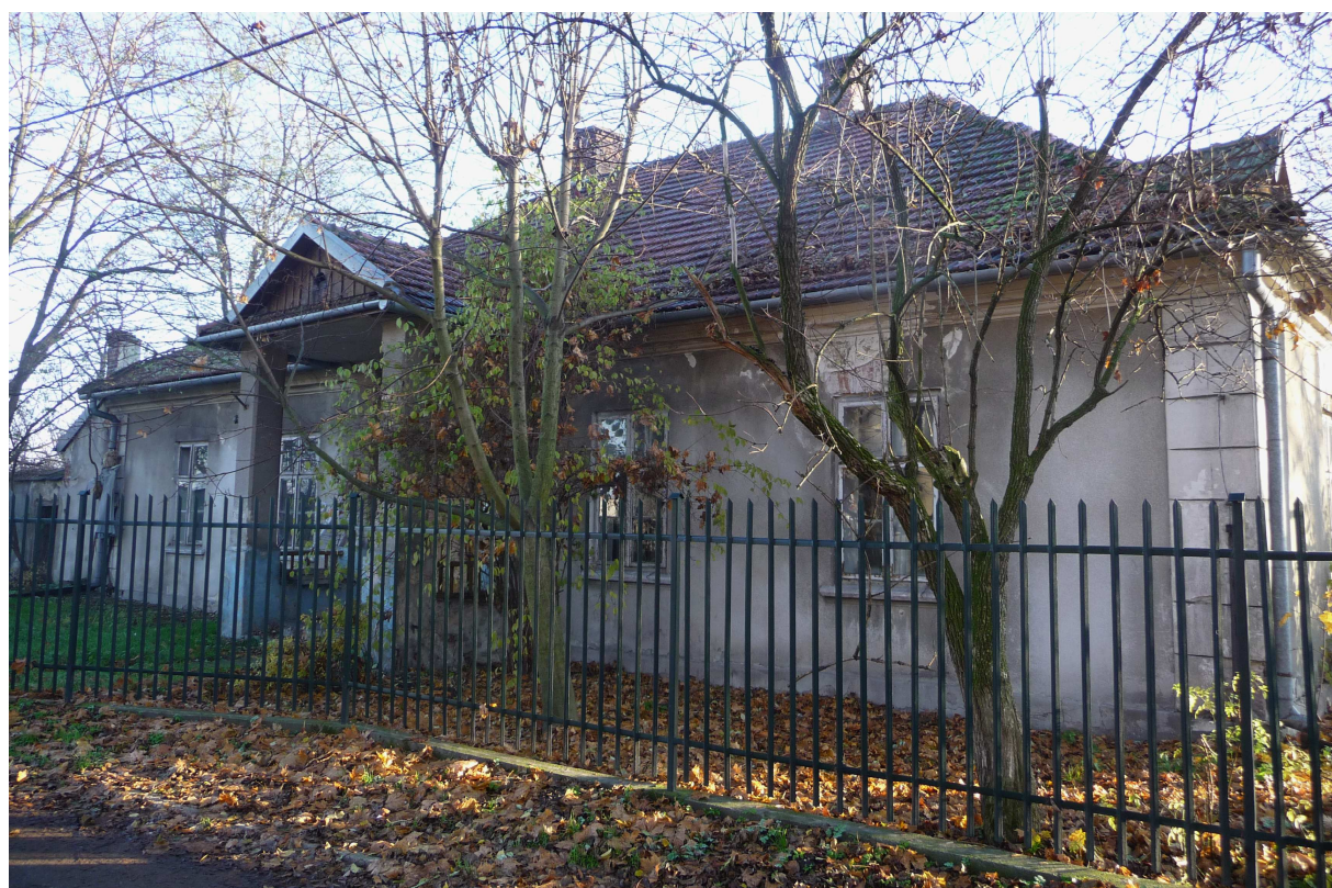
Fot. nr 144. Fasada dworku. (10.11.2012)
