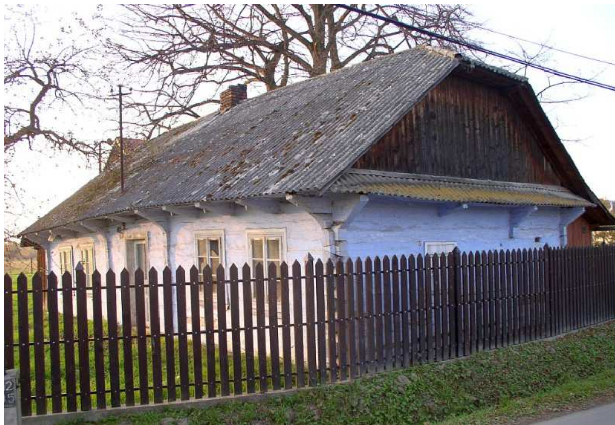
Fot. nr 331. Widok od strony ogrodu. (23.10.2010)
