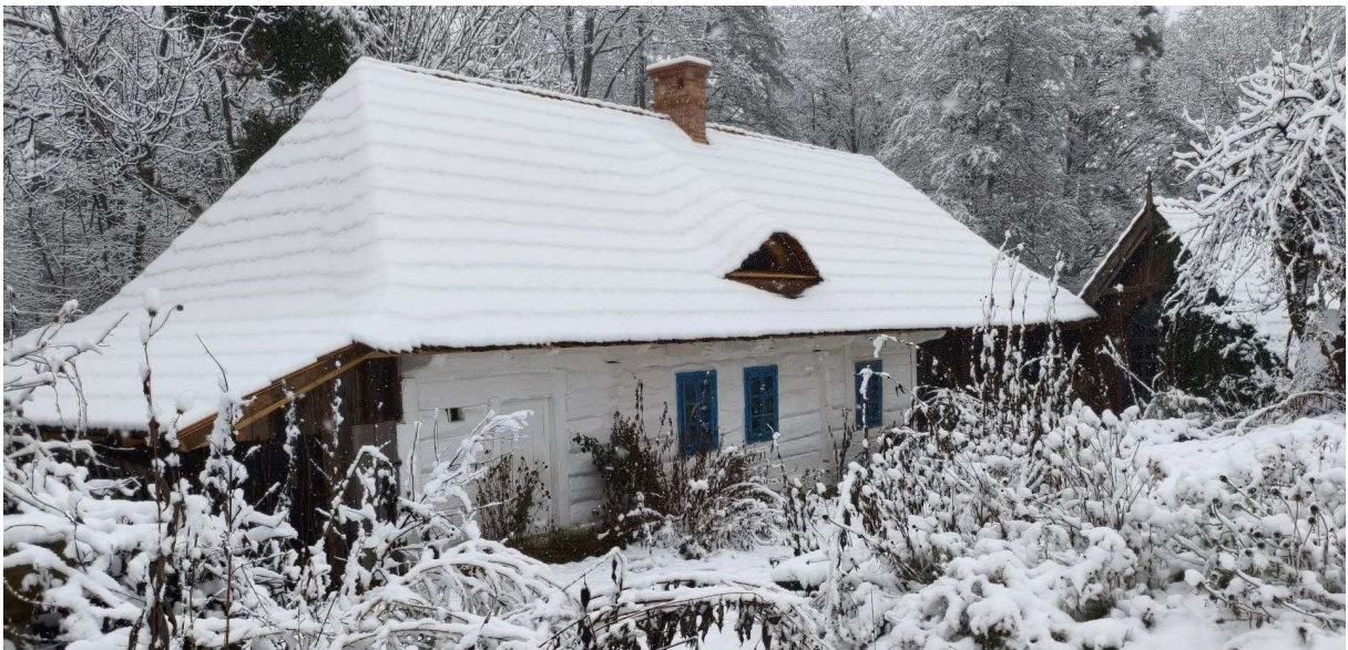
Fot. nr 6d. Stan po dwuletniej odbudowie. (21.11.2025)
