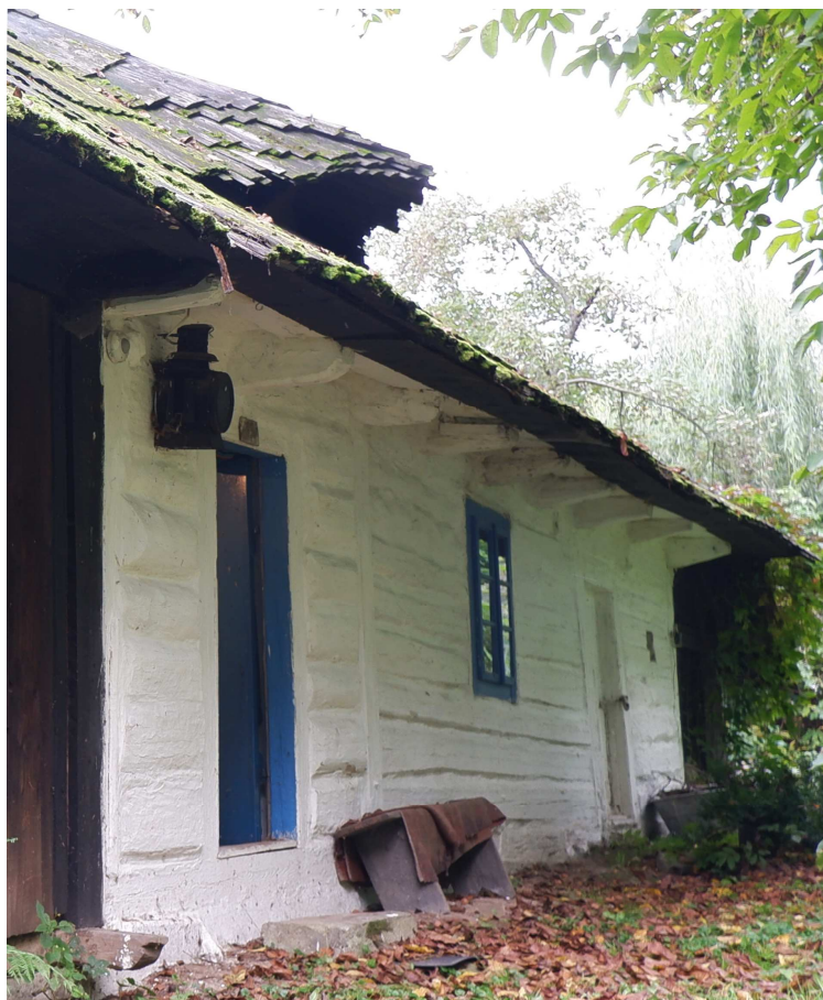
Fot. nr 37 (37-38). Część mieszkalna.
