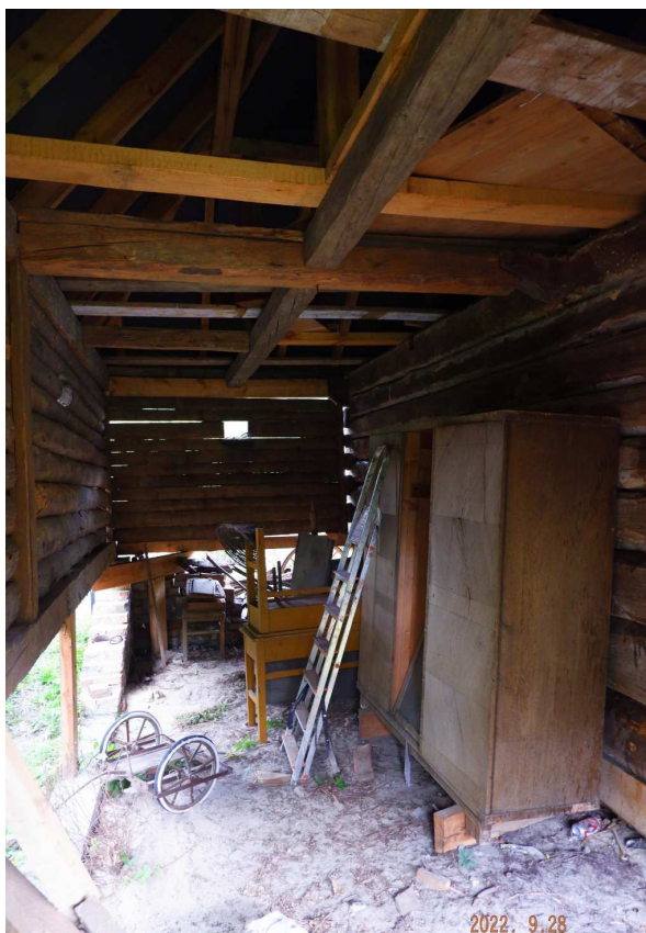
Fot. nr 87. Część gospodarcza na etapie rekonstrukcji.
