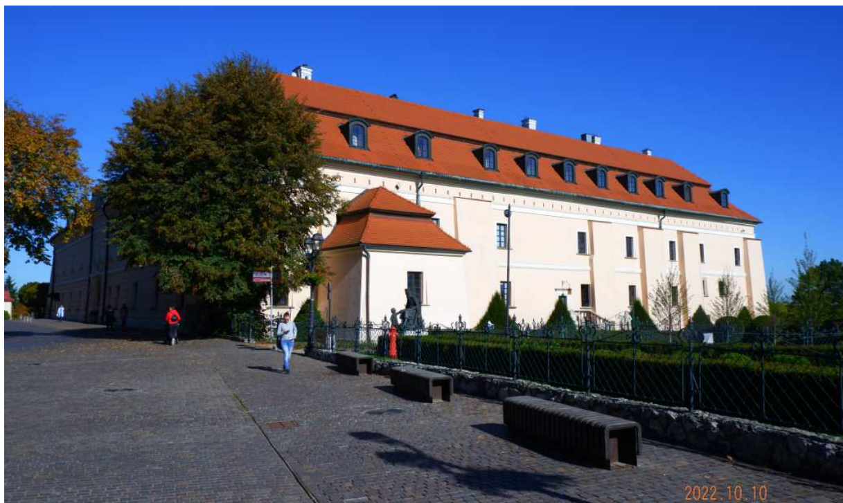
Fot. nr 226. Południowe skrzydło zamku.
