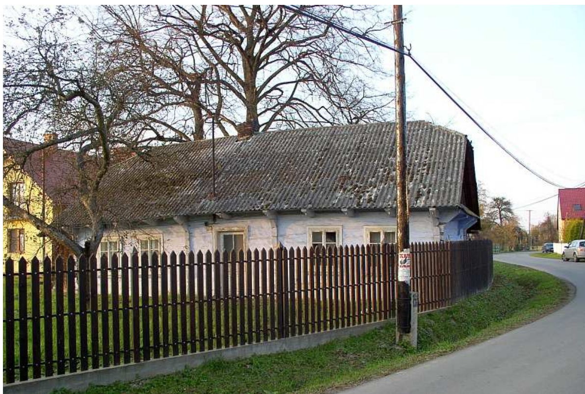
Fot. nr 330 (330-334). Relikt etnograficzny spod nr 99 – bielona chałupa z dachem naczółkowym, zakończonym okapem, zapewne z początku XX wieku, w której drzwi wiodące do sieni nie są już oryginalne. (23.10.2010)
