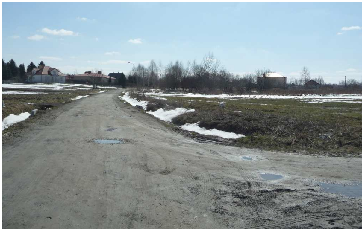
Fot. nr 53. Na „Przycni” na skraju Małej Strony – widok spod przepustu kolejowego „przed koleją”. (08.04.2013)
