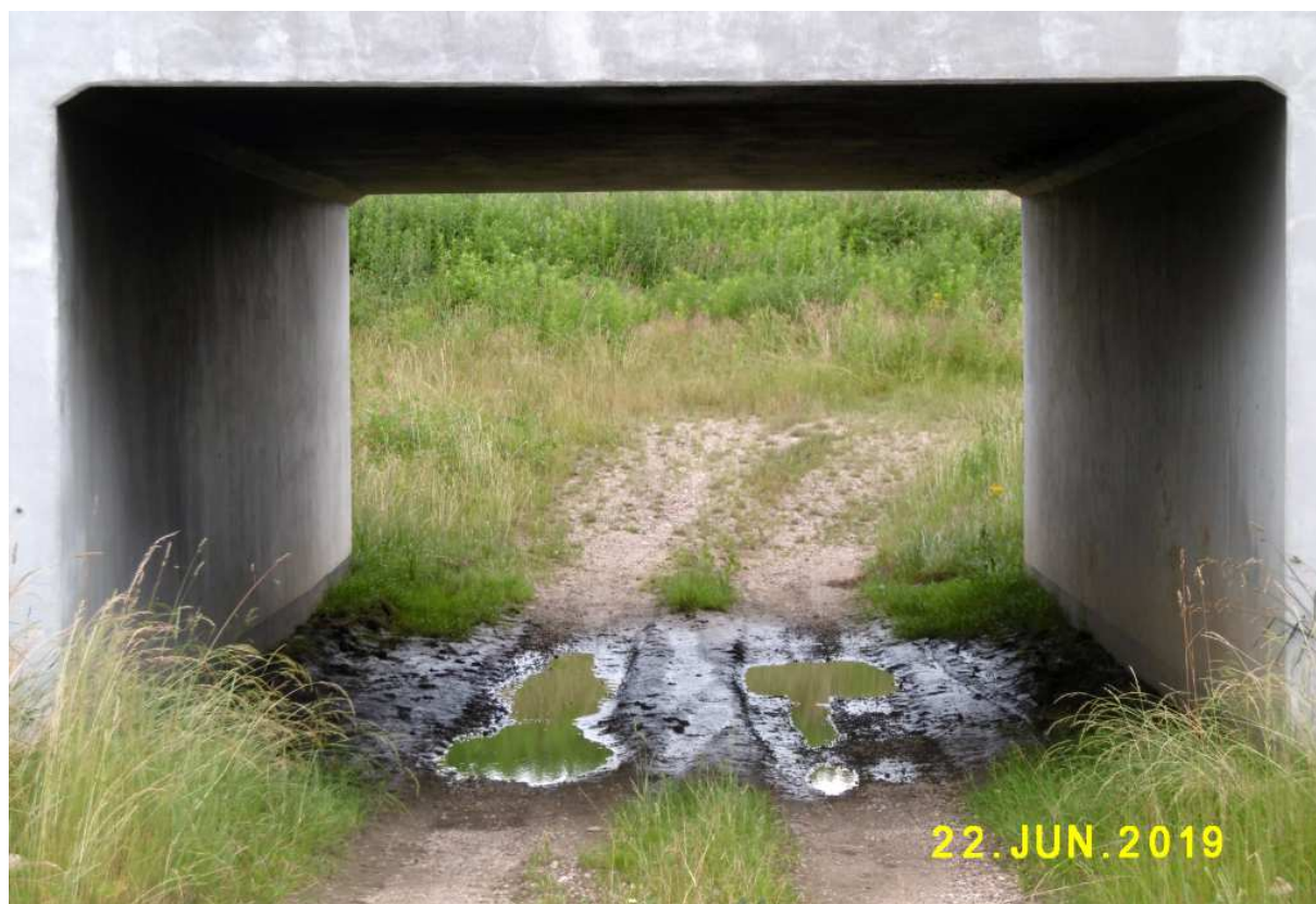
Fot. nr 380. Przepust kolejowy w kierunku pól na „Łuckowym”.
