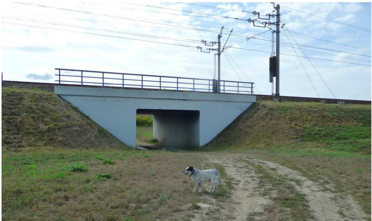
Fot. nr 606. Przepust na wysokości „Rędzin”. (02.09.2022)
