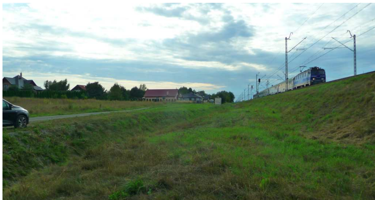
Fot. nr 549. Nowa zabudowa przed koleją, usytuowana wzdłuż nasypu kolejowego biegnącego w stronę Trzciany – widok z końcowego fragmentu „Przycni”. (28.08.2022)
