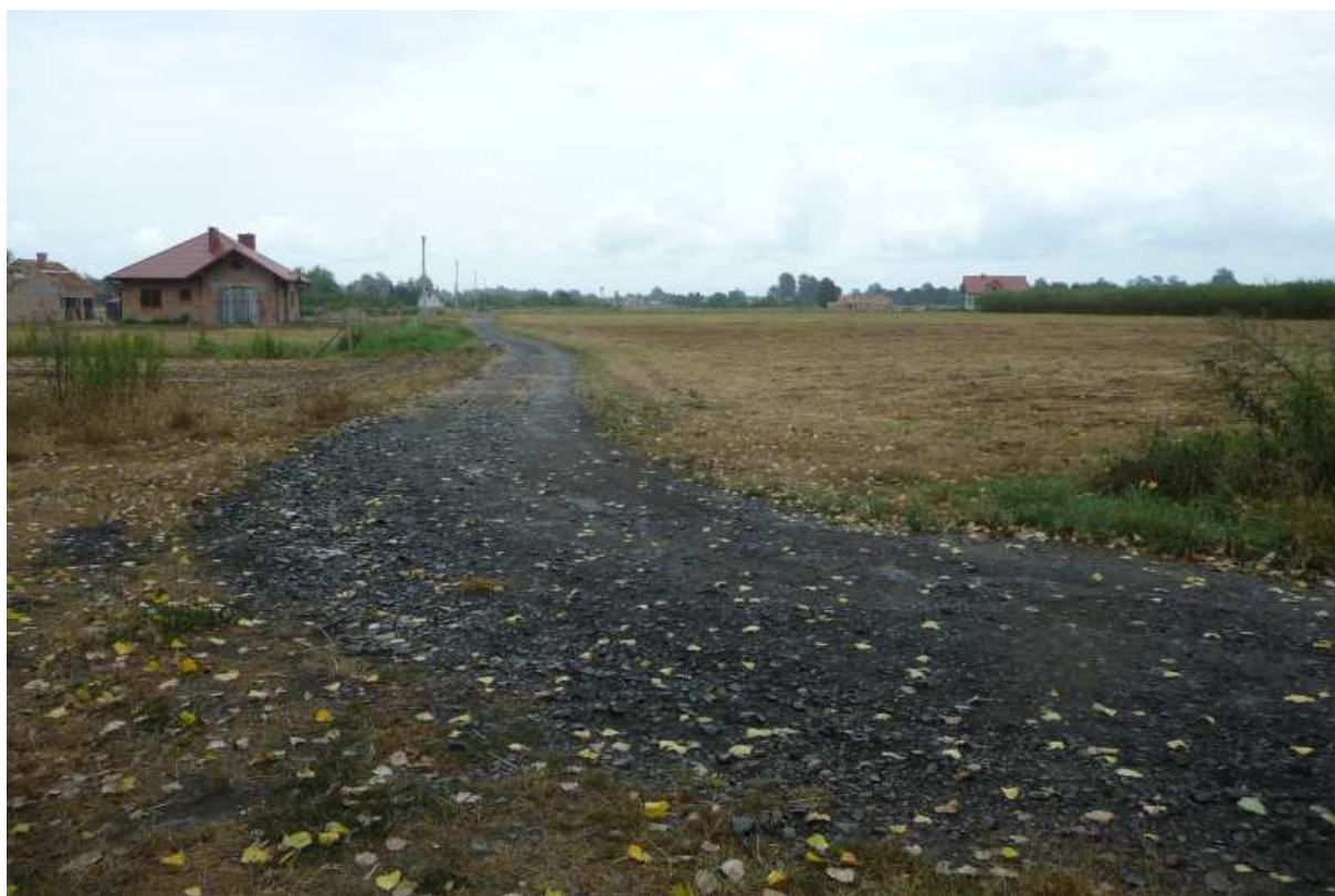
Fot. nr 19. Pierwszy dom powstający przy wysypanej już szutrem odnodze głównej drogi transportowej „Włósienia”, odchodzącej w kierunku „Kamyszyna”. (12.08.2012)
