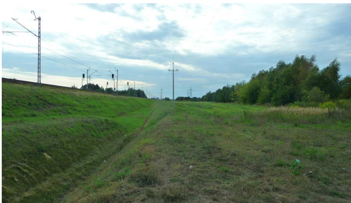
Fot. nr 551. Wzdłuż nasypu kolejowego w stronę Trzciany w ujęciu od strony „Dybkowa”. (28.08.2022)
