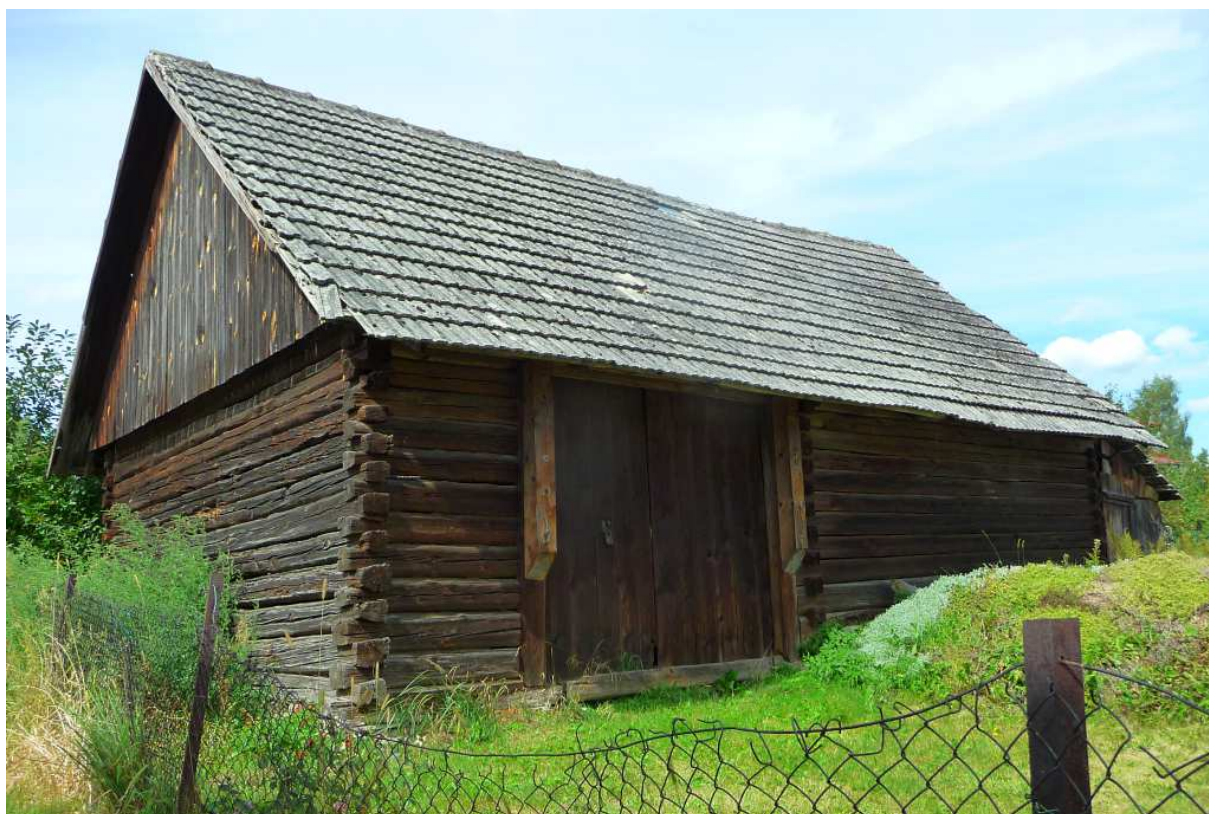
Fot. nr 548a. Ujęcie od strony podwórka. (02.09.2022)
