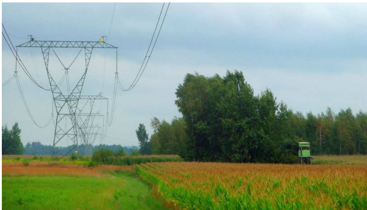
Fot. nr 520 (520-536). Widoki wzdłuż drogi wiodącej od przepustu kolejowego na przedłużeniu „Przycni” poprzez Rędziny ku Bratkowicom. (13.08.2022)
