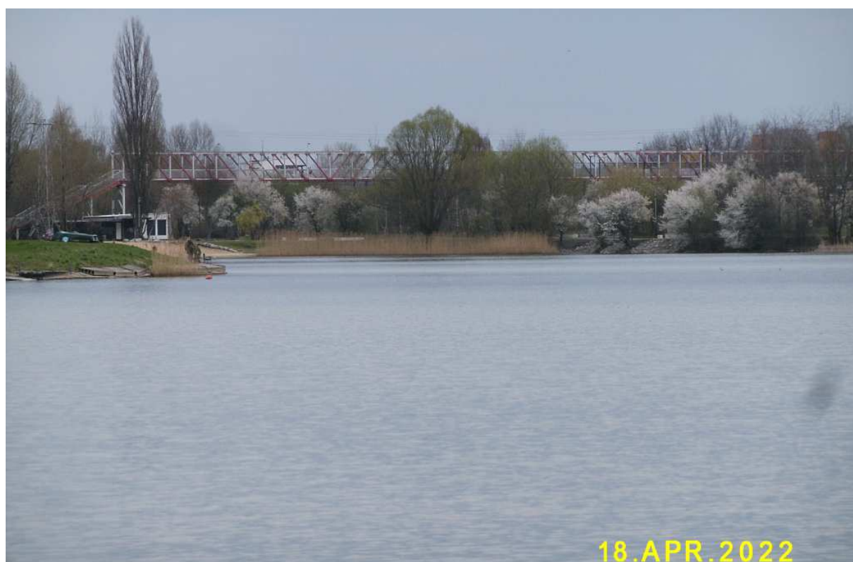
Fot. nr 215. W stronę kładki nad torami kolejowymi.
