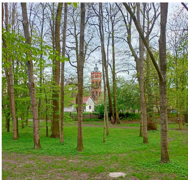
Fot. nr 247 (247-249). Eklektyczna wieża ciśnię przy ulicy Górników 25. (01.05.2022)
