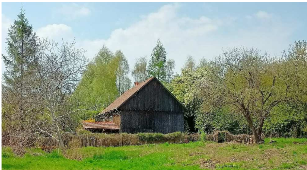
Fot. nr 350 (350-351). Samotny kiedyś dom przy ulicy Obronnej 23a. (03.05.2022)
