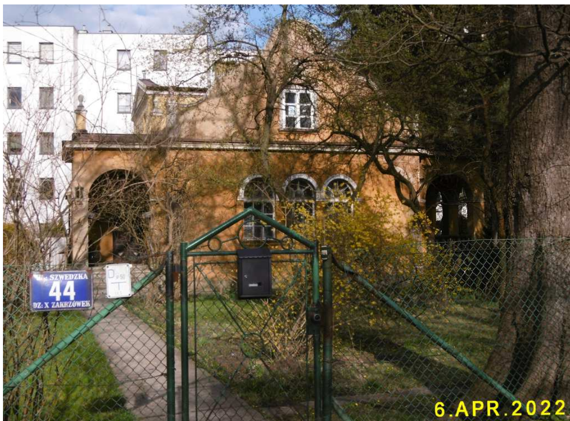
Fot. nr 19. Willa o cechach neorenesansowych spod nr 44, wybudowana na pocz. XX wieku wg projektu Ludwika Wojtyczki i Jana Zarzyckiego, rozbudowana w roku 1918.
