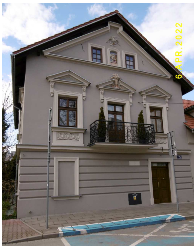
Fot. nr 33. Przykładnie odnowiona fasada.
