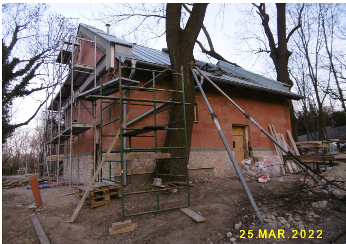
Fot. nr 103. Trwa rewitalizacja dawnego ogrodu przy dworze i odbudowa spichlerza.
