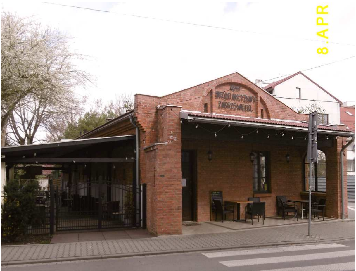
Fot. nr 9 (9-11). Odnowiony i przeznaczony na cele gastronomiczne budynek dawnej rogatek zakrzowieckiej przy ulicy Twardowskiego 45, gdzie pierwotnie mieściła się brama w zespole obwarowań Twierdzy Kraków, powstała ok. roku 1890.
