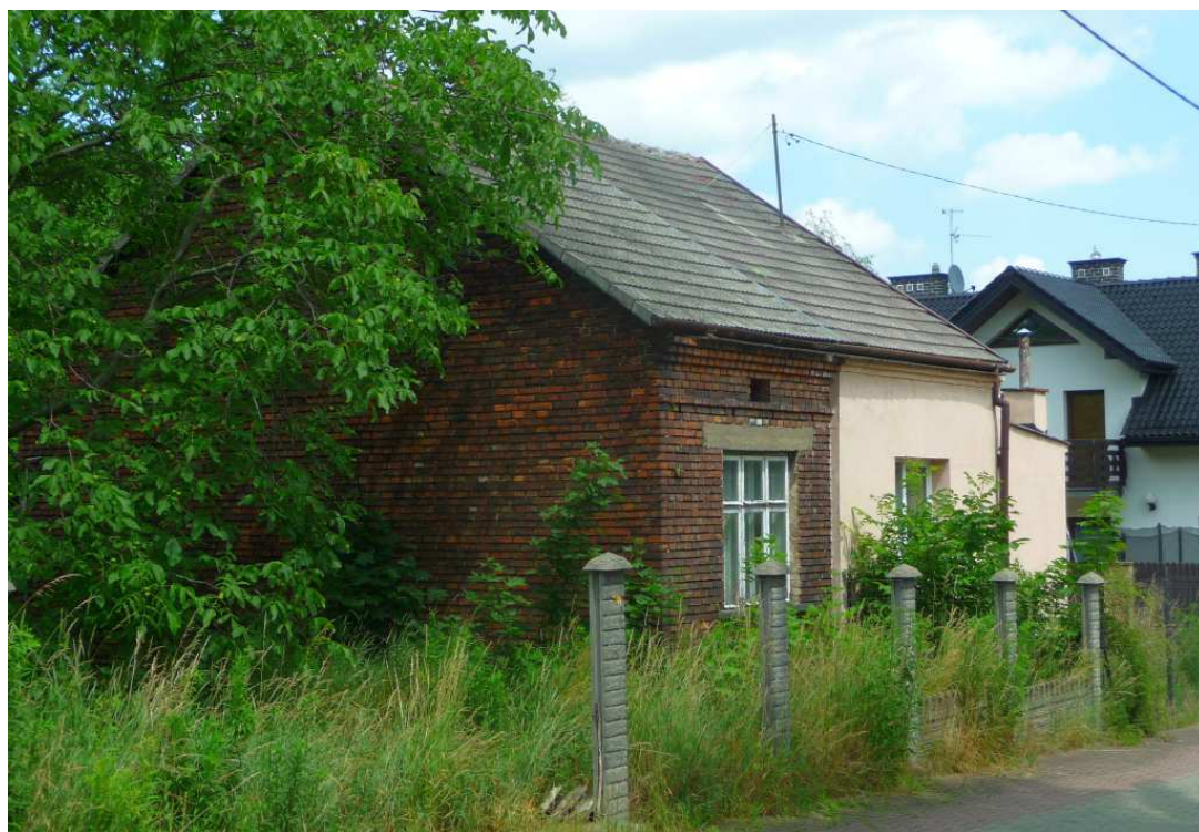
Fot. nr 118. Oryginalny fragment zapewne jeszcze przedwojennego domu z ulicy Monerskiej 22. (17.06.2022)
