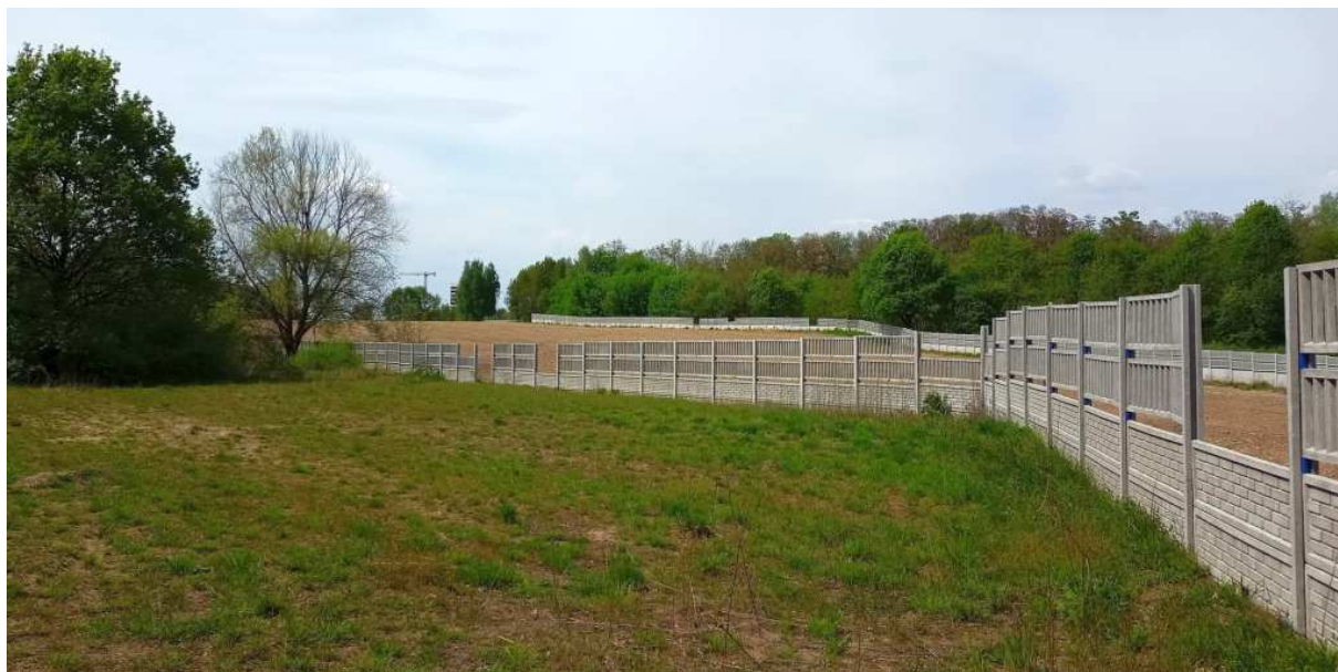
Fot. nr 393 (393-395). Smutny widok na nielegalnie postawione ogrodzenie. Właściciel gruntu, potencjalny deweloper, próbuje stosować politykę faktów dokonanych. Ale zabudowa tego pięknego zakątka kolejnym betonowym blokowiskiem bynajmniej nie jest jeszcze przesądzona, bo na ukończeniu jest MPZP. (11.05.2022)
