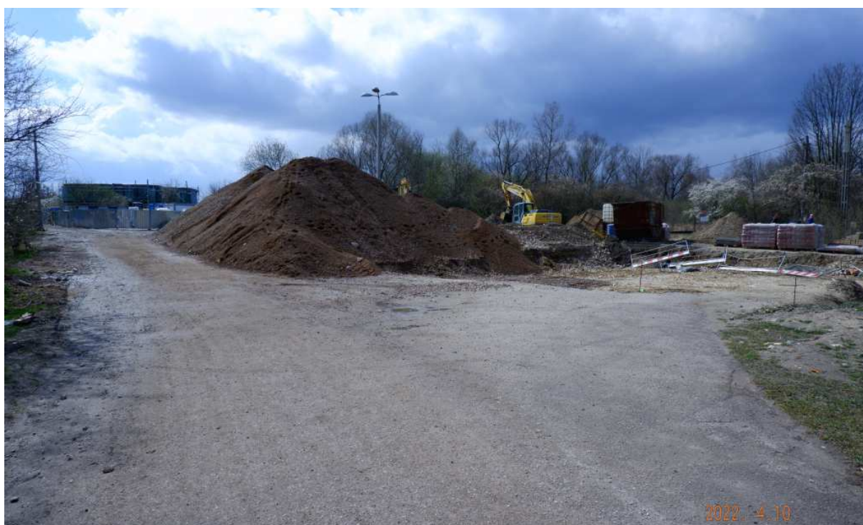
Fot. nr 53 (53-56). Prace ziemne i budowlane przy ulicy Wyłom, gdzie przy zbiorniku wodnym powstaje miejskie kąpielisko.
