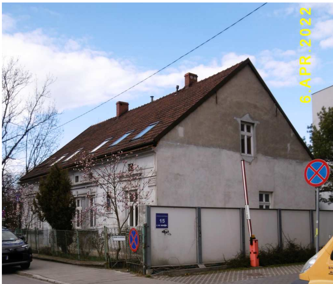
Fot. nr 44 (44-47). Dom z ulicy Mieszczańskiej 15, wybudowany w roku 1926, którego projektantem był Jan Zarzycki. (06.04.2022)
