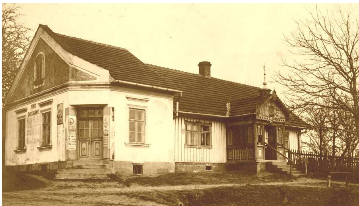
Fot. nr 29b. Budynek na „Klinie” (Bilczyce nr 50) w pełnej krasie – jeszcze bez dobudowanego w prawej części fragmentu tzw. stolarni. Stan zapewne gdzieś z końca II. dekady XX wieku, już ze sklepem ogólnospożywczym (kolonialnym) na froncie i szyldem: „Gospoda Klin Franciszek Kaleta” na bocznej ścianie ganku.
