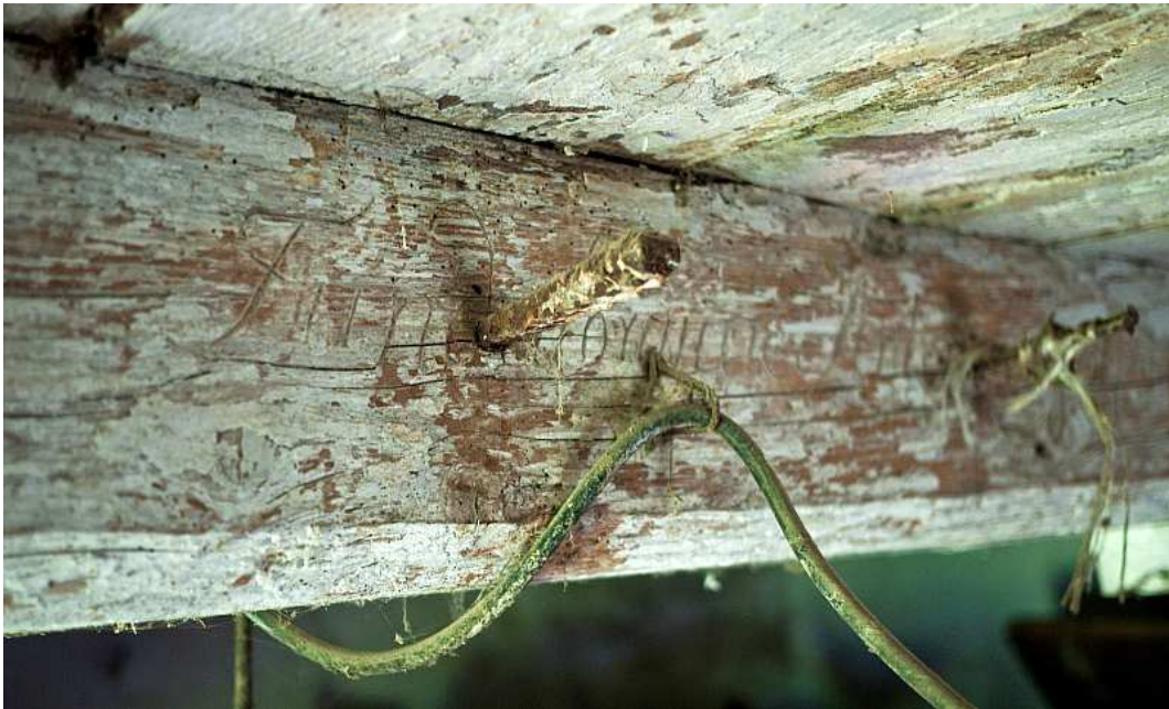
Fot. nr 85 (85-85c). Oryginalne napis na bocznym fragmencie powały zachowanego fragmentu domu. Cały napis brzmi, z boku belki: „Fundatorowie Antoni Augustyniek i Maria żona”. Napis na spodzie belki: „RP - 1853”. Fotografii domu, dziś już wyburzonego i belki (fot. nr: 84-85c) wykonał Tomasz Augustynek.
