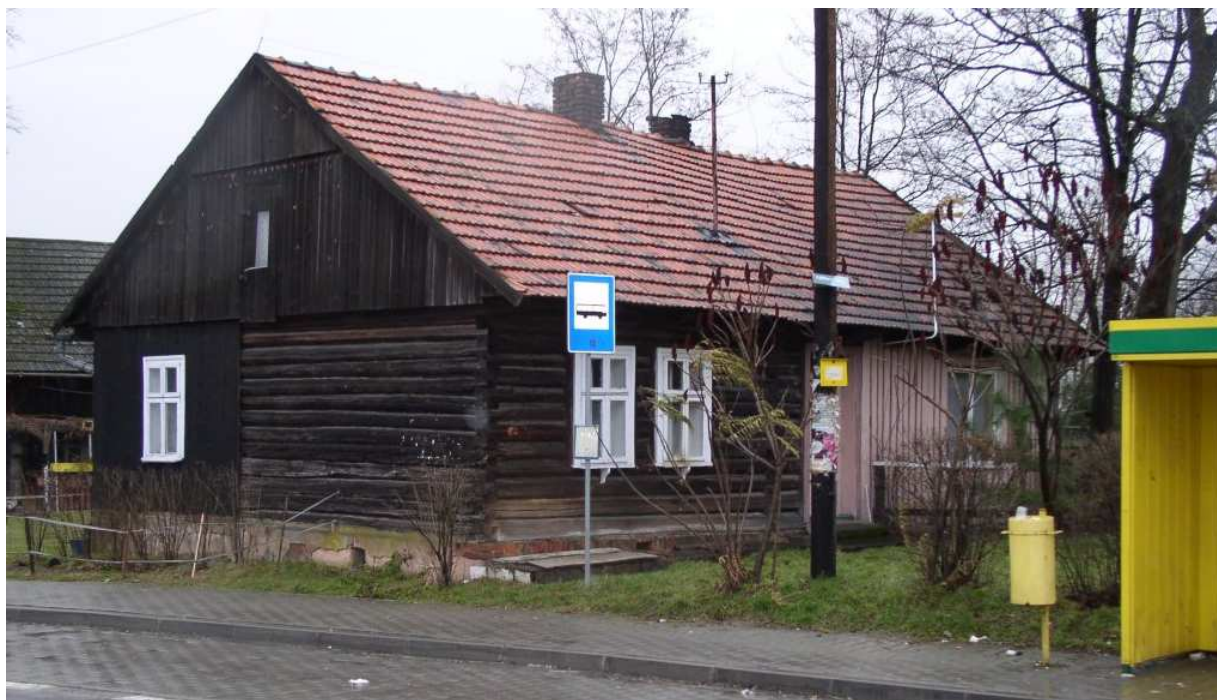
Fot. nr 29 (29-29a). Wspólny dom Stolców i „Wójcioków” (Władysława Kalety – „Wójcioka”) do dziś strzegący „Pagorka” (2008). Dziś budynek wygląda już nieco inaczej; został obudowany sidingiem i wymieniono w nim okna na bezpodziałowe plastiki.
