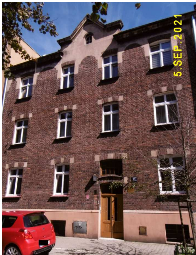
Fot. nr 110. Kamienica z ulicy Filareckiej 21, która powstała w I ćwierci XX wieku.
