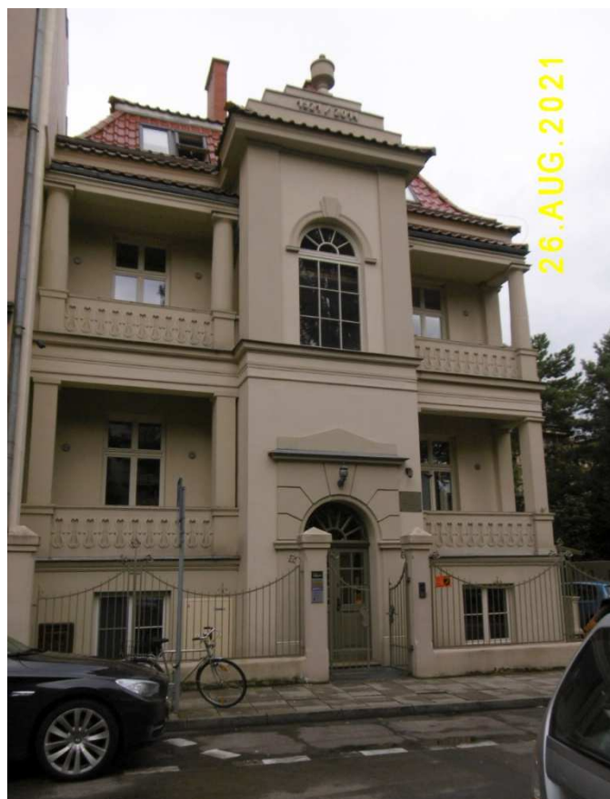
Fot. nr 343. Fasada stuletniego budynku, stojącego przy ulicy Zduńskiej 18.
