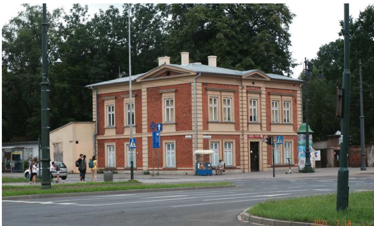
Fot. nr 57. Odnowiona, dawna Rogatka Wolska z ulicy Piłsudskiego 29, wybudowana wg projektu Henryka Żołdaniego w roku 1893. I tylko charakterystycznego daszku przed wejściem, znanego z archiwalnych fotografii, brak. (18.07.2021)
