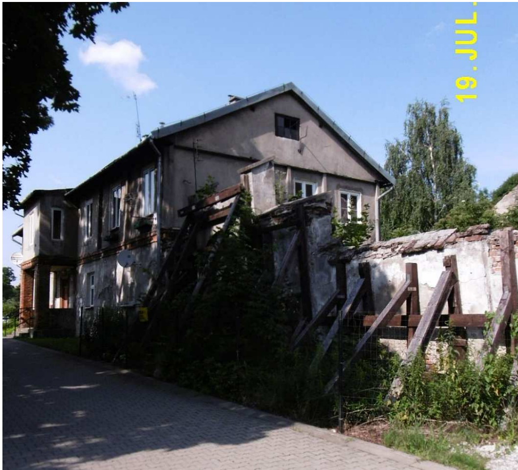
Fot. nr 316 (316-323). Spojrzenia na stan współczesny dawnego dworku spod nr 119A.
