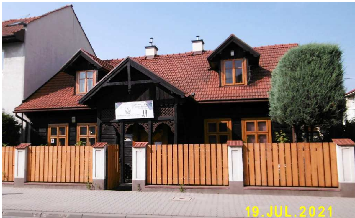
Fot. nr 290. Spojrzenie na fasadę.
