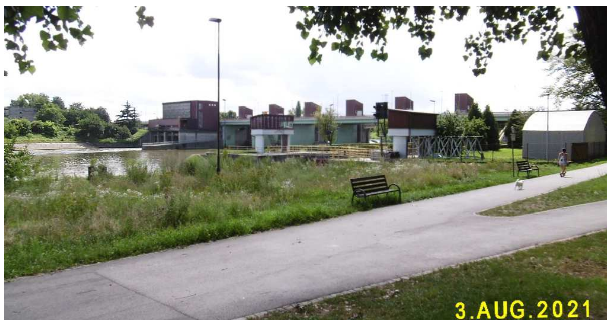
Fot. nr 282. Wybudowany na początku lat 60. XX wieku stopień wodny na Dąbiu.
