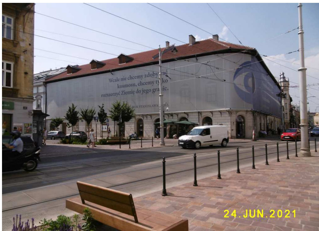
Fot. nr 399. Dawny Zajazd Kazimierski w narożu ulic: Krakowskiej 29 i Węglowej 1.
