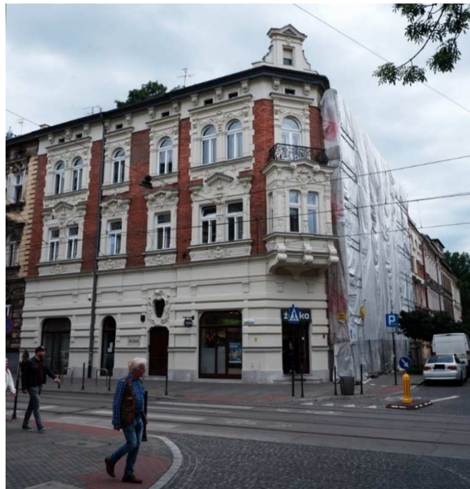
Fot. nr 23. Odrestaurowana kamienica z ulicy Karmelickiej 50/Grabowskiego 2, która została wybudowana w roku 1905 wg projektu Aleksandra Biborskiego.
