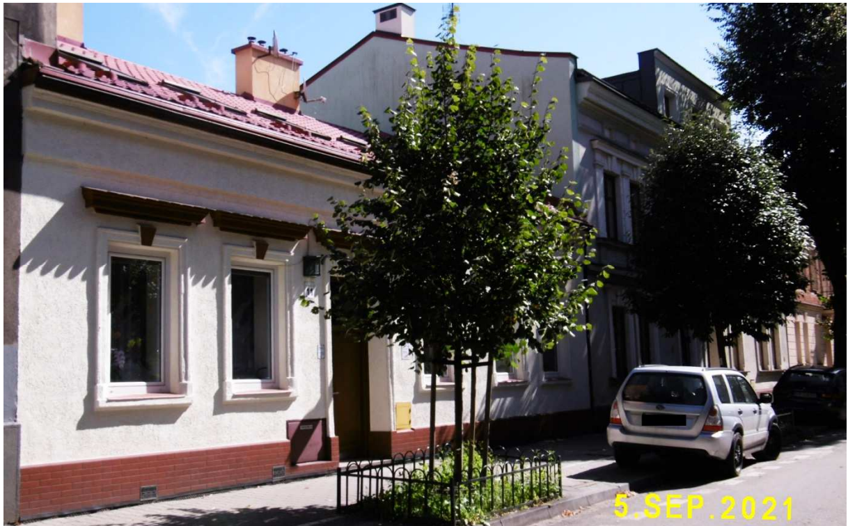
Fot. nr 113. Fragment niskiej zabudowy ulicy Filareckiej 9-11, powstały pod koniec XIX wieku, który oddaje jeszcze klimat dawnego Półwsia.
