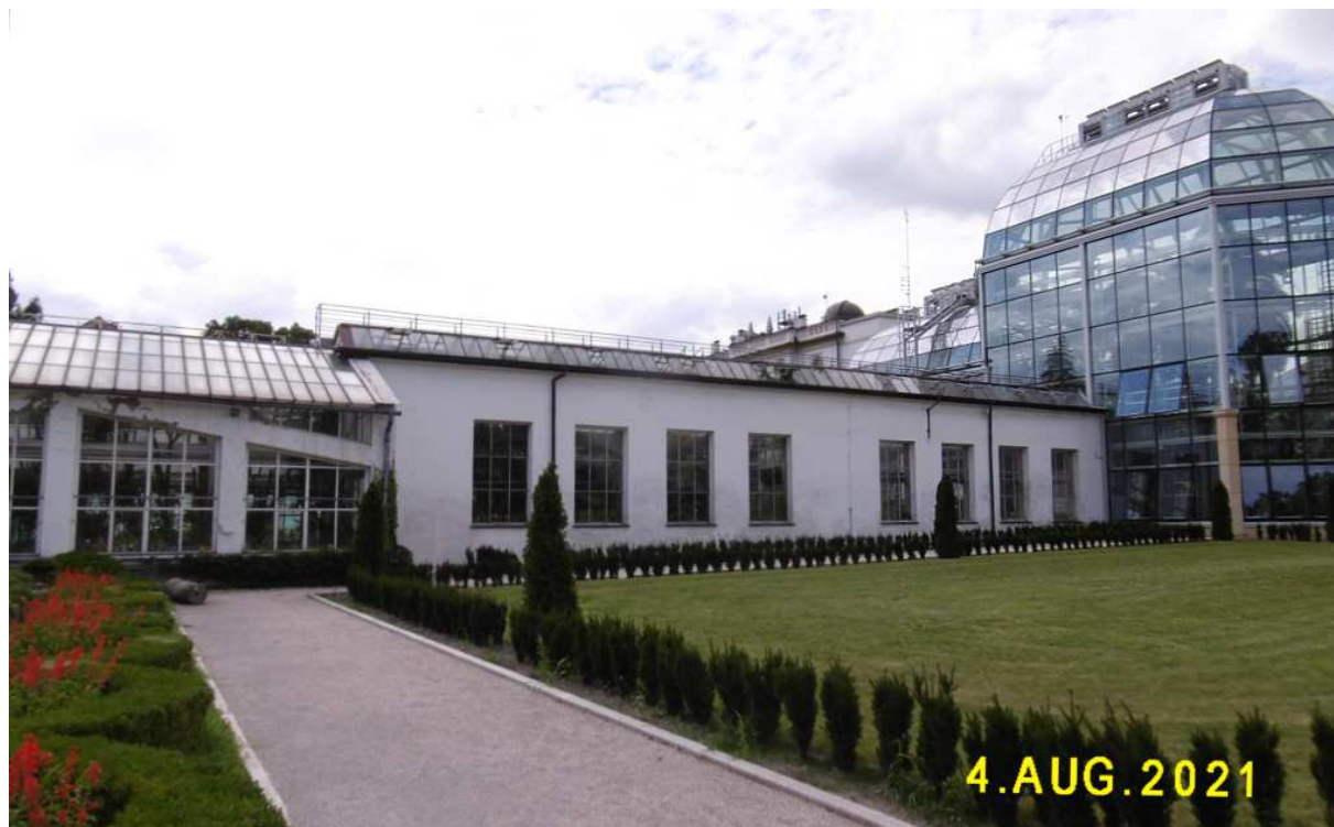
Fot. nr 182 (182-183). Szklarnia, jedna z kilku w Ogrodzie, przy wejściu na jego teren.
