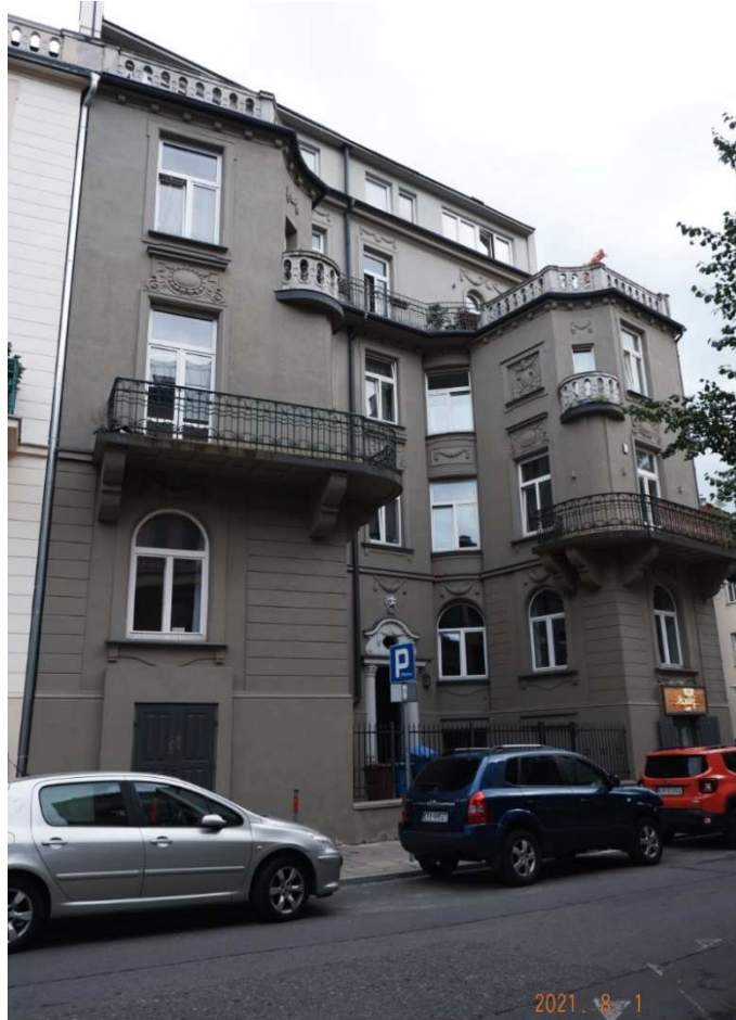
Fot. nr 22. Kamienica z ulicy Kremerowskiej 16, której nadbudowa może porażać. Budynek powstał w latach 1919-12 wg projektu Henryka Lamensdorfa.
