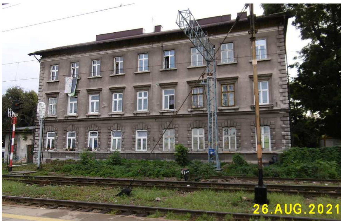
Fot. nr 436 (436-438). Budynek kolejowy na stacji PKP Płaszów przy ulicy Prokocimskiej 5 i detale jego fasady.
