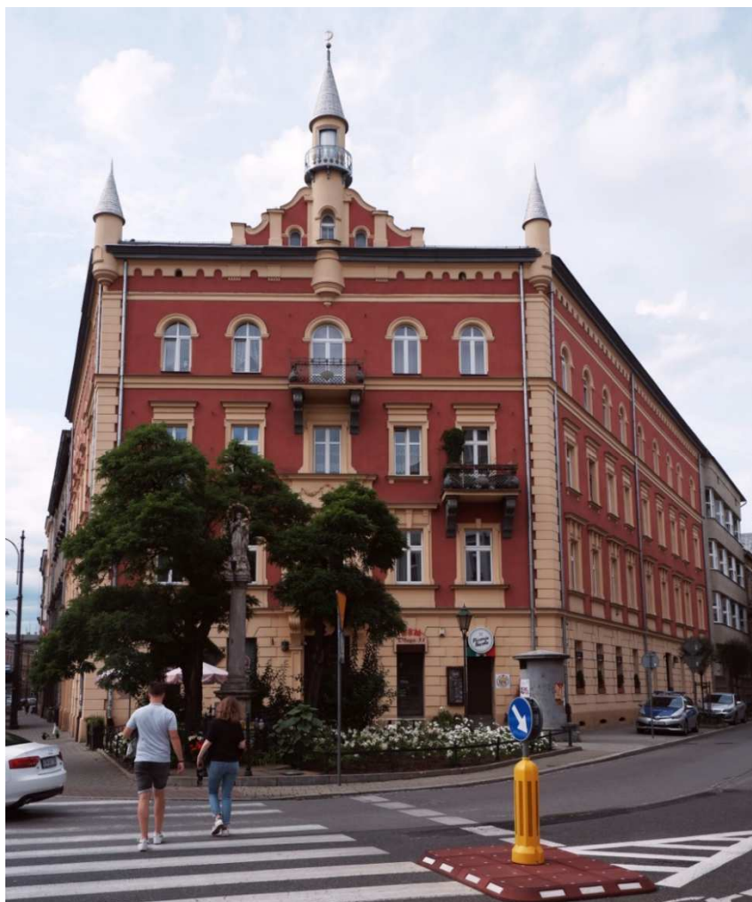
Fot. nr 162. Dom Turecki z naroża ulic: Długiej 31 i Pędzichów 2, pierwotnie 2-piętrowy, który dla Teodora Rayskiego powstał w latach 1883-85 wg projektu Hentyka Lamnsdorfa.
