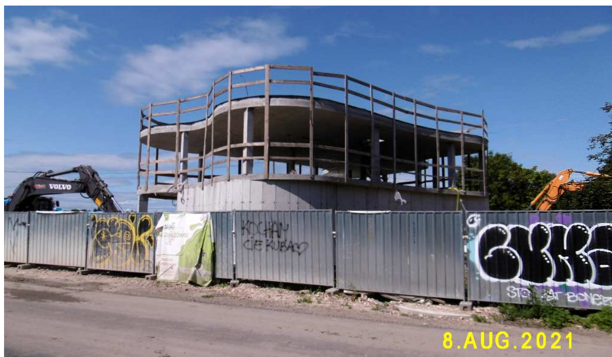
Fot. nr 366. Obiekt powstający przy kąpielisku, gdzie będzie też zapewne platforma widokowa.
