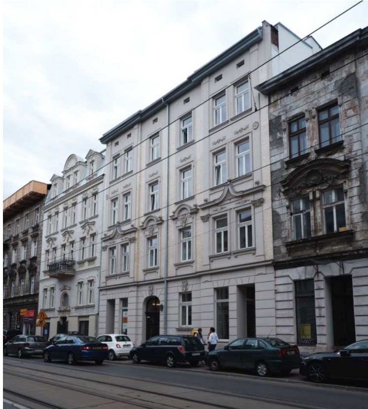
Fot. nr 406. Wyremontowane kamienice przy ulicy Starowiśnej 41 i 43. (01.08.2021)
