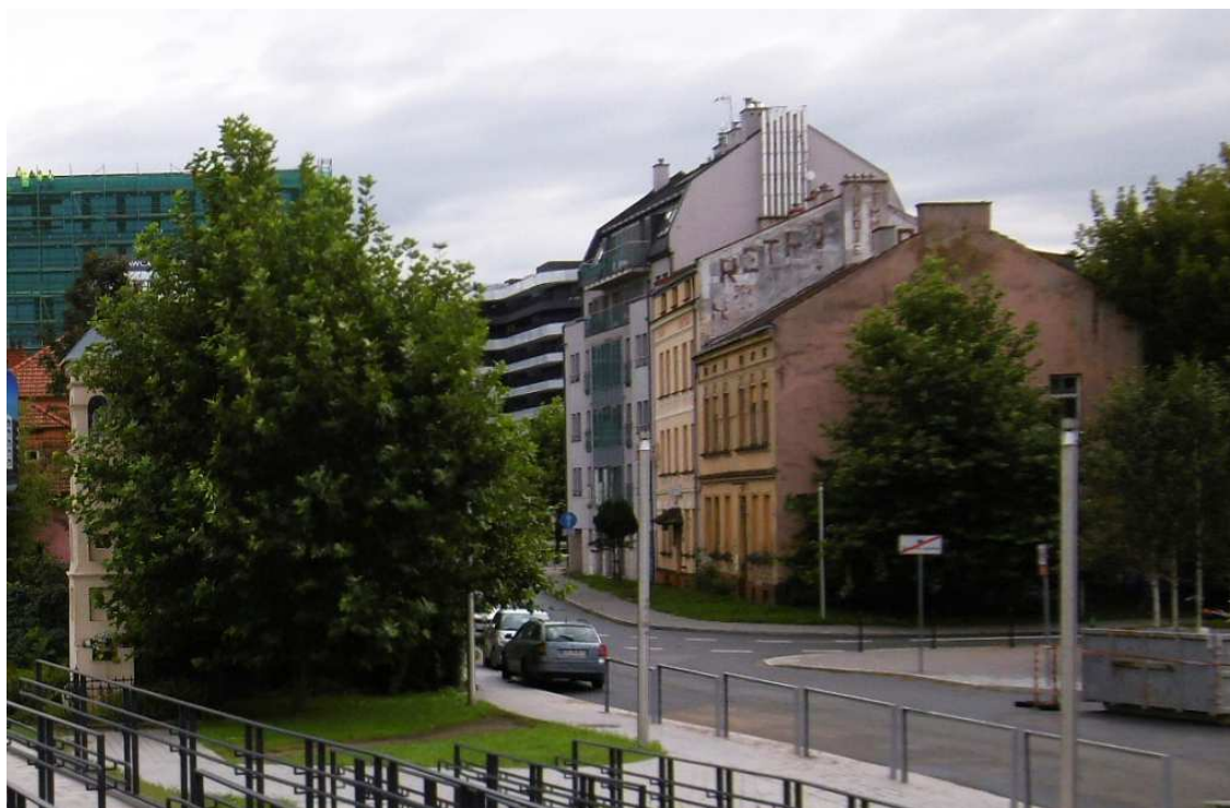
Fot. nr 358a. Fragment zabudowy ulicy Barskiej, na styku z Ludwinowem, o numerach: 57-61. Pierwsze dwa budynki to pozostałe jeszcze relikty dawnej zabudowy Zakrzówka. (26.08.2021)
