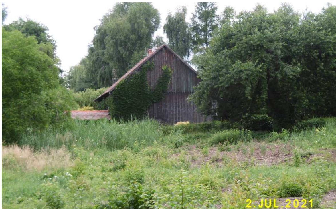
Fot. nr 490. Systematycznie pochałaniany przez zarośla samotny kiedyś w okolicy domu przy ulicy Obronnej 23a.
