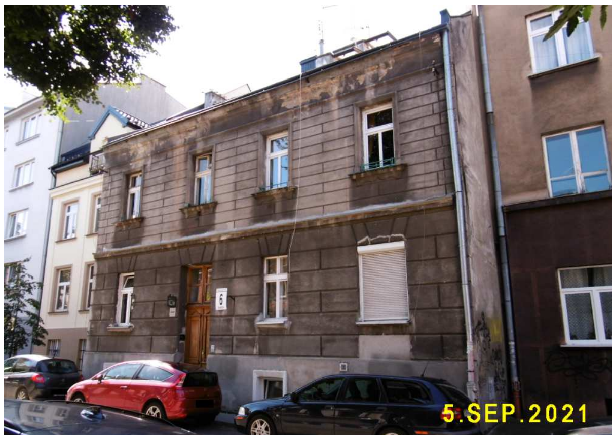
Fot. nr 112. Ostały jeszcze, zapewne ponad 100-letni relikw dawnej zabudowy Pólsia z ulicy Filareckiej 6.
