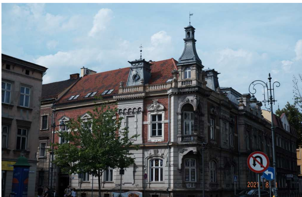
Fot. nr 155. Pałac Zdzisława Włodka, właściciela dóbr Dąbrowicy k. Bochni, wzniesiony w latach 1898-99 przy ulicy św. Filipa 25 wg. projektu Jana Sasa-Zubrzyckiego.
