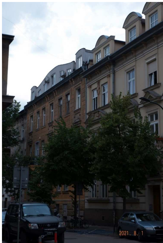
Fot. nr 17. Niezbyt gustowna nadbudowa kamienic pod nr: 15 i 17.
