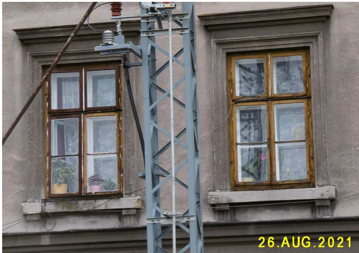
Fot. nr 437 (437-438). Dwa z trzech pozostałych w fasadzie oryginalnych okien typu ościeżnicowego.
