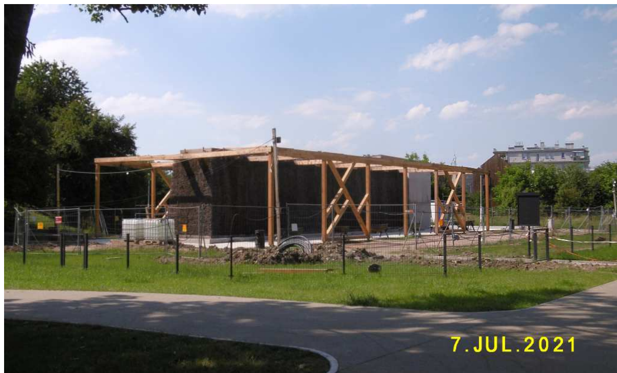
Fot. nr 473. Bliska otwarcia tężnia solankowa, choć jej uruchomienie ciągle się przeciąga.
