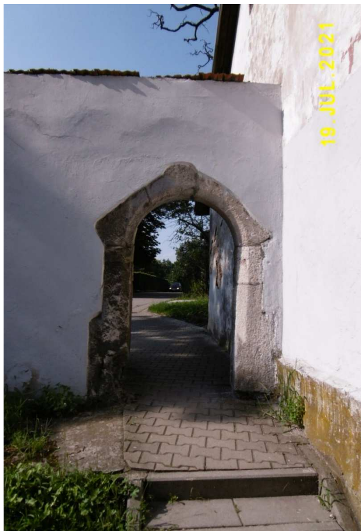
Fot. nr 310. Wejście na teren posesji pod nr 119.
