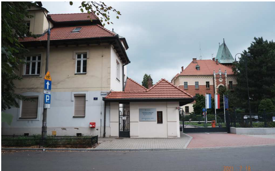
Fot. nr 114 (114-115). Zespół zabudowy Miejskiego Przedsiębiorstwa i Kanalizacji (dawny Miejski Wodociąg Pompowy im. Franciszka Józefa) przy ulicy Senatorskiej 1/Łowieckiej 2, który powstał w latach 1911-13 wg projektu Jana Rzymkowskiego. (18.07.2021)
