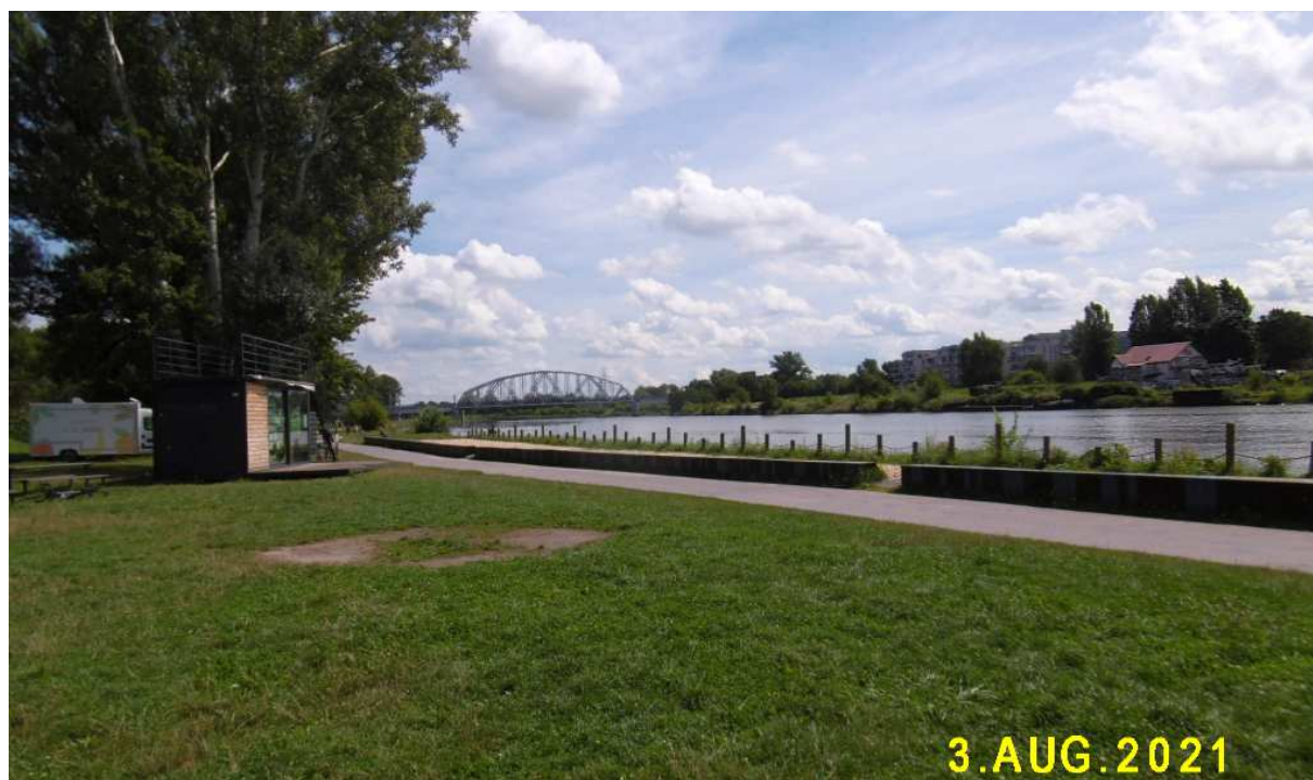
Fot. nr 275 (275-276). Widoki w stronę mostu kolejowego.
