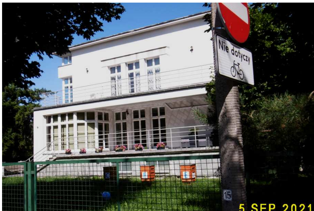
Fot. nr 90. Przykład przedwojennej zabudowy Cichego Kącika – willa z ulicy Domeyki 2 (przed wojną Pęszyc-Grudzińskiego), która powstała w roku 1936 wg projektu Adolfa Szyszko-Bohusza. W tym czasie powstała cała zabudowa tej ulicy.
