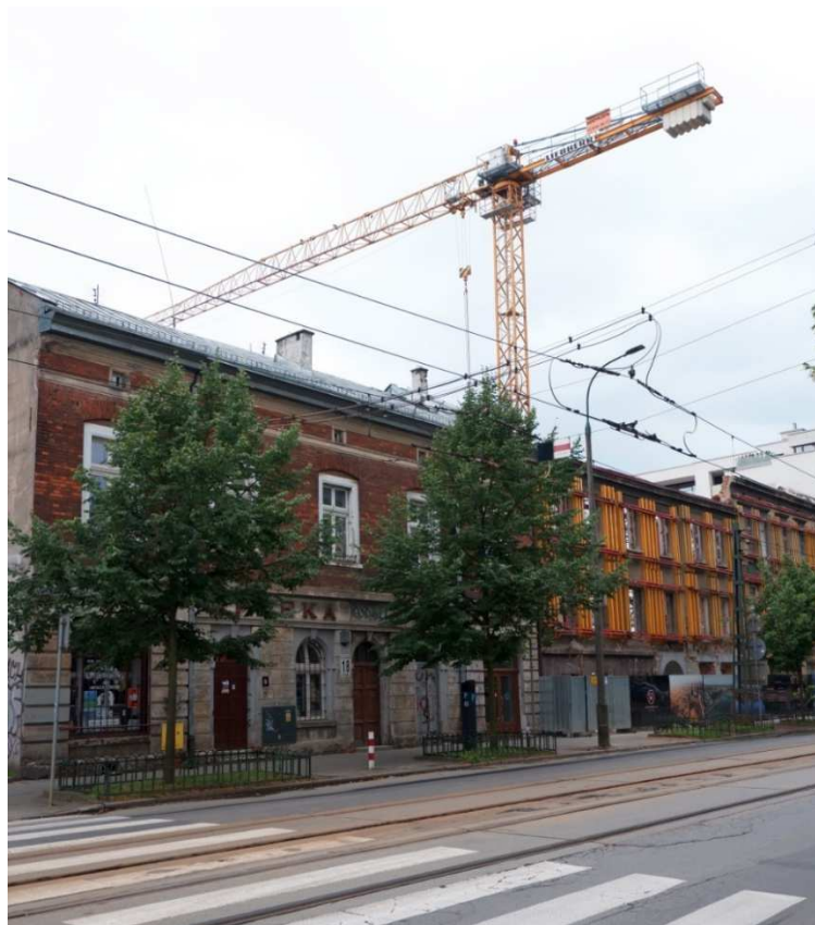
Fot. nr 122. Trwa przebudowa na apartamentowce kamienic pod nr 20 i 22. (18.07.2021)
