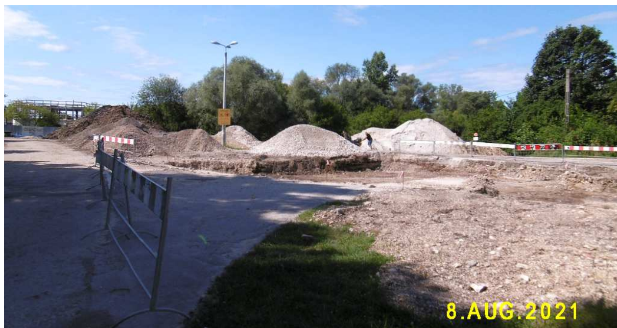
Fot. nr 365 (365-367). Roboty budowlane przy ulicy Wyłom przy tworzeniu nowego kąpieliska na skalistym brzegu zbiornika wodnego, pozostałości po dawnym kamieniołomie wapienia fabryki sody Solvay.
