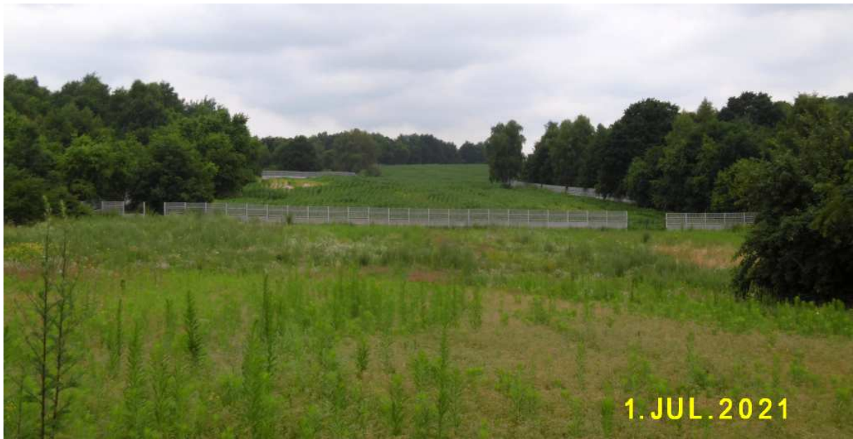
Fot. nr 474 (474-477). Wyglądający niczym obóz koncentracyjny, centralny fragment zielonego terenu, rozciągającego się wzdłuż ulicy Słona Woda, który właściciel, potencjalny deweloper, ogrodził w sposób nielegalny.
