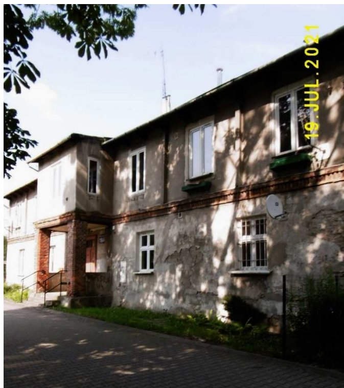
Fot. nr 318 (318-319). Detale fasady
