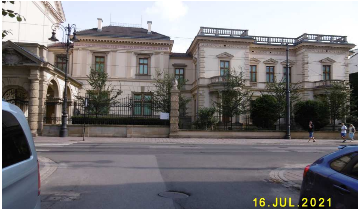
Fot. nr 62. Pałac Czapskich z ulicy Piłsudskiego 10-12, który powstał w latach 1883-84 wg projektu Antoniego Siedeka.
