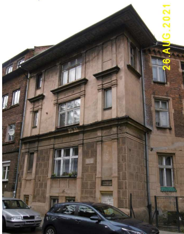
Fot. nr 339. Dobudowane do kamienicy w roku 1911 lewe skrzydło.
