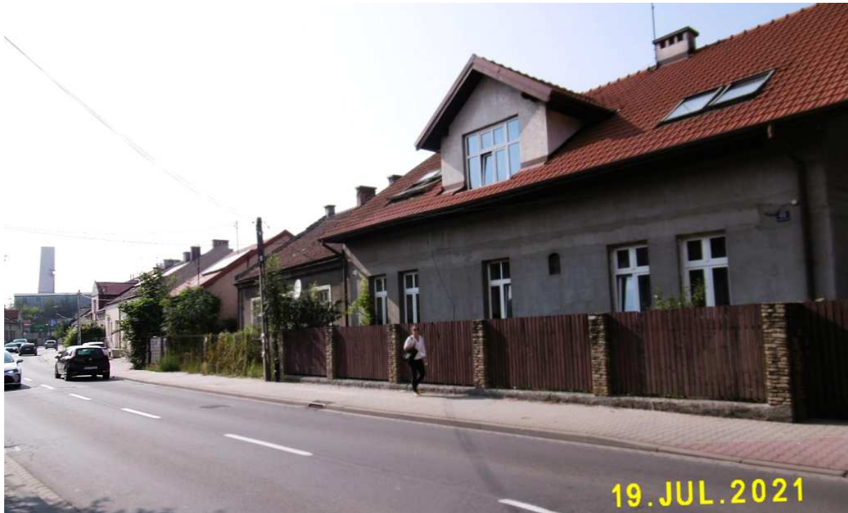
Fot. nr 292. Zabudowa ulicy poniżej domu o numerze 49.
