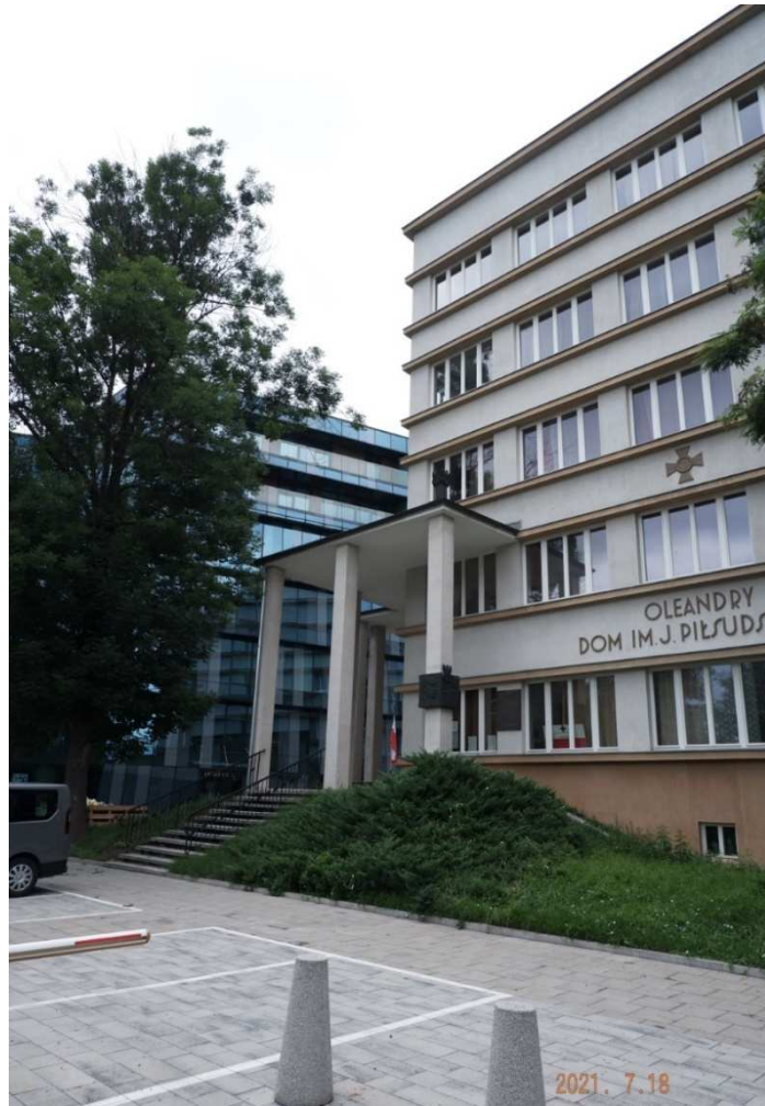
Fot. nr 70. Dom im. J. Piłsudskiego przy ulicy 3-Maja 7 oraz nowo powstały pod nr 9, w miejscu gmachu Petroinformu, budynek o szklanej fasadzie i krzywych ścianach
