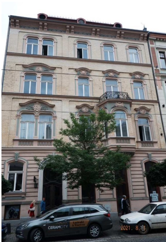
Fot. nr 38 (38-41). Przykłady stylu przejściowego pomiędzy eklektyzmem, a secesją. Kamienica pod nr 11 z roku 1899, wyb. wg projektu Zygmunta Luksa (nadb. w latach 30.)
