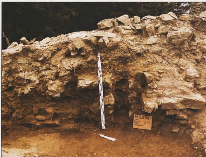
Ryc. 5. Wnęka na belkę we wschodnim murze obwodowym
