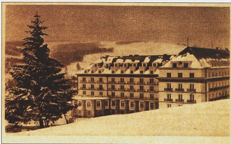
Hotel - Pension „Lwigród” Zakładu Ubezp. Prac. Umysł. we Lwowie. Gmach, wykonany w r. 1928, jest największym tego rodzaju hotelem uzdrowiskowym w Polsce. [Fot. z rozdziału Uzdrowiska , podpis oryginalny]
