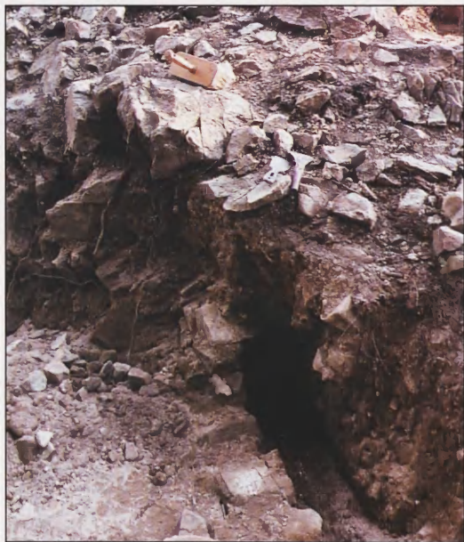
Ryc. 3. Kanał we wnętrzu wschodniego muru obwodowego
