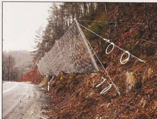
To nowatorskie rozwiązanie wykonała szwajcarska firma Geobrugg
