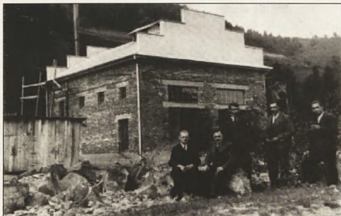
Budynek elektrowni w budowie
