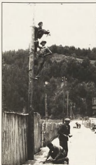
Budowa sieci elektrycznej
