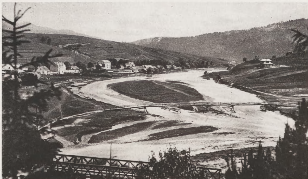
Most na Popradzie (początek lat dwudziestych)
