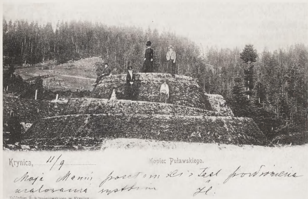
Kopiec Pułaskiego w budowie — pocztówka z 1901 roku
