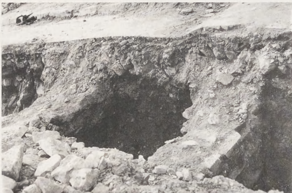
Odslonięte sklepienia piwnic, kryjących się pod muszyńskim Rynkiem (fot. Barbara Rucka)
