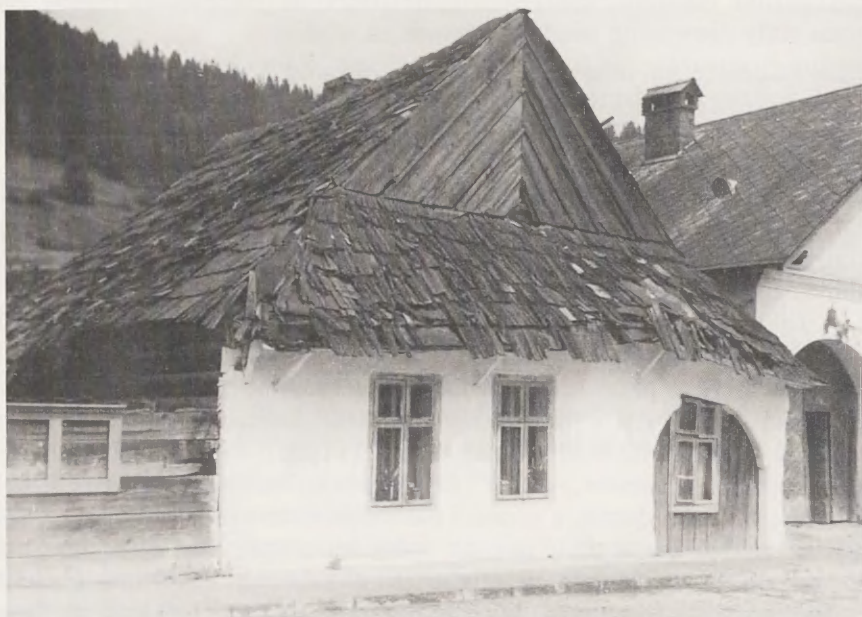
Dom Bęynków. Stan z 1958 roku. Dom rozebrano wiosną 1964 roku.
